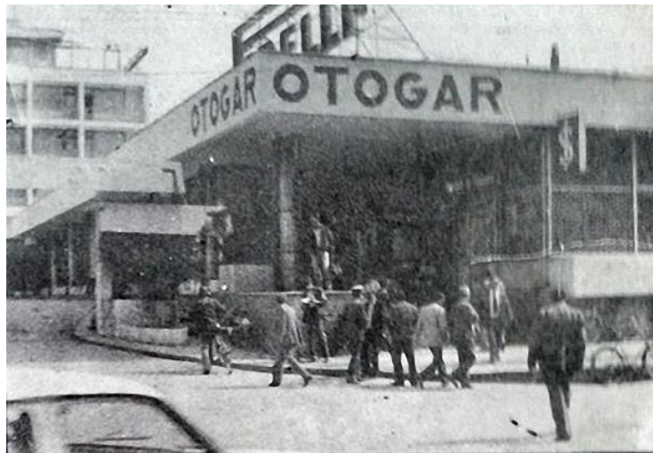
Eski otogarın İş Bankası yanındaki girişi. (Arslan, 2023)
