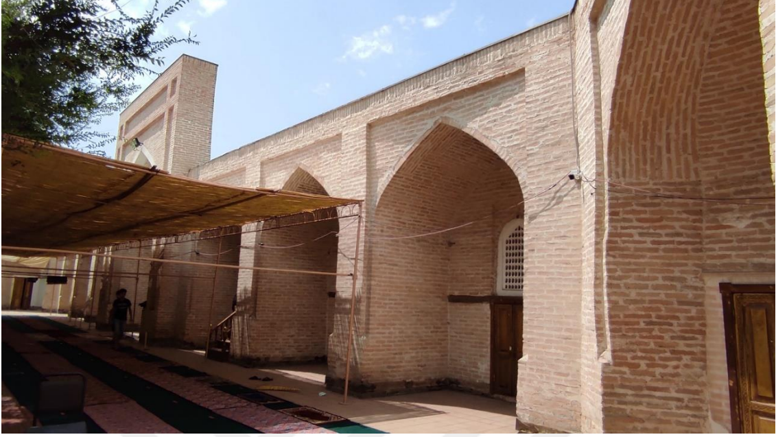
Fotoğraf 2.127. Batı cephe görünümü.
