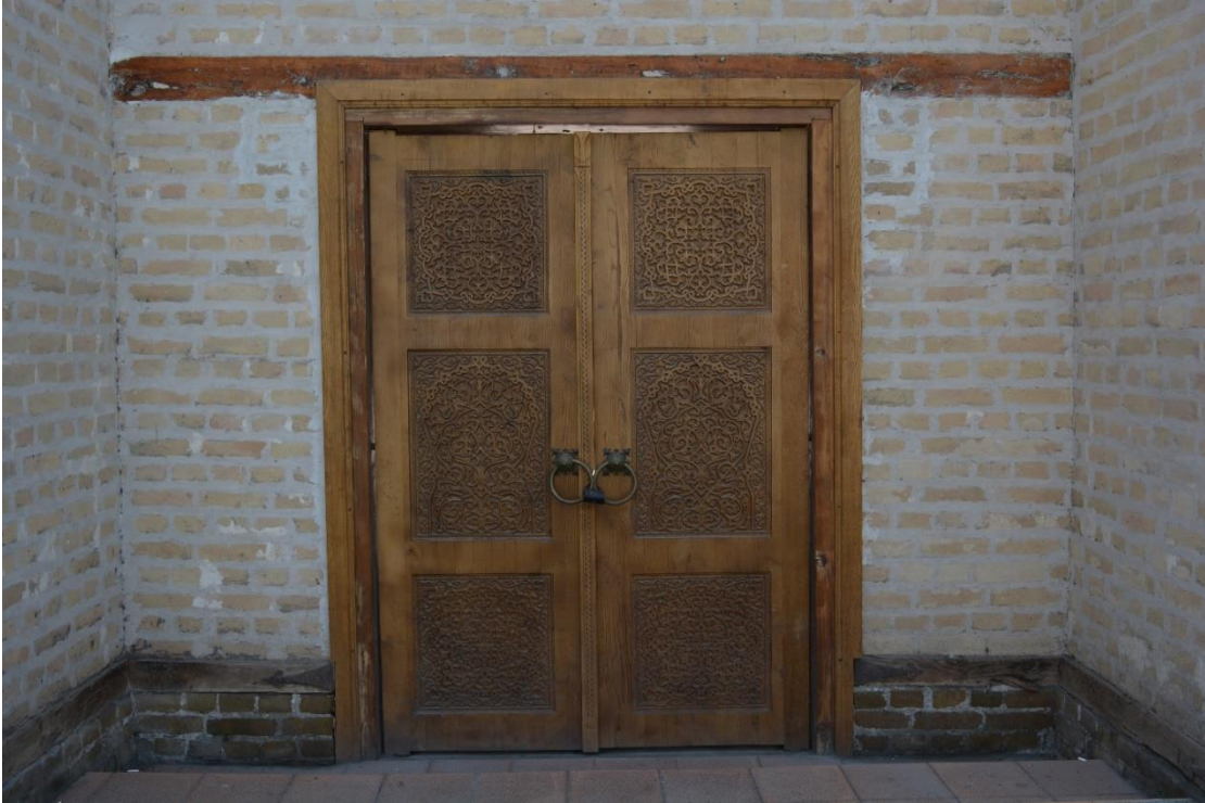
Fotoğraf 2.85. Yapıya girişin sağlandığı ahşap kapının detay görünümü.
