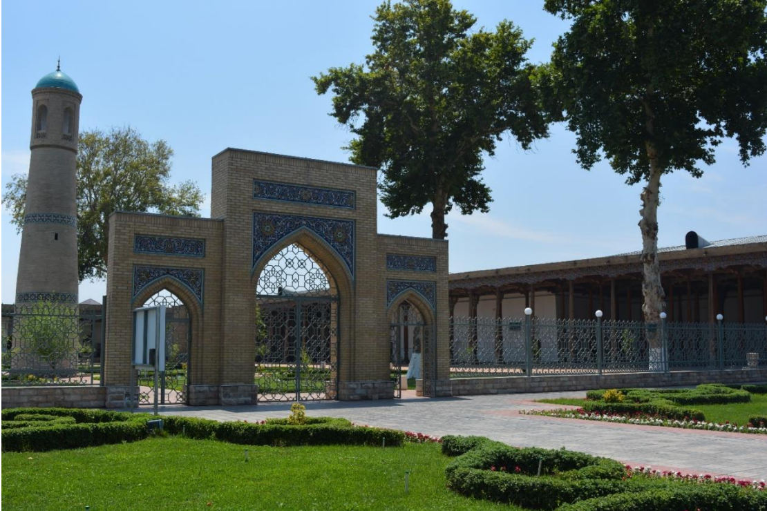
Fotoğraf 2.6. Kuzey cephe avluya giriş kapısı görünümü.
