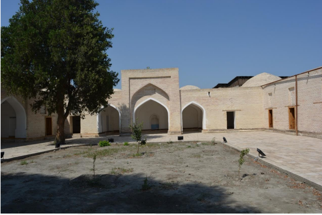
Fotoğraf 2.171. Batı cephe görünümü.
