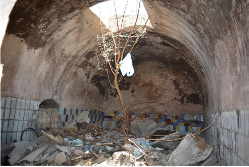
Fotoğraf 2.295. Güneydoğu köşede yer alan halvet hücresi ile diğer halvete açılan kapı görünümü.
