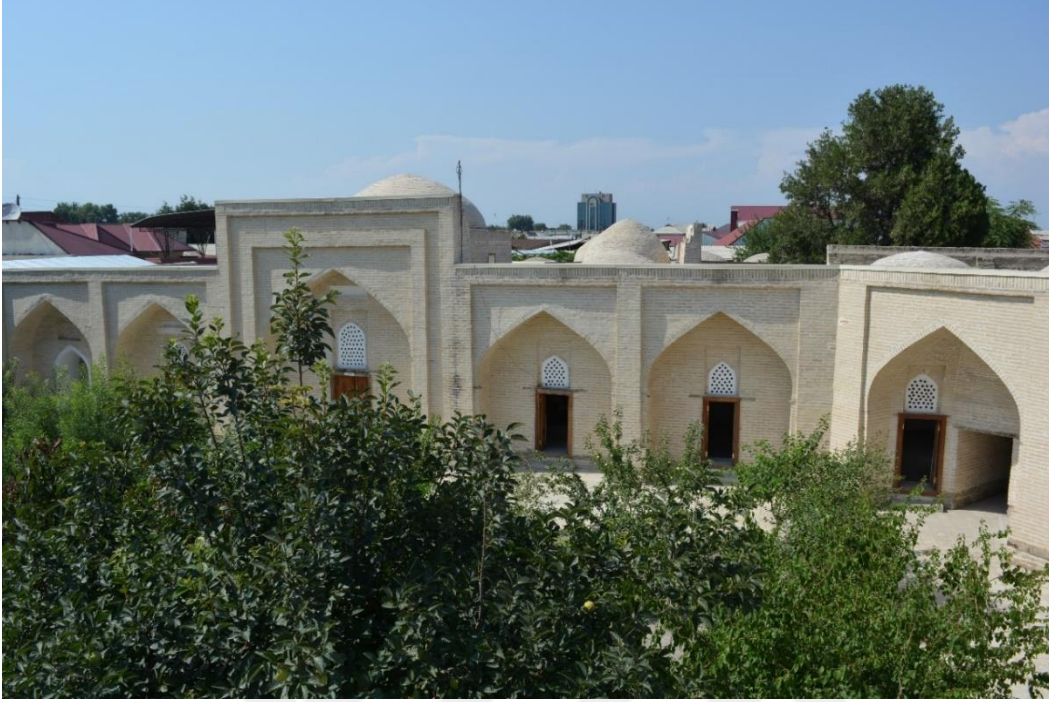
Fotoğraf 2.137. Avlunun kuzey cephesi görünümü.
