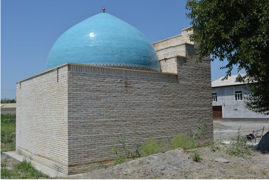
Fotoğraf 2.249. Doğu ve güney cephe görünümü.
