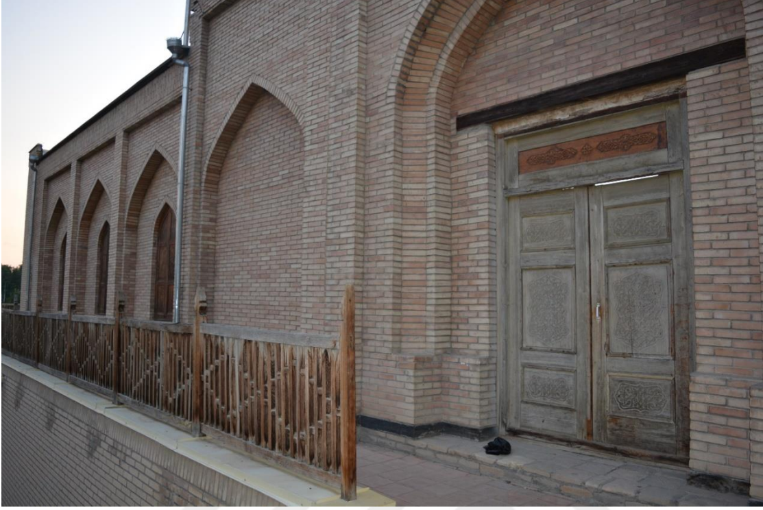
Fotoğraf 2.306. Güneybatıda yer alan giriş açıklığı görünümü.
