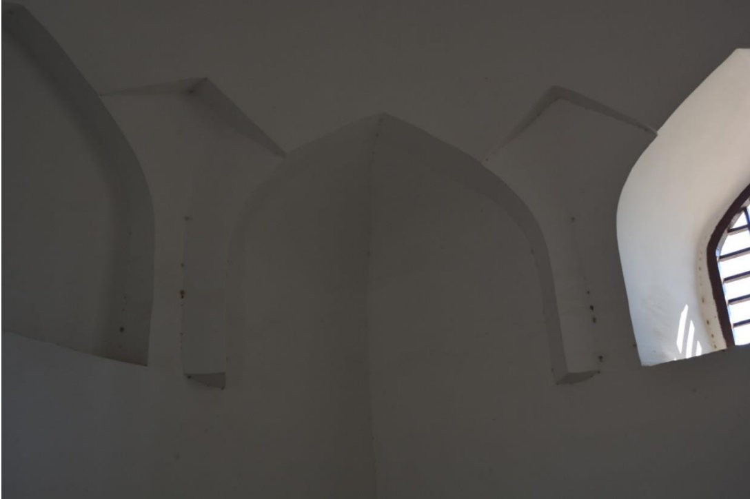
Fotoğraf 2.207. Kubbeye geçiş görünümü.
