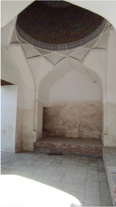
Fotoğraf 2.242. Sağır sivri kemer ve kubbeye geçiş öğeleri görünümü.
