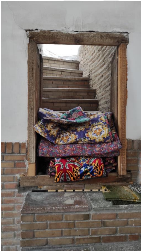
Fotoğraf 2.222. Güneybatı köşede yer alan merdiven görünümü.
