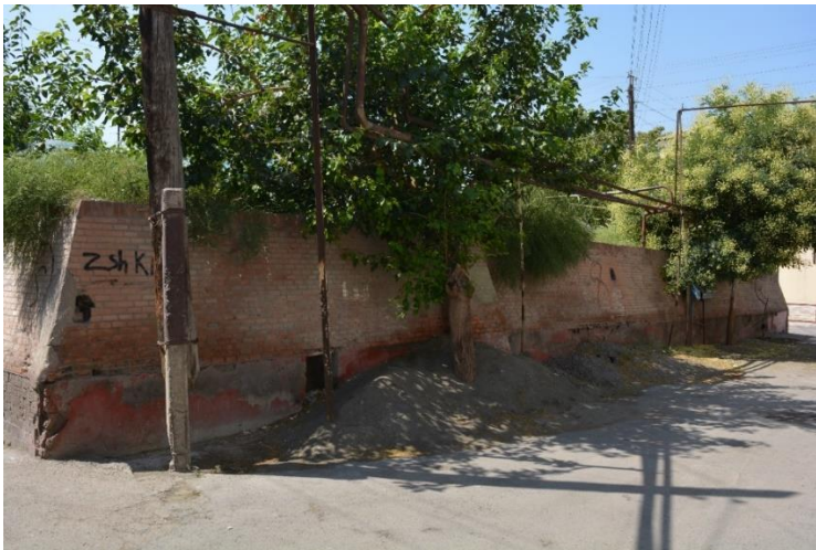
Fotoėraf 2.280. Kuzey cephe görünümü.
