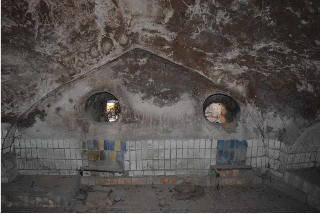
Fotoğraf 2.297. Kuzeydoğu halvet hücresi kemer detayı görünümü.
