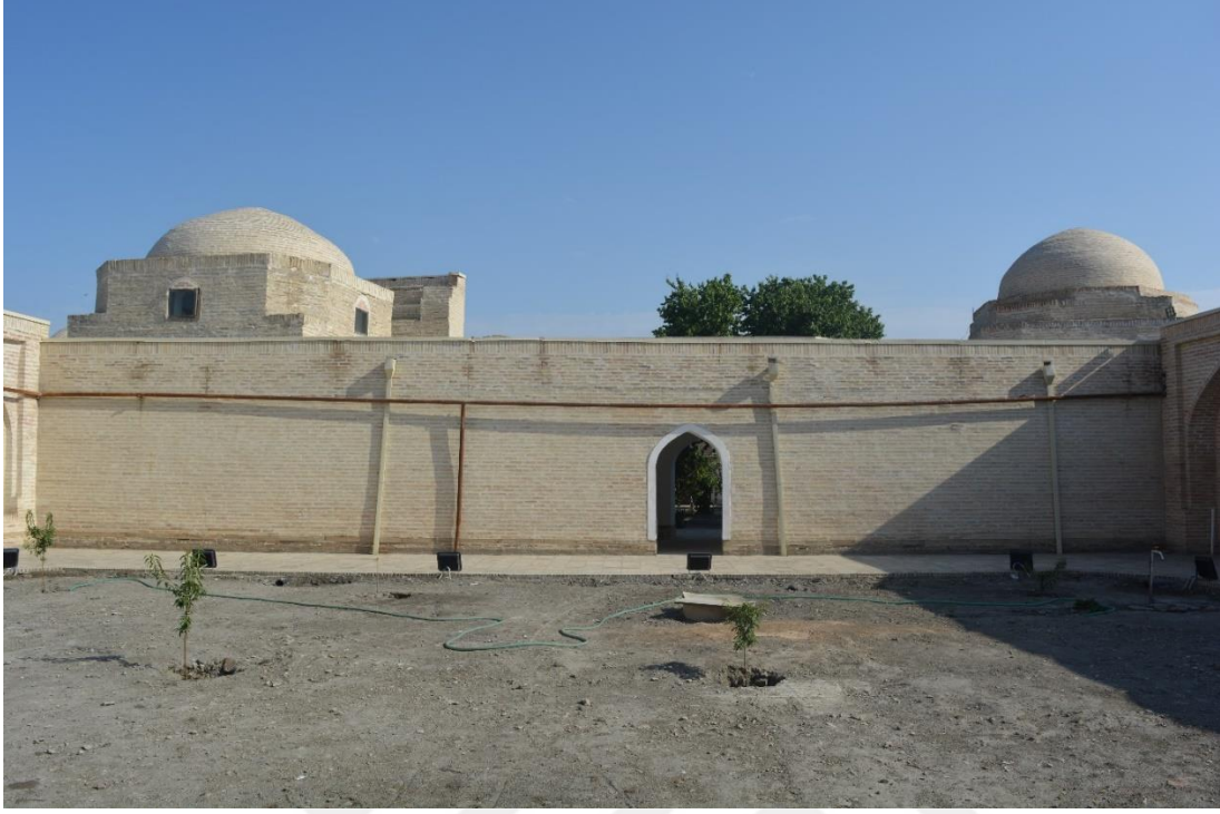
Fotoğraf 2.157. Güney cephe görünümü.
