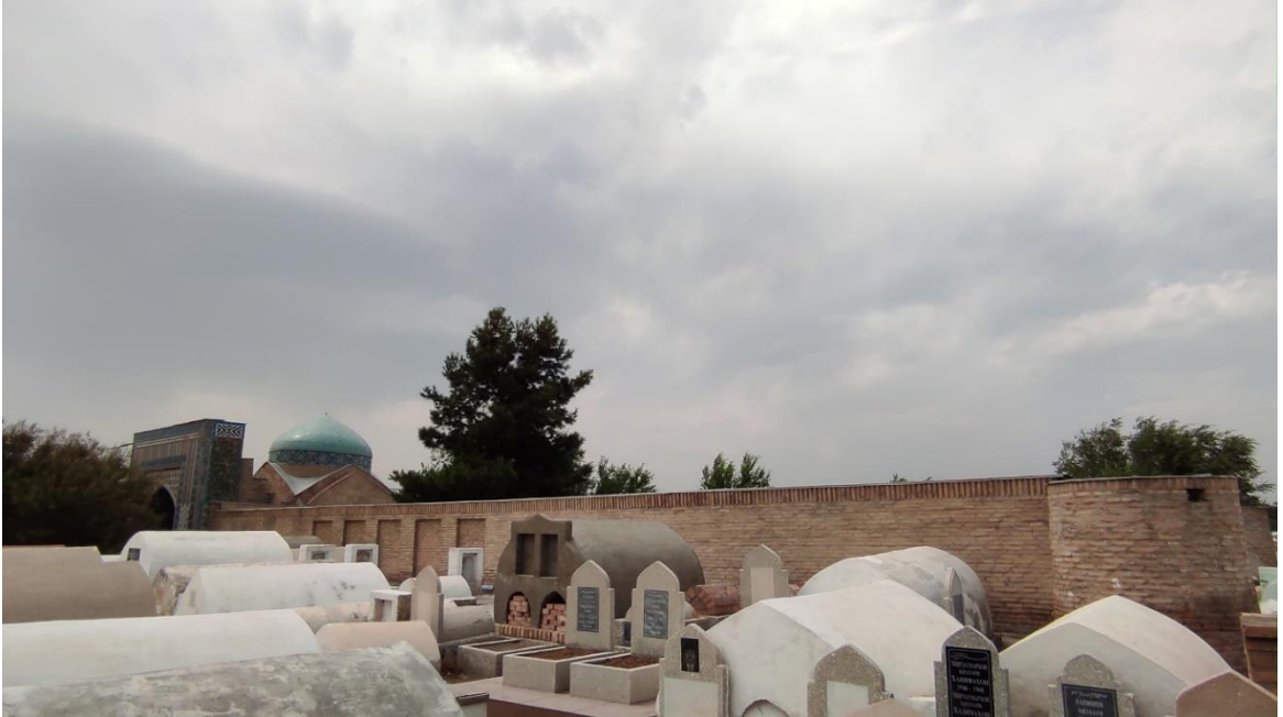
Fotoğraf 2.212. Güney cephe görünümü.
