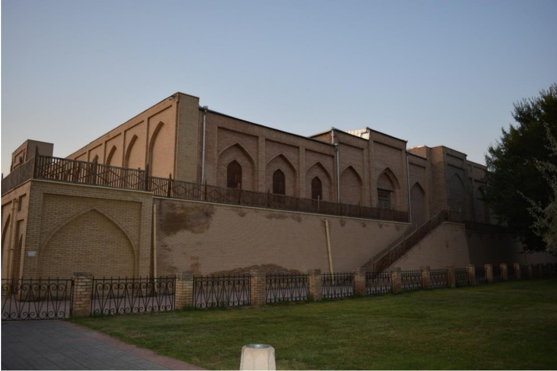
Fotoğraf 2.305. Güneybatı köşeden cephenin görünümü.
