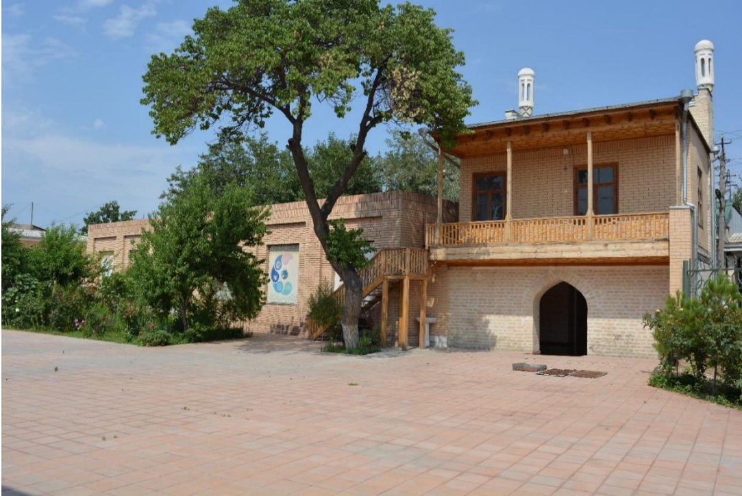
Fotoğraf 2.97. Avlunun doğu cephesi görünümü.
