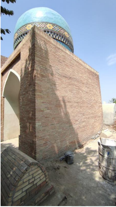
Fotoğraf 2.237. Batı cephe görünümü.
