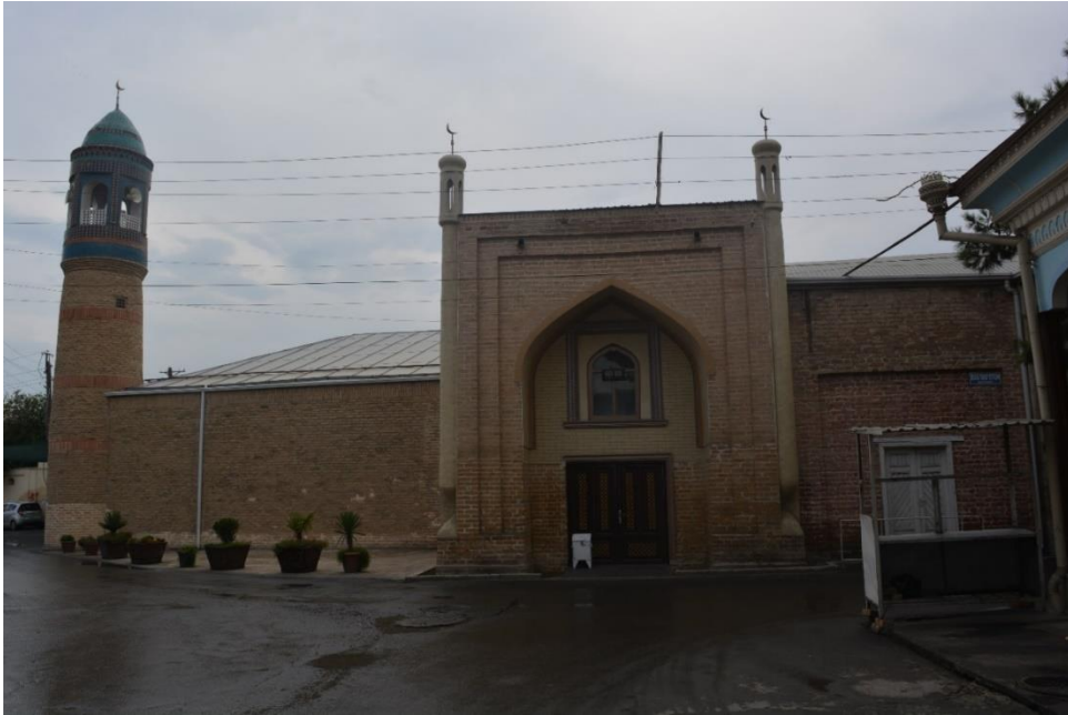
Fotoğraf 2.176: Batı cephe ve cephede yer alan kapı görünümü.
