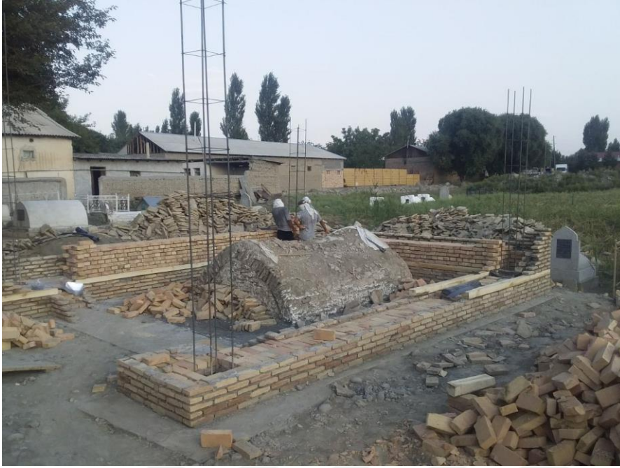
Fotoğraf 2.261. Türbe inşasının tekrar yapım aşaması görünümü.
