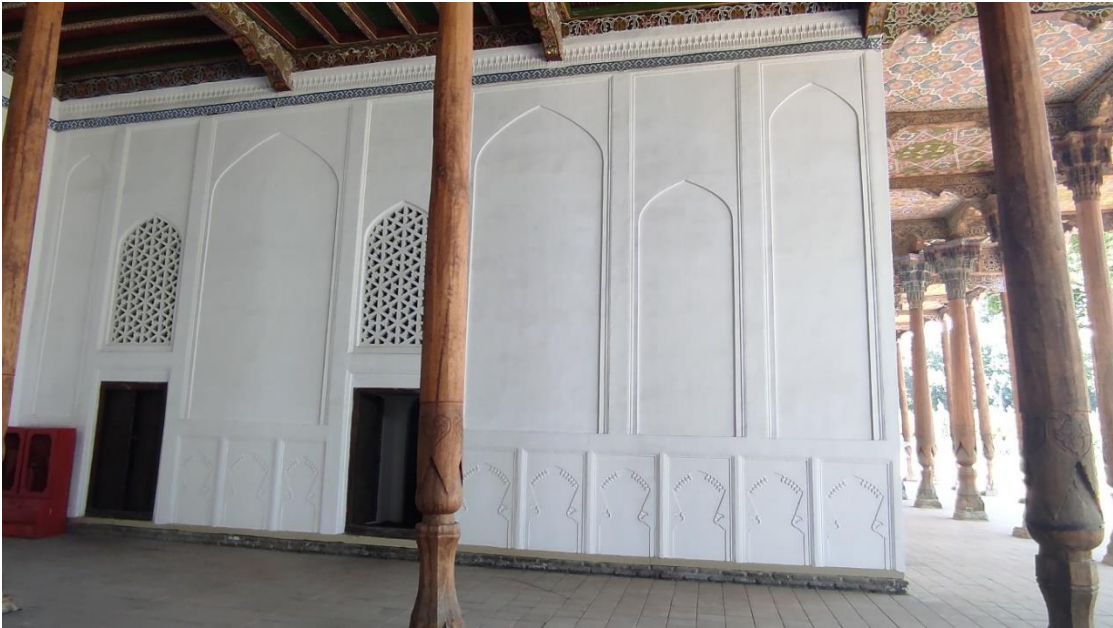
Fotoğraf 2.18. Kışlık bölümün güney cephe görünümü.
