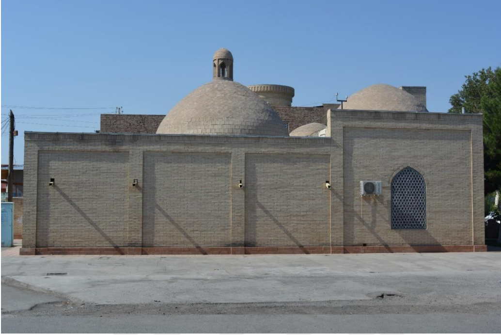
Fotoğraf 2.262. Güney cephe görünümü.
