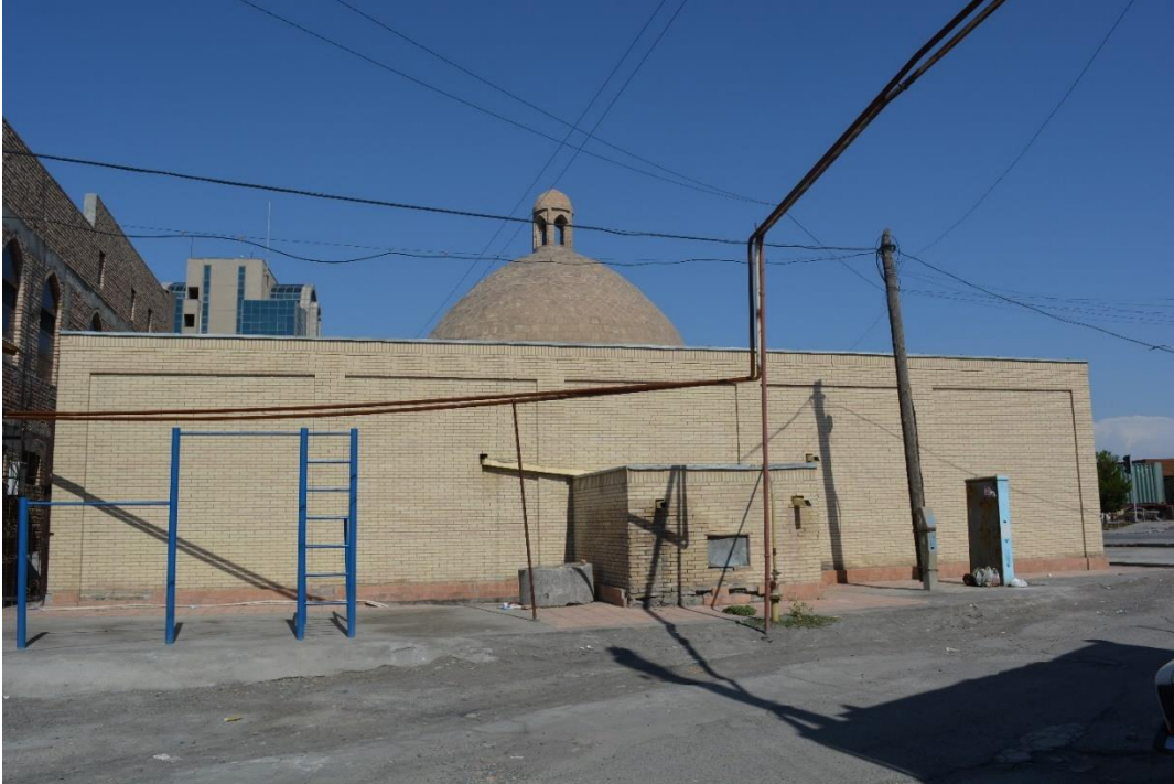
Fotoğraf 2.263: Batı cephe görünümü.
