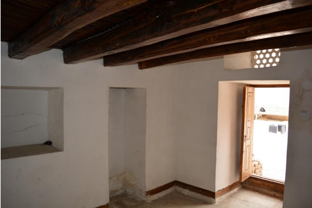
Fotoğraf 2.41. Hücre odalarının içeriden görünümü.
