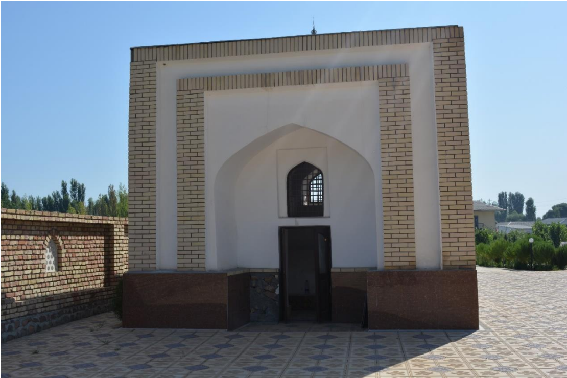
Fotoğraf 2.205. Batı cephe görünümü.
