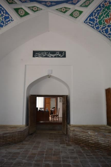
Fotoğraf 2.326. Kuzey duvarında yer alan kapı açıklığı görünümü.
