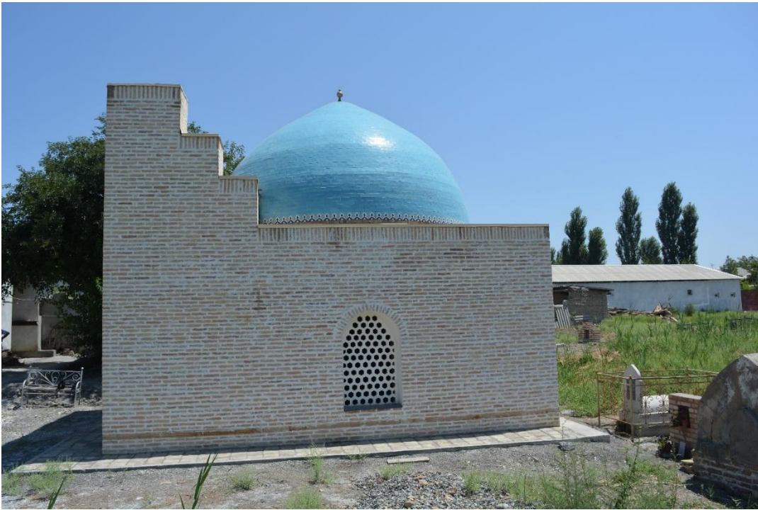
Fotoğraf 2.250. Doğu ve güney cephe görünümü.
