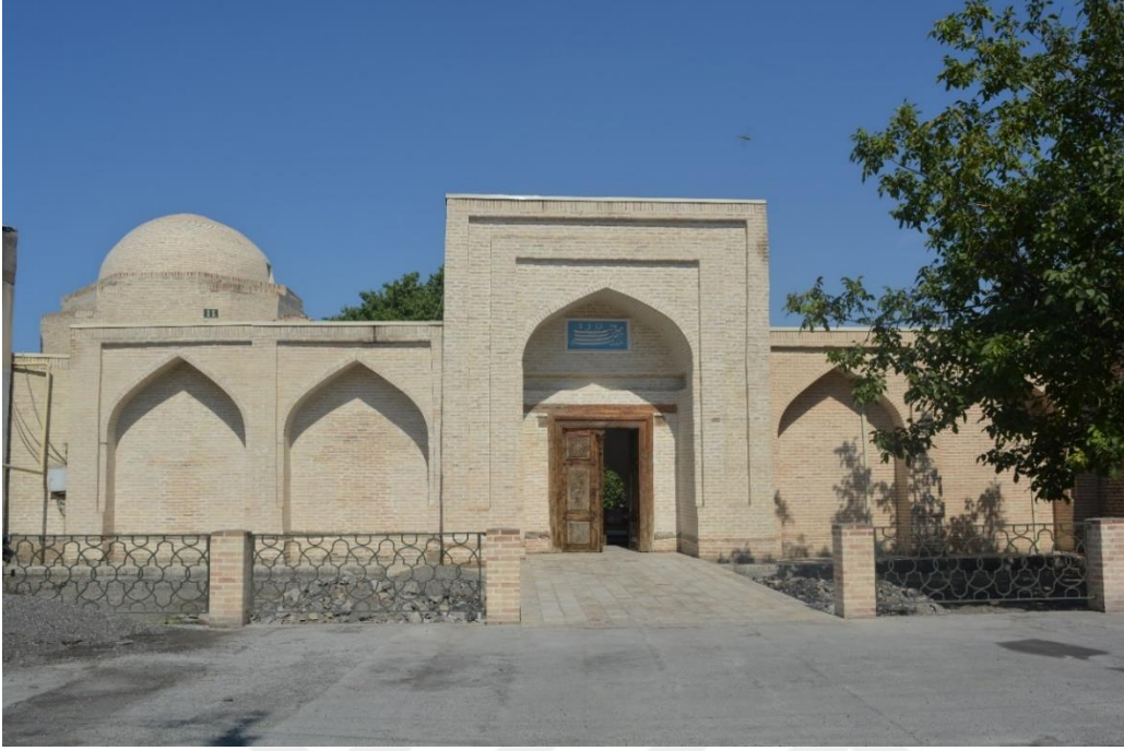
Fotoğraf 2.131. Batı cephe görünümü.
