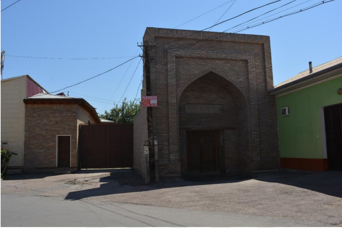
Fotoğraf 2.79. Kuzeybatıda yer alan taç kapı görünümü.
