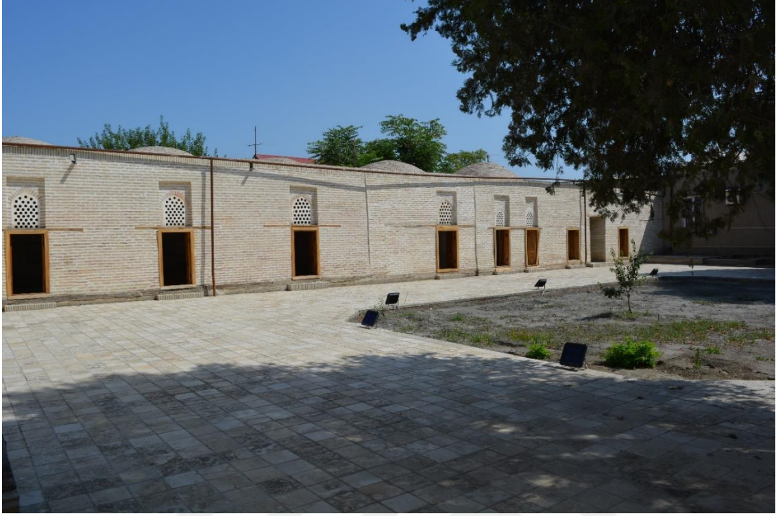
Fotoğraf 2.165. Avlunun kuzey cephesi görünümü.
