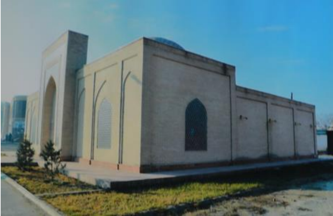
Fotoğraf 2.265. Kuzey cephe görünümü.
