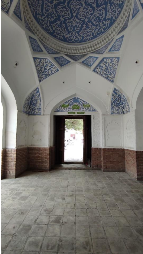
Fotoğraf 2.220. Kubbeye geçiş öğeleri ve cephelerde yer alan kartuşlar görünümü.
