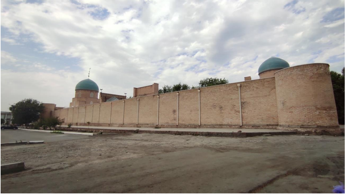
Fotoğraf 2.102. Batı cephe görünümü.
