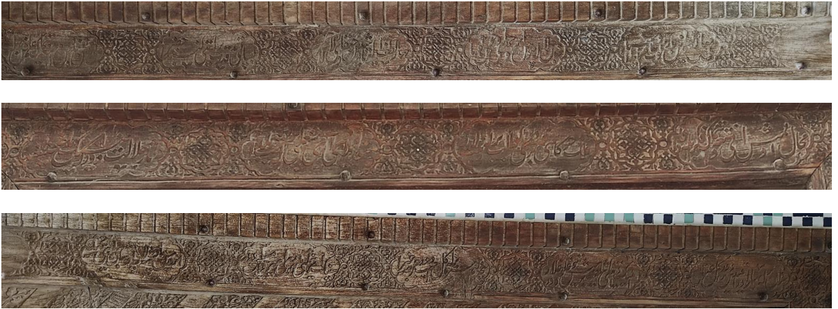
Fotoğraf 2.216. Kapı pervazını kuşatan yazı kuşağı görünümü.
