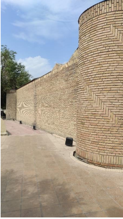
Fotoğraf 2.209. Batı cephe görünümü.
