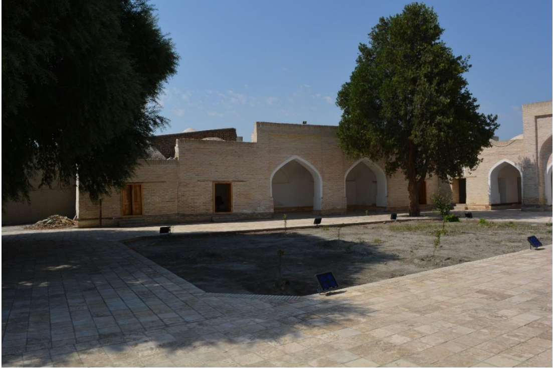
Fotoğraf 2.168. Güney cephe görünümü.
