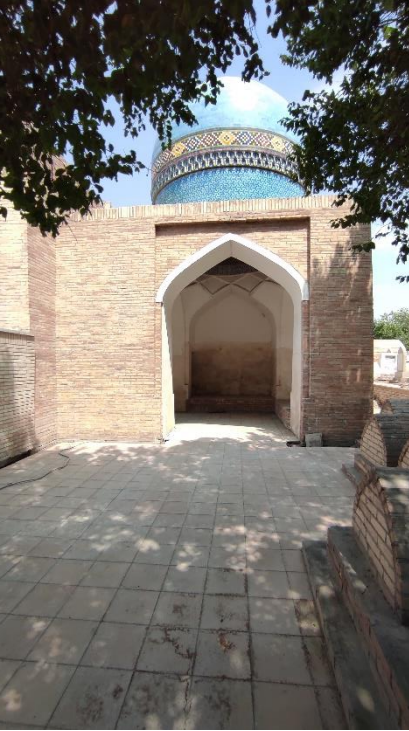
Fotoğraf 2.238. Batı cephe görünümü.
