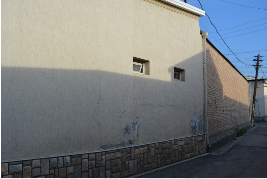
Fotoğraf 2.46. Batı cephe görünümü.
