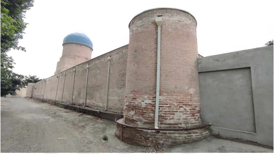
Fotoğraf 2.101. Güney cephe görünümü.
