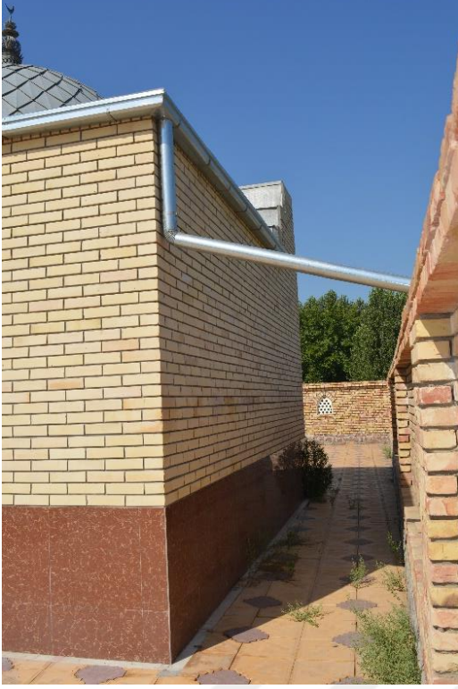
Fotoğraf 2.202. Kuzey cephe görünümü.
