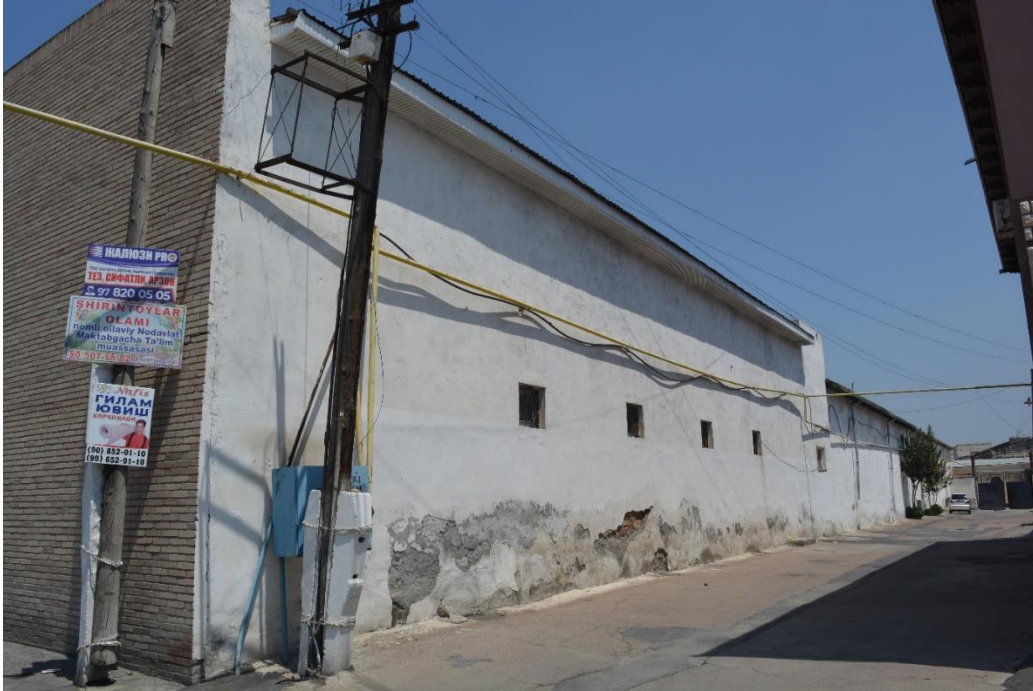
Fotoğraf 2.2. Güney cephe görünümü.
