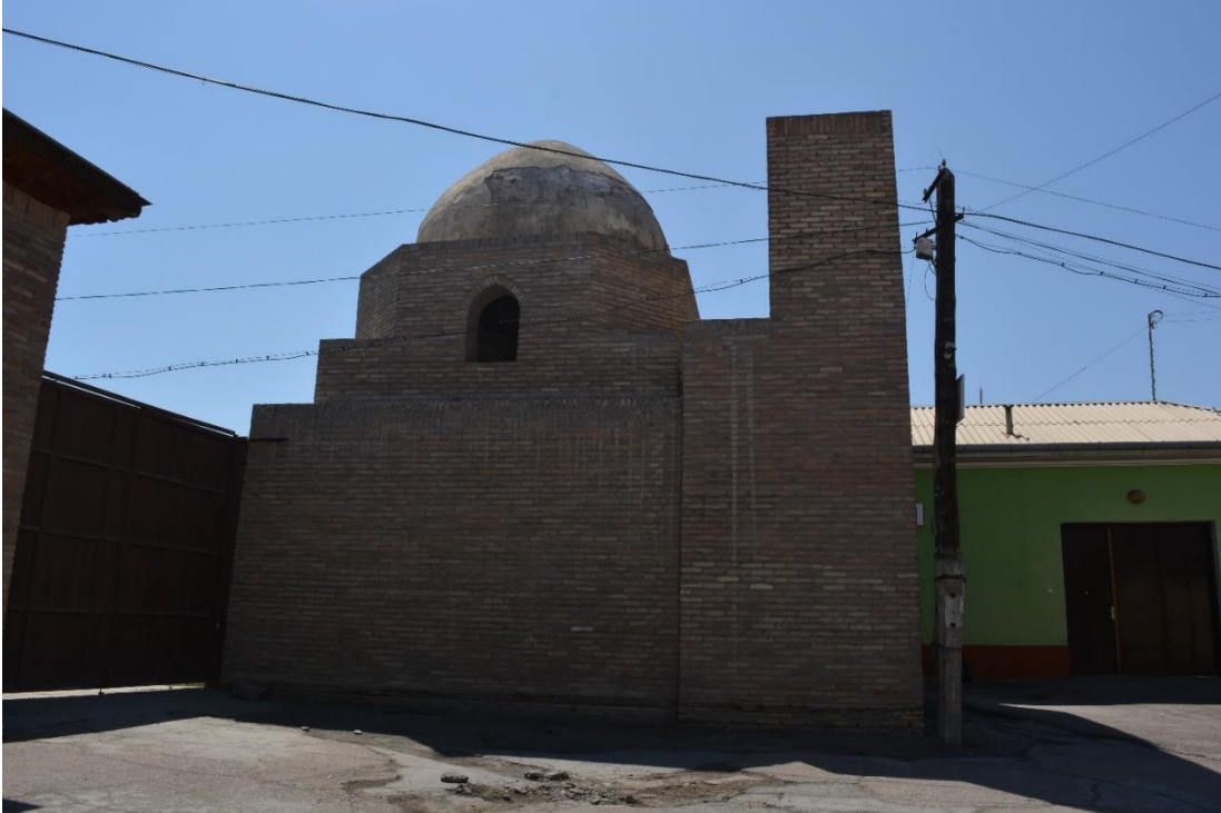
Fotoğraf 2.80. Taç kapı girişinin kubbe görünümü.
