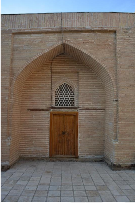
Fotoğraf 2.60. Batı cephe hücre girişi görünümü.
