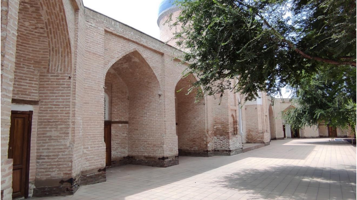
Fotoğraf 2.122. Güney cephe görünümü.
