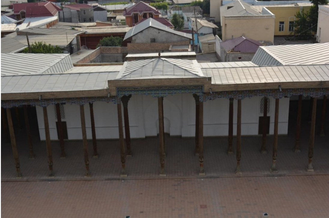
Fotoğraf 2.24. Kırmı sac çatı görünümü.
