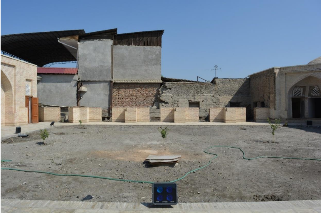
Fotoğraf 2.156. Kuzey cephe görünümü.
