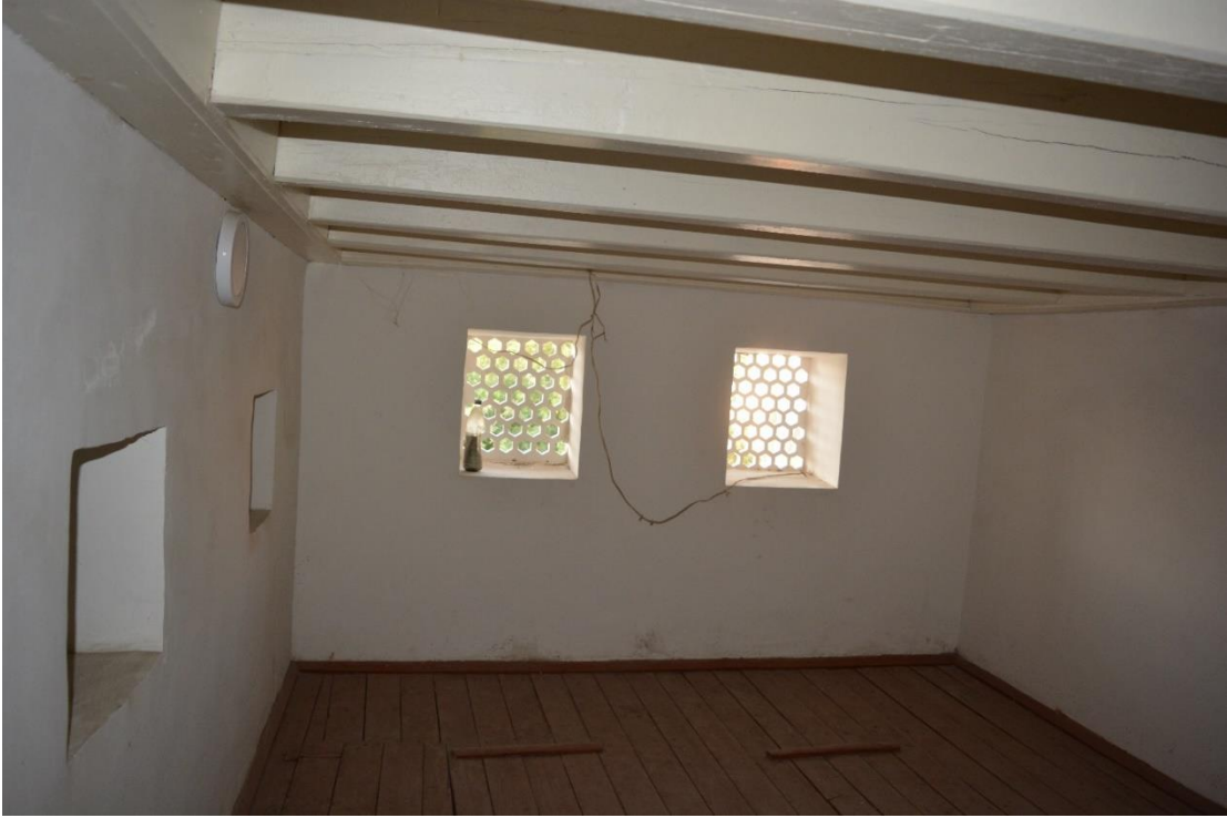
Fotoğraf 2.77. İkinci katta yer alan odanın görünümü.
