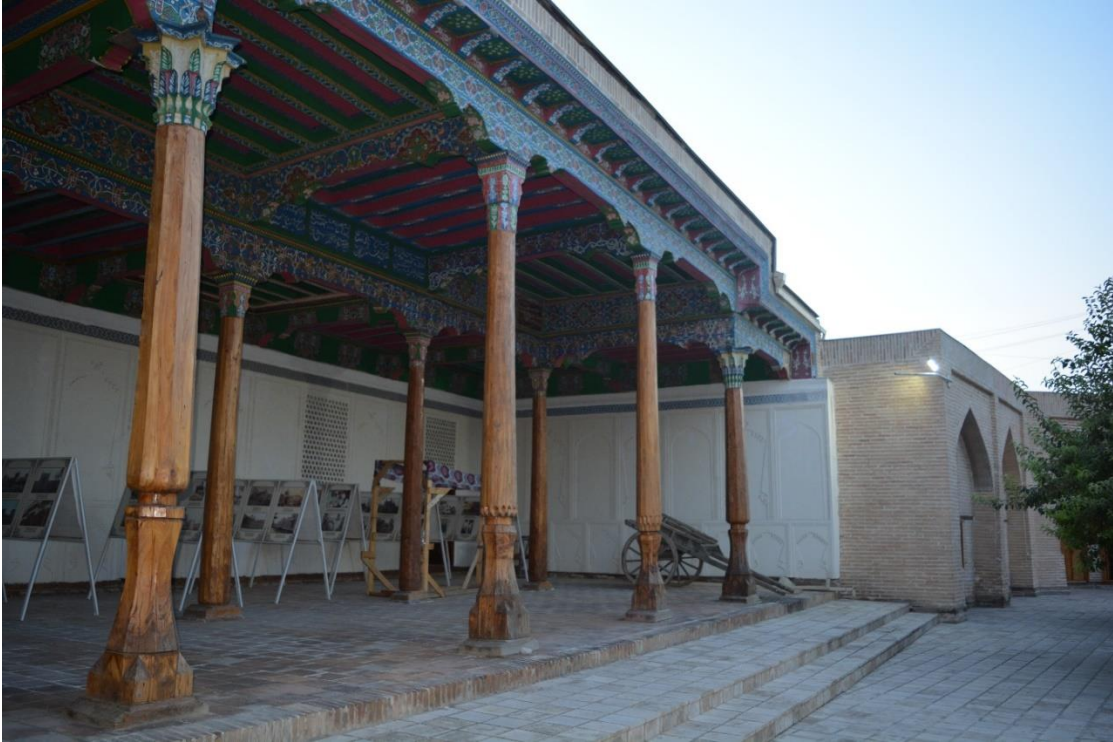
Fotoğraf 2.53. Batı cephe görünümü.
