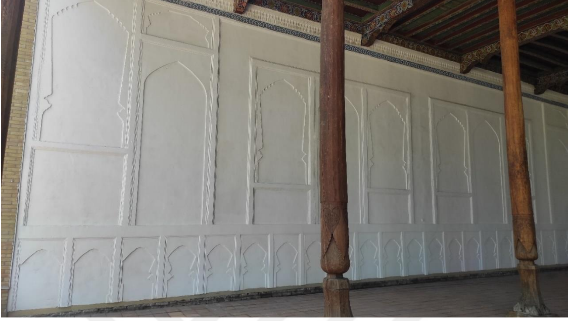
Fotoğraf 2.9. Güney cephe duvarı alçı süsleme görünümü.
