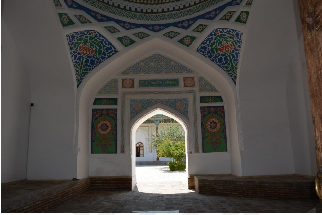
Fotoğraf 2.329. Batı duvarından avluya geiş aıklığı grnm.
