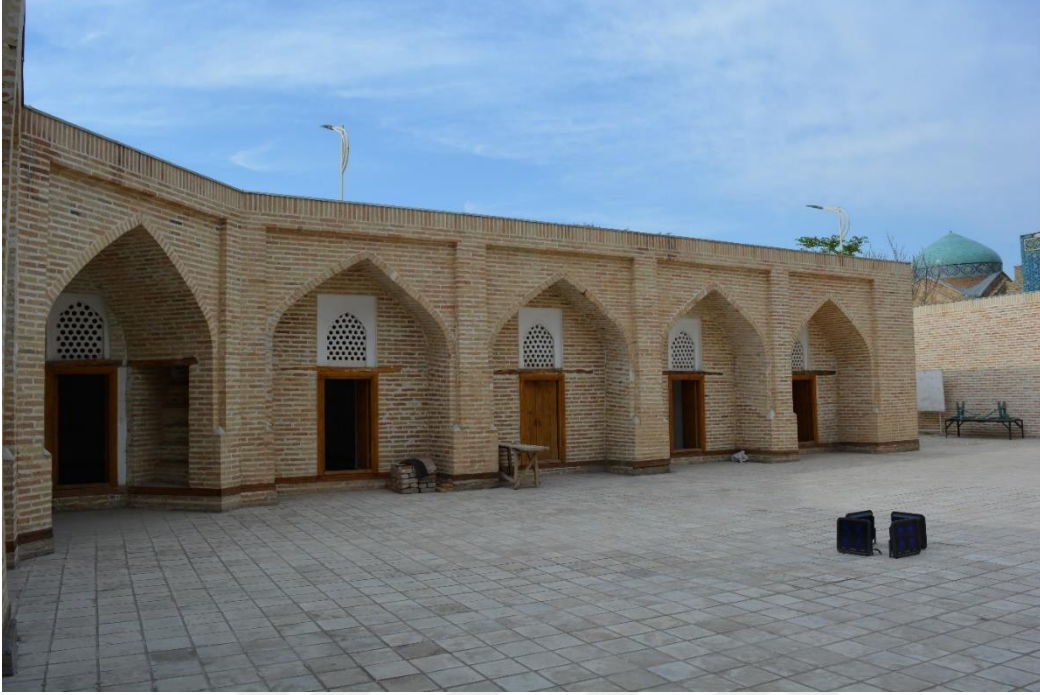
Fotoğraf 2.40. Kuzey cephe görünümü.
