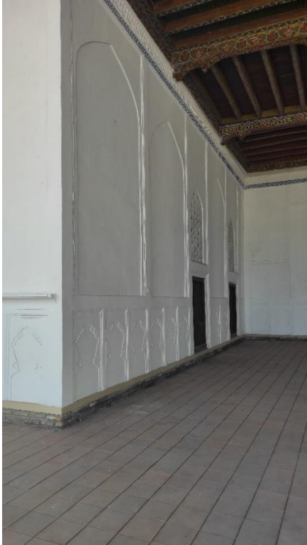
Fotoğraf 2.16. Kışlık bölümün kuzey cephe görünümü.
