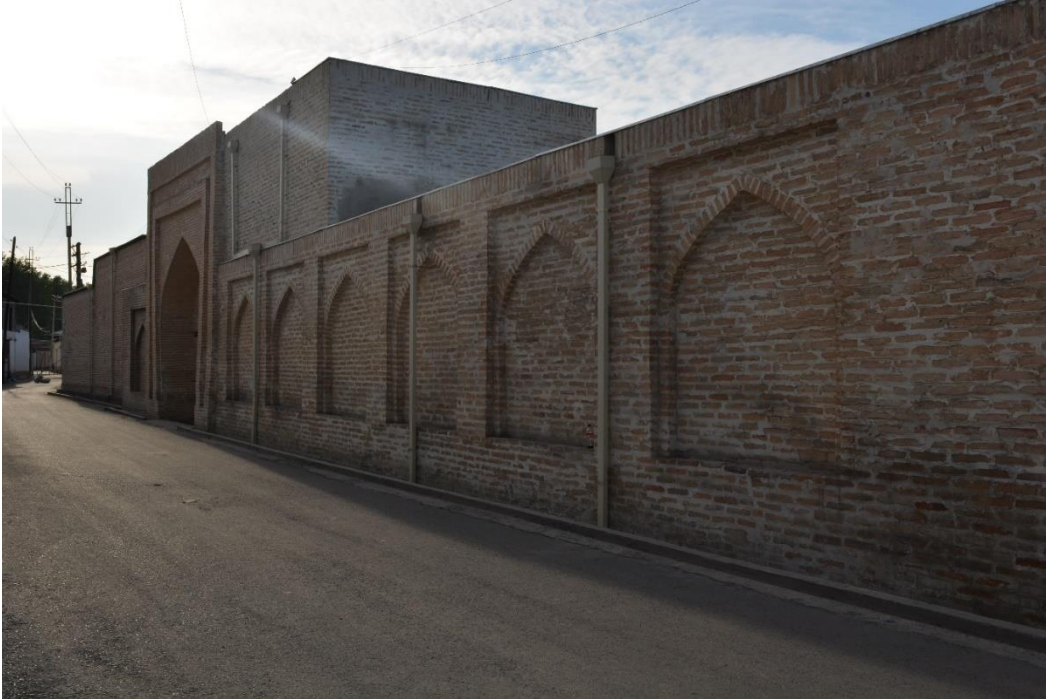
Fotoğraf 2.49. Güney cephe görünümü.
