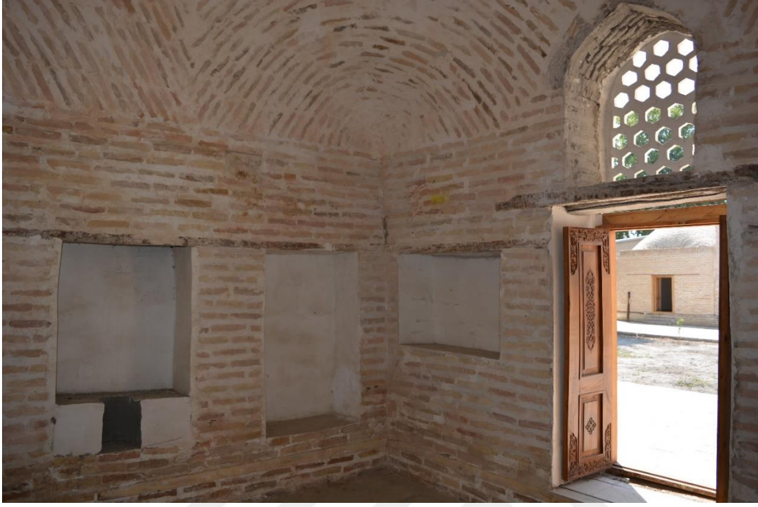
Fotoğraf 2.167. Kubbe ile örtülü hücre odası görünümü.
