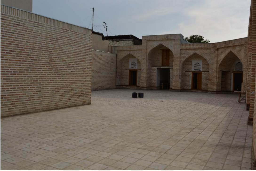
Fotoğraf 2.36. Batı cephe görünümü.
