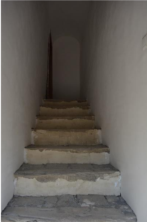
Fotoğraf 2.146. Dershane bölümünün ikinci katına çıkış merdiveni görünümü.
