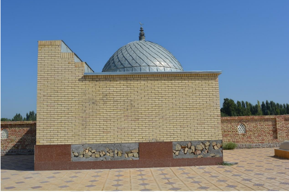
Fotoğraf 2.204. Güney cephe görünümü.
