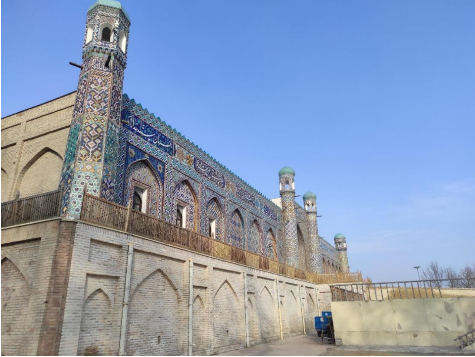
Fotoğraf 2.313. Doğu cephenin zeminden görünümü.
