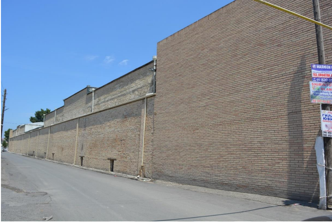
Fotoğraf 2.3. Batı cephe görünümü.
