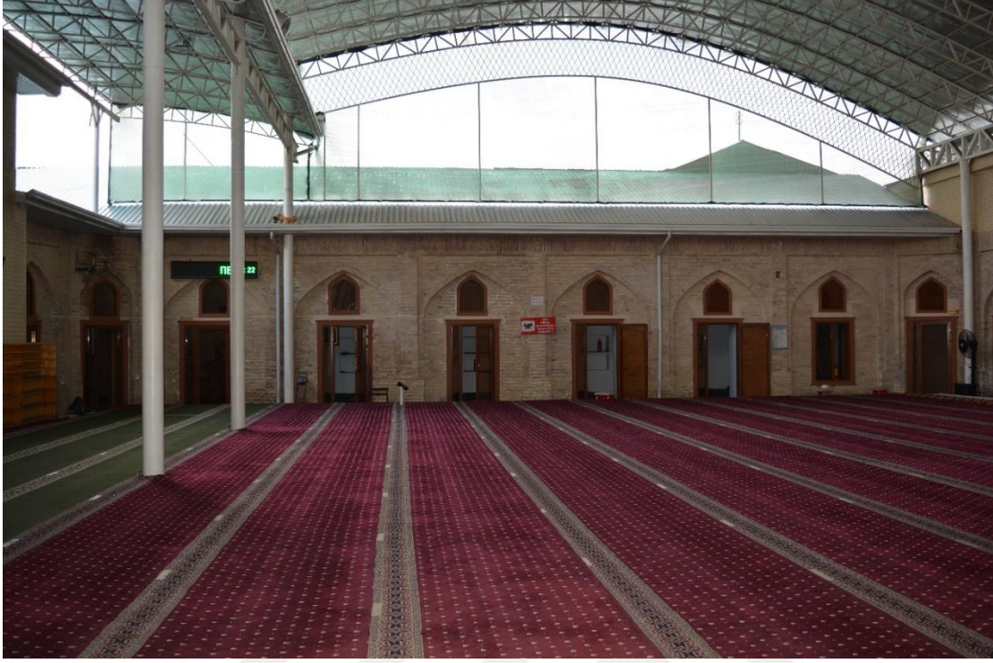
Fotoğraf 2.183. Avludan güney cephede yer alan hücre odalarının görünümü.
