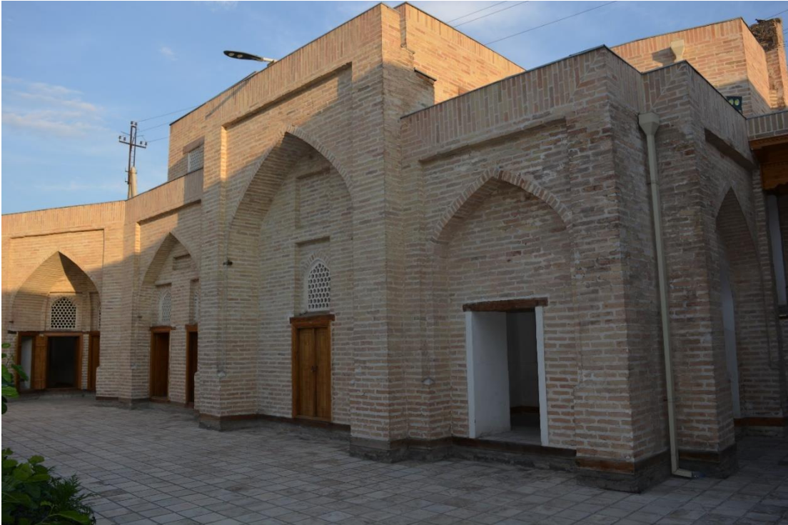
Fotoğraf 2.73. Güney cephe görünümü.
