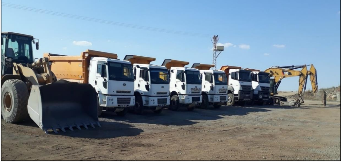
Şekil 3.10 Bağlar Belediyesi bazalt agrega tesisleri makine parkı 1
