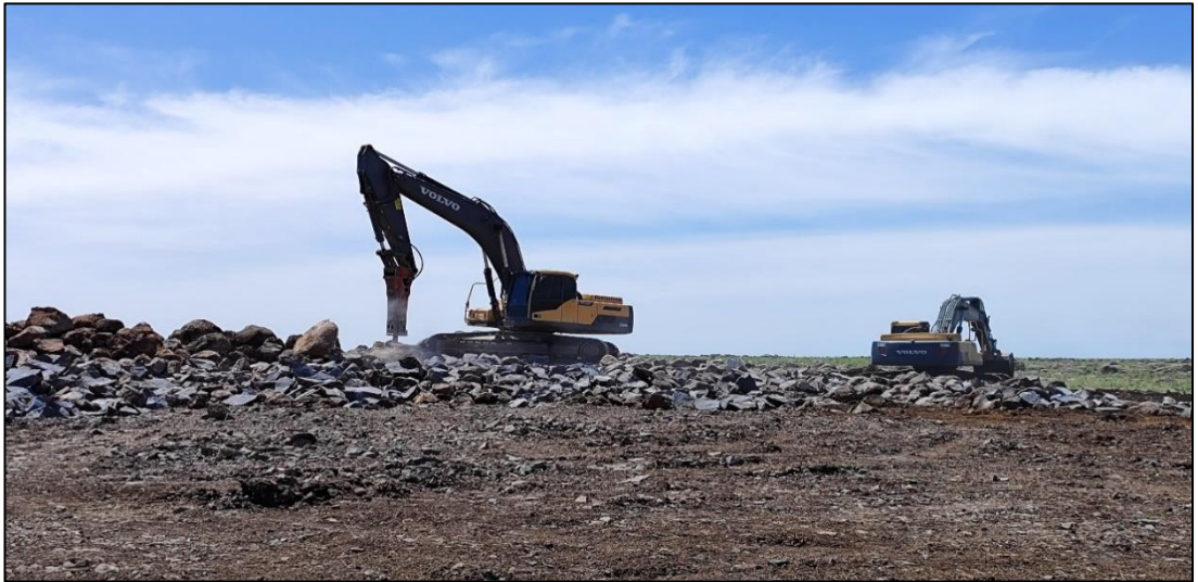
Şekil 3.3 Bazaltların kapladığı alandaki taşların kırılması
