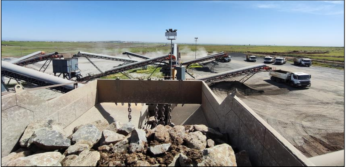
Şekil 3.5 Bazalt agregası tesisleri bunker ve bantların görünümü
