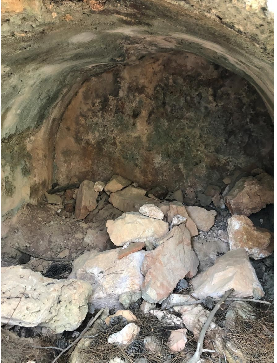
M88 İçten Görünüm
