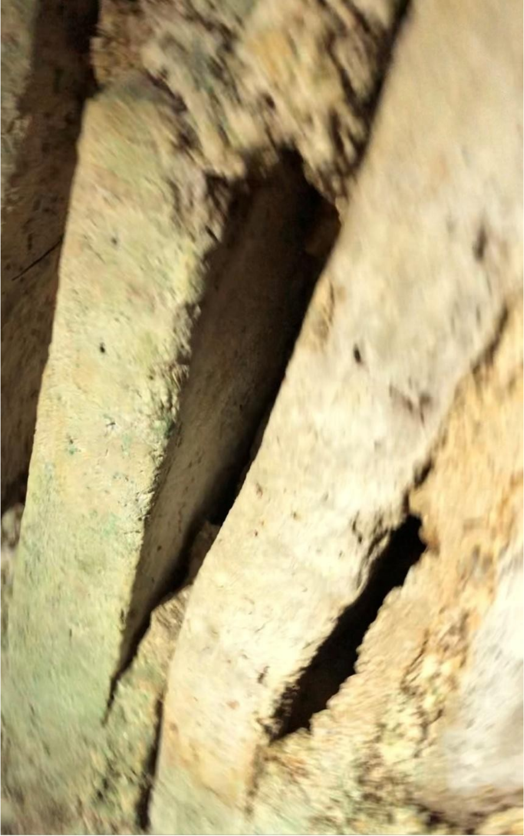
Hyposorion mezarın diklemesine örülen tuğla tonoz çatısı
