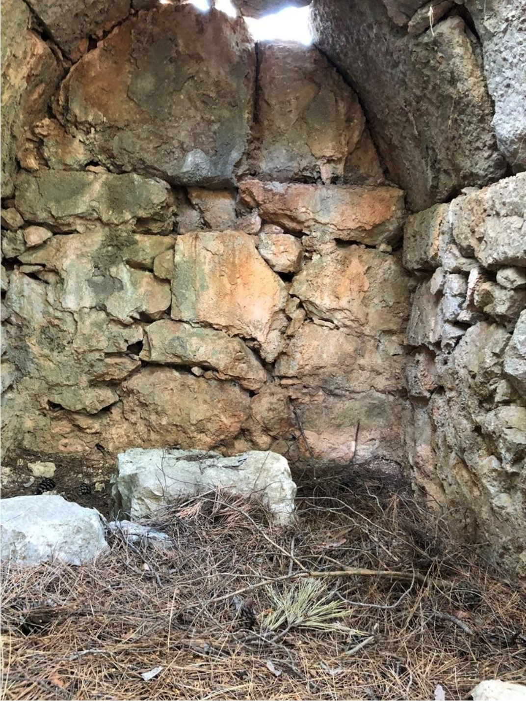
M45 İçten Görünüm
