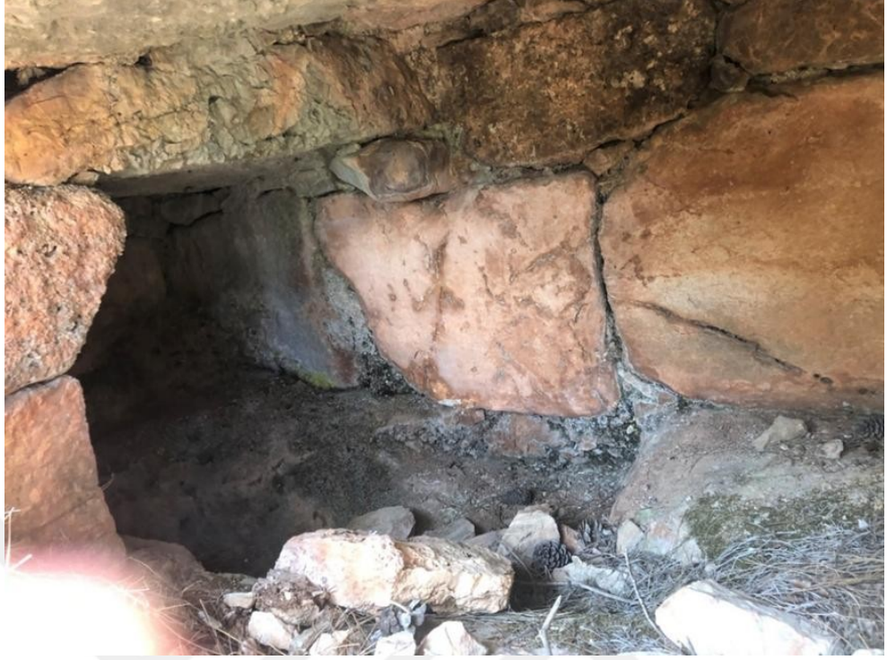
M123 İçten Görünüm
