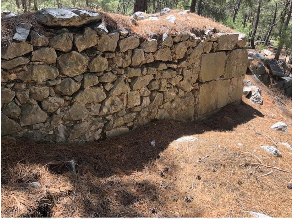
M62 Kuzey Duvar
