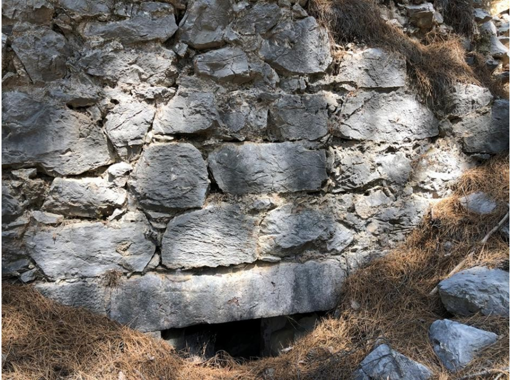
M62 Güney Duvar ve Hyposorion tuğla tonoz çatı detayı
