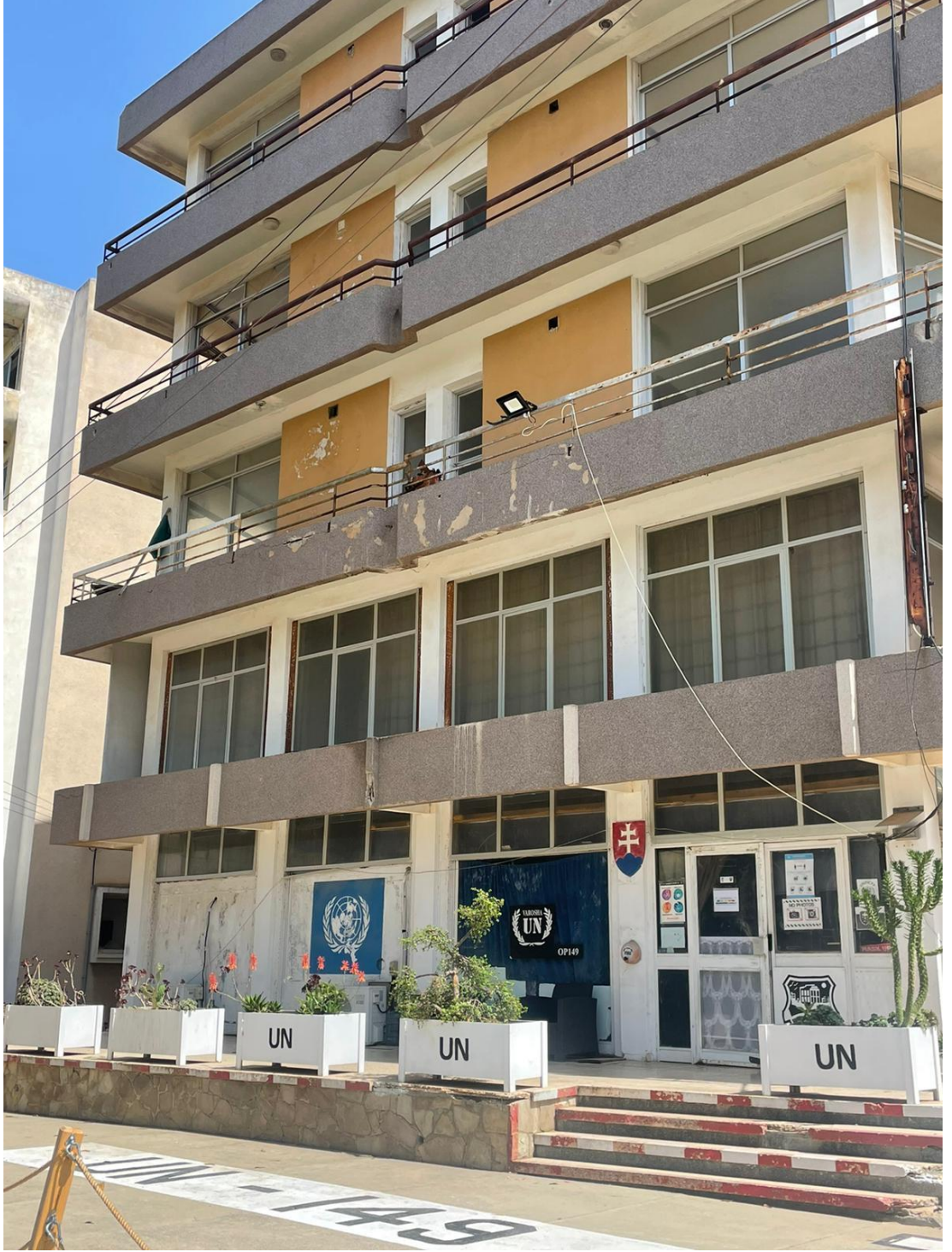
Kapalı Maraş-Dikelya yolu üzerinde birleşmiş milletler kontrol noktası 2022 (kaynak: bizzat çekim)
