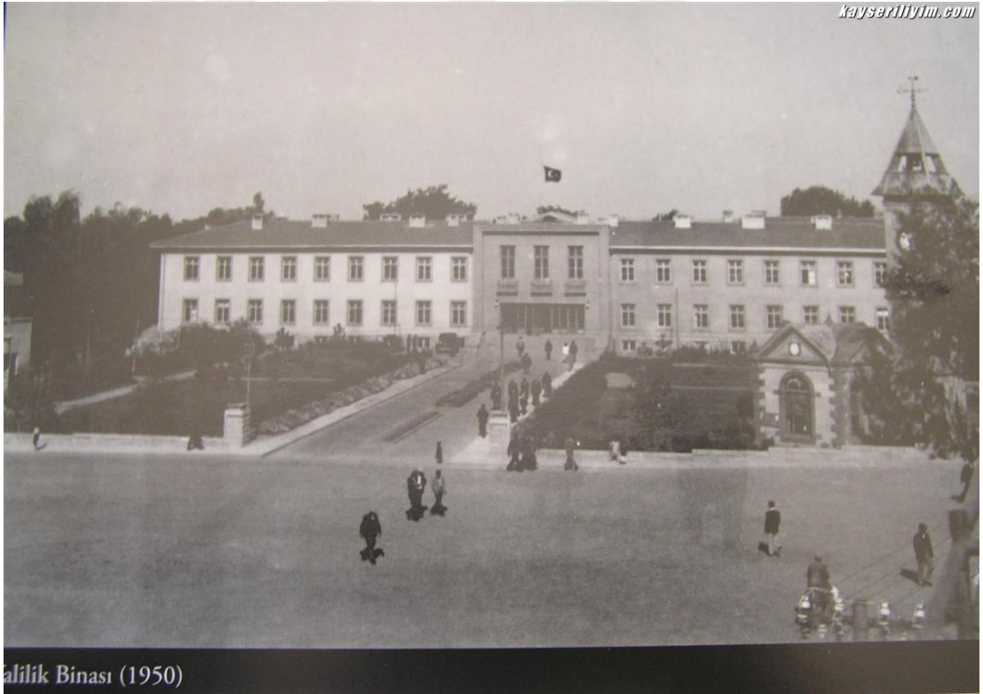
Resim 7. 1950 yılında Valilik Binasının Durumu 912
