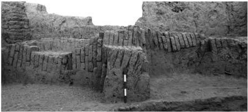
Fig.4.53: Anıtsal Yapının Yıkılan Duvarlarının Detayları (Ökse ve Görmüş, Figs. 3,4,5)
