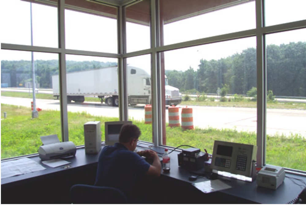
Resim 2.10. Anayol üzerindeki WIM istasyonundaki ölçüm evi
