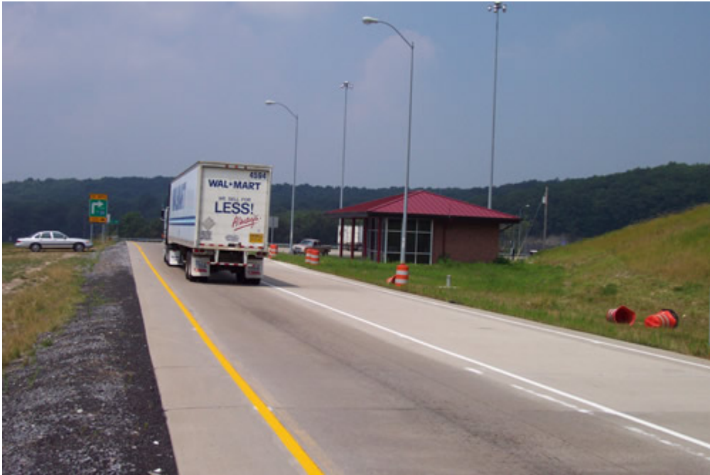
Resim 2.6. Anayol üzerindeki WIM istasyonunda yeterliliği sağlayan araçların yönlendirildiği By-Pass şeridi [1]
