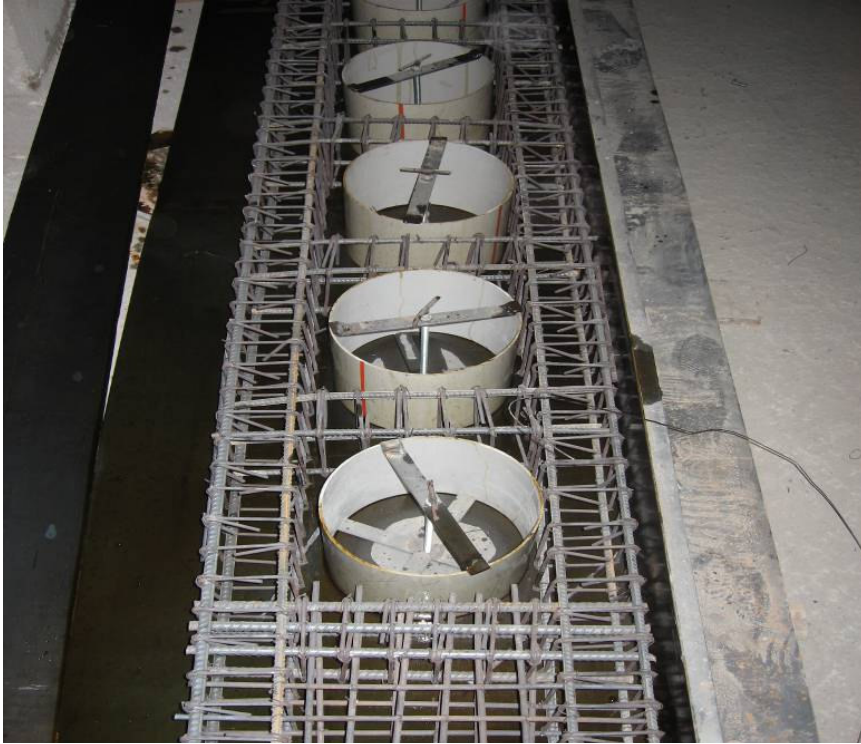
Resim 4.2. Kiriş kalıbına yerleştirilmiş dairesel boşluk kalıbı
