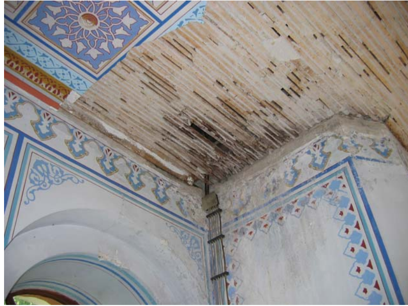
Fotoğraf No: 13 Mahfil minare girişi tavanı
