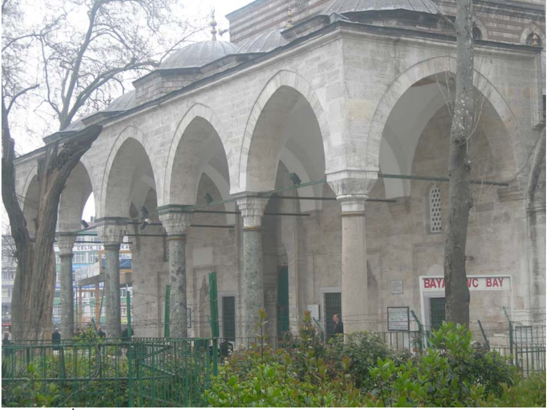
Resim 95: İstanbul Murad Paşa Camii, son cemaat yeri.
