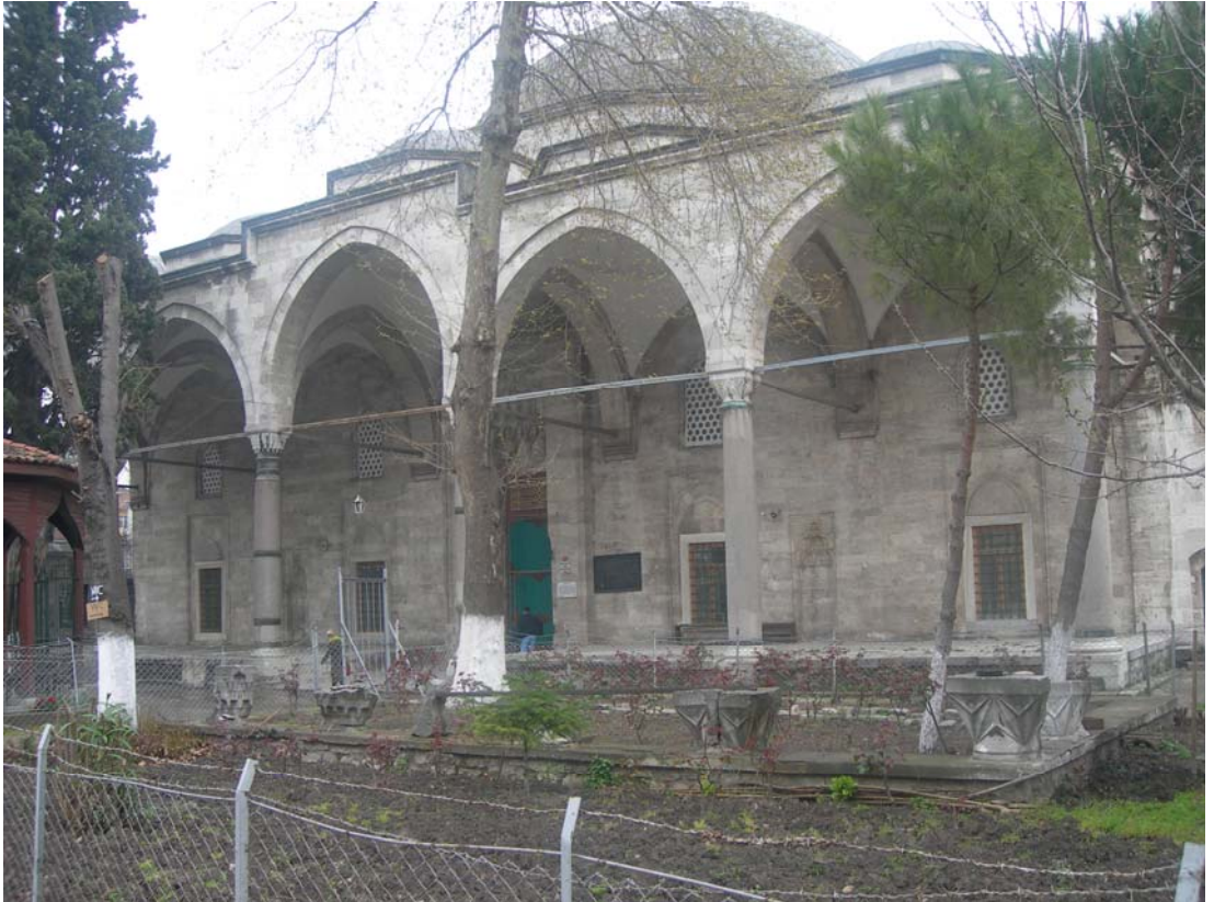
Resim 104: İstanbul Davud Paşa Camii, giriş cephesi genel görünüş.
