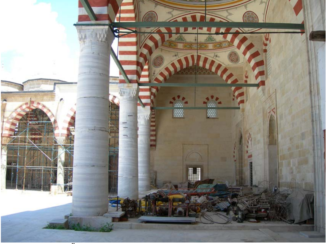
Resim 75: Edirne Üç Şerefeli Camii, giriş cephesi.
