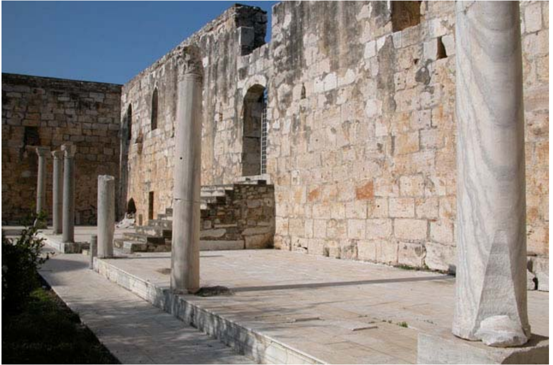
Resim 2: Selçuk İsa Bey Camii, asıl ibadet mekânı kuzey cephesi.
