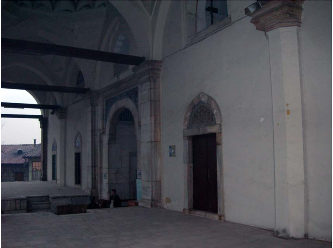
Resim 38: Bursa Muradiye Cami, giriş cephesi.
