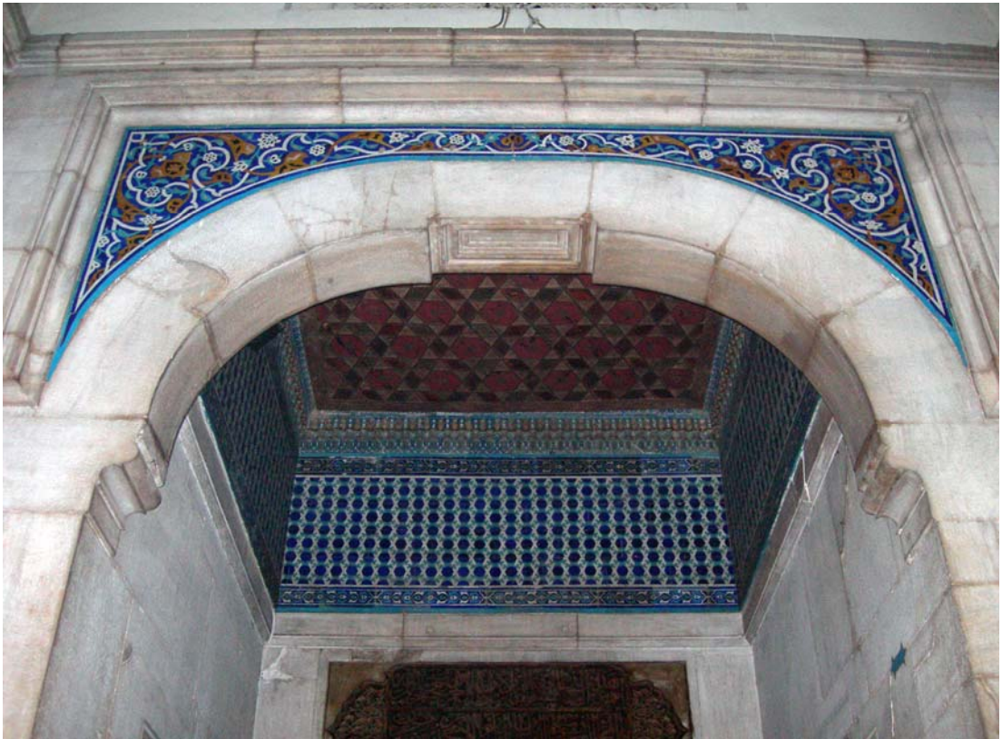
Resim 45: Bursa Muradiye Camii, cümle kapısı kuşatma kemeri.
