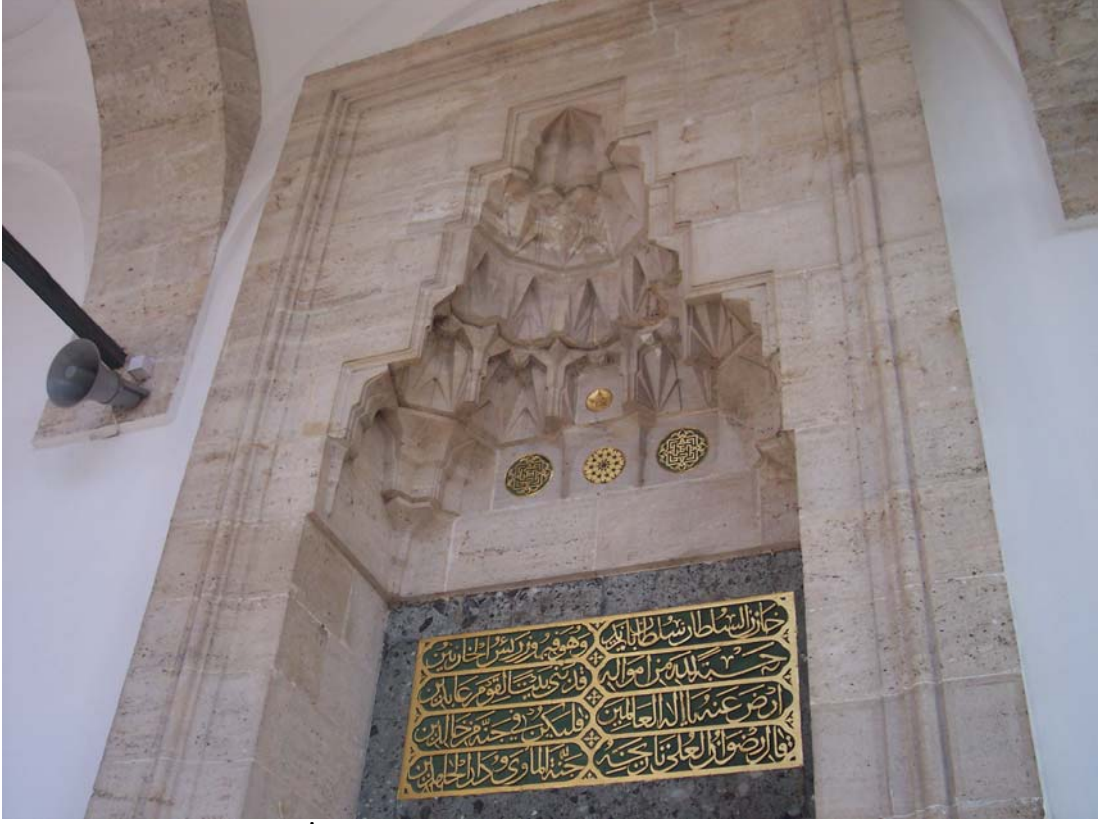
Resim 112: İstanbul Firuz Ağa Camii, cümle kapısı kavsarası.
