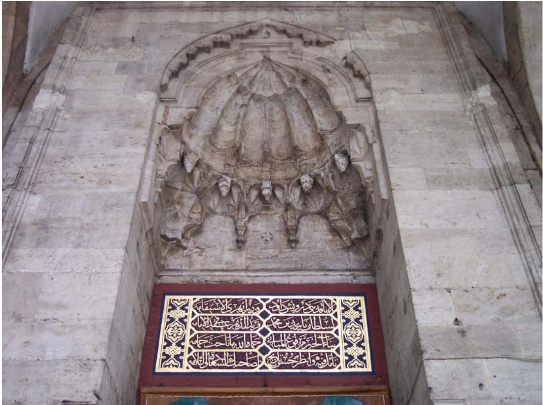
Resim 106: İstanbul Davud Paşa Camii, cümle kapısı kavsarası ve kitabe.
