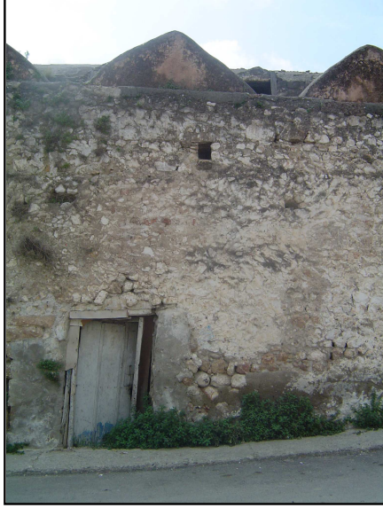
Resim 4.5. Yan cephe a
