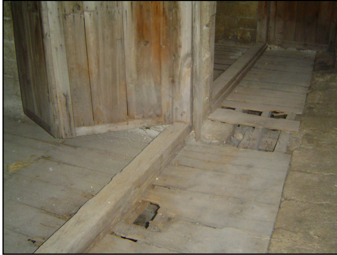
Resim 4.18. Ahşap zemin döşemesi
