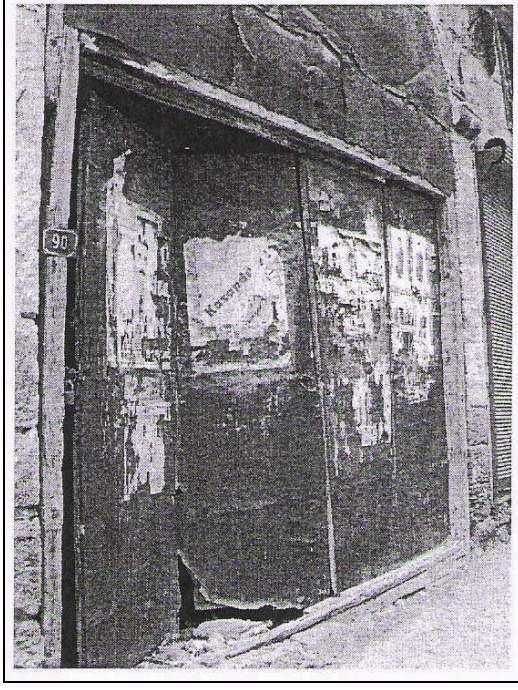
Resim 5.6.Özgün dükkan katlanır doğrama örneği
