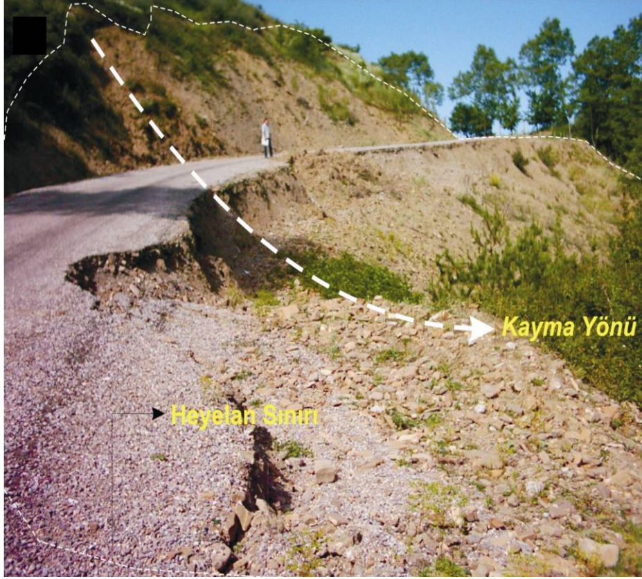
Şekil 5.3. Çalışma alanında gözlenen dairesel kayma türündeki heyelanlara ilişkin bir örnek.
