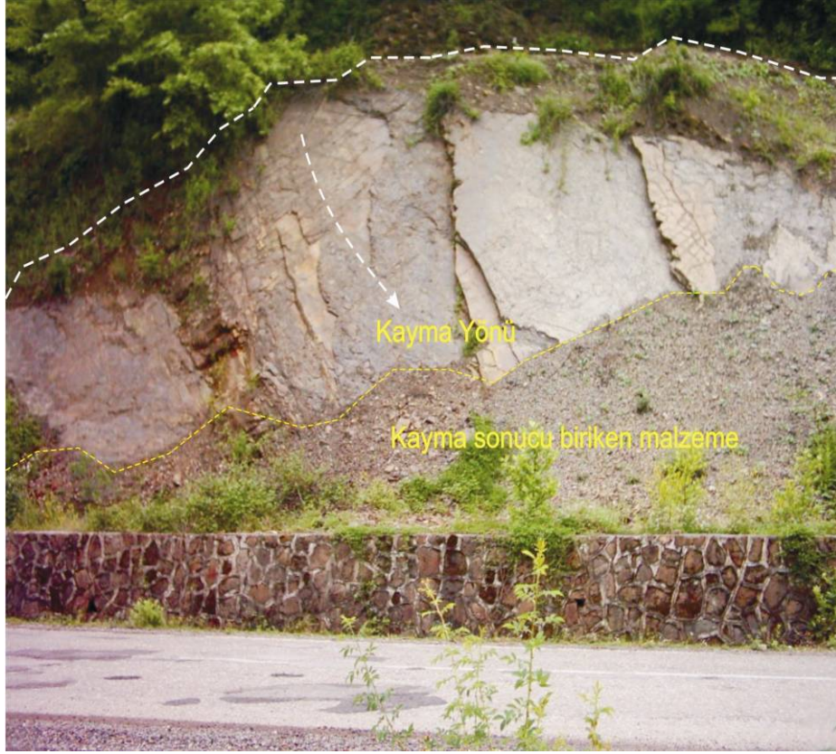
Şekil 5.5. Çalışma alanında gözlenen toprak kayması türündeki heyelanlara ilişkin bir örnek.
