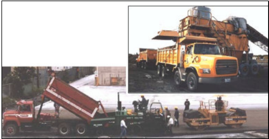
Şekil 2.1. SSB’nin taşınması ve yerleştirilmesi
