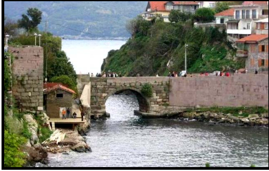
Şekil 4.14 Amasra-Kemere Köprüsü (Anonim 2007a)
