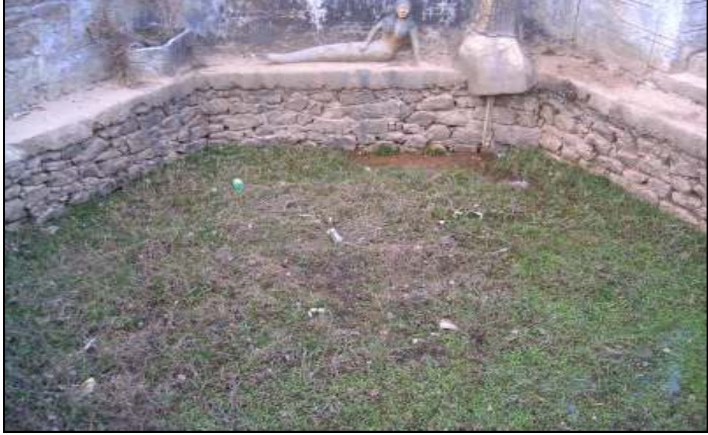
Şekil 5.11. Ulupınar kaynağının görünümü. (Aralık 2006)
