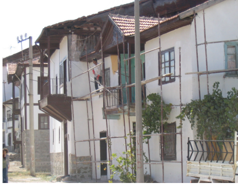
Resim 1.7. GÜdöl'de onarım çalışmaları
