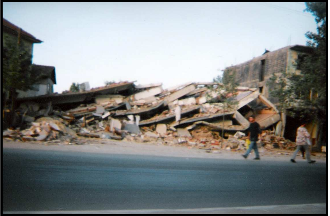
Resim 11: Binaların Yıkılması ve Enkazların Kaldırılması Büyük Çevresel Sorun Olmuştur (19 Ağustos 1999).
