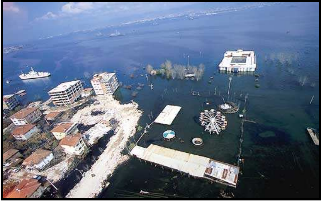
Resim 15: Gölcükte Deprem Sonrası Çökme ve Kaymalar Sonucu Suya Gömülen Kamu Binaları (Gölcük Belediye Arşivi)
