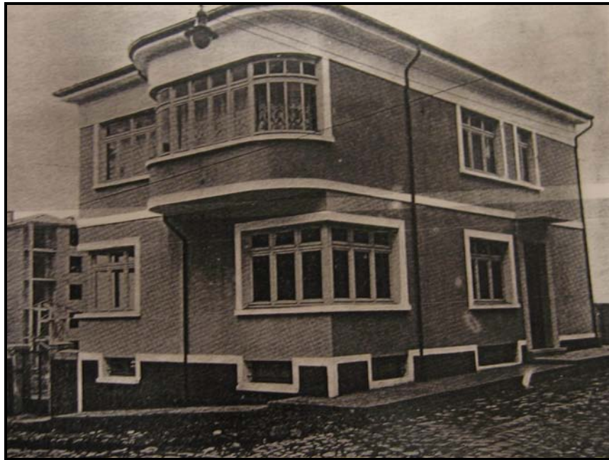
Resim 91 : İhsan Bey Evi, esas cephesi, Kadıköy. Faruk GALİP'ten.
