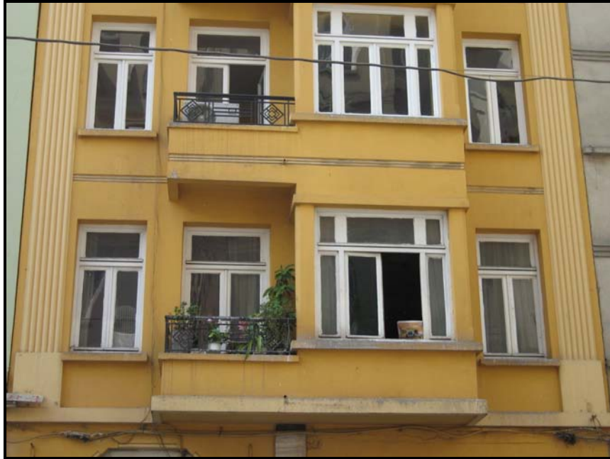
Resim 128 : Gevrek Apartman›, esas cephesi, Talimhane. Derya ÖZAKBAŞ'tan.
