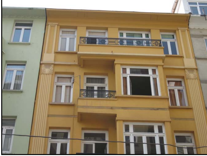
Resim 127 : Gevrek Apartman›, esas cephesi, Talimhane. Derya ÖZAKBAŞ'tan.
