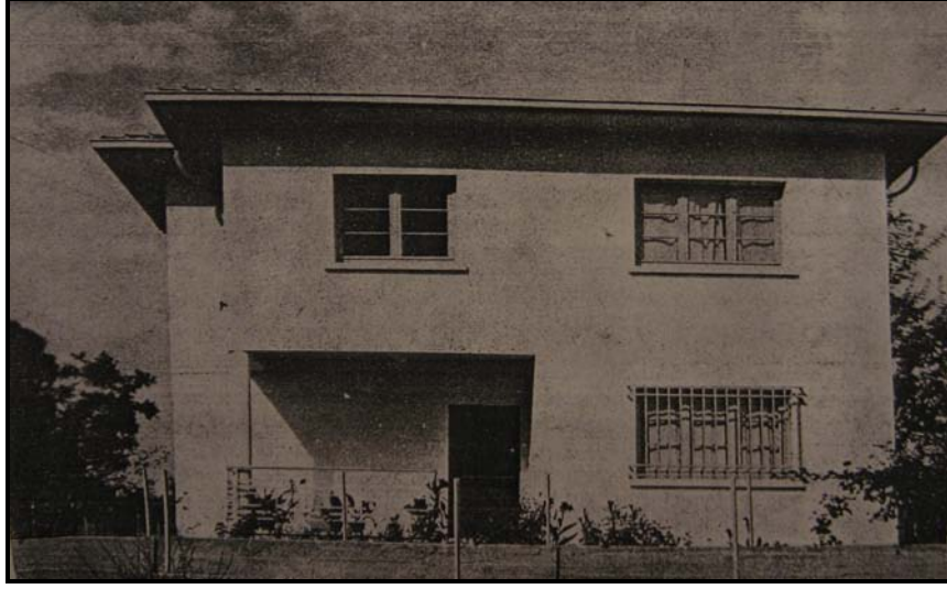
Resim 125 : Kira Evi, giriş cephesi, Feneryolu. Adil DENKTAŞ'tan.
