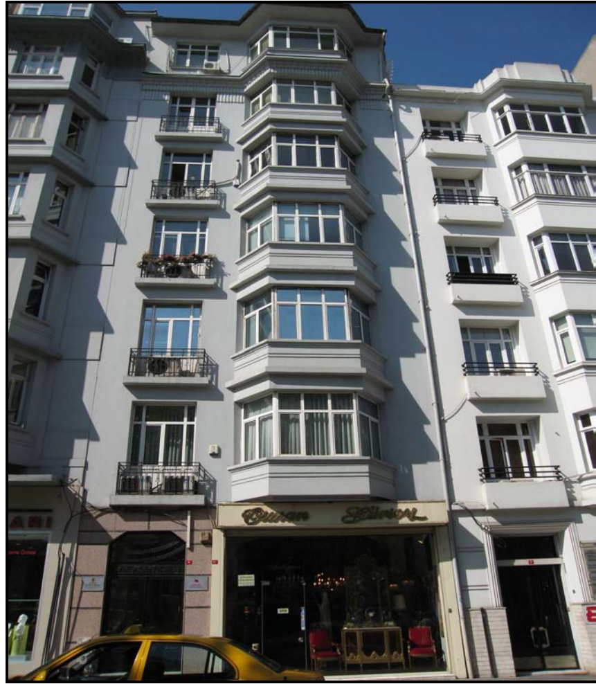
Resim 65 : Platin Apartmanı, esas cephesi, Gümüşsuyu. Derya ÖZAKBAŞ'tan.
