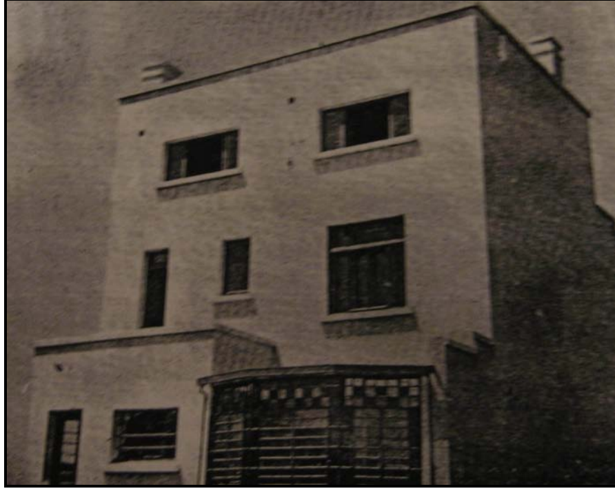
Resim 6 : Sıdıka Haydar Hanım Evi, arka cephesi, Rızapaşa, Kadıköy. Faruk GALİP'ten.
