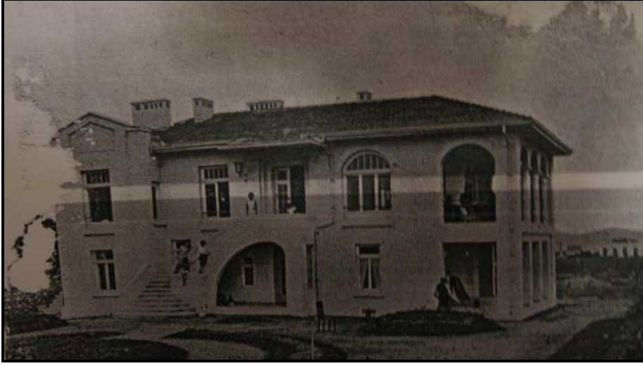
Resim 81 : Mr. L. Varber Villas›, esas cephesi, Suadiye Plaj›. Vedat [TEK]’ten.
