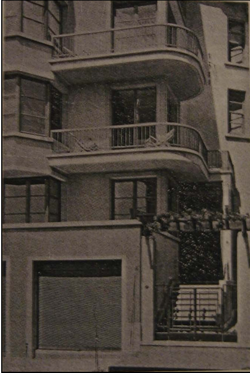
Resim 78 : Hüsnü Bey Apartman›, esas cephesi, Nişantaşı. Nizamettin HÜSNÜ'den.
