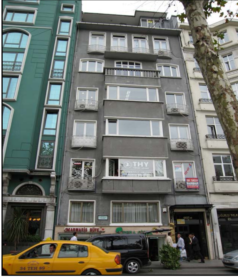
Resim 58 : Gezi Apartmanı, esas cephesi, Gümüşsuyu. Derya ÖZAKBAŞ'tan.
