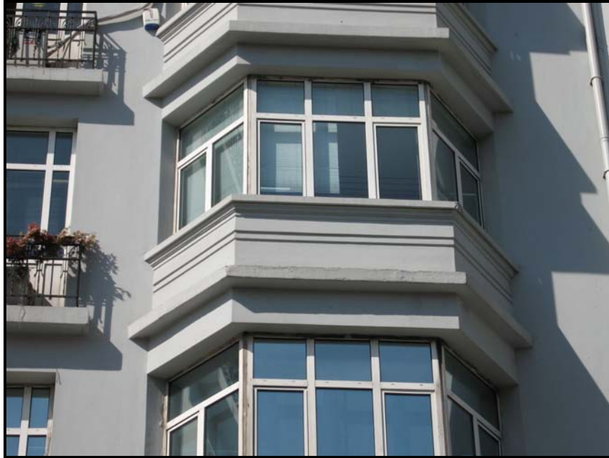
Resim 67 : Platin Apartman», esas cephedeki kapalı çıkma, Gümüşsuyu. Derya ÖZAKBAŞ'tan.
