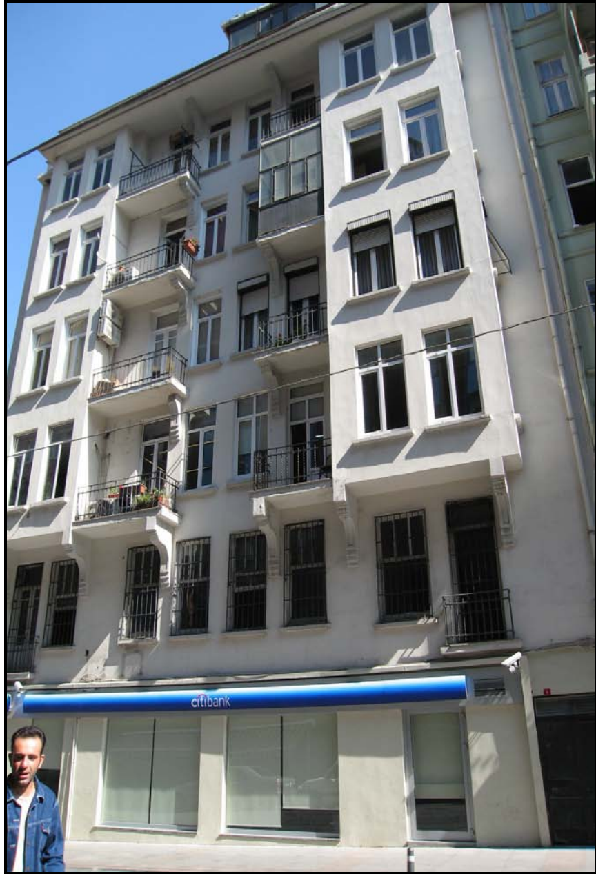
Resim 74 : Cumhuriyet Apartmanı, arka cephesi, Gümüşsuyu. Derya ÖZAKBAŞ'tan.
