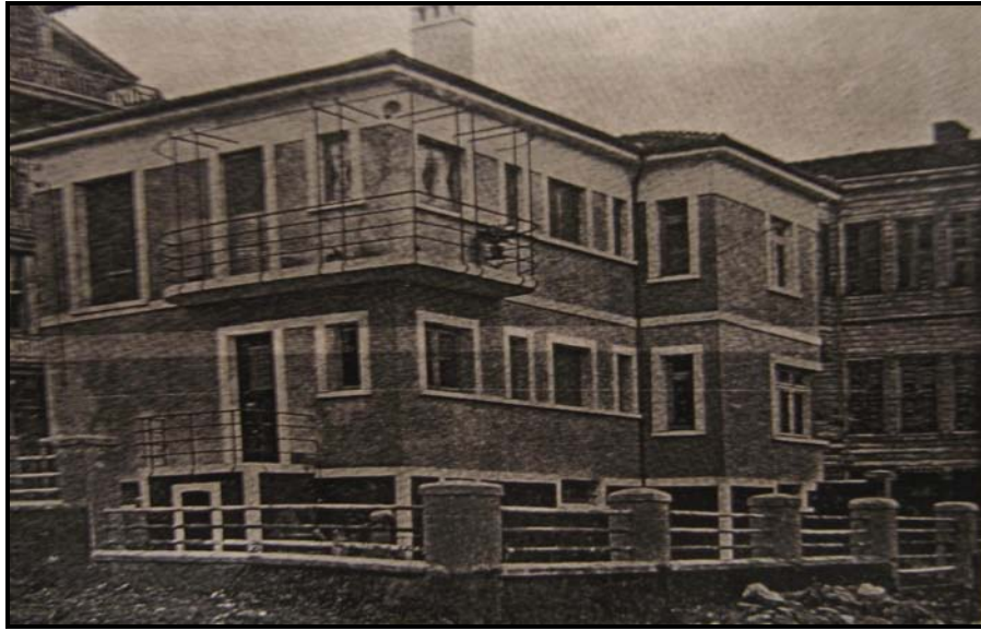
Resim 93 : İhsan Bey Evi, arka cephesi, Kadıköy. Faruk GALİP'ten.
