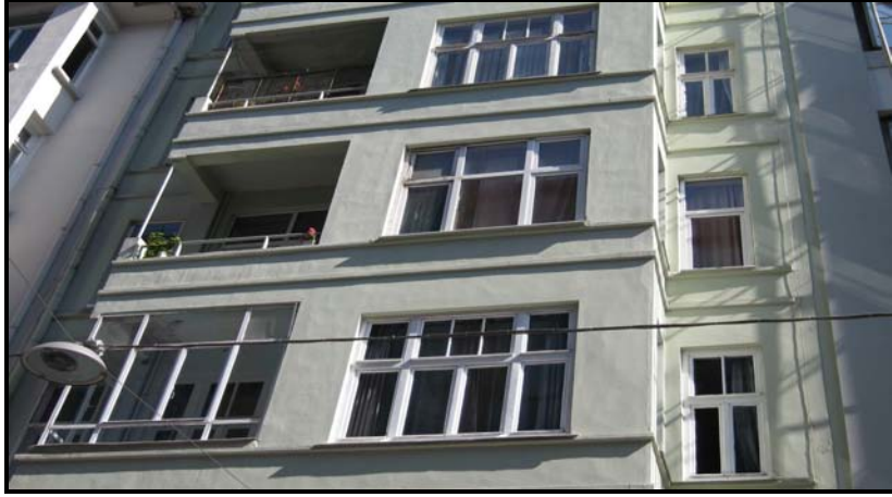
Resim 136 : İnkılâp Apartmanı, arka cepheden detay, Gümüşsuyu. Derya ÖZAKBAŞ'tan.
