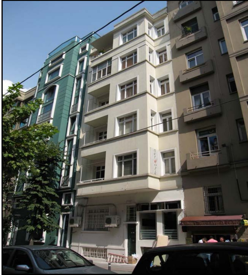
Resim 30 : İstiklâl Apartmanı, arka cephesi, Gümüşsuyu. Derya ÖZAKBAŞ'tan.
