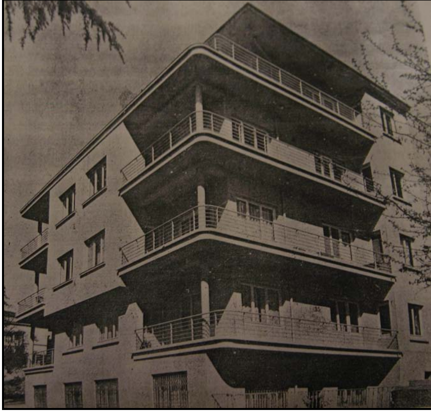
Resim 61 : Kira Evi, yan cephesi, Kadıköy. Zeki SAYAR'dan.
