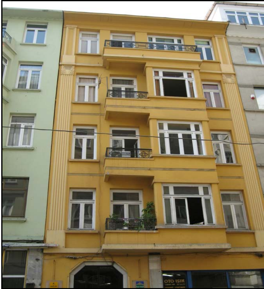
Resim 126 : Gevrek Apartman›, esas cephesi, Talimhane. Derya ÖZAKBAŞ'tan.
