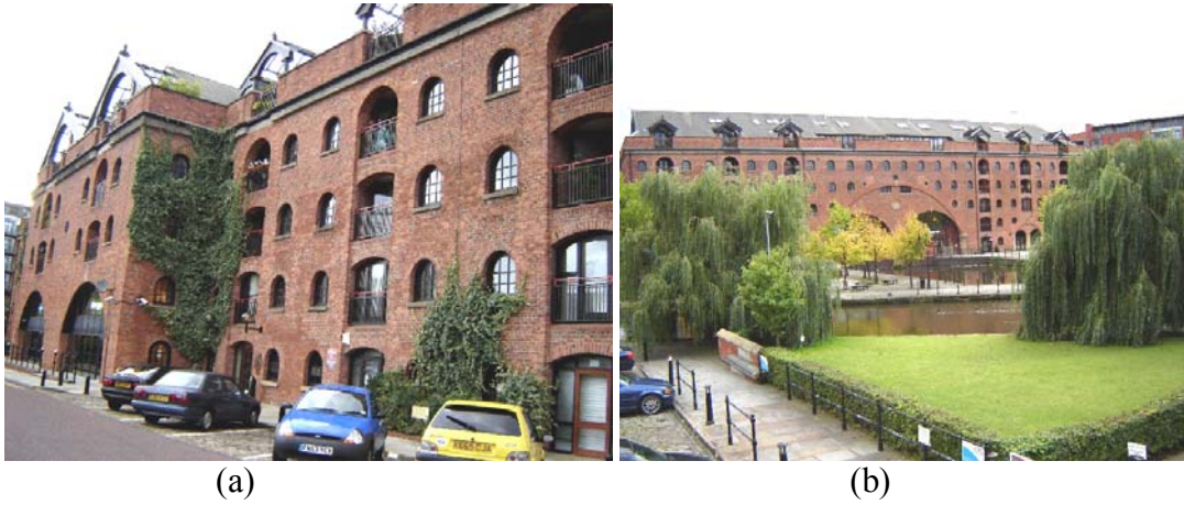
Resim 4.28. Konut, alışveriş ve ofis olarak işlevlendirilen Middle Warehouse yapısı [Mengüşoğlu, 2006]
