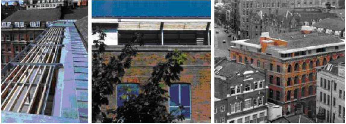
Resim 4.38. Çatı etrafında devam eden metal saçak silmesi [Powell, 2001]
