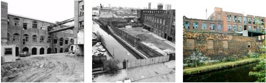
Resim 4.32. Yapıların dönüşüm uygulamasının öncesindeki durumları
