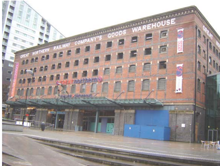
Resim 4.14. Great Northern Railway Warehouse yapısının ön görünümü
