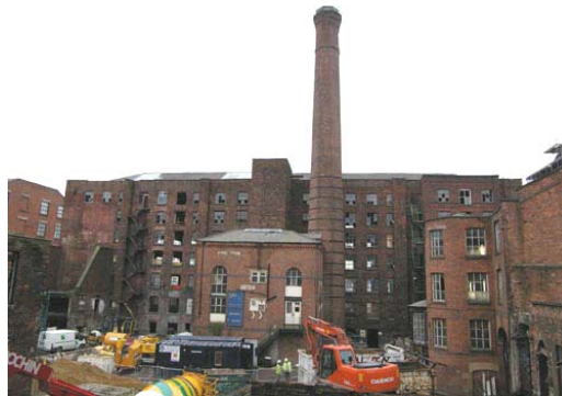
Resim 4.6. Merkezi bir avlu etrafında gruplaşan fabrika ve depo yapılarından oluşan Murray's Mill, Manchester pamuk fabrikası kompleksinde Old Mill yapısı cephesi
