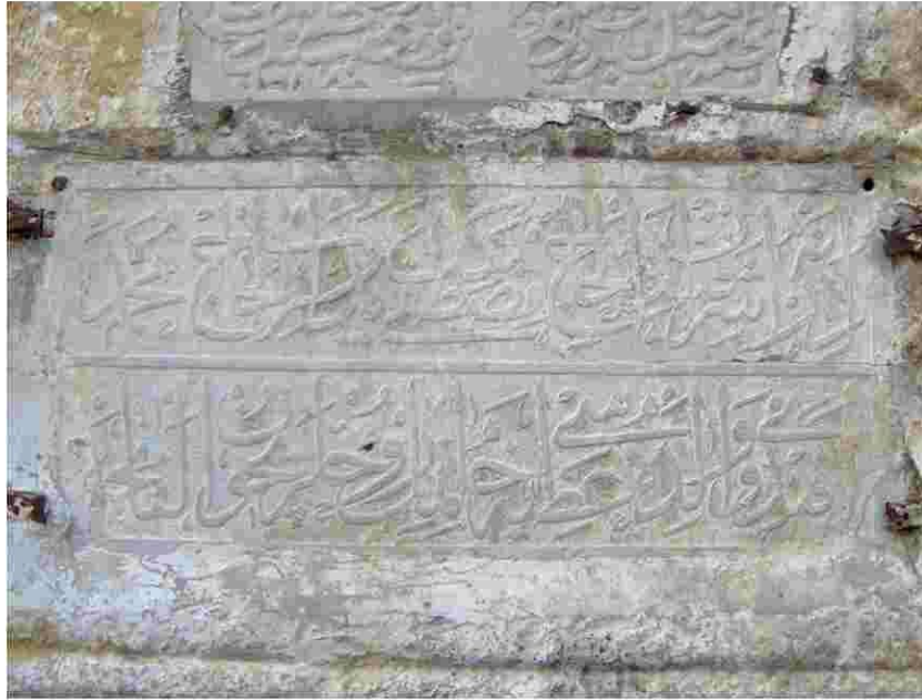
Fot.10: Sinan Ağa (Cavidan Hanım) Çeşmesi onarım kitabesi
