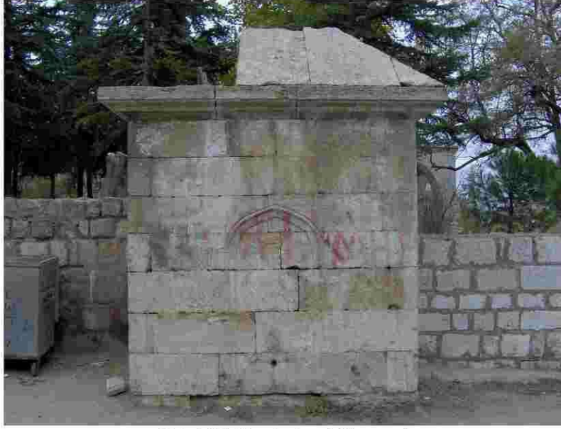
Fot.104: Beylerbeyi Çeşmesi
