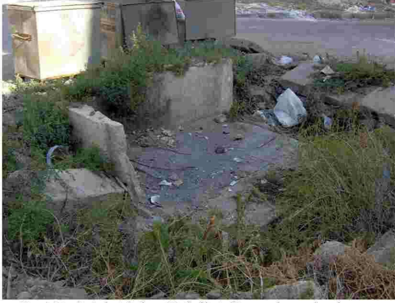
Fot.154: Soğuk ( Sultan II. Selim) Çeşme, bugünkü durumu
