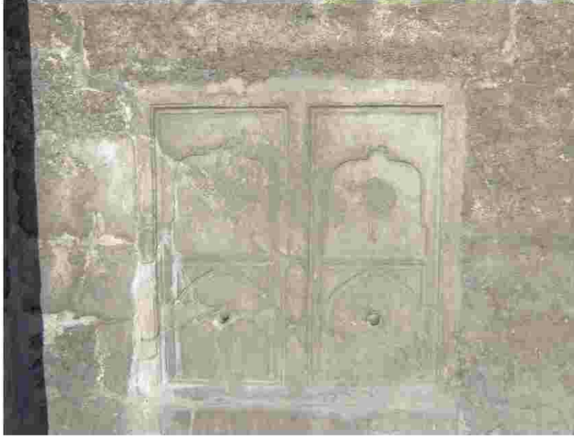
Fot.31: Hacı Müslim Çeşmesi ayna taşları
