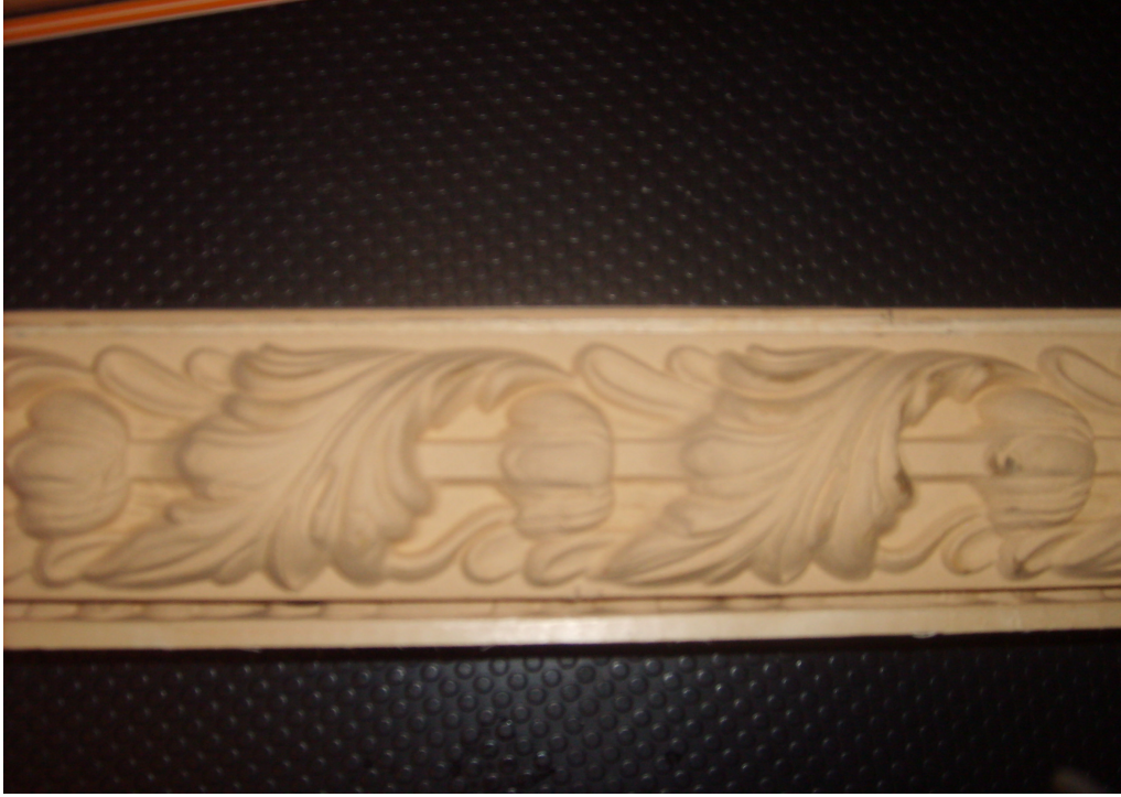
Resim 5.29. Sütunlarda kullanılan macunla yapılan oyma [28]
