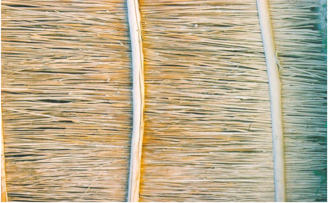
Şekil 4.13 Kargı kamışının çatıda izolasyon malzemesi olarak kullanımı (Çavuşcu Beldesi / Ilgın)
