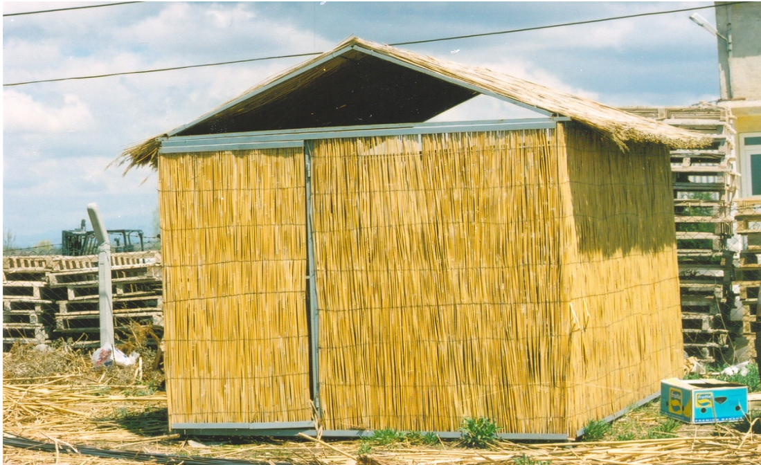
Şekil 5.13 Bitkisel hammadde kullanılarak oluşturulan ev tipi korunak (Ali Barut atölyesi)
