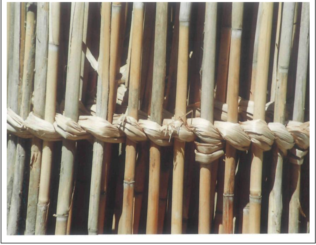
Şekil 4.46 Kenetleme tekniği ile yapılan balık kafesi ayrıntısı(Yeşildağ Beldesi / Beyşehir)
