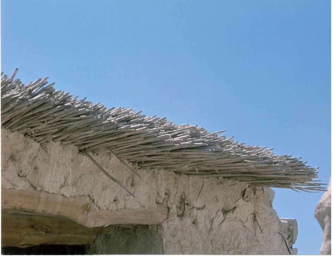
Şekil 4.67 Kargı kamışının damlarda koruyucu olarak kullanımı (Çavuşçu Köyü / Ilgın)
