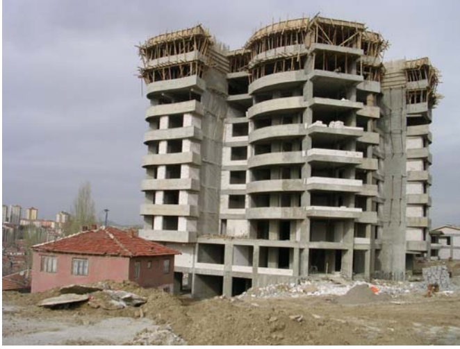
Resim 5.8. Cadde sonunda bulunan sitenin inşaat aşaması [Canan Özer özel çekim, 2005]
