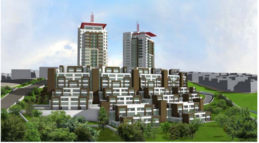
Şekil 4.1. Dikmen Vadisi III. Etap teras evlerden bir görünüm [Kuzu Grup arşivi]
