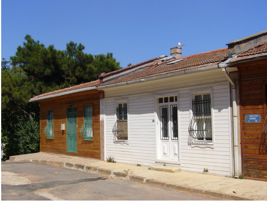
Resim no: 10. Çakıltaşı Sokak, No: 4. Ön cephe.
