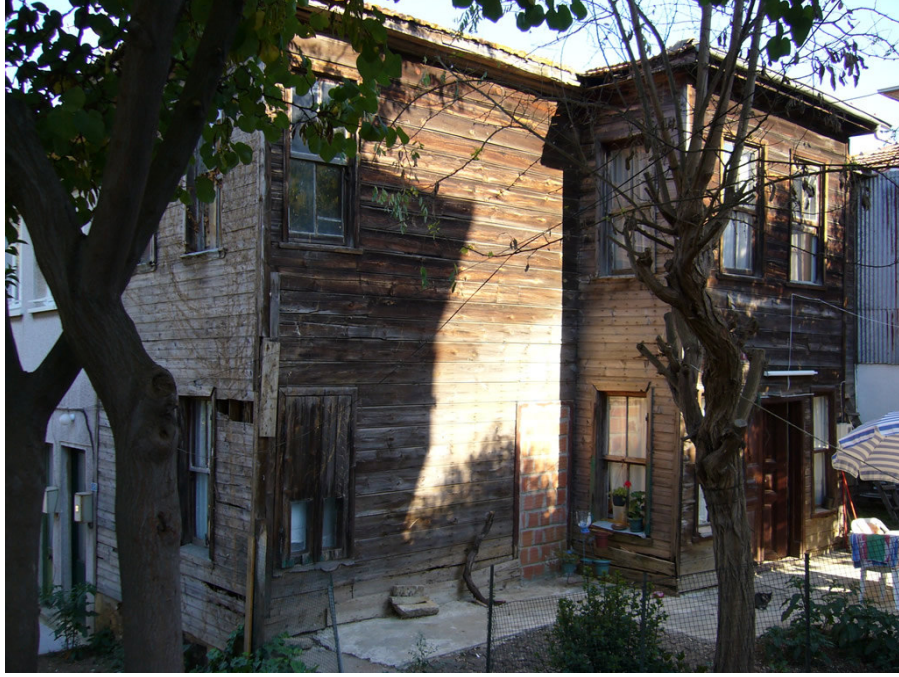
Resim no: 8. Burgaz Çayır Sokak, No: 8. Ön cephe ve yan cephe.
