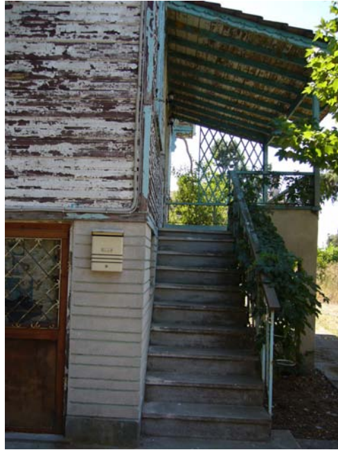
Resim no: 25A. Esentepe Yolu, No:2. Giriş bölümü.
