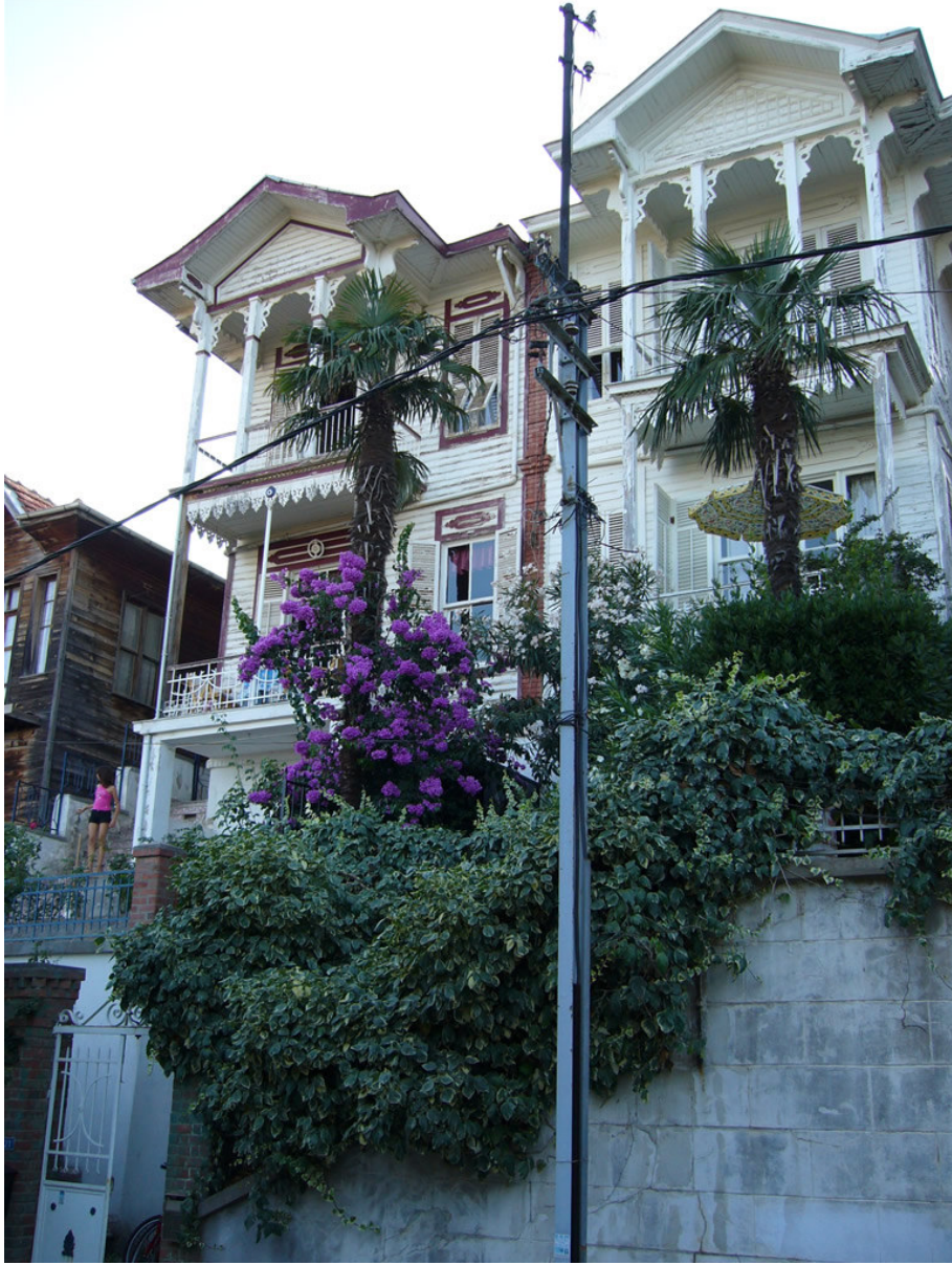
Resim no: 1. Andriomenos Köşkü I. Mehtap Sokak, No:21. Ön cephe.
