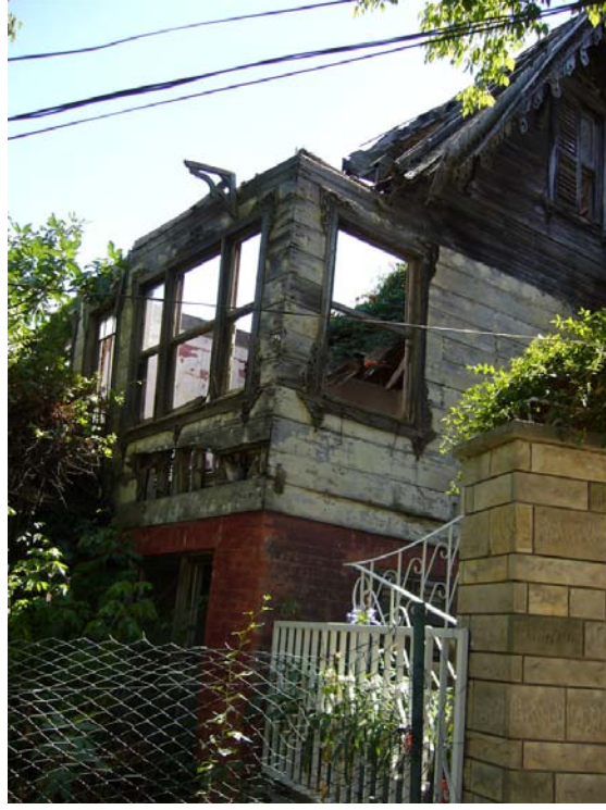
Resim no: 67A. Burgaz Çayır Sokak, No: Belli değil. Yan cephe.
