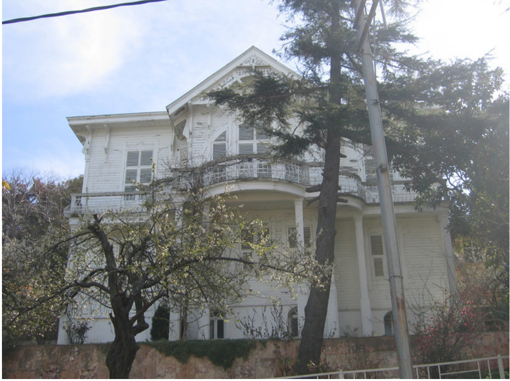
Resim no: 73. Girav Köşkü. Gönüllü Caddesi, No:81. Ön cephe.
