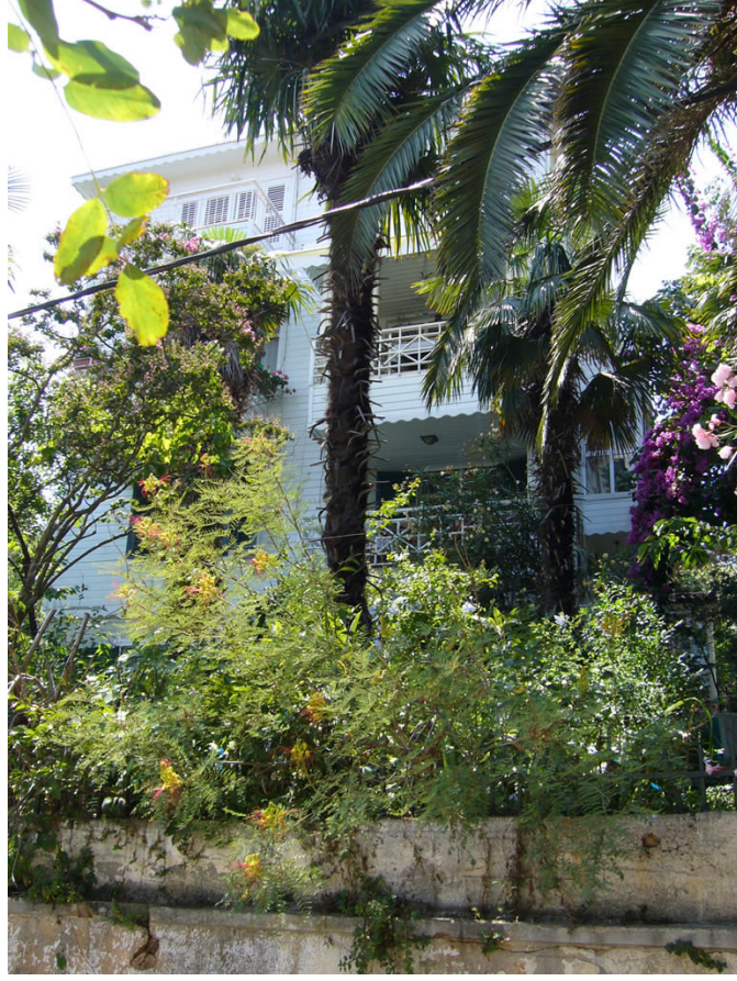
Resim no: 47. Sarnıç Sokak, No:19. Ön cephe.
