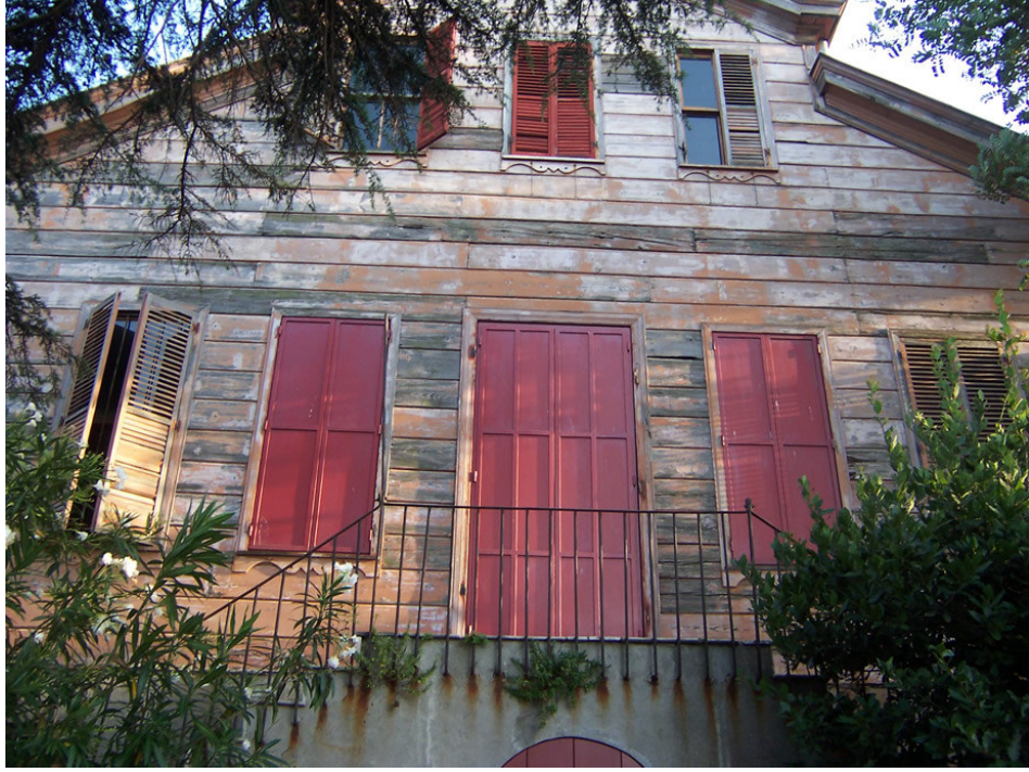
Resim no: 6C. Barnas Evi. Gönüllü Caddesi, No: 62. Arka cephe.
