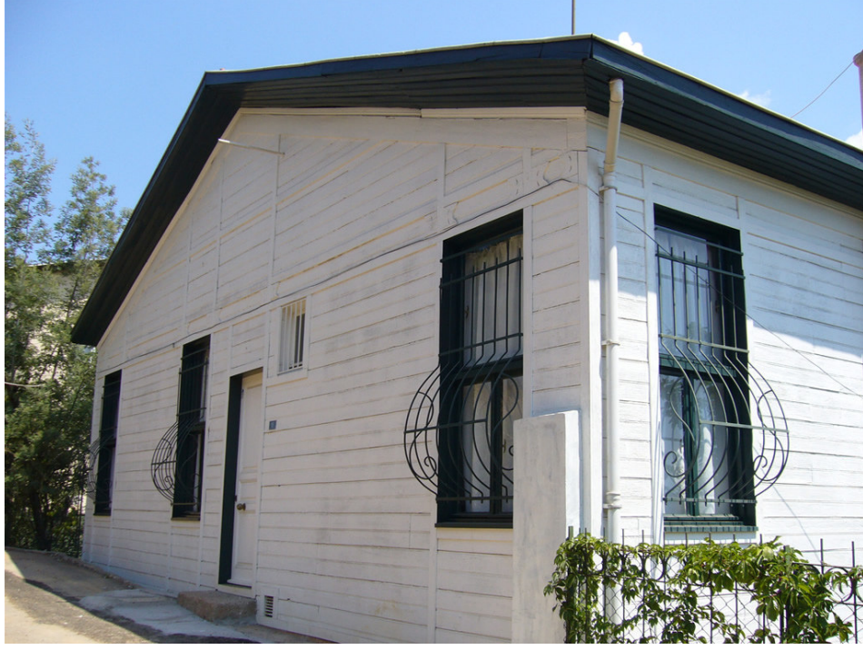
Resim no: 4. Azizler Sokak, No:15. Ön cephe.
