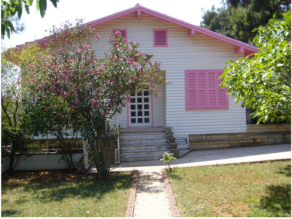
Resim no: 3. Azizler Sokak, No:11. Ön cephe.
