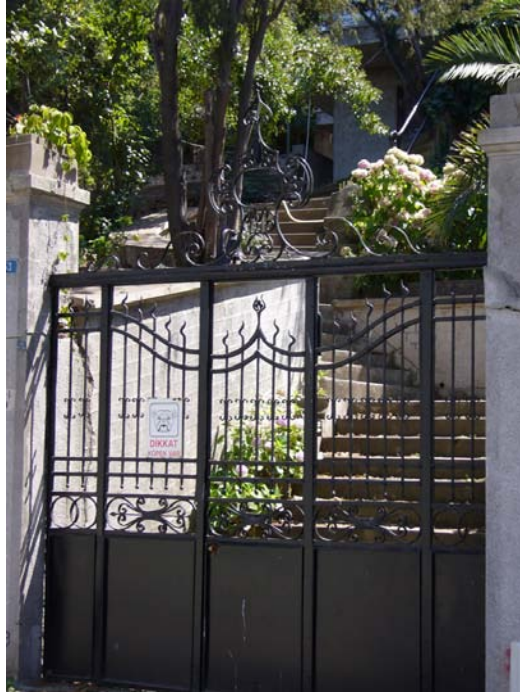
Resim no: 22A. Dimitrakopulo Köşkü I. Mehtap Sokak, No:53. Bahçe kapısı detayı.
