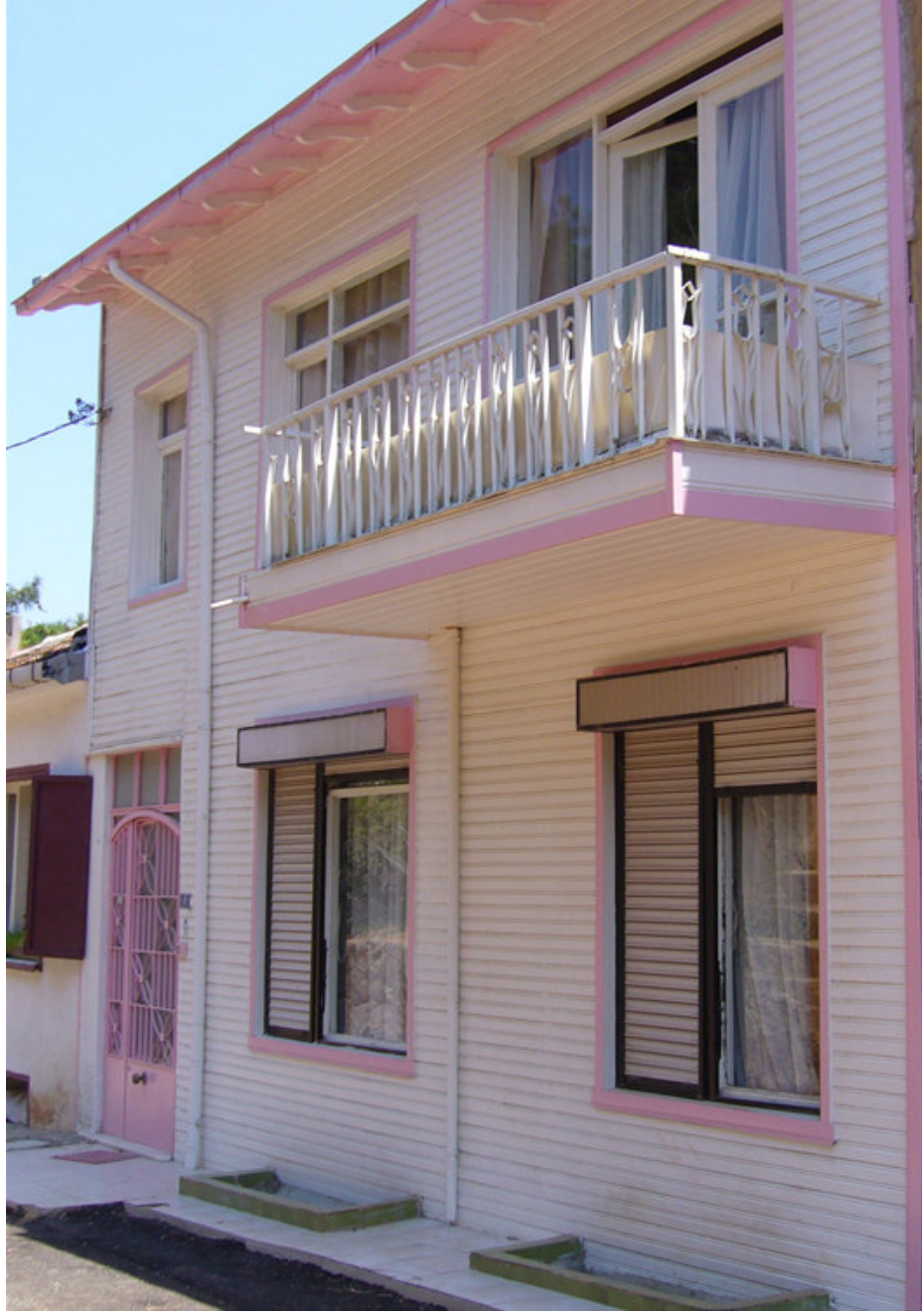
Resim no: 2. Azizler Sokak, No:9. Ön cephe.
