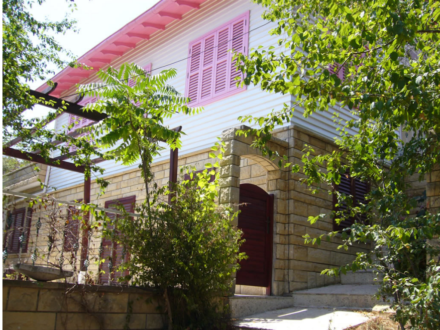
Resim no: 3A. Azizler Sokak, No:11. Sol yan cephe.
