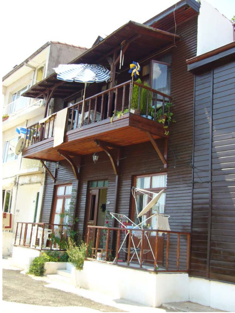
Resim no: 12. Çakıltaşı Sokak, No: 15. Ön cephe.
