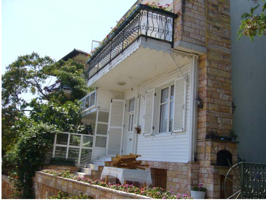
Resim no: 14. Çakıltaşı Sokak, No: 37. Ön cephe.
