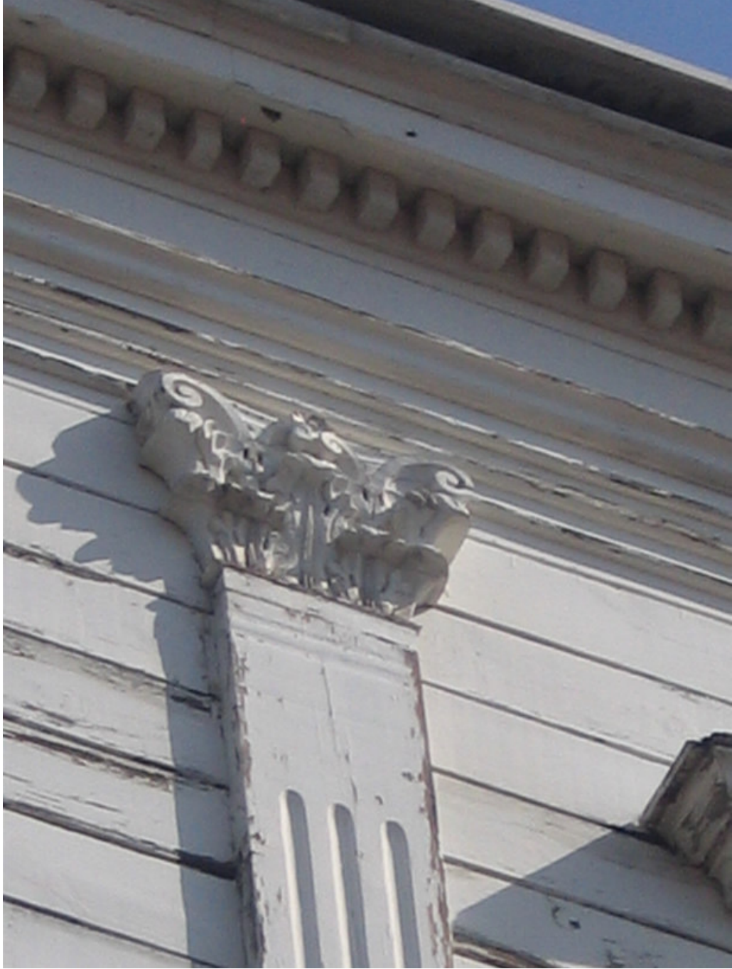
Resim no: 70D. Burgaz Palas. arşı - Yalı Caddesi, No:1. Pilastr detayı.
