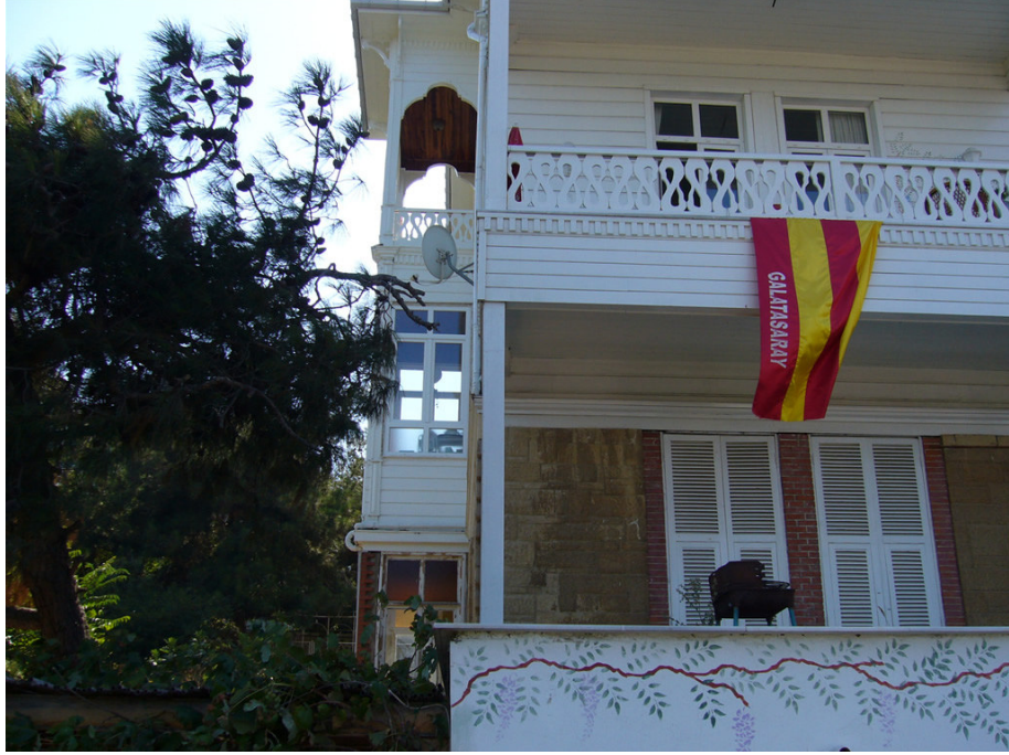
Resim no: 57B. Yediç Evleri. Mehtap Sokağı, No:37. Ön ve yan cephe balkon detayı.
