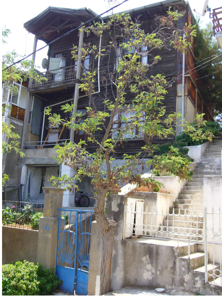
Resim no: 49. Sarnıç Sokak, No:27. Ön cephe.
