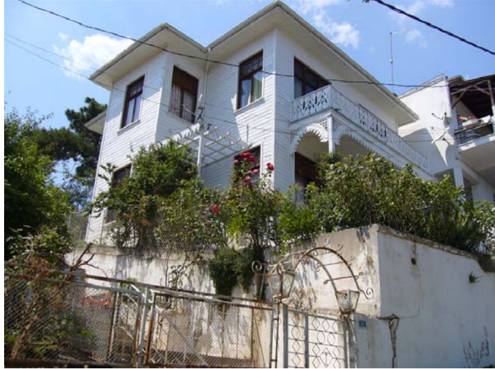
Resim no: 48A. Sarnıç Sokak, No:23. Ön cephe ve yan cephe.
