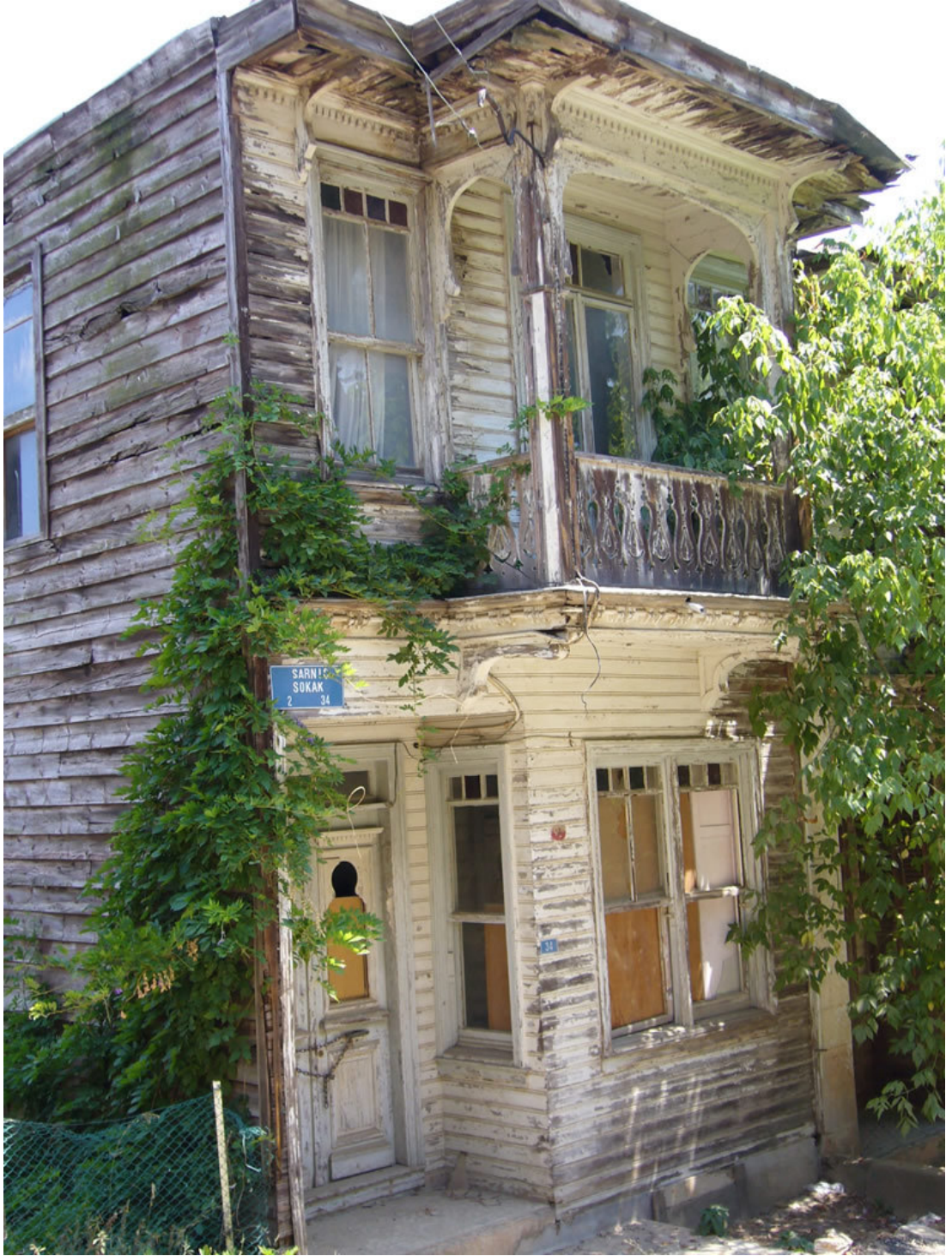
Resim no: 51. Sarnıç Sokak, No:34. Ön cephe.
