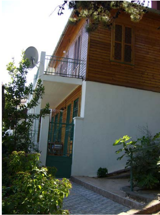
Resim no: 11. Çakıltaşı Sokak, No: 6. Arka cephe.
