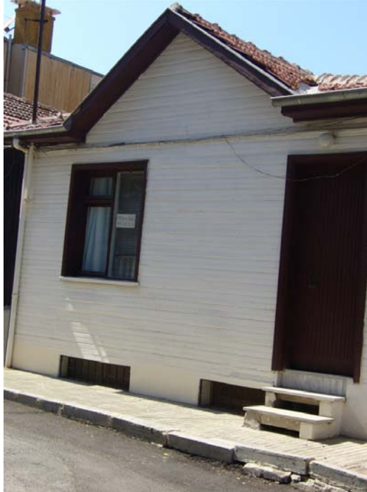
Resim no: 53. Yeniyalı Sokak, No:42. Ön cephe.
