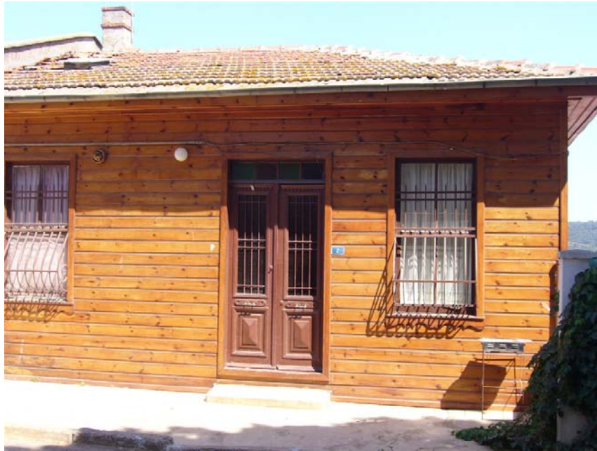
Resim no: 9. Çakıltaş Sokak, No: 2. Ön cephe.
