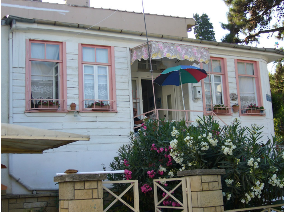
Resim no: 28. Gökdemir Aralığı Sokak, No:2. Ön cephe.
