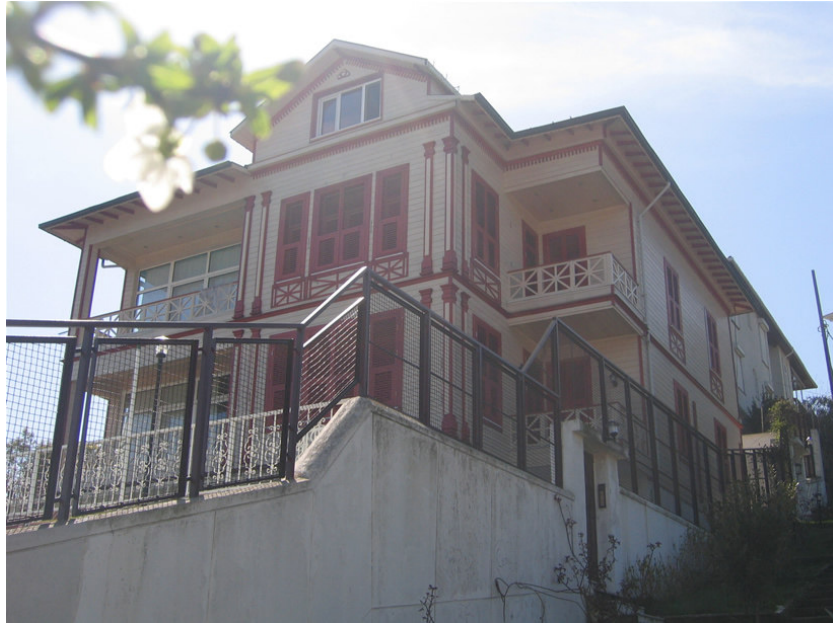
Resim no: 58. Yorgiapelis Evi. Gönüllü Caddesi, No:31. Ön ve yan cephe.
