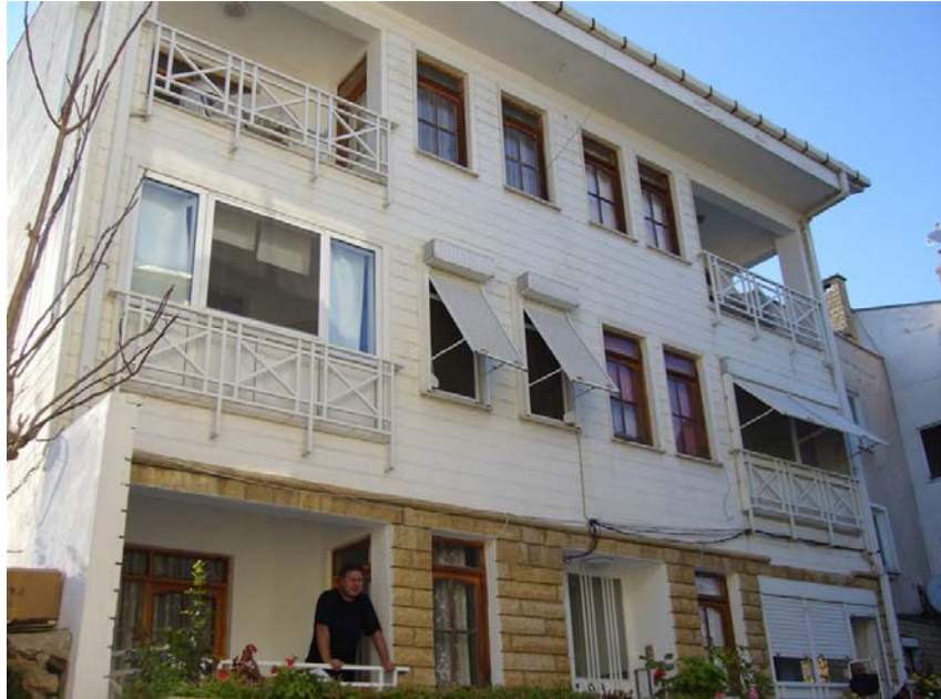
Resim no: 68. Burgaz Çayır Sokak, No: 5. Ön cephe.
