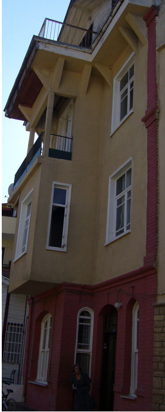
Resim no: 71A Çınarlık Sokak, No:6. Ön cephe.
