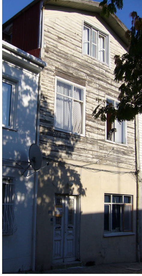
Resim no: 30. Gökdemir Aralığı Sokak, No:11. Ön cephe.
