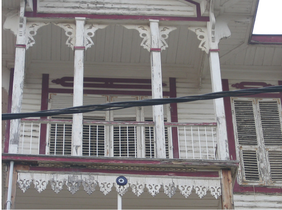
Resim no: 1B. Andriomenos Köşkü I. Mehtap Sokak, No:21. Ön cepheden detay.
