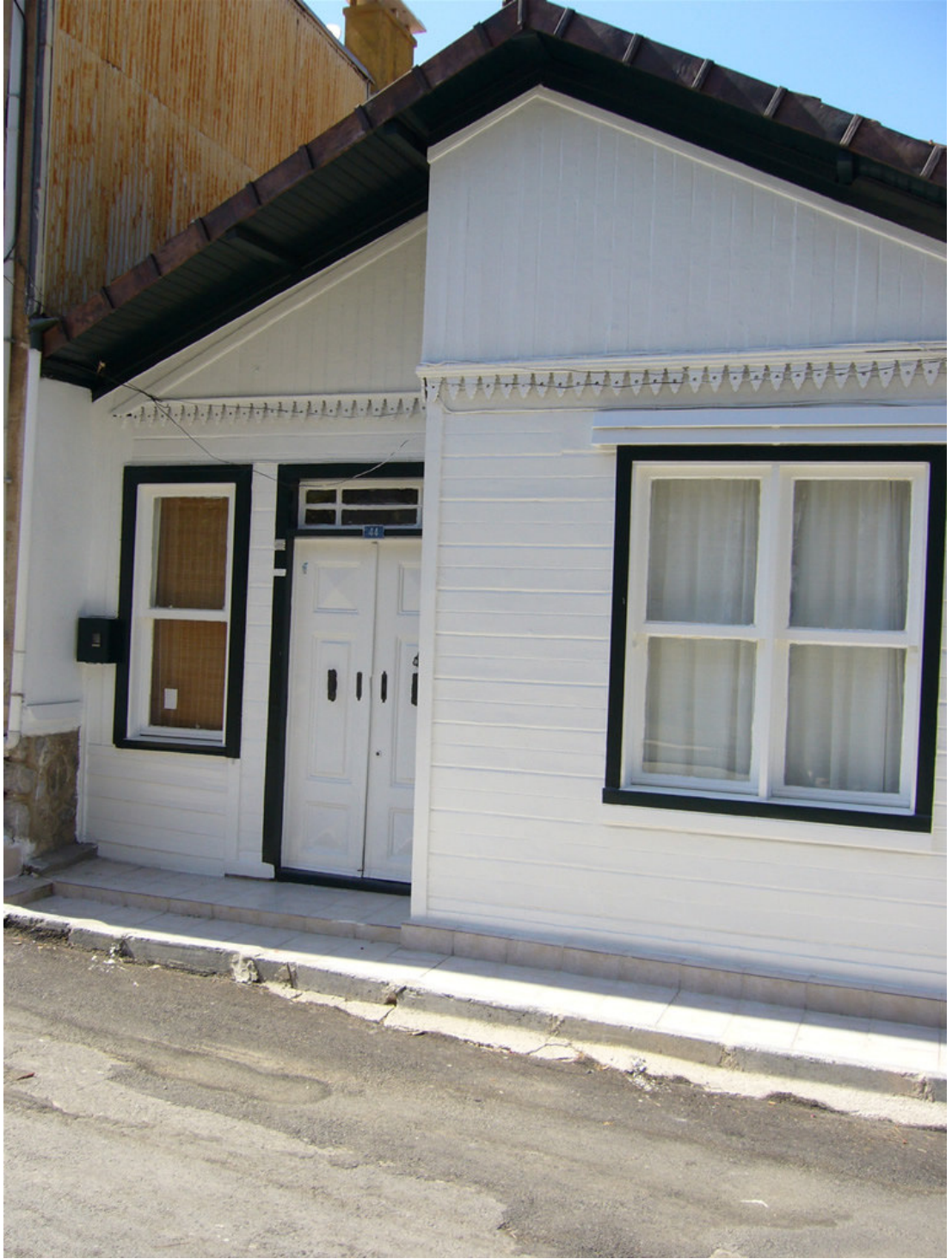
Resim no: 54. Yeniyalı Sokak, No:44. Ön cephe.
