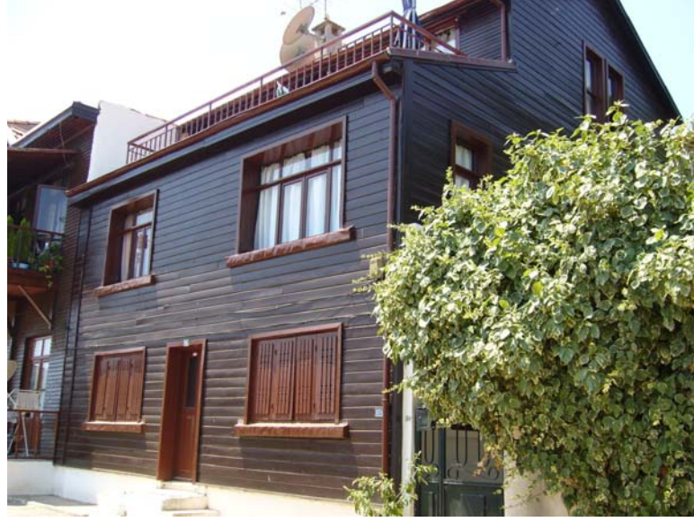
Resim no: 13. Çakıltaşı Sokak, No: 17. Ön cephe.
