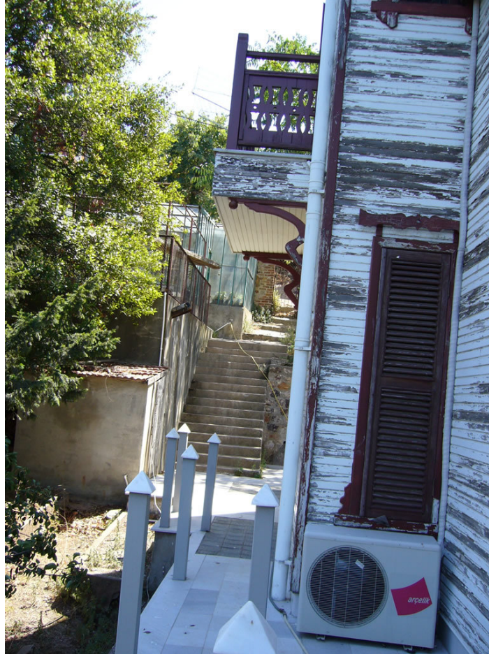
Resim no: 22D. Dimitrakopulo Köşkü I. Mehtap Sokak, No:53. Yan cephe balkon ve pencere detayı.
