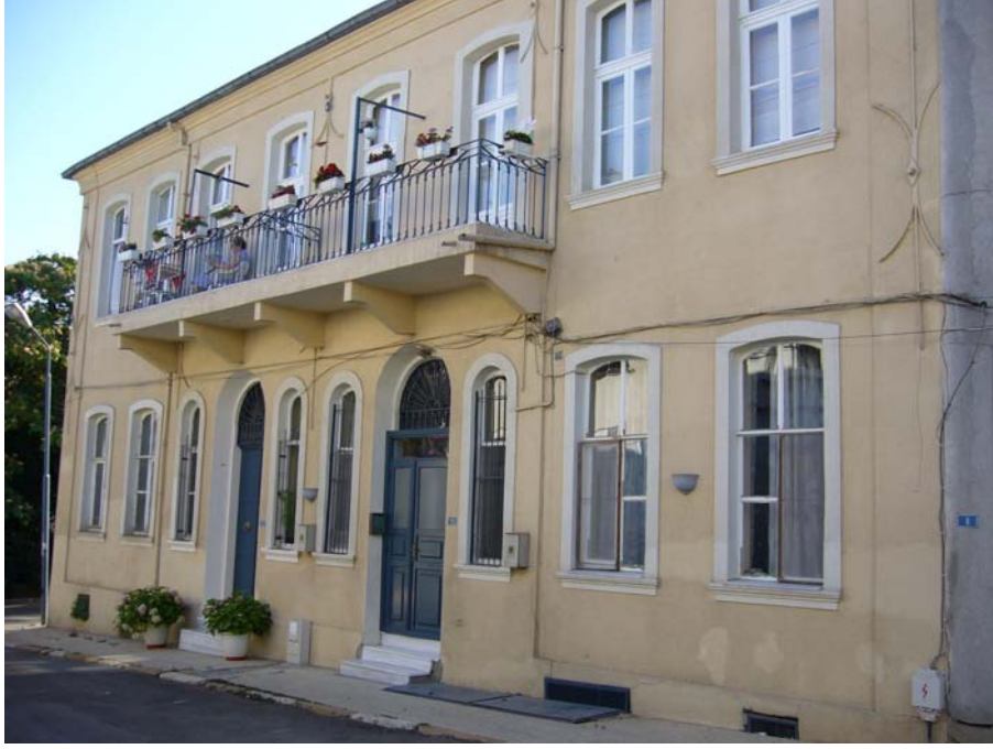
Resim no: 61. Gökdemir Aralığı Sokak, No:10-12. Ön cephe.
