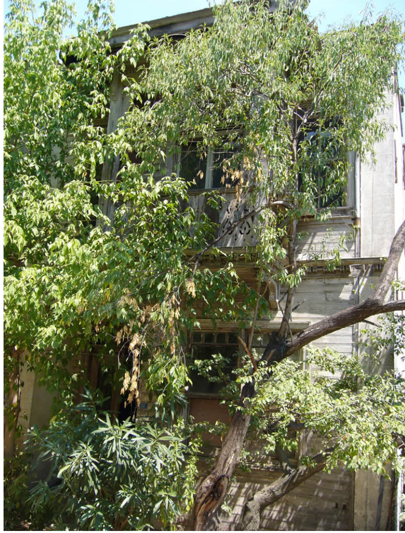
Resim no: 50. Sarnıç Sokak, No:33. Ön cephe.
