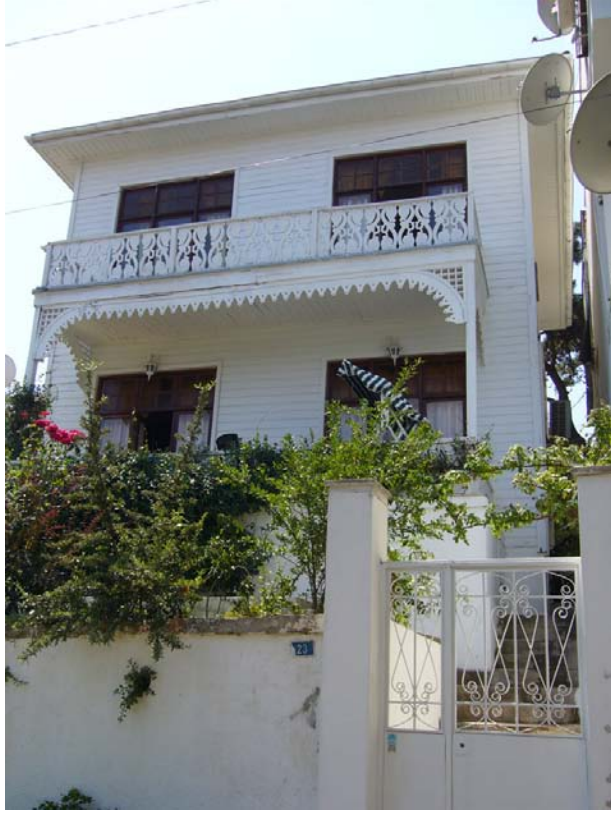
Resim no: 48. Sarnıç Sokak, No:23. Ön cephe.
