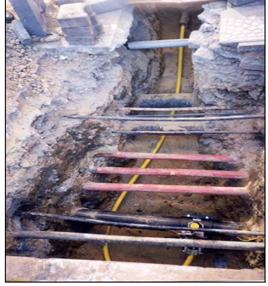
Şekil 1.31. Doğalgaz hattının döşenmesi
