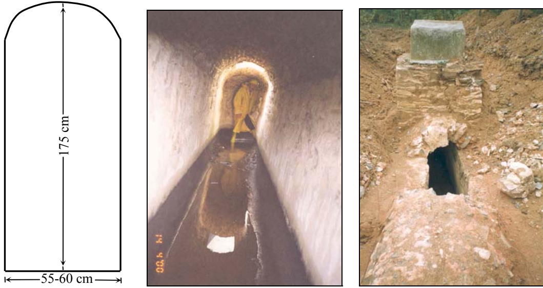
Şekil 1.12. Kırkçeşme su galerisi ve muayene bacası
