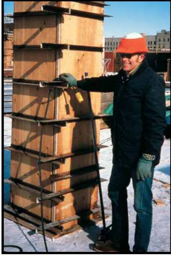
Şekil 4.2 Yalıtımlı kalıp [11]
