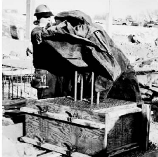
Şekil 4.3 Bir temel ayağının plastik örtü ile korunması [10]
