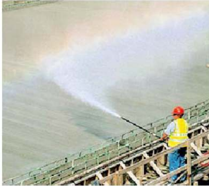
Şekil 3.5 Betonun nemlendirilmesi [6]
