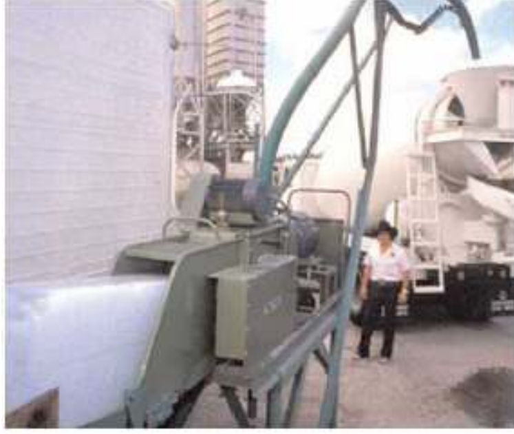
Şekil 3.4 Beton karışım suyuna buz parçaları eklenmesi [6]
