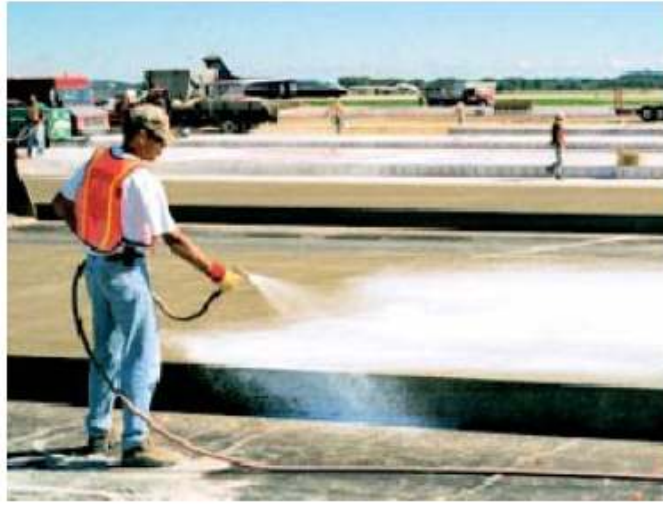
Şekil 3.8 Sıvı malzeme ile koruma [9]
