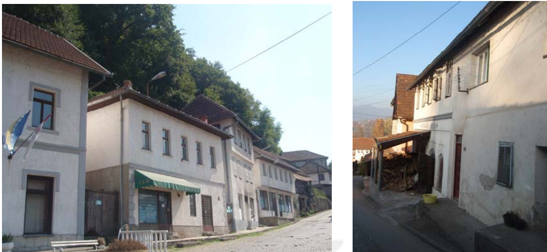
Slika 79. Centralni dio čaršije degradiran izgradnjom pomoćnim objektima
