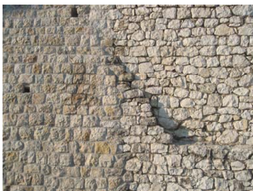
Slika 88. Stanje na terenu zidanje novog dijela zida
