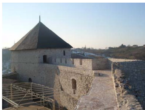
Slika 89. Kruna zida ozidana primjenom novog kamena
