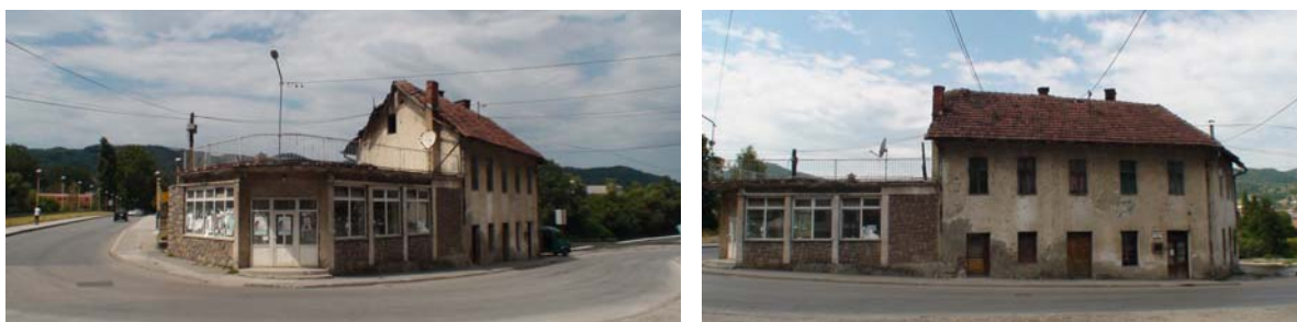
Slika 80. Pogled na objekte koji čine ulaznu sekvencu u stari dio grada u Maglaju
