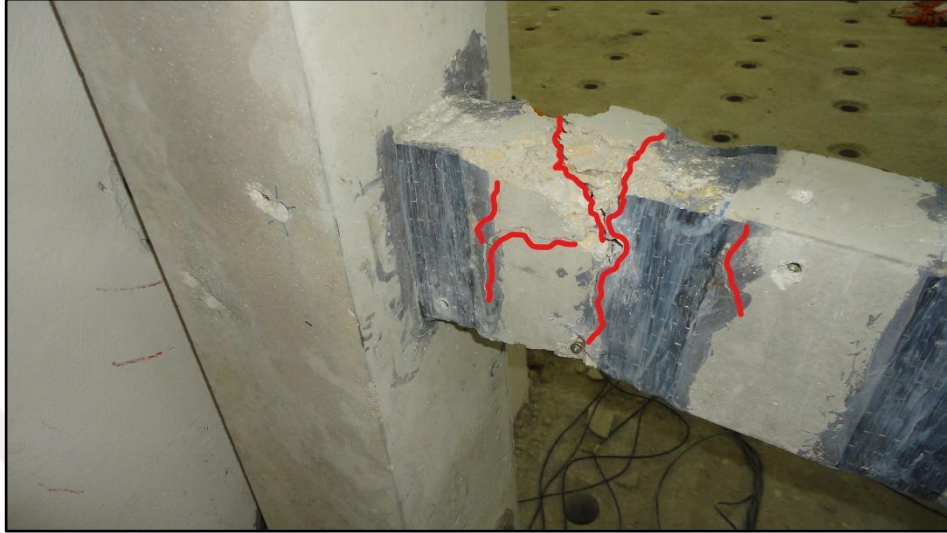
Şekil 4.34. S3 deney elemanında meydana gelen çatlak gelişimi.
