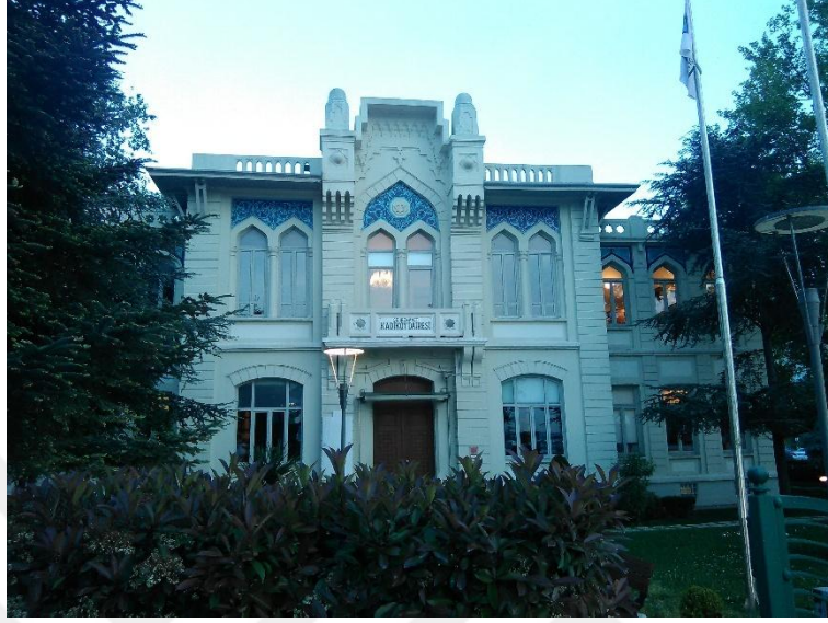
Şekil 4.12: Kadıköy Tarih, Edebiyat ve Sanat Kütüphanesi binası. Kadıköy, İstanbul. (Fotoğraf. E. Cihan Erkek, Mayıs 2019)
