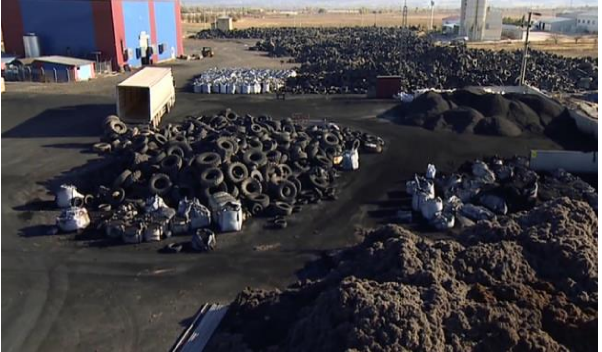
Şekil 1.8. Era Çevre Teknolojileri AŞ./Erzincan ÖTL Geri Dönüşüm Tesisi (Era Çevre Teknolojileri Sitesi, 2016)
