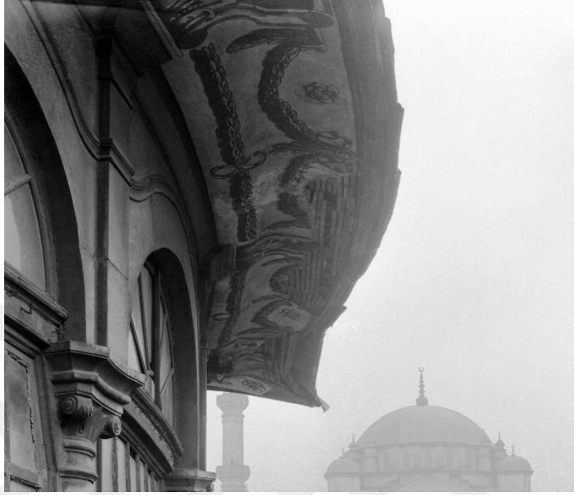
Türbenin Ahşap Saçağı
