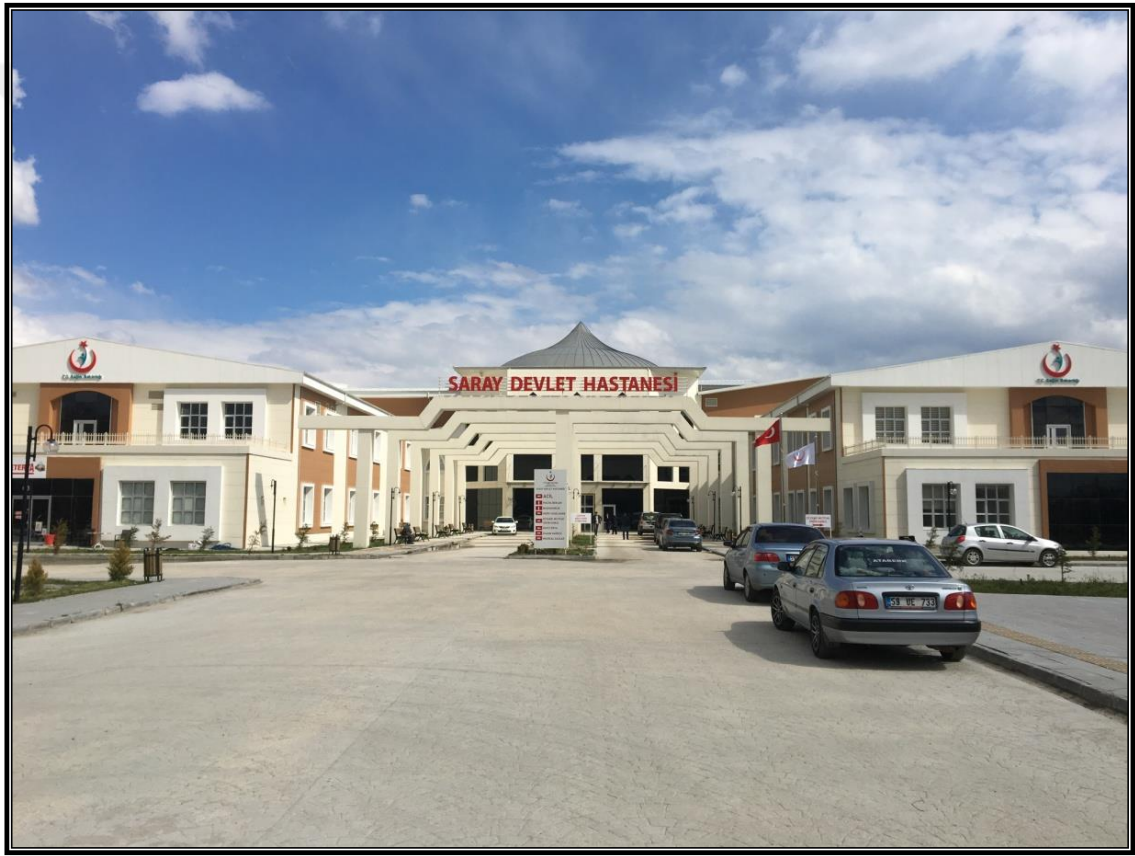
Fotoğraf 2.12. 2016 Yılında Hizmete Giren Saray Devlet Hastanesinin Yeni Binası.
