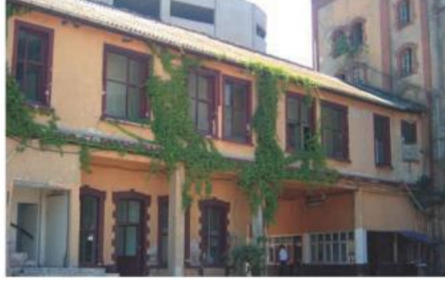
Şekil 5.5: Yönetim ve idare binası genel görünümü, 2009. (Fotoğraf: Tanyeli, İkiz, 2009)
