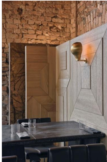
Şekil 5.32: Ahşap iç kabuk olarak tasarlanan alanlarda aydınlatma elemanlarının bağlantı elemanlarının gizlenildiği bir tasarımıdır. (Fotoğraf: Engin Aydeniz)
