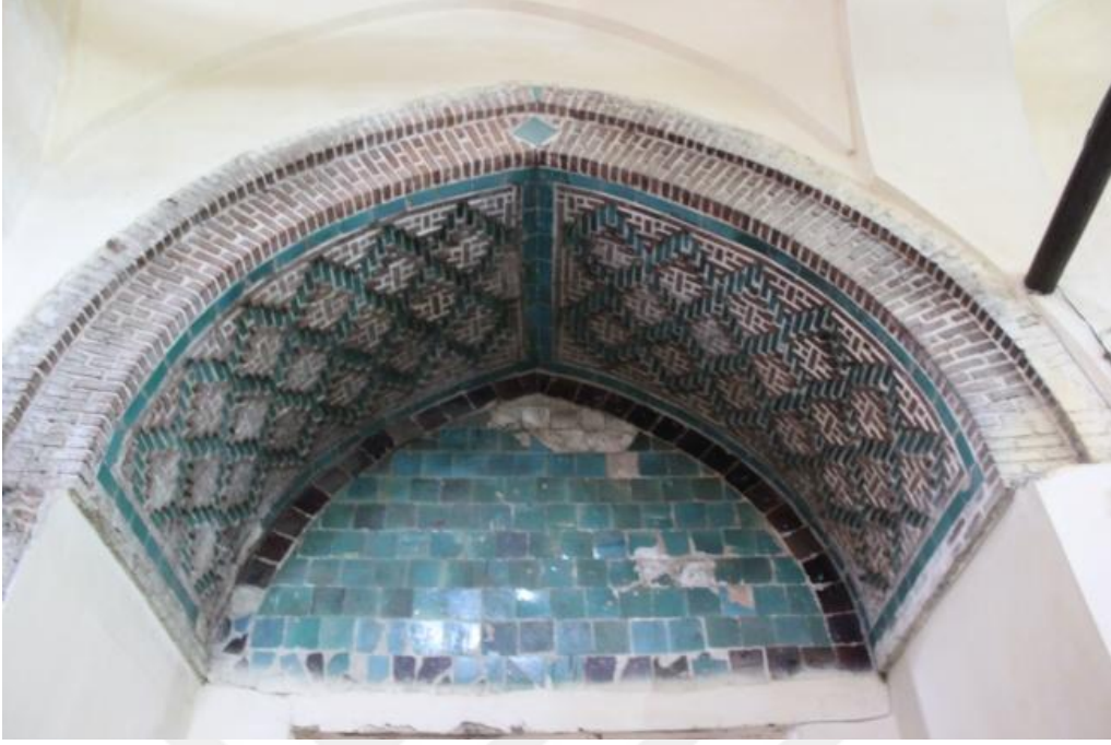
Fotoğraf 27: Gökmedrese Türbesi Eyvan Kemer
