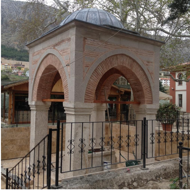
Fotoğraf 70: Kurtboğan Türbesi Onarım Sonrası
