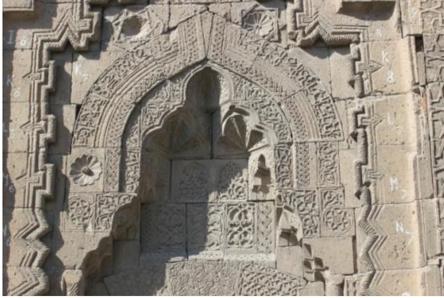
Fotoğraf 7: Halifet Gazi Türbesi Giriş Kapı Ayrıntı
