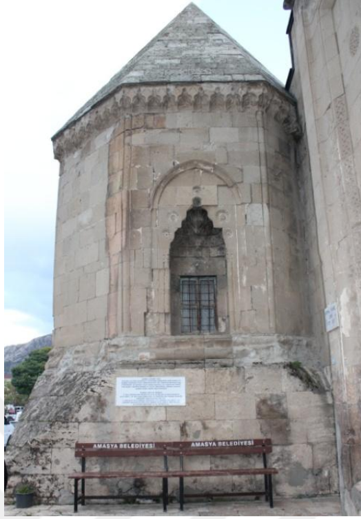
Fotoğraf 11: Burmalı Minare Camii (Cumudar) Türbesi Batı Cephesi Görünüşü
