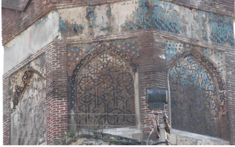
Fotoğraf 25: Gökmedrese Türbesi Kaskanak Detayı
