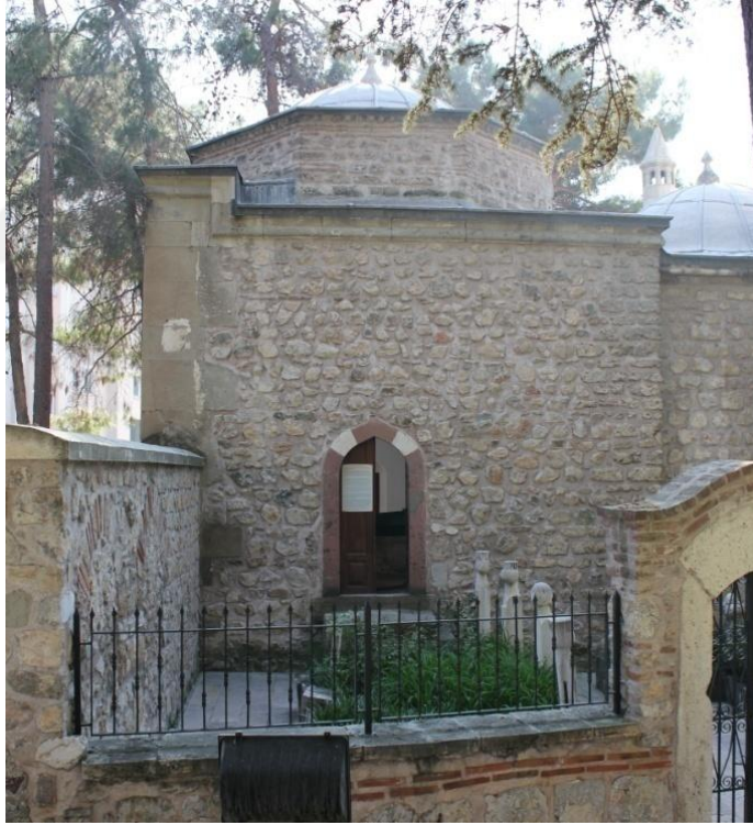
Fotoğraf 74: Hızır Paşa Türbesi Kuzey Cephe Görünüşü
