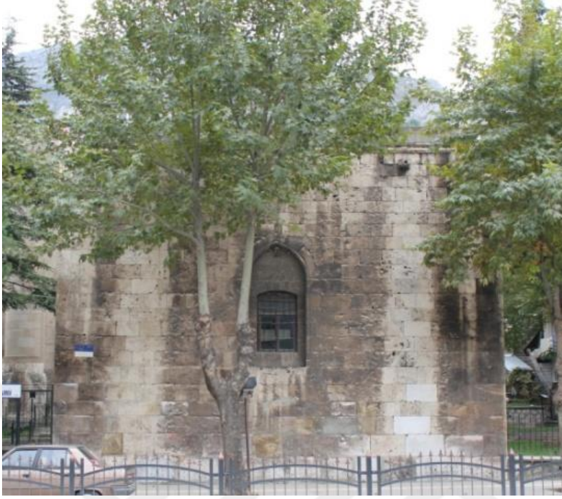
Fotoğraf 33: Torumtay Türbesi Kuzey Cephe Görünüşü
