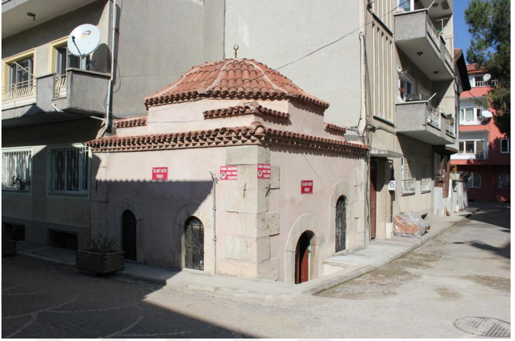
Fotoğraf 63: Selamet Hatun Türbesi Genel Görünüş
