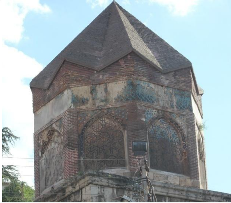
Fotoğraf 24: Gökmedrese Türbesi Kasnak ve Üst Örtü
