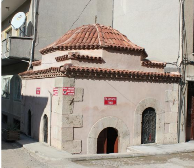
Fotoğraf 64: Selamet Hatun Türbesi Genel Görünüş
