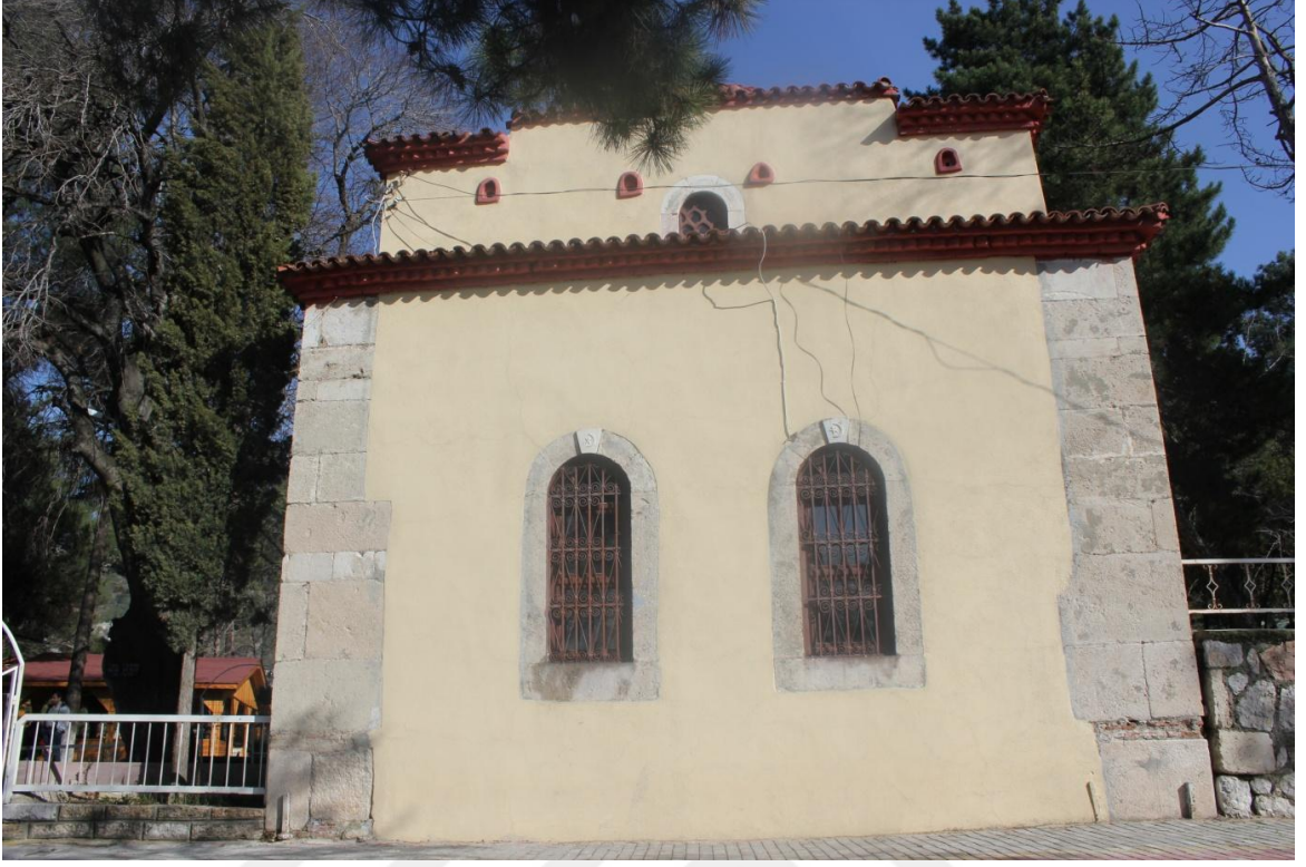
Fotoğraf 87: Pir Süceaddin İlyas Türbesi Batı Cephesi Görünüşü
