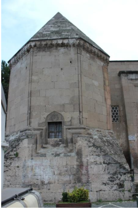
Fotoğraf 12: Burmalı Minare Camii (Cumudar) Türbesi Kuzey Cephe Görünüşü
