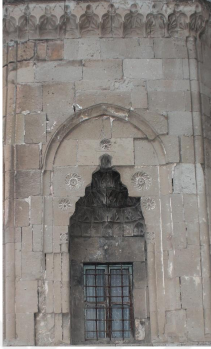
Fotoğraf 17: Burmalı Minare Cami (Cumudar) Türbesi Batı Cephe Penceresi
