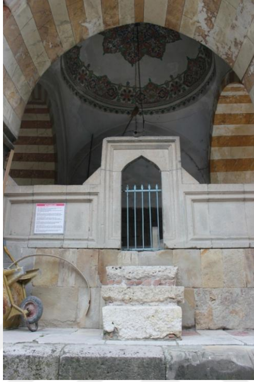
Fotoğraf 61: Yörgüç Paşa Türbesi
