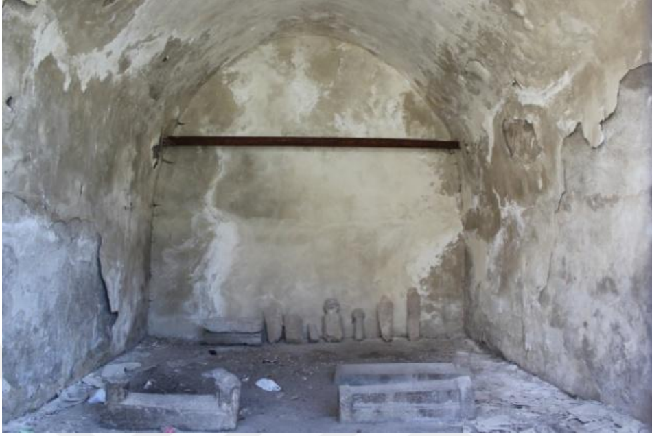
Fotoğraf 53: Şadgeldi Paşa Türbesi İç Mekân
