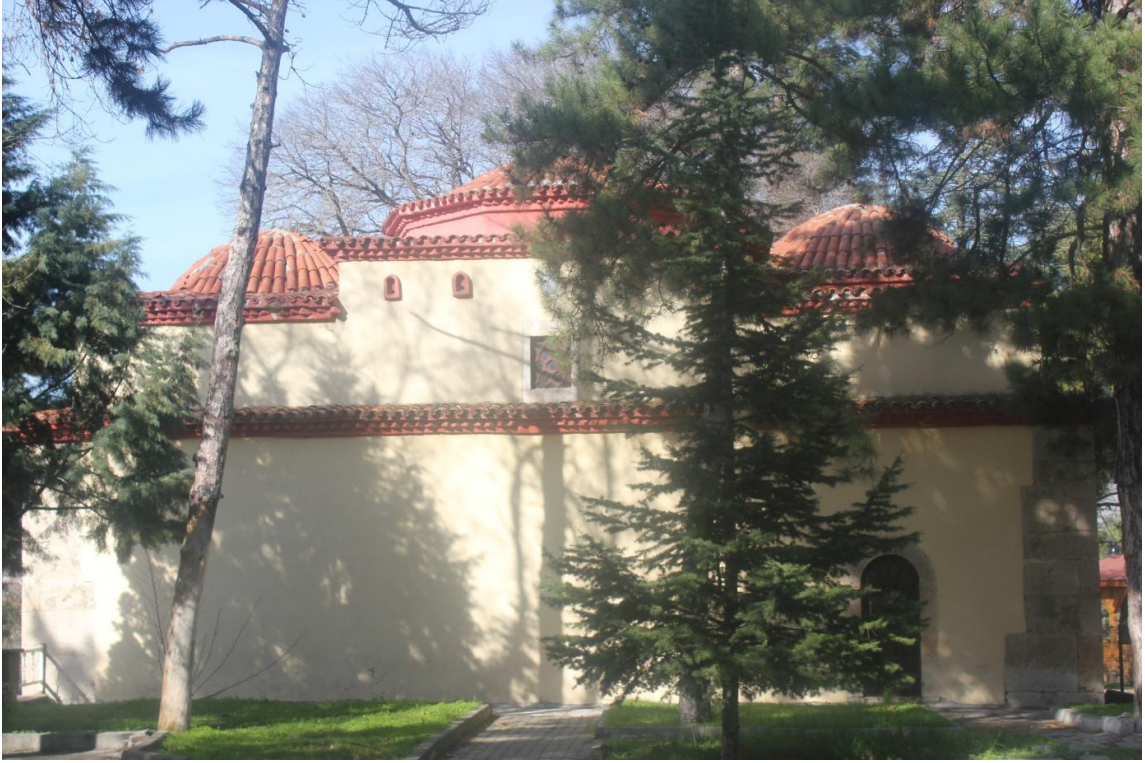
Fotoğraf 86: Pir Süceaddin İlyas Türbesi Güney Cephe Görünüşü
