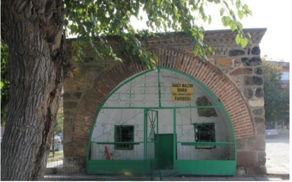
Fotoğraf 94: Hacı Nazır Baba Türbesi Giriş Cephesi
