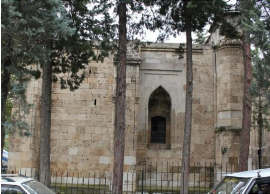
Fotoğraf 34: Torumtay Türbesi Batı Cephe Görünüşü
