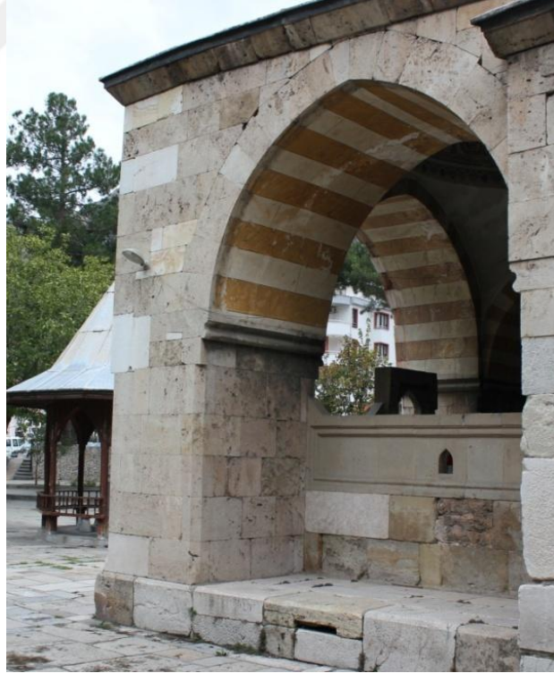
Fotoğraf 60: Yörgüç Paşa Türbesi Görünüşü
