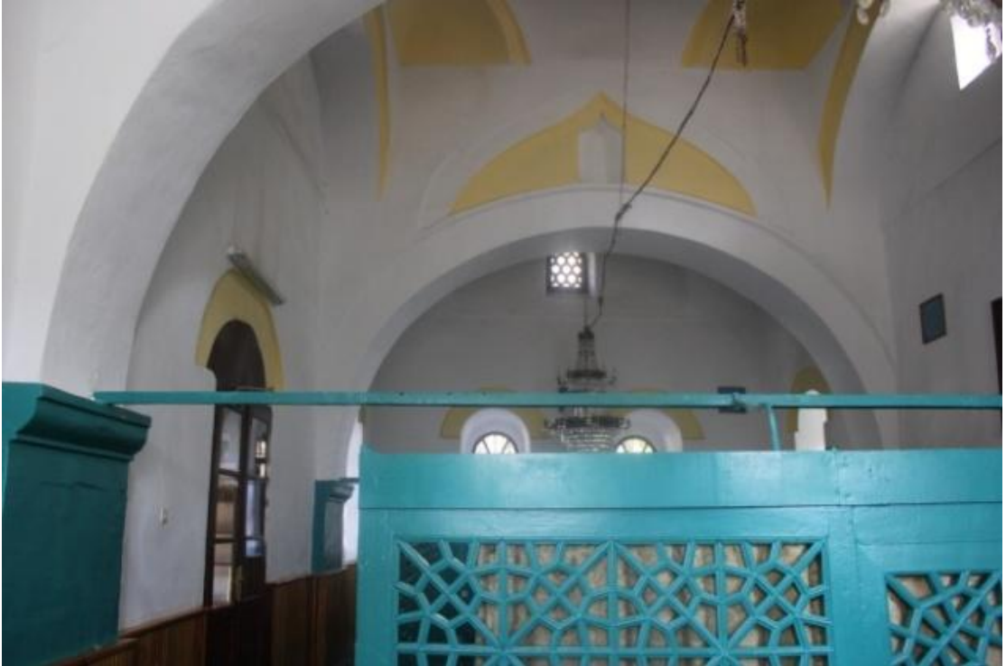
Fotoğraf 91: Pir Süceaddin İlyas Türbesi İç mekân Görünümü
