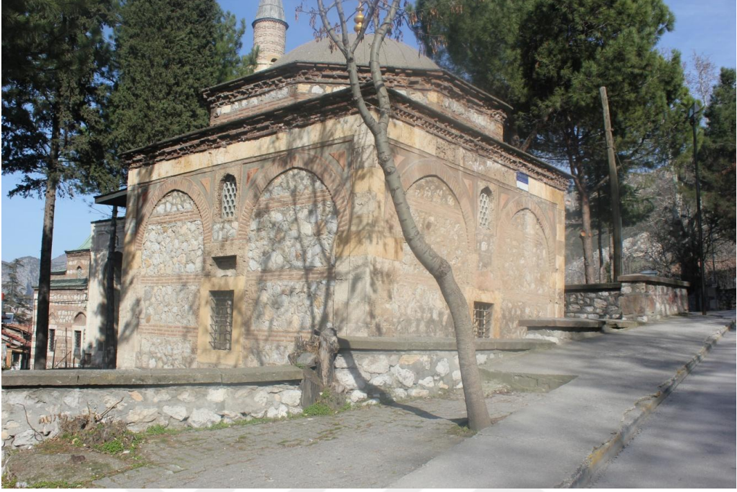
Fotoğraf 104: Kemal Paşa Türbesi Batı Cephe
