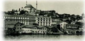
Cibali Tütün ve Sigara Fabrikası
