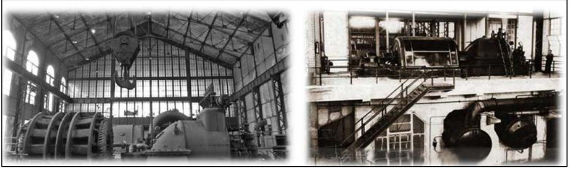
Şekil 2.30: Silahtarağa elektrik fabrikası 1 ve 2 numaralı makine dairesi
