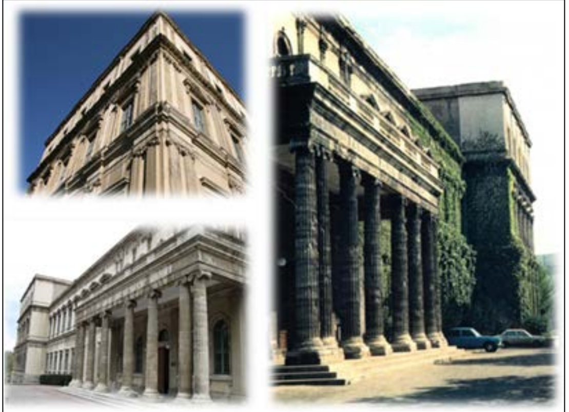
Şekil: 2.13: 1970 dönemi Batı ve Güney cephesi kemerler
