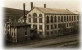
Silahtarğa Elektrik Santrali
