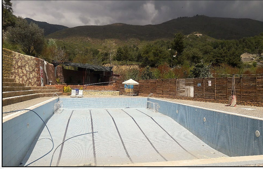
Foto 3.32: Tulpar Yüzme Havuzu (Karlisu Mahallesi)
