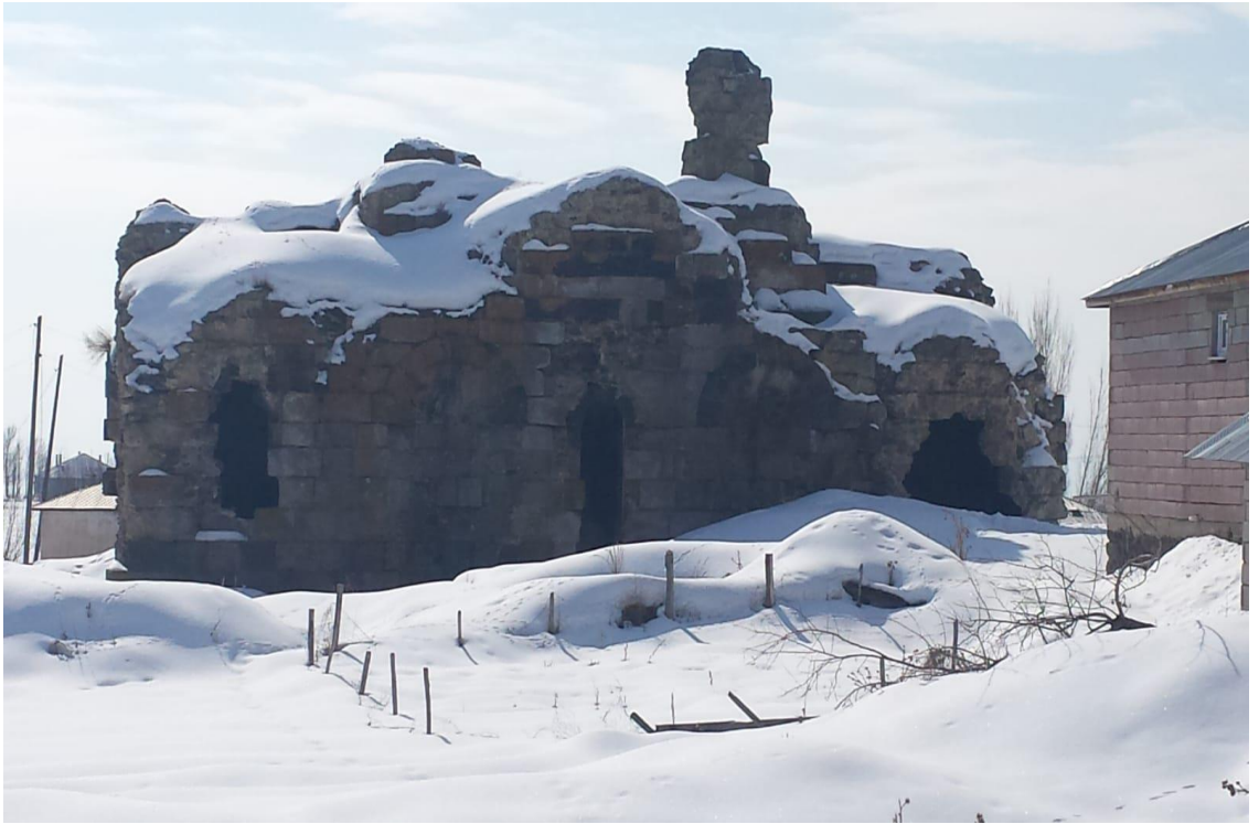
Foto 67: Salmanağa Kırsal Mahallesinde Yer Alan Tarihi Kilise Kalıntısı
