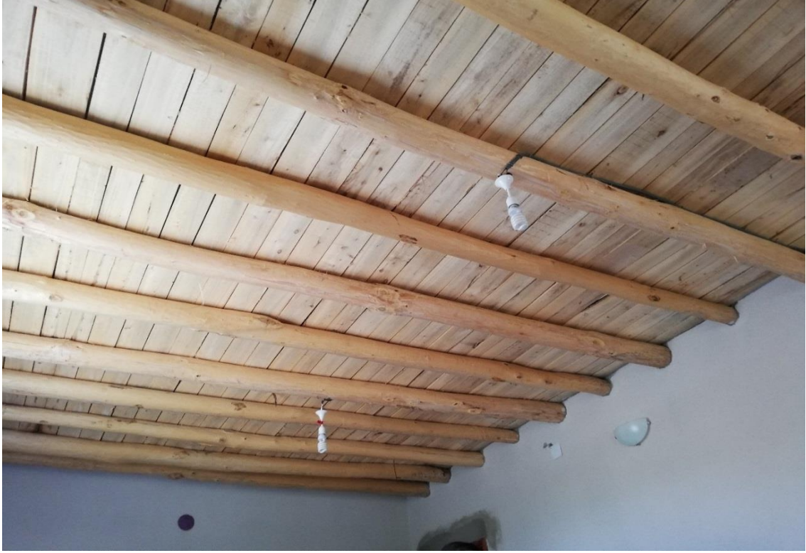
Foto 50: Kır Yerleşmelerinde Meskenlerin Tavan Yapısı
