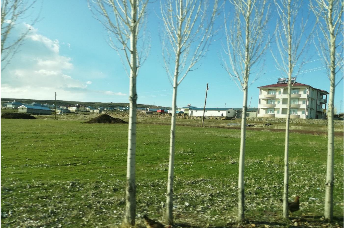
Foto 38: Kirsal Mahallelerde Yapılan Yeni Tip Çok Katlı Mesken ve Yanında Yer Alan Ahır Eklentisi (Topraklı Kirsal Mahallesi)
