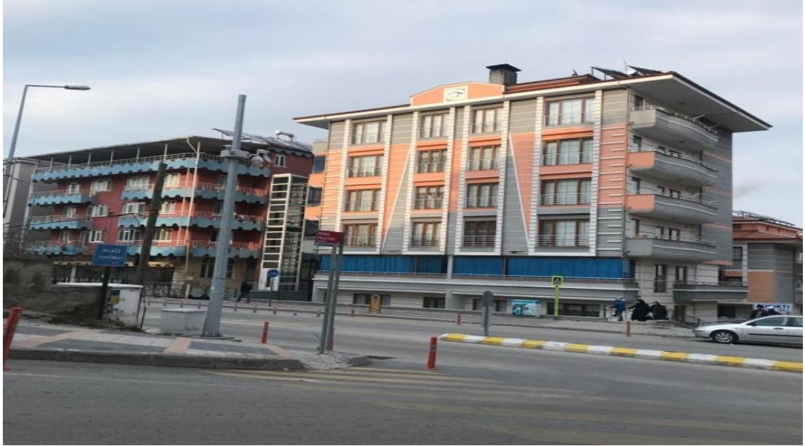
Fotoğraf 2.5. Yeni Yapılan Konutlardan Bir Görünüm.
