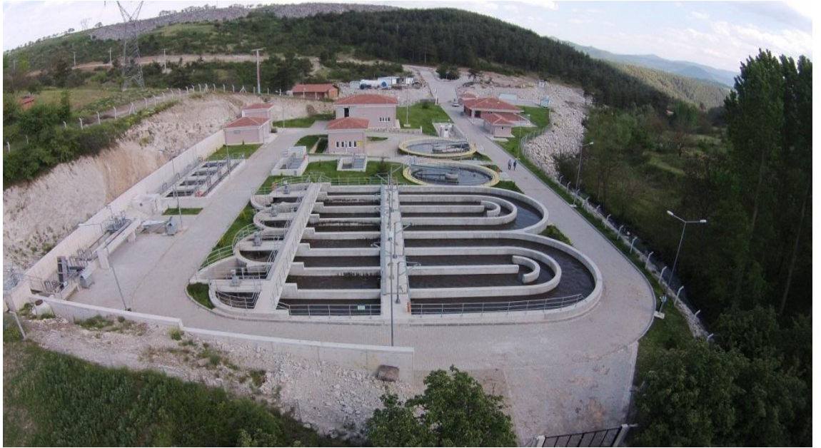
Fotoğraf 3.30. Dursunbey Şehrinde Atık Su Arıtma Tesisinden Bir Görünüm.
