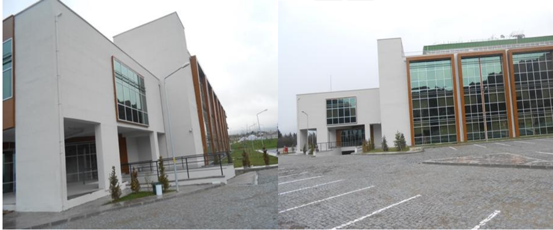
Fotoğraf 3.19. Dursunbey İlçe Sağlık Müdürlüğü Hizmet Binası.
