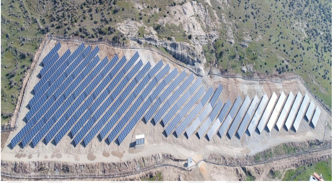
Fotoğraf 3.29. Dursunbey Şehri Güneş Enerji Üretim Panellerinden Bir Görünüm.
