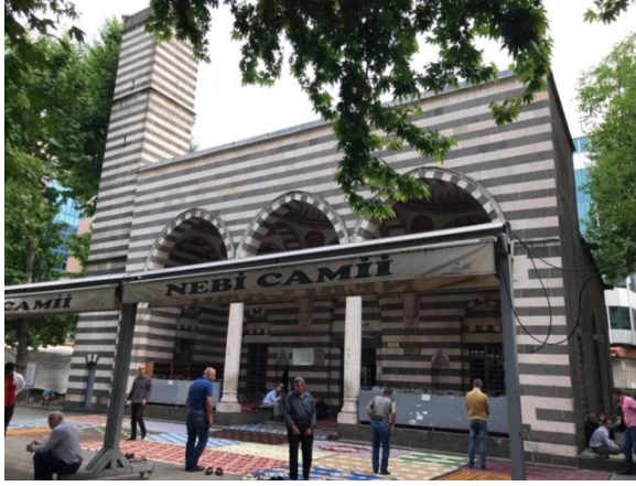
(a) Dış görünüm
