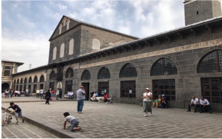
Şekil 3.14 Diyarbakır Ulu Camii; dış görünümü
