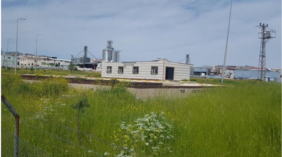
Foto 34. OSB Girişinden Atık Su Arıtma Tesisinin Görünümü
