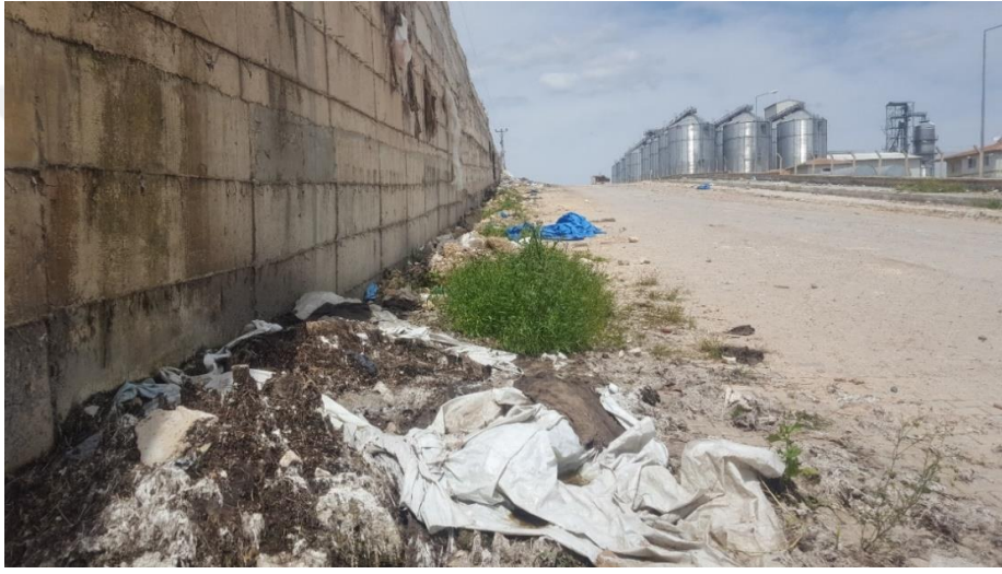
Foto 35. Viranşehir OSB'deki Altyapı Sorunları ve Görüntü Kirliliği
