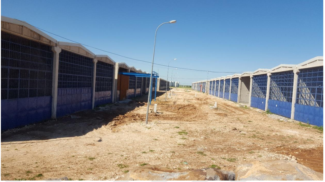
Foto 17. Viranşehir Yeni KSS Bölünmüş İşyeri Alanları
