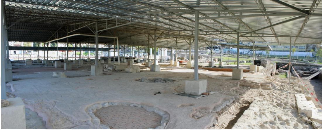
Şekil 5: Mozaikli Yapı Genel görünüş
