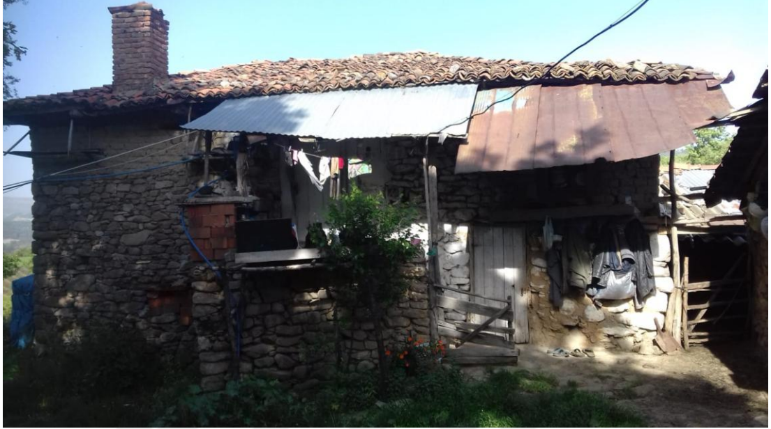
Foto 25 Yaz Aylarında Yaşanan Dam Yerleşmesinden Bir Görünüm
