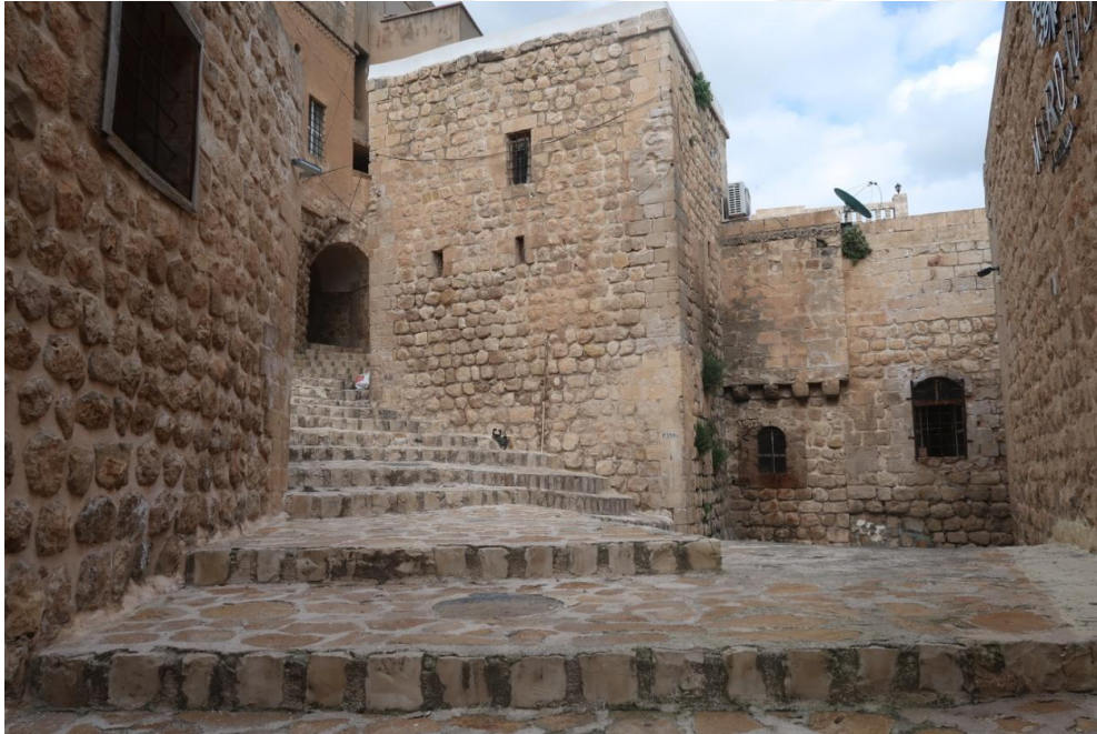
Resim 5.1. Taşın temel yapı malzemesi olarak kullanılmasıyla eski Mardin Kenti'ni bir bütün olarak algılaması (Çaltekin, 2019)
