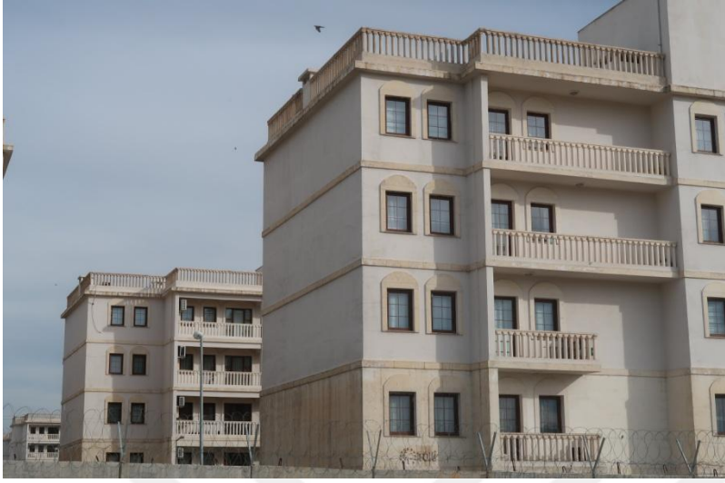
Resim 6.3. İstasyon Mahallesi Kentsel Dönüşüm Projesi, Cephe çalışmaları (Çaltekin, 2019)
