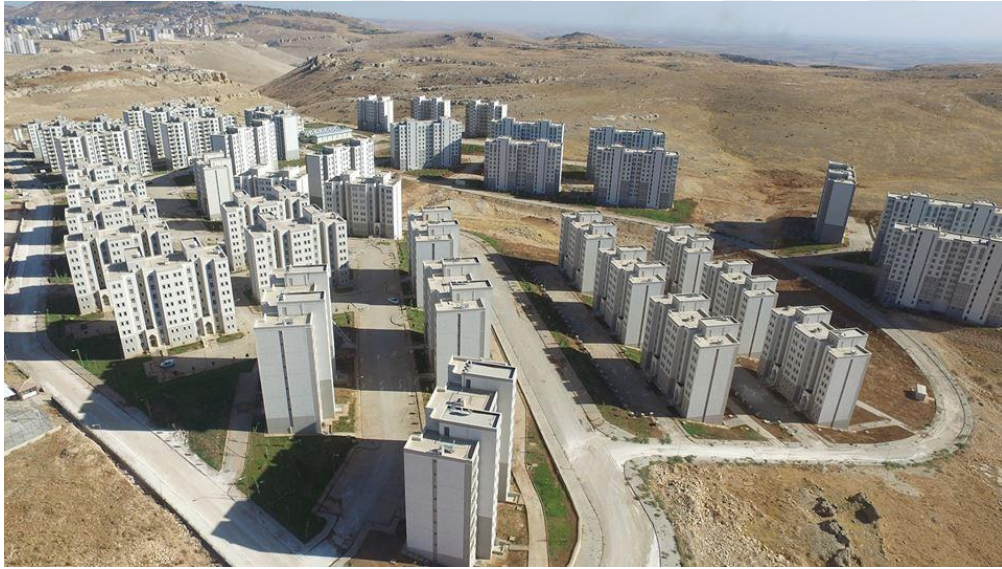
Resim 4.10. Toki Nur Mahallesi Kentsel Dönüşüm ve Gelişim Projesi, (Mardin Büyük Şehir Belediyesi)
