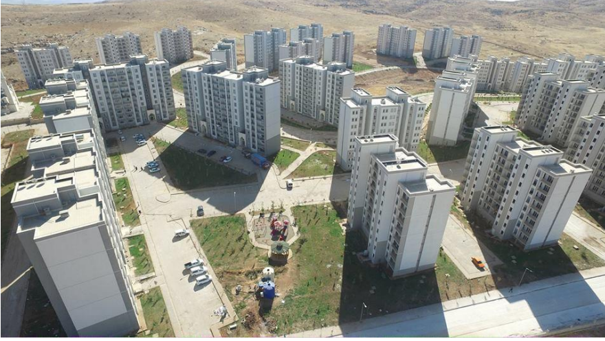
Resim 4.11. Toki Nur Mahallesi Kentsel Dönüşüm ve Gelişim Projesi, (Mardin Büyük Şehir Belediyesi)
