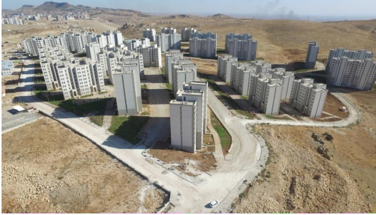
Resim 6.13. Ayrık düzende yerleştirilen blokların Güneş ışınlarıyla ilişkisi. Toki Nur Mahallesi Kentsel Dönüşüm Projesi. (Olgaç, 2019)
