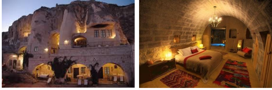
Görsel 2.14. Kapadokya evleri, Nevşehir (http-65, 2019)
