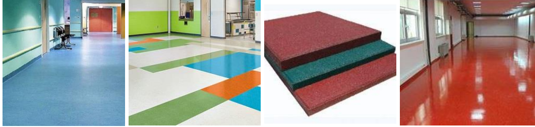
Görsel 1.52. Plastik esaslı zemin kaplamaları ( Linolyum, vinil, kauçuk karo, epoksi) (http-52, 2019)
