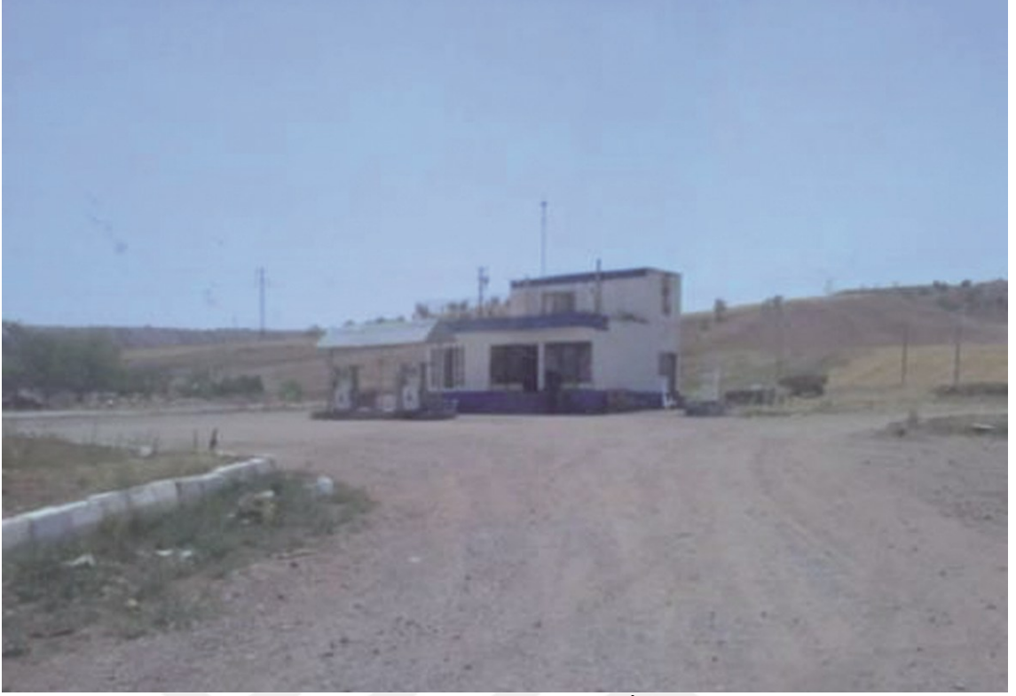
Fotoğraf 14. Güzelyurt Köyü Yakınlarında Akaryakıt İstasyonu (2017)
