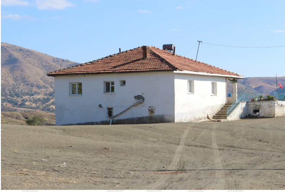
Fotoğraf 21. Yığma tuğla ile yapılmış 2 katlı ve kiremit çatı örtüsü (Büyükaşar 2017)
