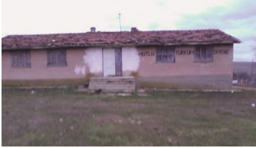
Fotoğraf 17. Yenialibudak Köyü Eski İlkokul Binası (2017)
