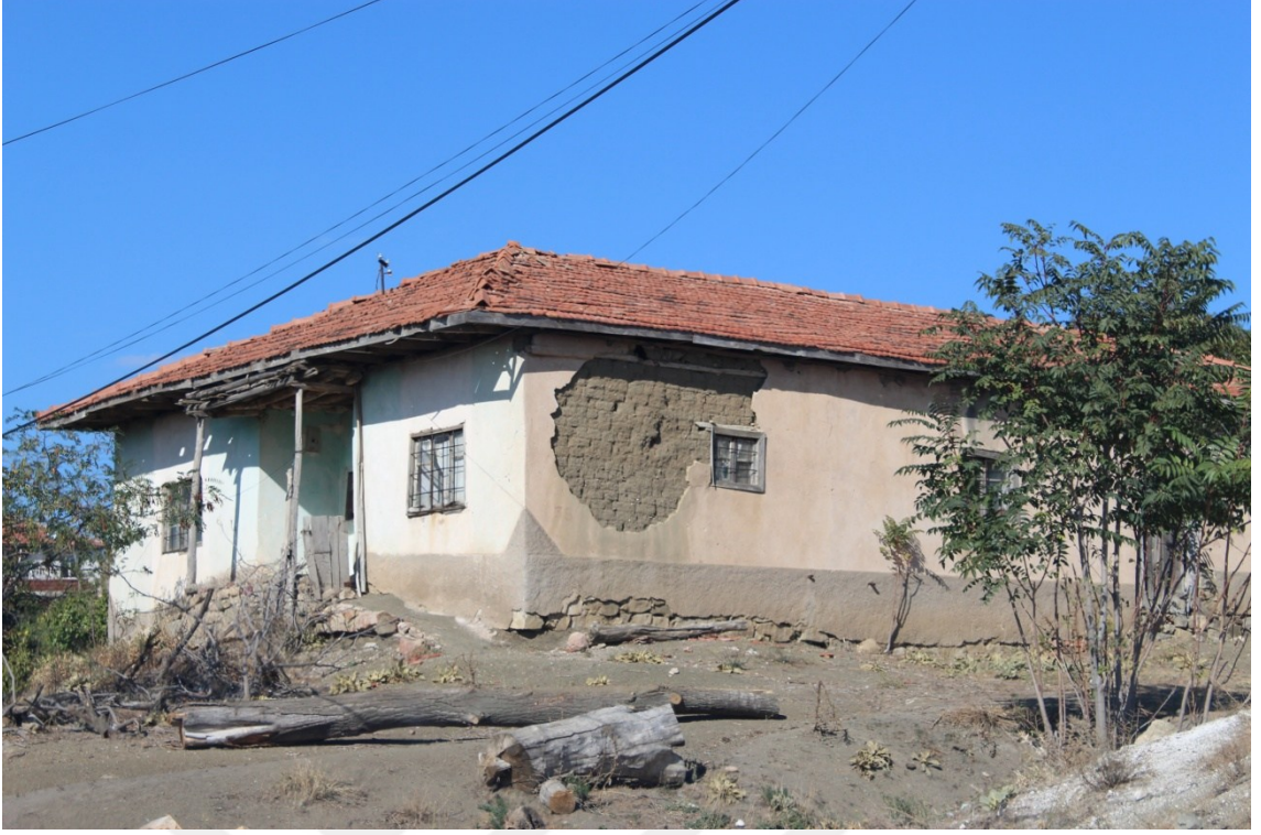
Fotoğraf 7. Kösedurak köyünde beton sıva ile kaplanmış toprak mesken, (2018)
