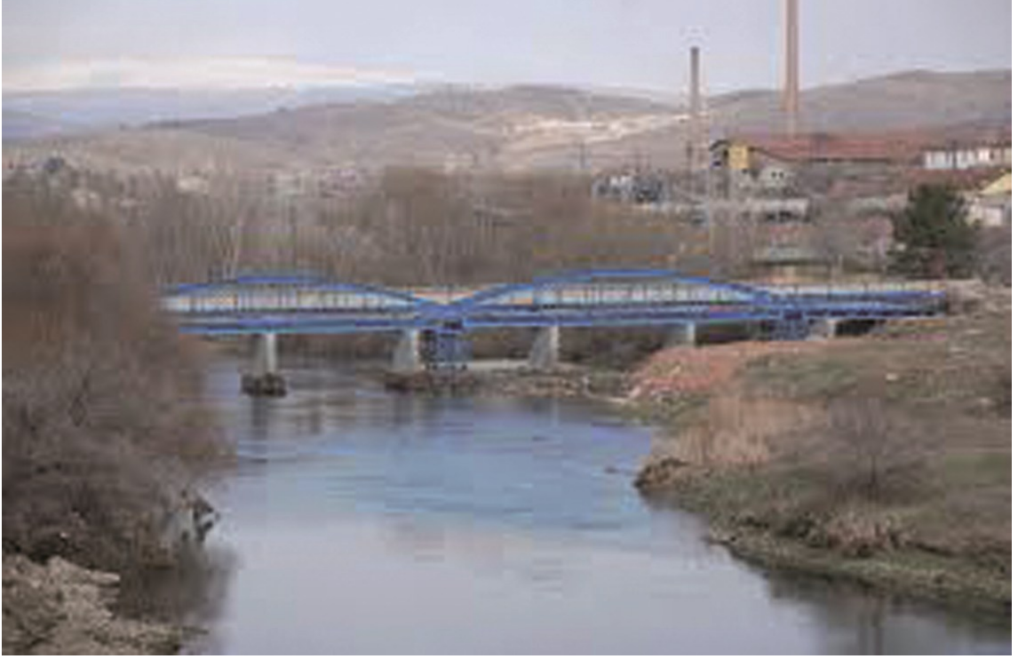
Fotoğraf 2. Yahşıhan-Bahşili arasında mühimmat taşıma amacıyla yapılmış demiryolu köprüsü (2018)
