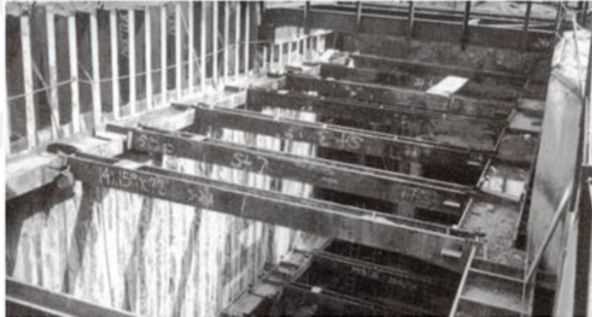
Şekil 2. 8. Aç-kapa istinat duvarı (Alkaya, 2011)
