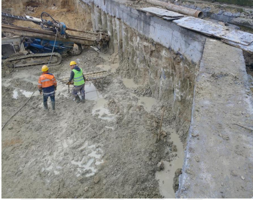
Şekil 2. 35. Ankraj delgisi yapılması
