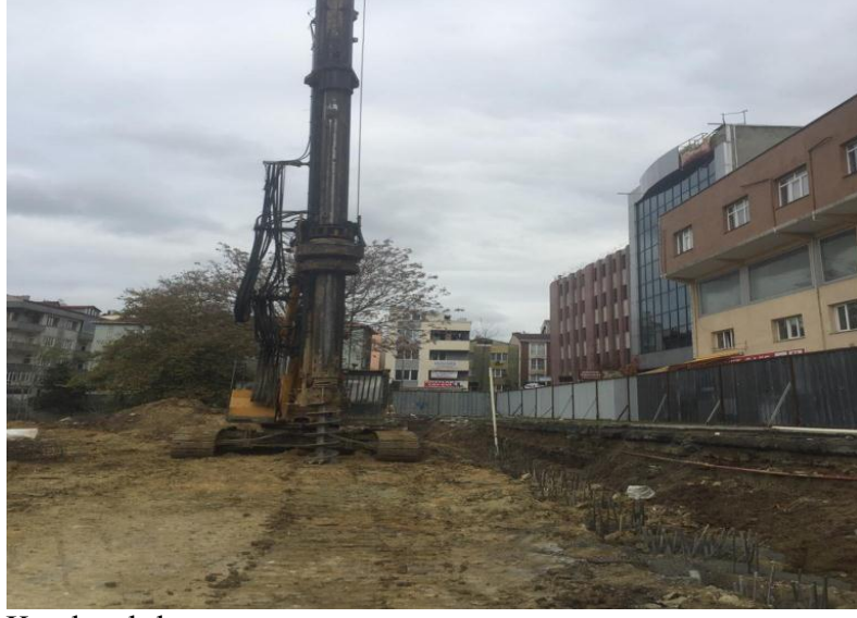
Şekil 2. 33. Kazık çakılması
