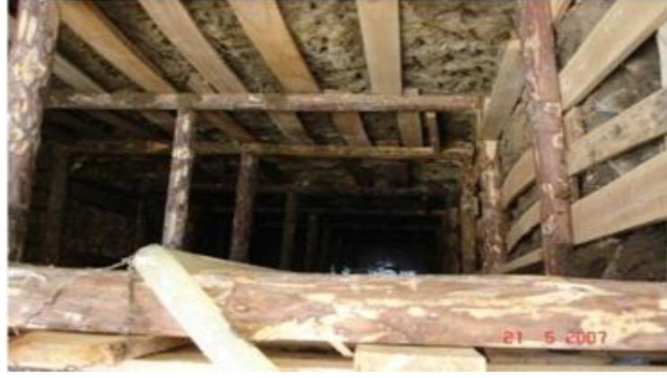
Şekil 2. 7. Kuyu tipi istinat duvarı (Alkaya, 2011)
