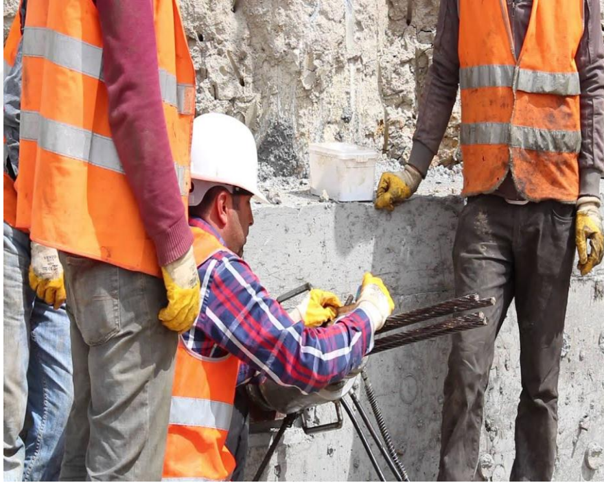
Şekil 2. 36. Ankraj germe işlemi
