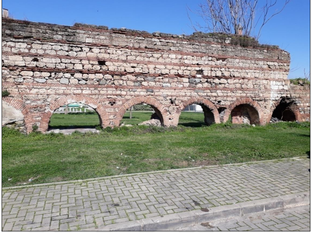
Şekil 35: Günümüzde Kanberler Hanı'na Ait Duvar Kalıntısı.
