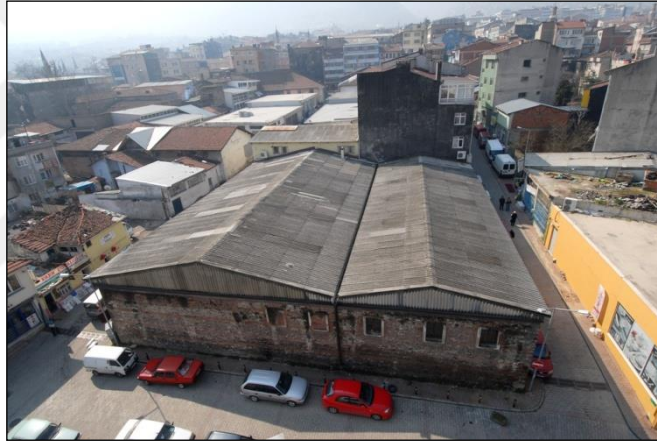
Şekil 49: Abdal Tahıl Deposu (Osmangazi Belediyesi Arşivi).
