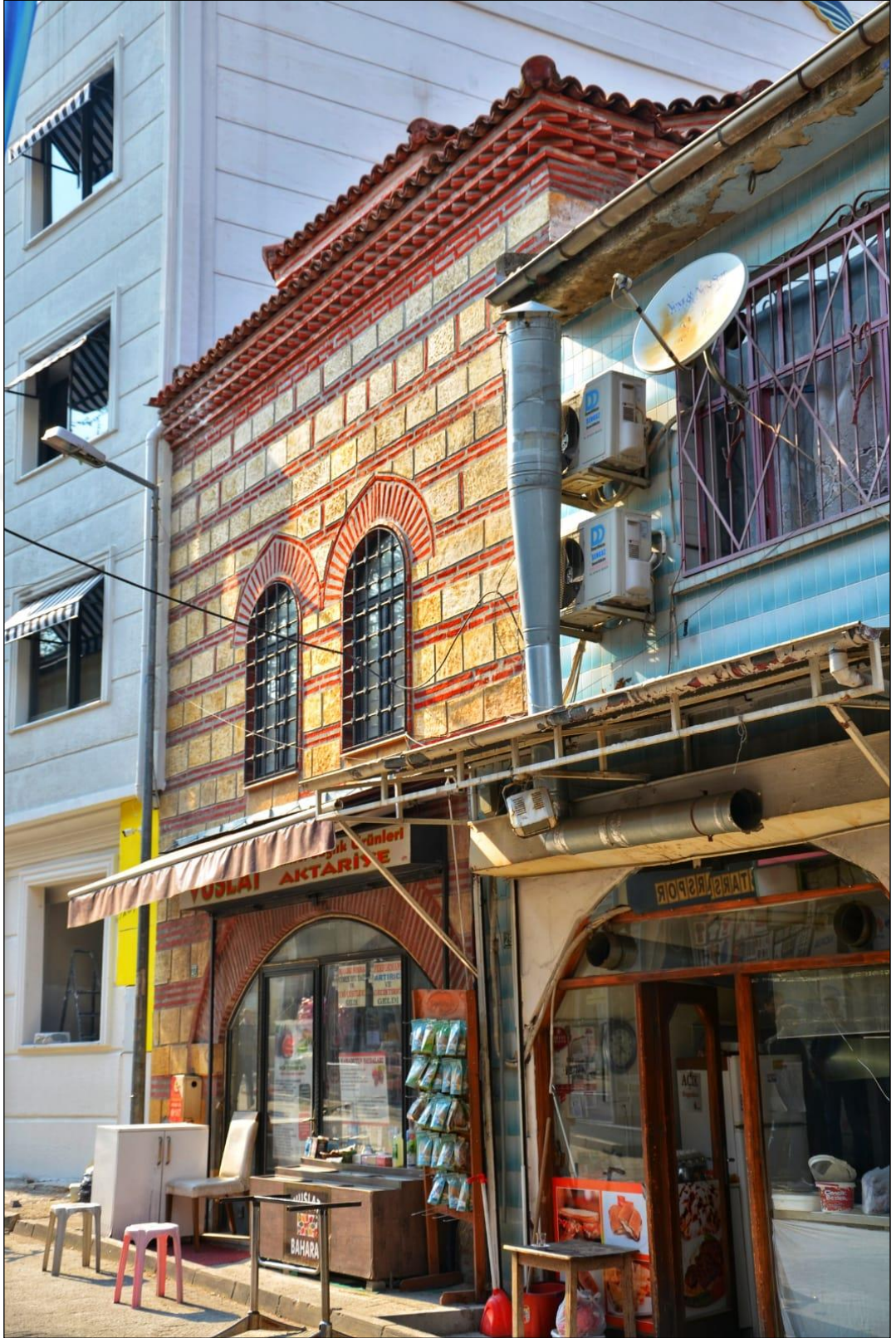
Şekil 47: Günümüzde Galle Han'ın Güney Bölümü.
