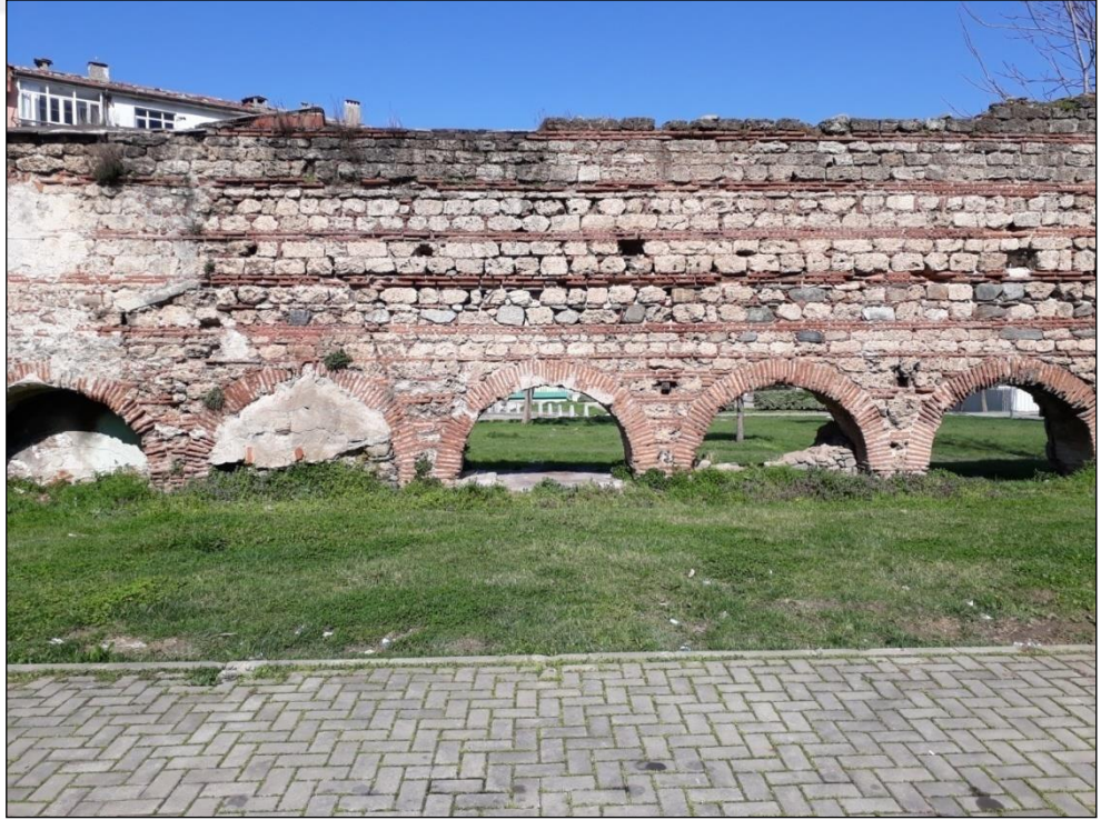
Şekil 36: Günümüzde Kanberler Hanı'na Ait Duvar Kalıntısı.
