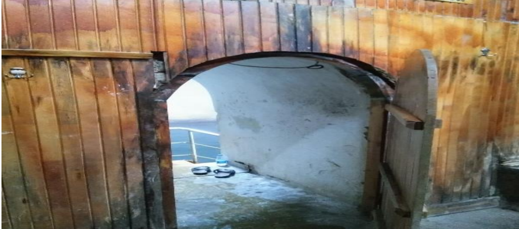
Resim 19-ç: Havuza Geçiş Kapısı
