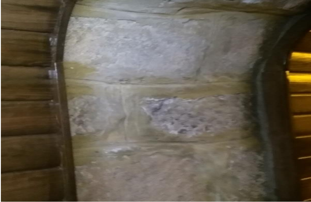
Resim 15-ç Eski Hamam Yenilenmesinde Orijinal Kalan Duvarlar
