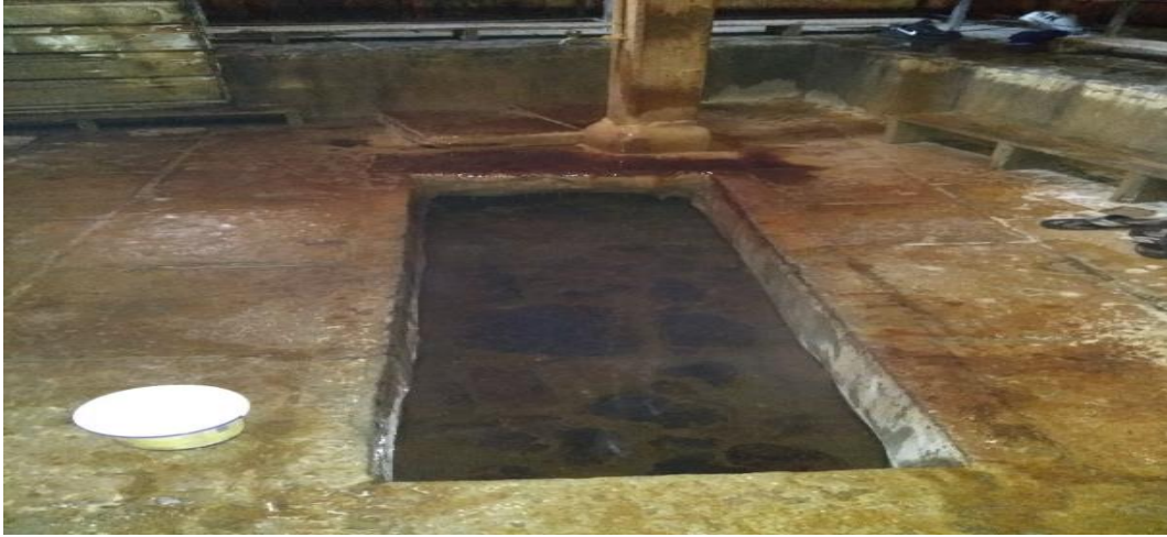
Resim 19-b: Sey Hamamı Fazla Suların Atıldığı Kanallar
