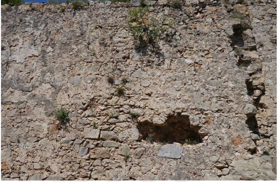
Resim 18 Soyunmalık Bölümü Batı Duvarı (1 Nolu) a. Malzeme e. Köklü Bitkiler
