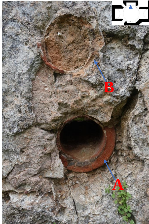
Resim 461 Sıcaklık Bölümü Kuzey Eyvanı Sıva Malzeme Su Künkleri (6 Nolu)
