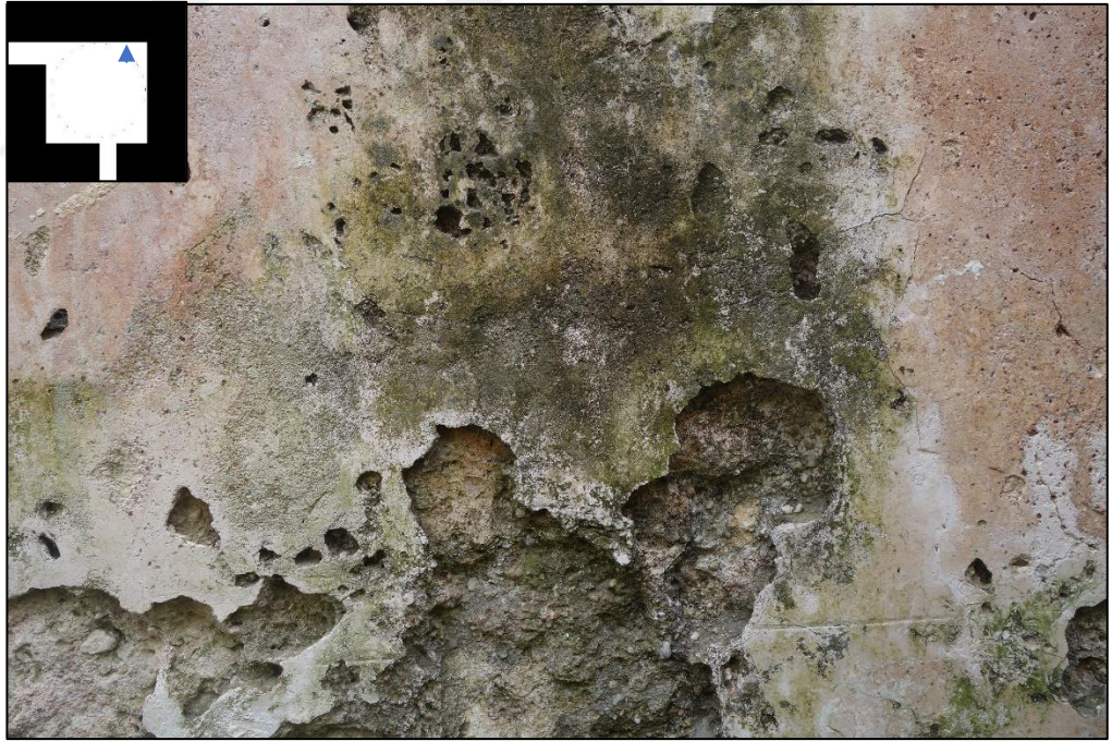
Resim 551 Sıcaklık Bölümü Batı Duvarı (3 Nolu) d. Renk Değişimi e. Biyolojik Oluşumlar
