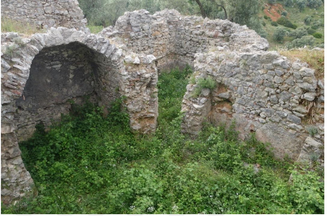
Resim 364 Yelli Hamamı Sıcaklık Bölümü Güney Doğudan Bir Görünüm
