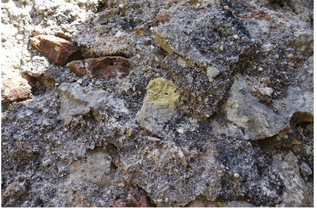
Resim 225 Kuzey Halvet Odası Kuzey Duvarı (3 Nolu) d. Renk Değişimi e. Biyolojik Oluşumlar
