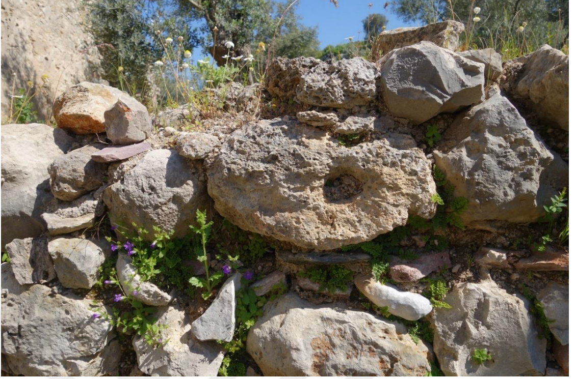
Resim 24 Soymalılık Bölümü Kuzey Duvarı (1 Nolu) c. Petek Gözlük e. Köklü Bitkiler
