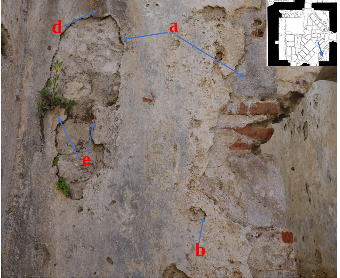
Resim 84 Ilıklık Bölümü Harç Malzeme (4 Nolu)
