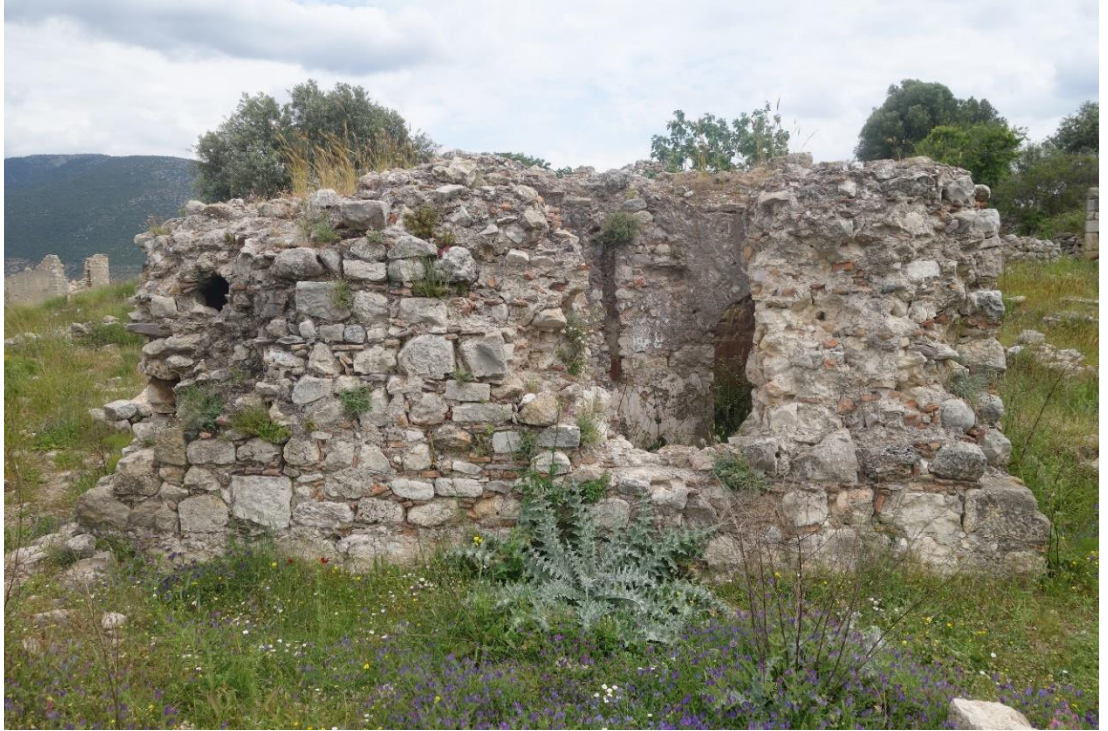
Resim 517 Kale Hamamı Kuzey Duvar Genel Görünüş
