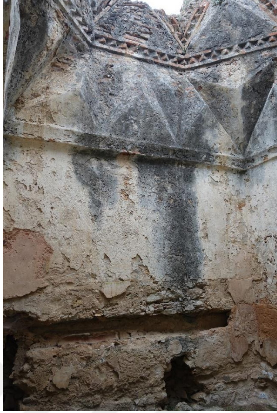
Resim 144 Doğu Halvet Odası Batı Duvarı (8 Nolu) a. Malzeme Kaybı d. Renk Değişimi e. Köklü Bitkiler
