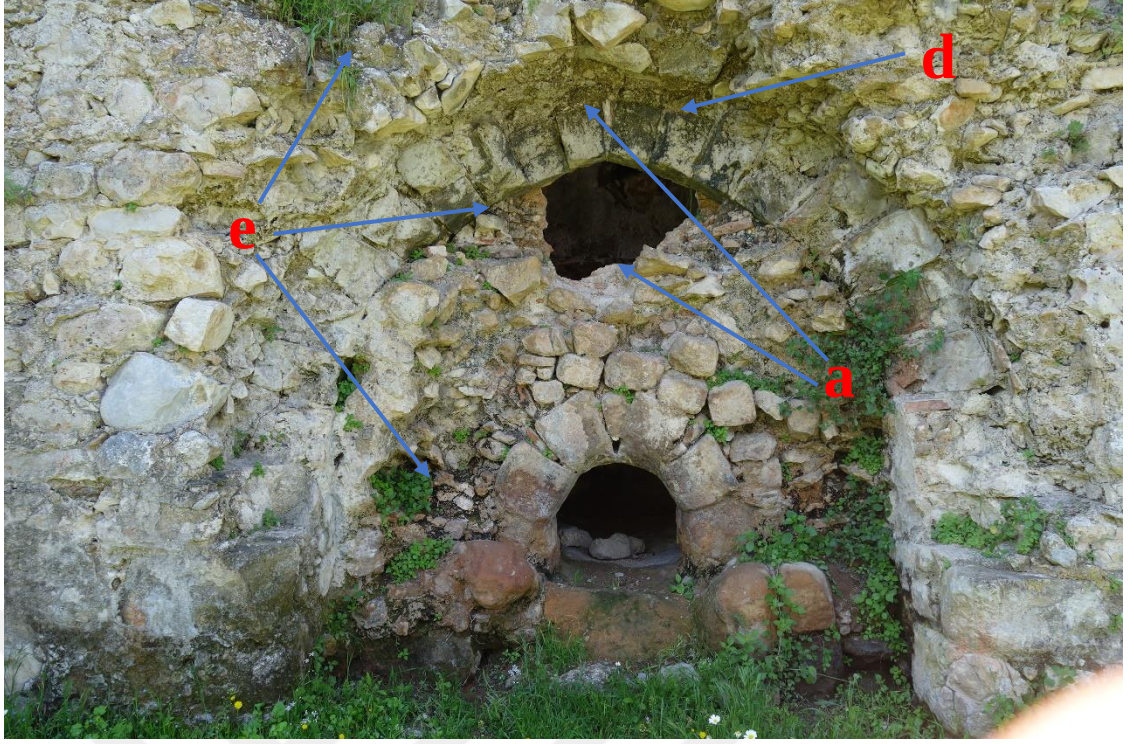
Resim 179 Külhan Bölümü (11 Nolu) a. Malzeme Kaybı d. Renk Değişimi e. Biyolojik Oluşumlar ve Köklü Bitkiler
