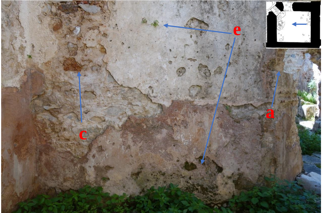
Resim 149 Doğu Halvet Odası Güney Duvarı (8 Nolu) a. Malzeme Kaybı c. Petek Gözlülük e. Biyolojik Oluşumlar ve Köklü Bitkiler
