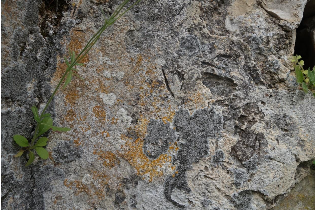
Resim 413 Ilıkkık Bölümü Doğu Duvarı (4 Nolu) e. Biyolojik Oluşum d. Renk Değişimi
