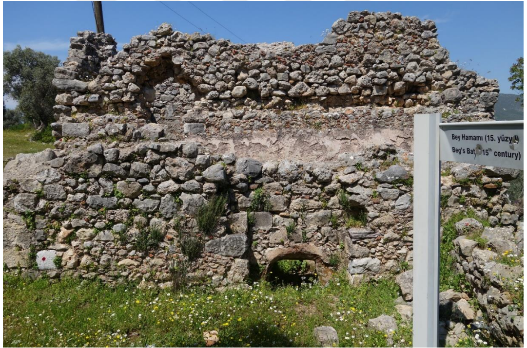
Resim 190 Bey Hamamı Doğu Duvarı Genel Görünüş
