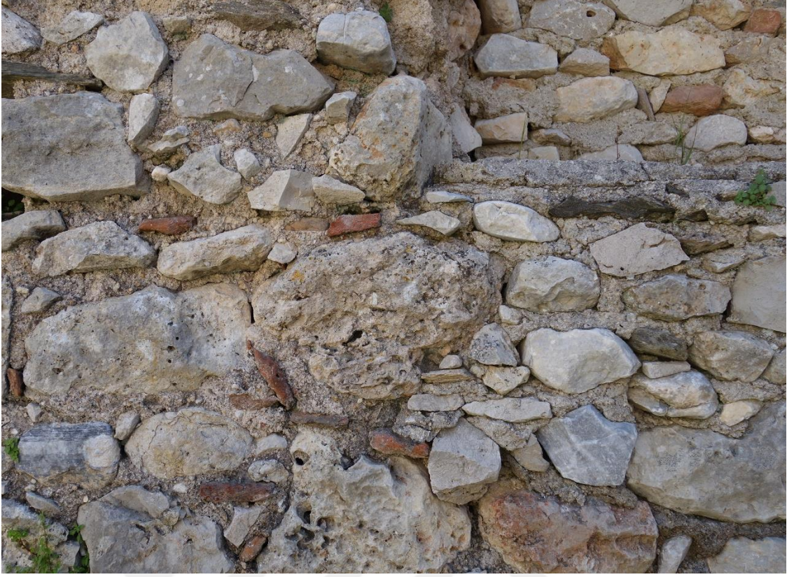
Resim 14 Soyunmalık Bölümü Doğu Duvarı (1 Nolu) c. Petek Gözlülük
