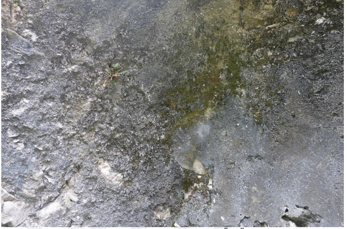
Resim 438 Sıcaklık Bölümü Doğu Eyvanı Üst Örtü (6 Nolu) d. Renk Değişimi e. Biyolojik Oluşumlar
