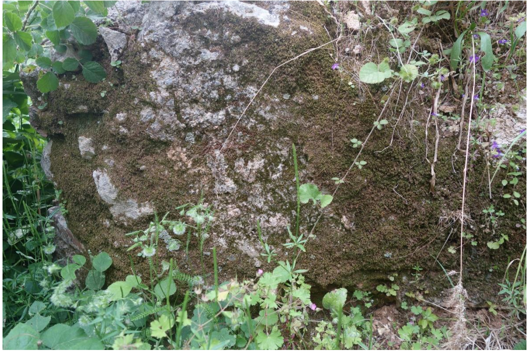
Resim 467 Doğu Halvet Bölümü Doğu Duvarı (7 Nolu) e. Biyolojik Oluşumlar ve Köklü Bitkiler
