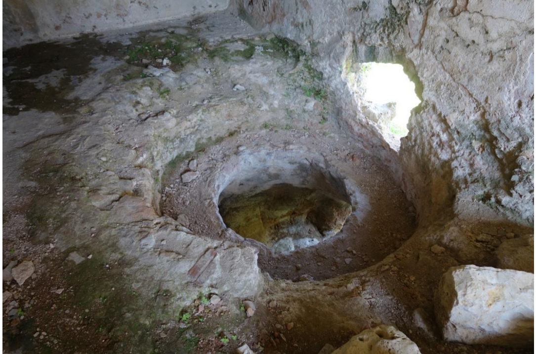
Resim 159 Su Deposu Ocak Bölümü Zemin (9 Nolu) a. Malzeme Kaybı d. Renk Değişimi e. Biyolojik Oluşumlar ve Köklü Bitkiler
