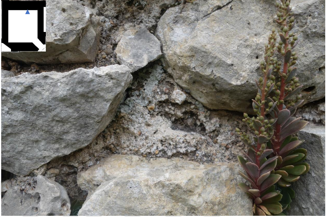
Resim 492 Batı Halvet Kuzey Duvarı Harç Malzeme (8 Nolu) a. Malzeme Kaybı d. Renk Değişimi e. Biyolojik Oluşumlar ve Köklü Bitkiler
