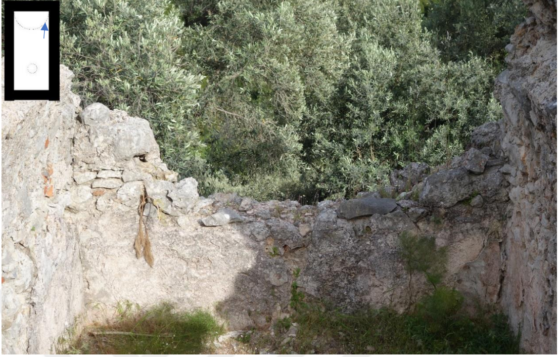
Resim 338 Su Deposu Bölümü Doğu Duvar (8 Nolu) a. Malzeme Kaybı d. Renk Değişimi e. Köklü Bitkiler
