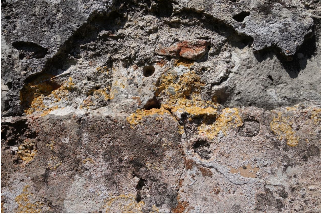
Resim 209 Sıcaklık Bölümü Batı Duvarı (2 Nolu) d. Renk Değişimi e. Biyolojik Oluşum
