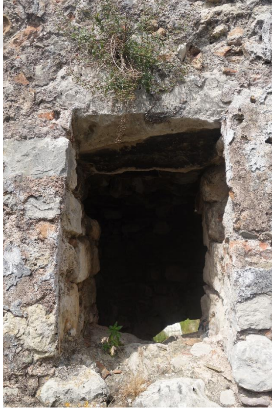
Resim 549 Sıcaklık Bölümü Doğu Duvarı (3 Nolu) e. Köklü Bitkiler
