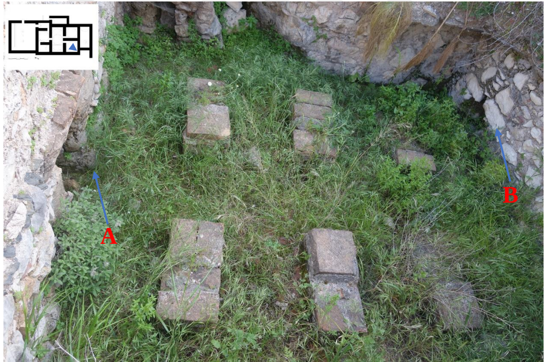
Resim 355 Batı Halvet Bölümü Payeler (6 Adet) Duman Kanalı (A) Tüteklik (B)
