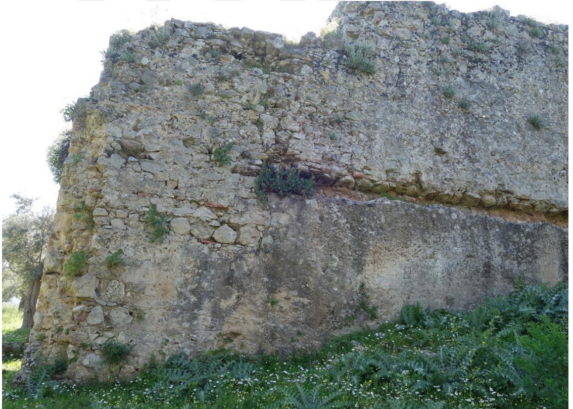
Resim 6 Büyük Hamam Batı Duvarı Genel Görünüş (17 Nolu)
