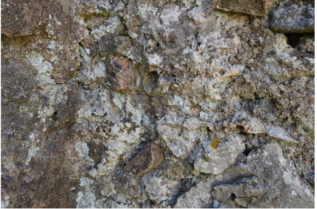
Resim 229 Kuzey Halvet Odası Güney Duvarı (3 Nolu) e. Biyolojik Oluşumlar
