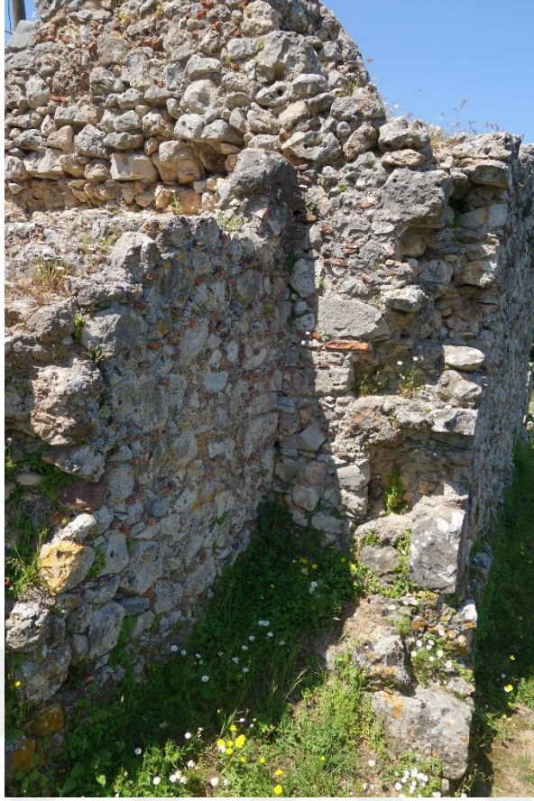
Resim 193 Bey Hamamı Kuzey Doğu Duvar Genel Görünüş
