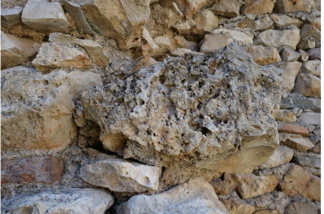
Resim 27 Soyunmalık Bölümü Güney Duvarı (1 Nolu) c. Petek Gözlülük
