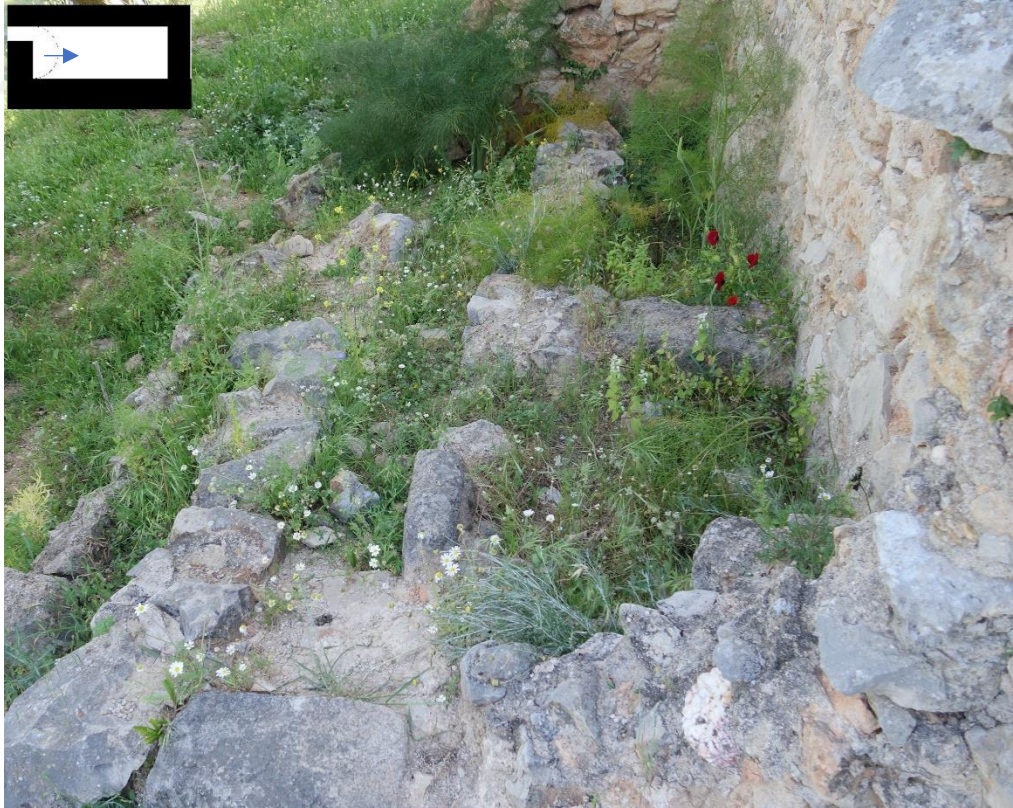
Resim 345 Ek Mekân (9 Nolu) a. Malzeme Kaybı e. Köklü Bitkiler
