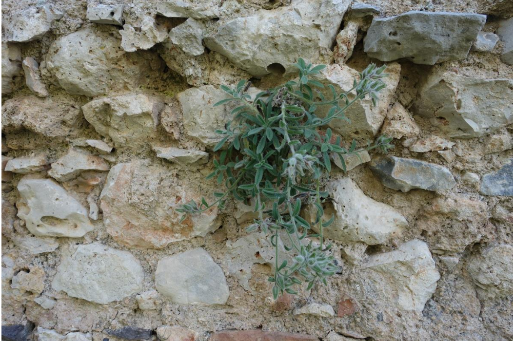
Resim 347 Ek Mekân Batı Duvarı (9 Nolu) e. Köklü Bitkiler
