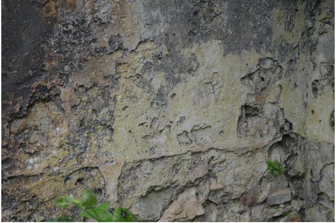
Resim 446 Sıcaklık Bölümü Batı Eyvanı (6 Nolu) d. Renk Değişimi e. Köklü Bitkiler ve Biyolojik Oluşumlar
