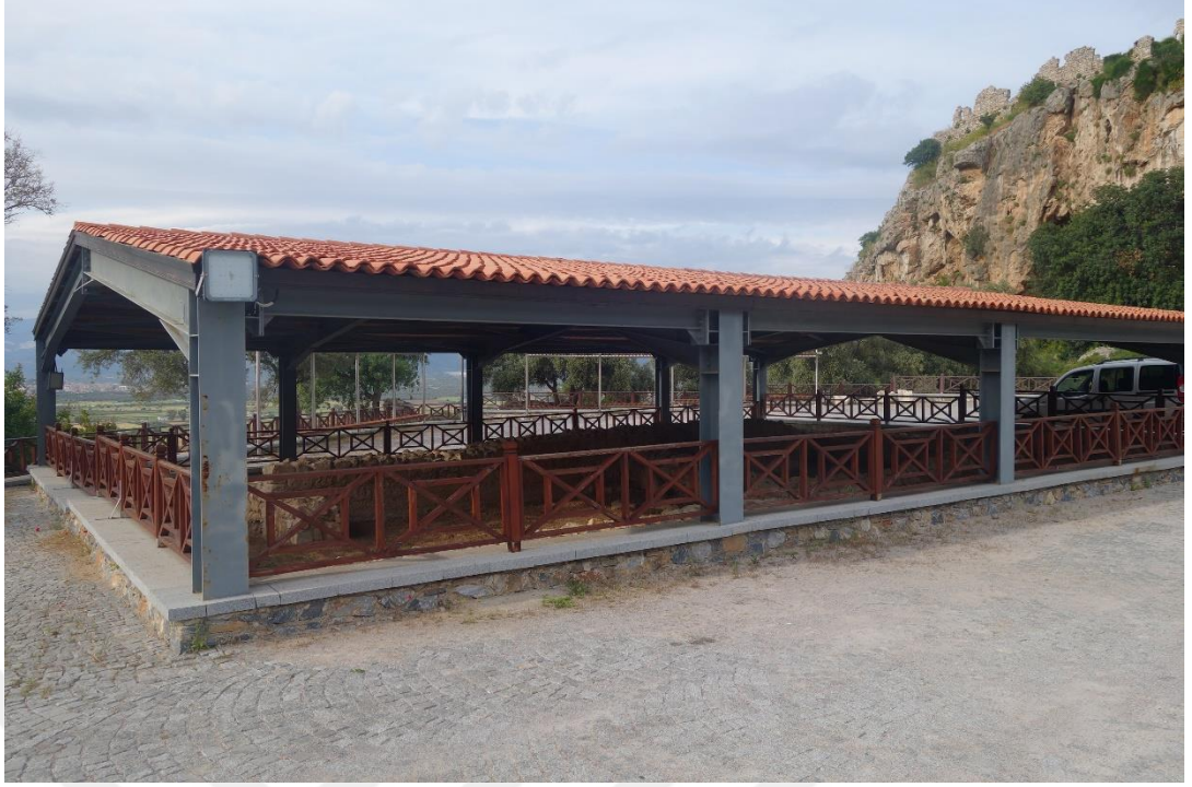
Resim 569 Karşılama Merkezi Yeni Hamamı Güney Batıdan Bir Görünüm
