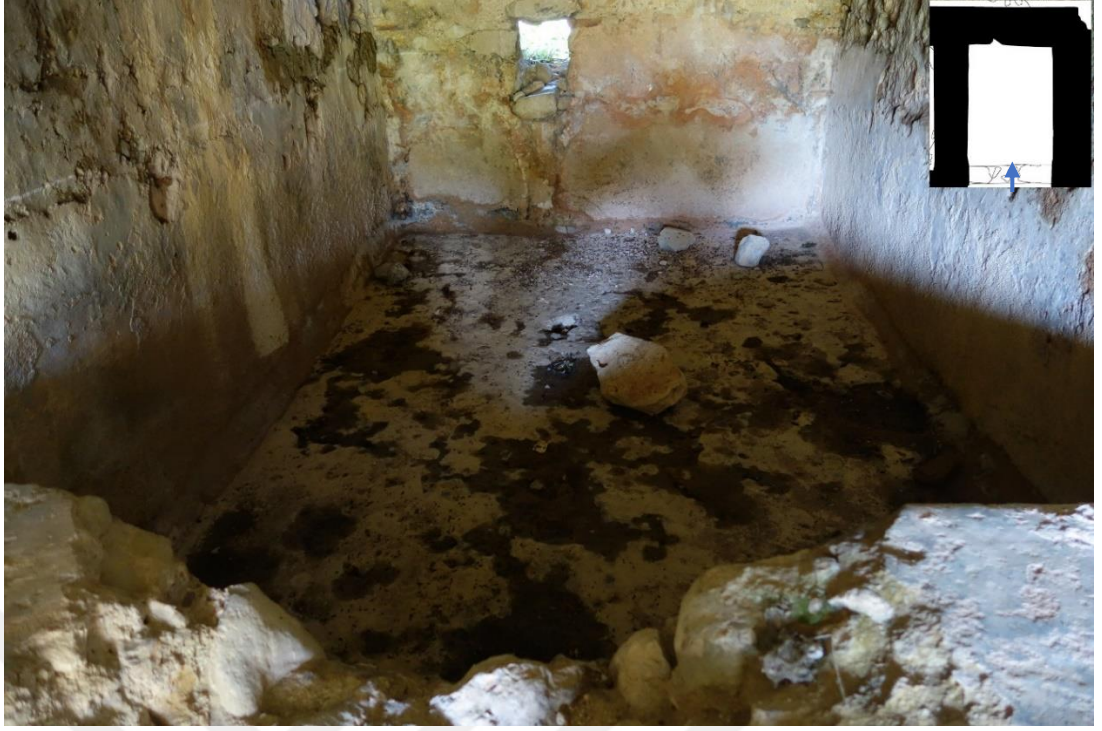
Resim 169 Su Deposu (2) Zemin (10 Nolu)
