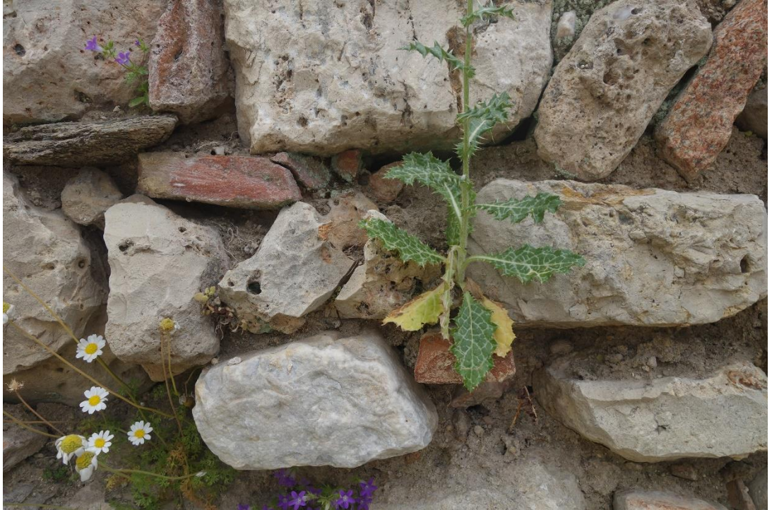
Resim 525 Soyunmalık Bölümü Batı Duvar (1 Nolu) c. Petek Gözlülük e. Köklü Bitkiler
