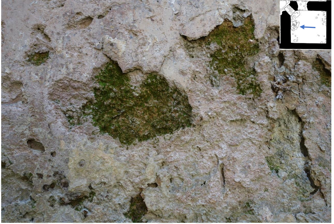
Resim 150 Doğu Halvet Odası Güney Duvarı (8 Nolu) a. Malzeme Kaybı e. Biyolojik Oluşumlar
