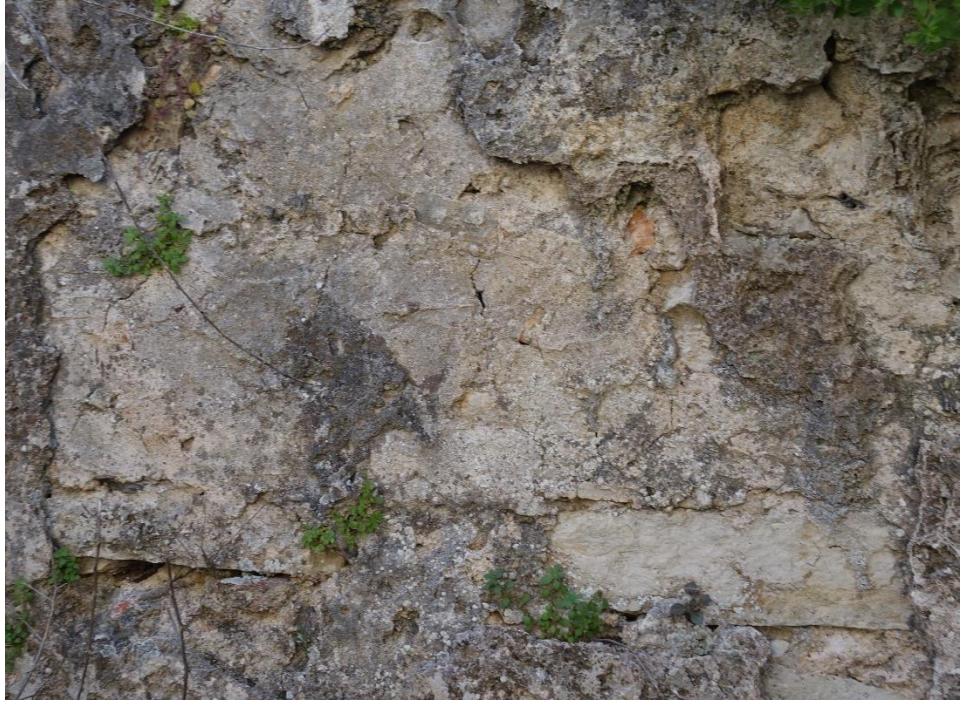
Resim 301 Traşlık Bölümü Batı Duvar (4 Nolu) d. Renk Değişimi e. Biyolojik Oluşum ve Köklü Bitkiler
