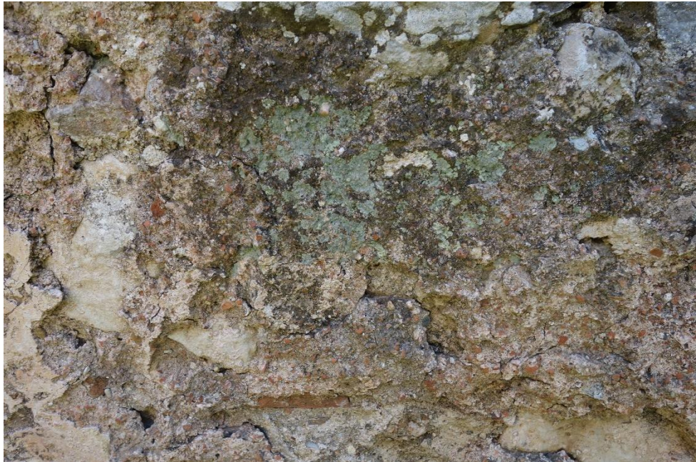
Resim 219 Kuzey Halvet Odası Doğu Duvarı (3 Nolu) d. Renk Değişimi e. Biyolojik Oluşumlar
