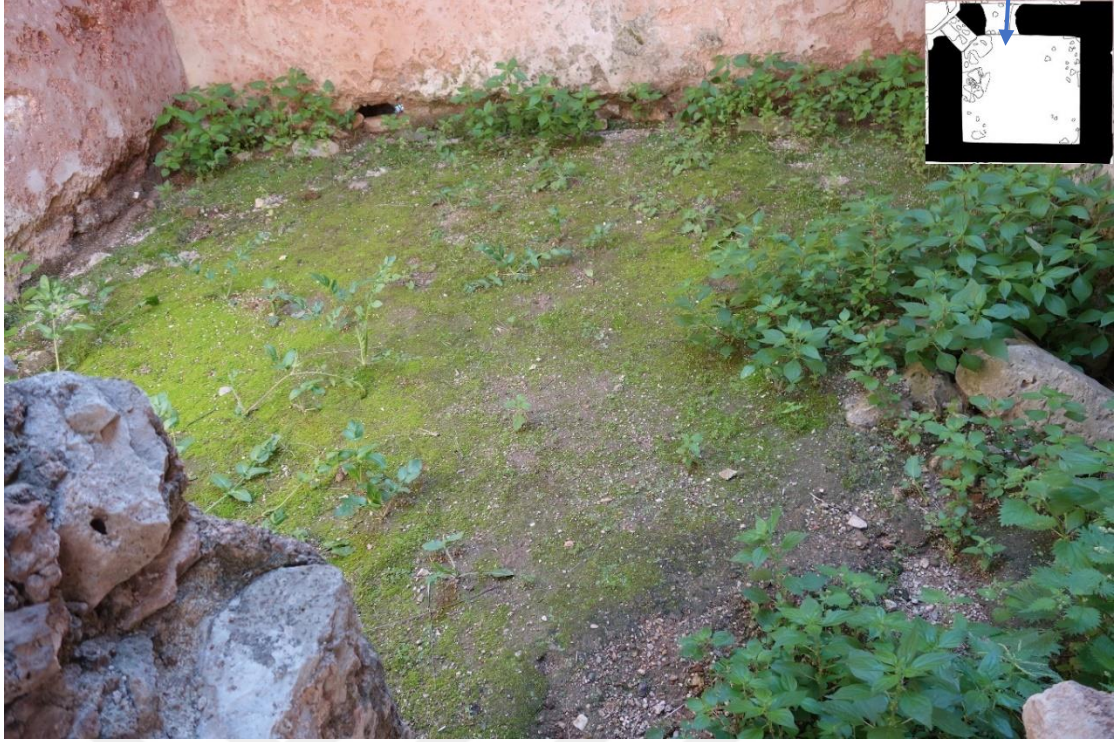
Resim 140 Doğu Halvet Odası Zemin (8 Nolu) a. Malzeme Kaybı e. Biyolojik Oluşum ve Köklü Bitkiler
