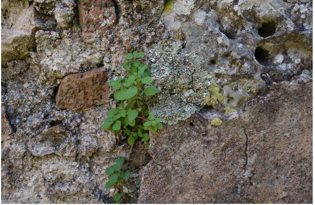
Resim 220 Kuzey Halvet Odası Doğu Duvarı (3 Nolu) d. Renk Değişimi e. Biyolojik Oluşumlar
