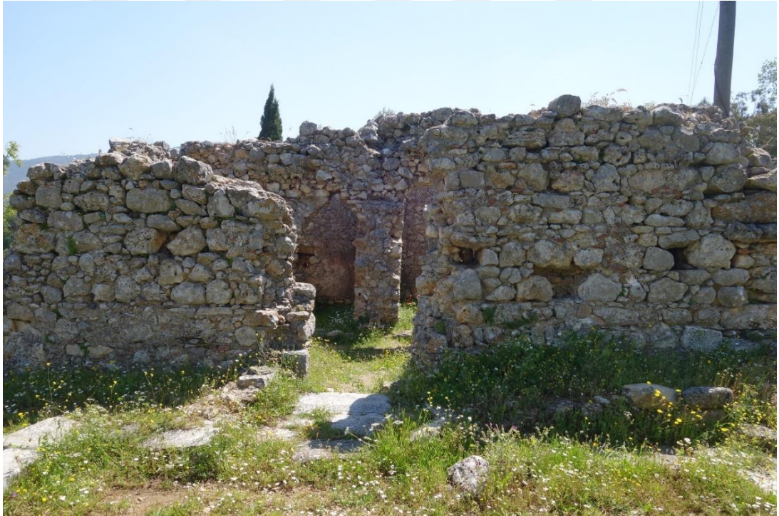
Resim 192 Bey Hamamı Batı Duvarı Genel Görünüş
