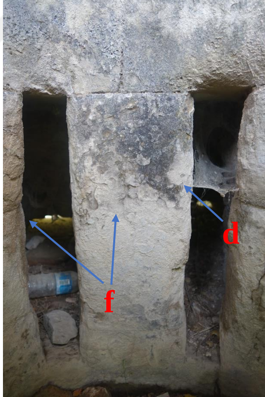
Resim 565 Duman Kanalları d. Renk Değişimi f. Kabuklanma
