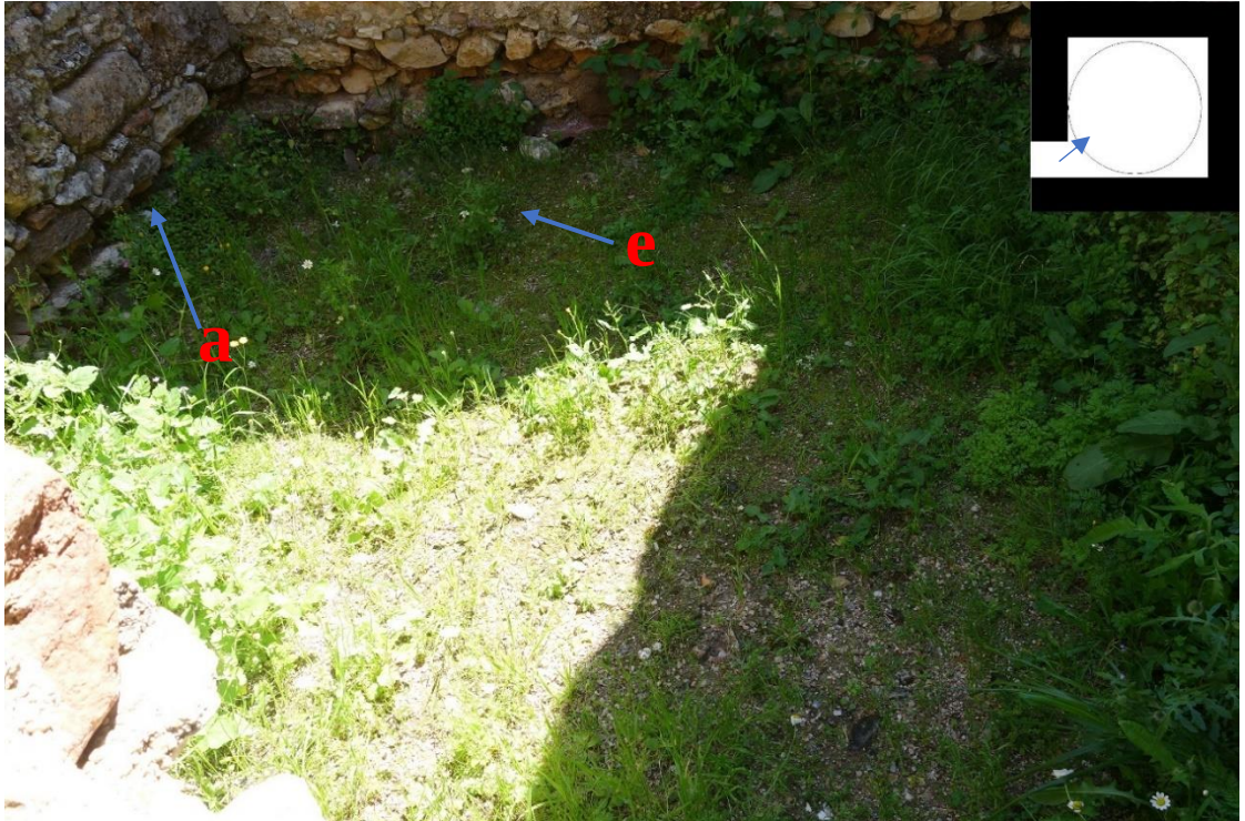
Resim 217 Kuzey Halvet Odası Zemin (3 Nolu) a. Malzeme Kaybı e. Köklü Bitkiler
