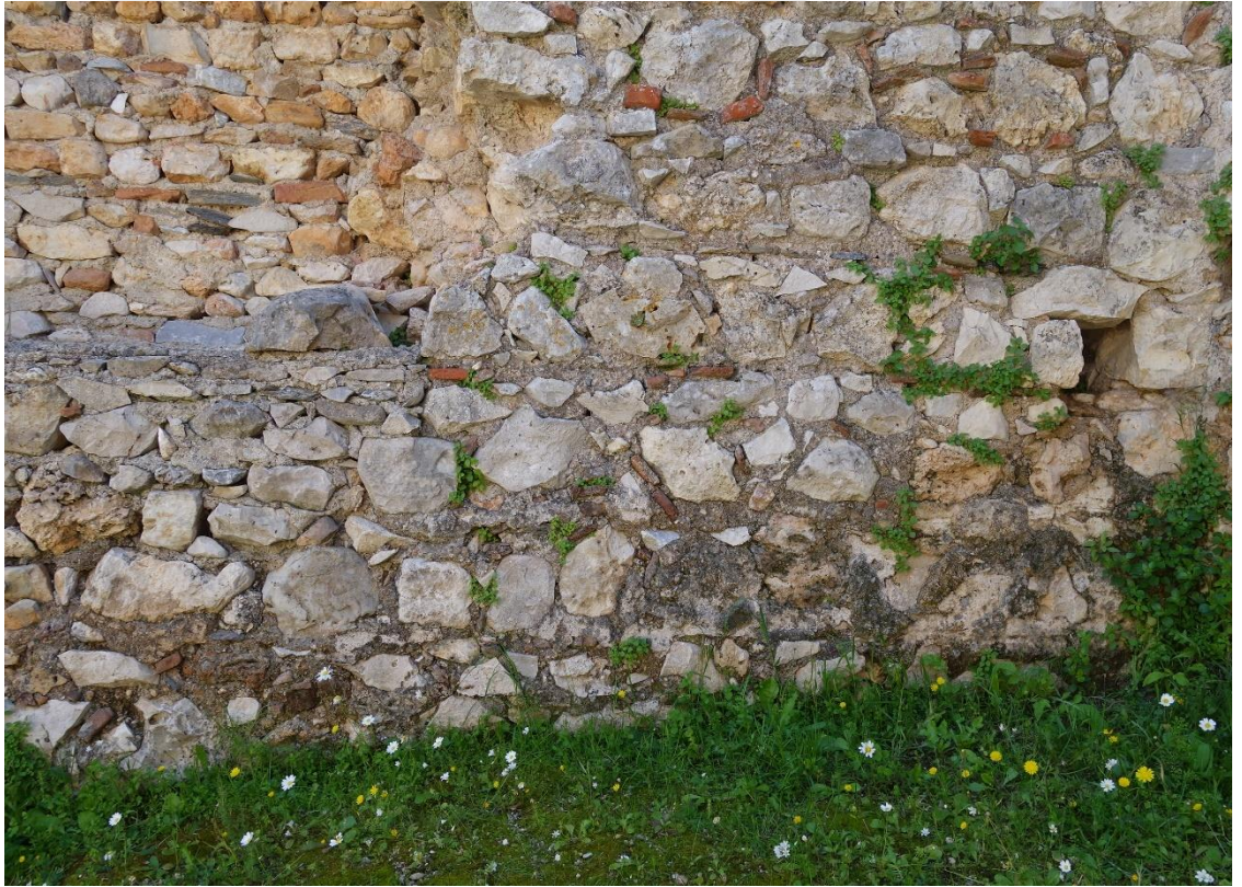
Resim 13 Soyunmalık Bölümü Doğu Duvarı (1 Nolu) d. Renk Değişimi e. Köklü Bitkiler
