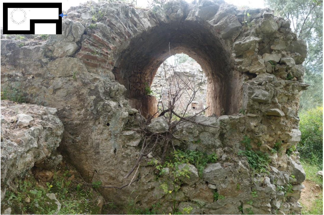
Resim 497 Su Deposu Bölümü (1) Genel Görünüş (9 Nolu)
