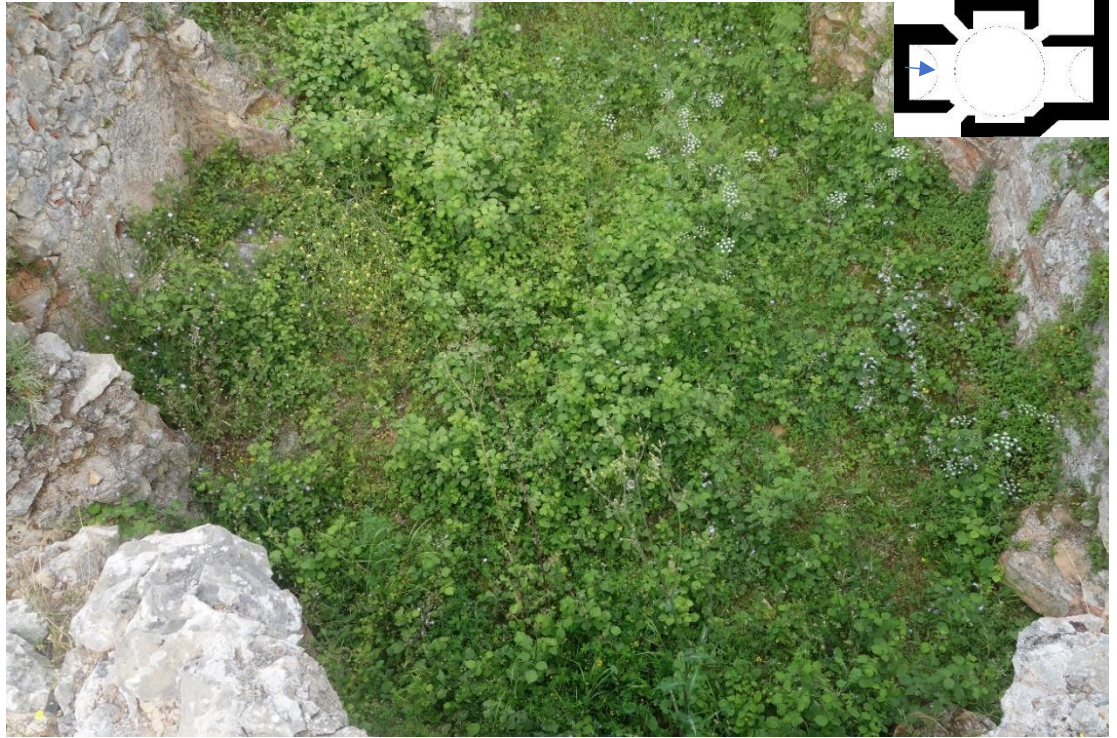
Resim 431 Sıcaklık Bölümü Zemin (6 Nolu) e. Köklü Bitkiler
