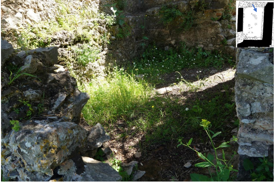
Resim 182 Ek Mekân Zemin (12 Nolu)
