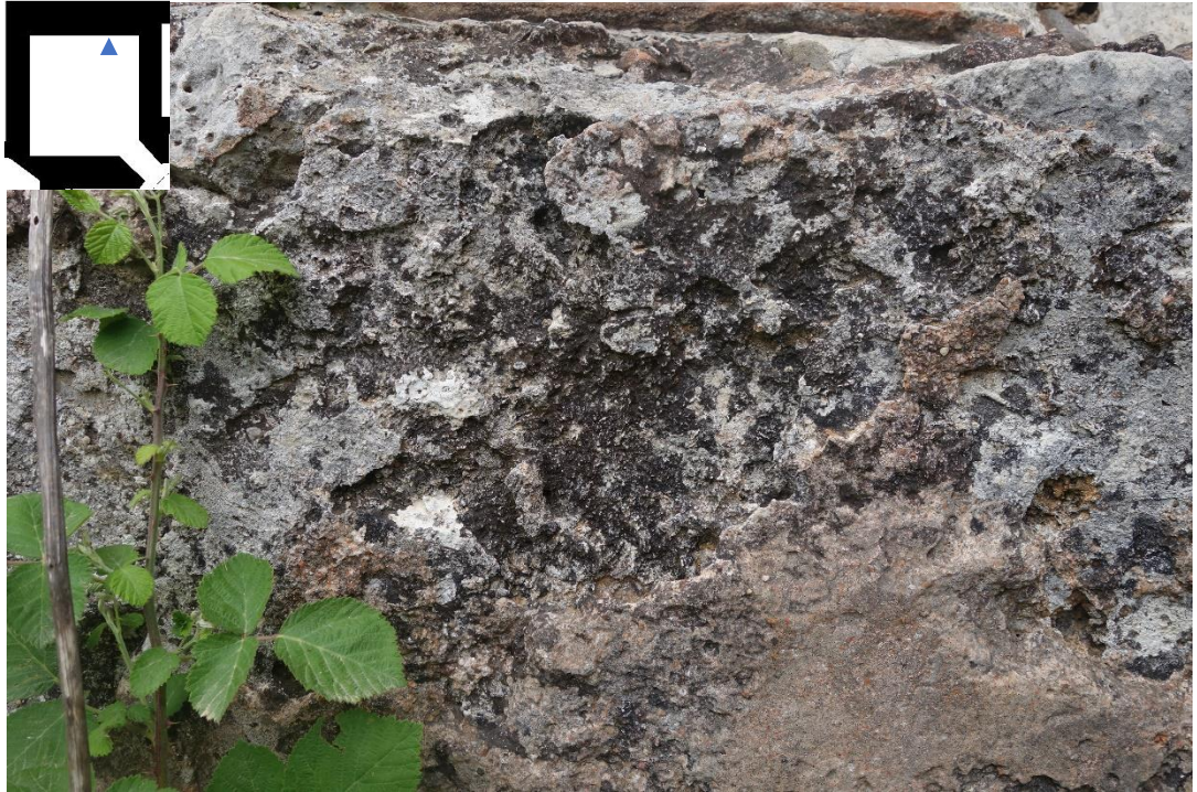
Resim 493 Batı Halvet Kuzey Duvarı Sıva Malzeme (8 Nolu) a. Malzeme Kaybı d. Renk Değişimi e. Biyolojik Oluşumlar
