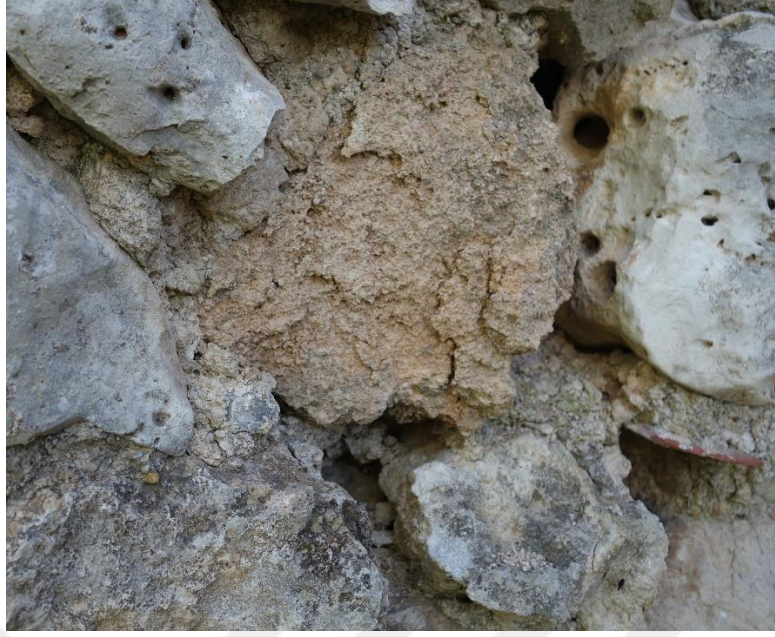
Resim 350 Ek Mekân Güney Duvar (9 Nolu) f. Kabuklanma
