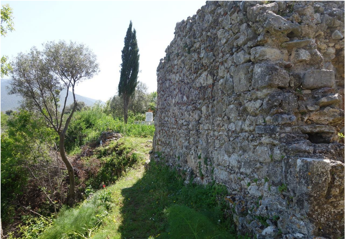
Resim 194 Bey Hamamı Kuzey Duvarı Genel Görünüş
