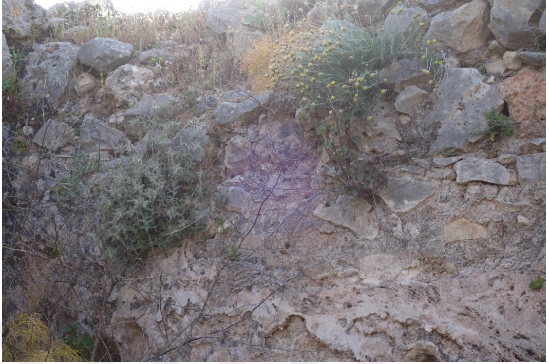
Resim 332 Batı Halvet Bölümü Batı Duvar (7 Nolu) e. Köklü Bitkiler
