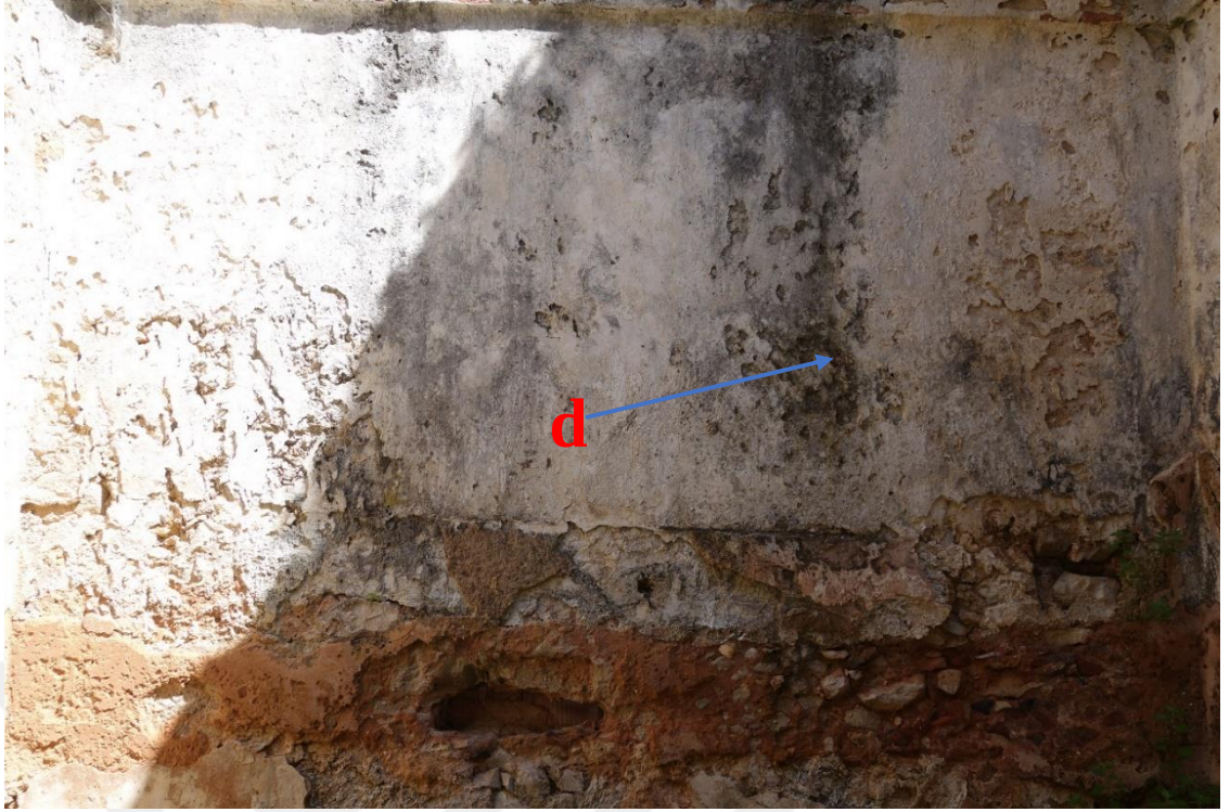
Resim 136 Batı Halvet Odası Kuzey Duvarı (7 Nolu) d. Renk Değişimi
