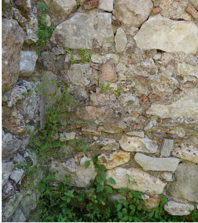
Resim 238 Güney Halvet Odası Doğu Duvarı (4 Nolu) e. Köklü Bitkiler
