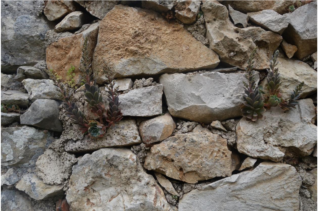
Resim 483 Batı Halvet Batı Duvarı (8 Nolu) e. Köklü Bitkiler
