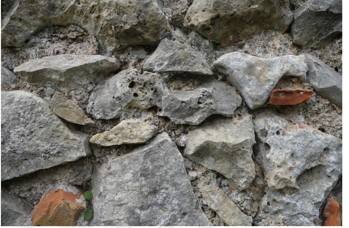
Resim 450 Sıcaklık Bölümü Kuzey Eyvanı (6 Nolu) c. Petek Gözlülük
