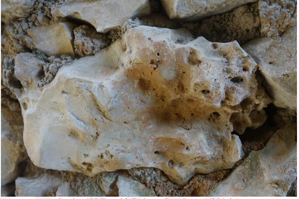
Resim 400 Tıraşlık Bölümü Batı Duvar (3 Nolu) c. Petek Gözlülük
