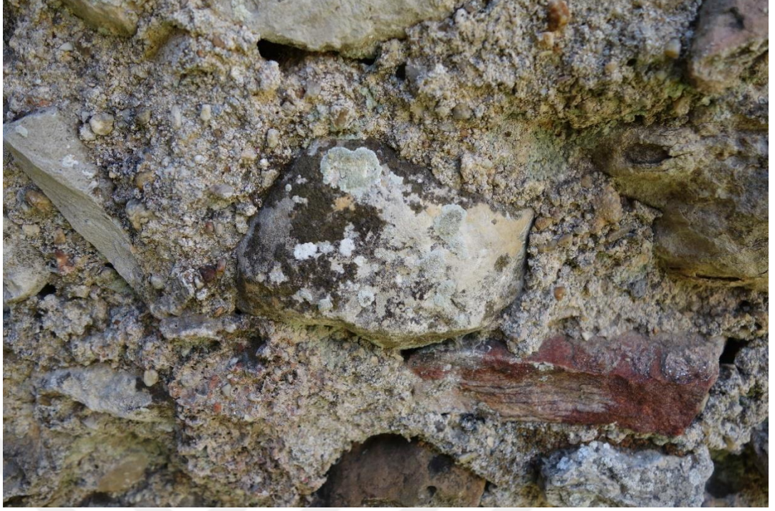
Resim 230 Kuzey Halvet Odası Güney Duvarı (3 Nolu) e. Biyolojik Oluşumlar
