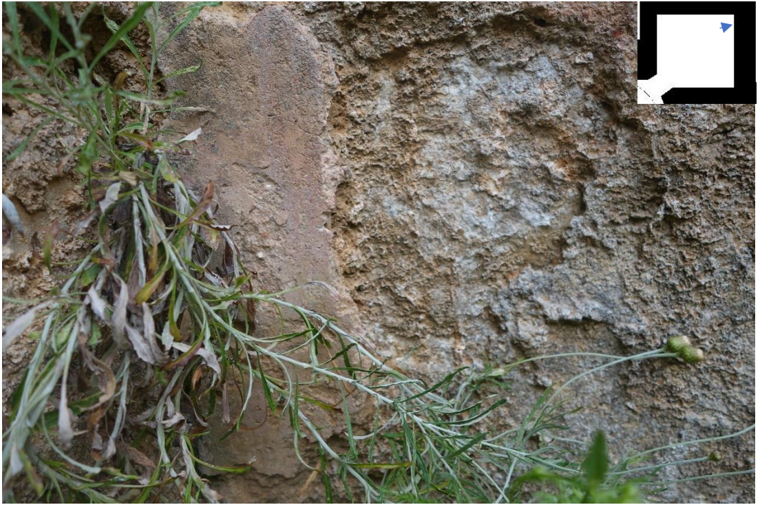
Resim 473 Doğu Halvet Bölümü Doğu Duvarı Sıva Malzeme (7 Nolu) a. Malzeme Kaybı d. Renk Değişimi e. Köklü Bitkiler
