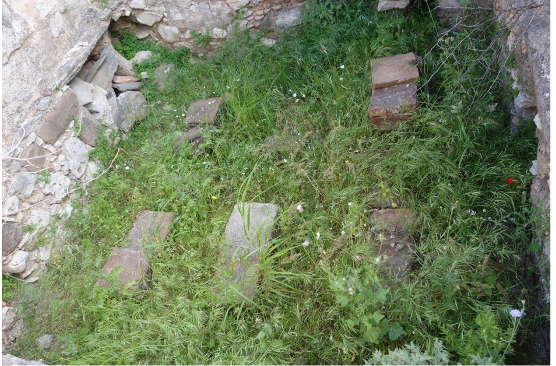
Resim 323 Doğu Halvet Bölümü Zemin (6 Nolu) a. Malzeme Kaybı e. Köklü Bitkiler
