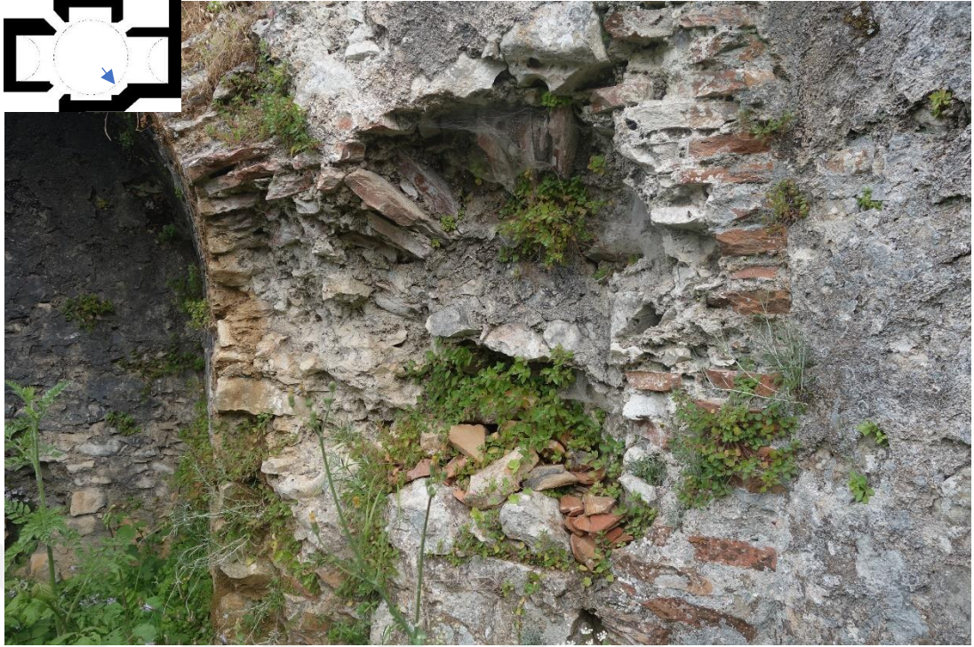
Resim 458 Sıcaklık Bölümü Güney Eyvanı (6 Nolu) a. Malzeme Kaybı b. Çatlak d. Renk Değişimi e. Köklü Bitkiler
