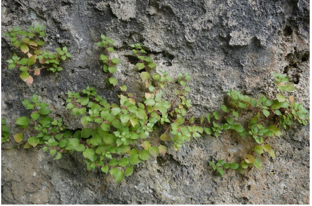
Resim 436 Sıcaklık Bölümü Doğu Eyvanı (6 Nolu) d. Renk Değişimi e. Köklü Bitkiler
