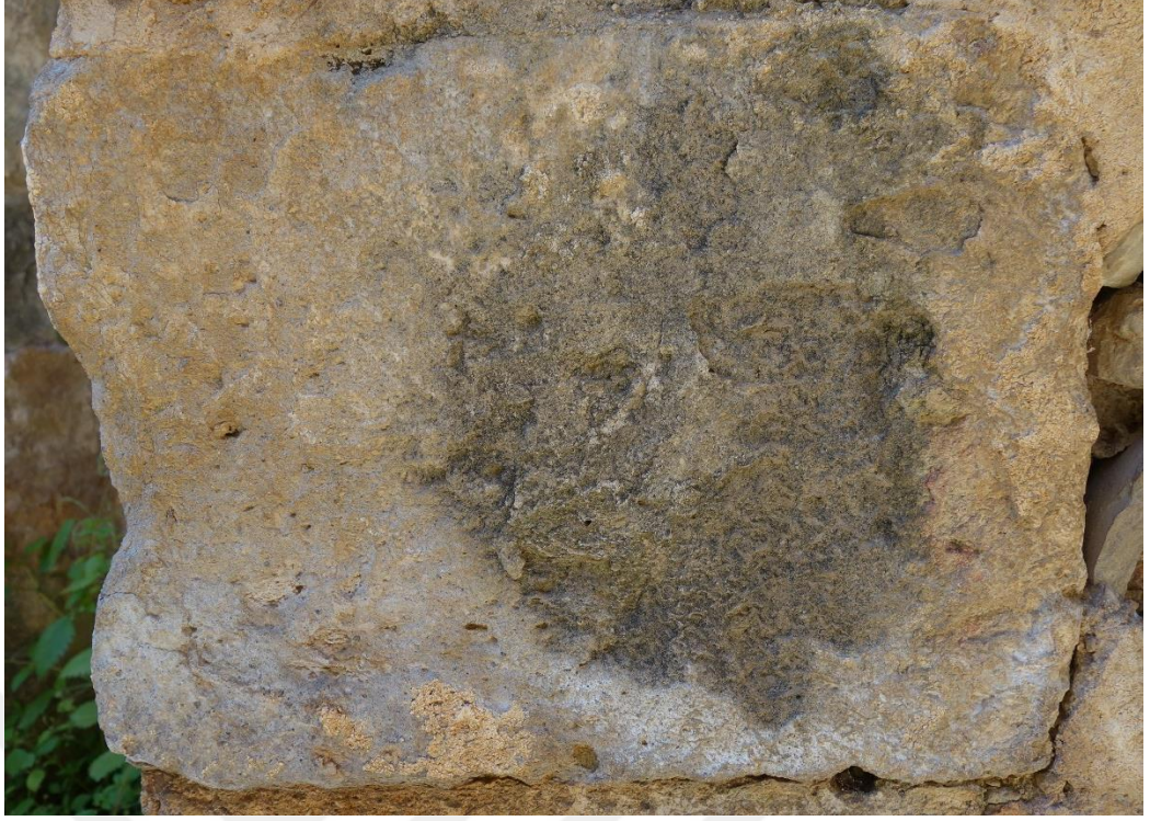
Resim 112 Sıcaklık Bölümü Batı Eyvan (6 Nolu) c. Petek Gözlülük
