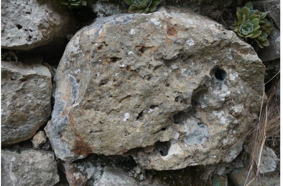
Resim 491 Batı Halvet Güney Duvarı (8 Nolu) c. Petek Gözlülük e. Biyolojik Oluşumlar ve Köklü Bitkiler
