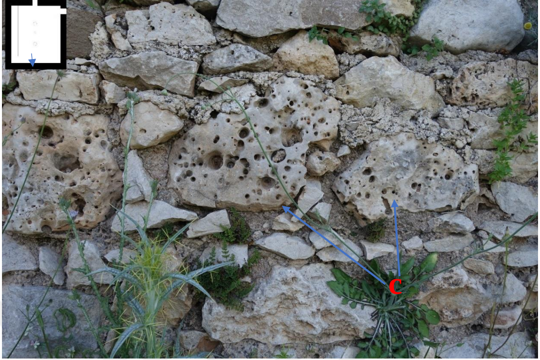
Resim 269 Soyunmalık Bölümü Batı Duvarı (1 Nolu) c. Petek Gözlülük
