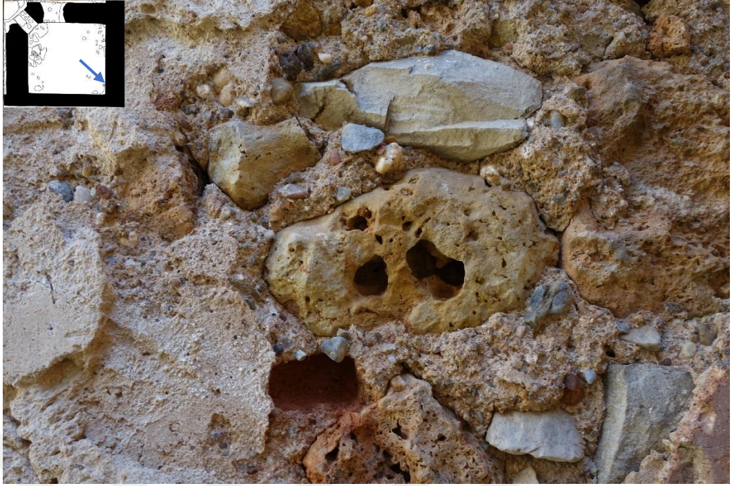
Resim 156 Doğu Halvet Odası Harç Malzeme (8 Nolu) a. Malzeme Kaybı
