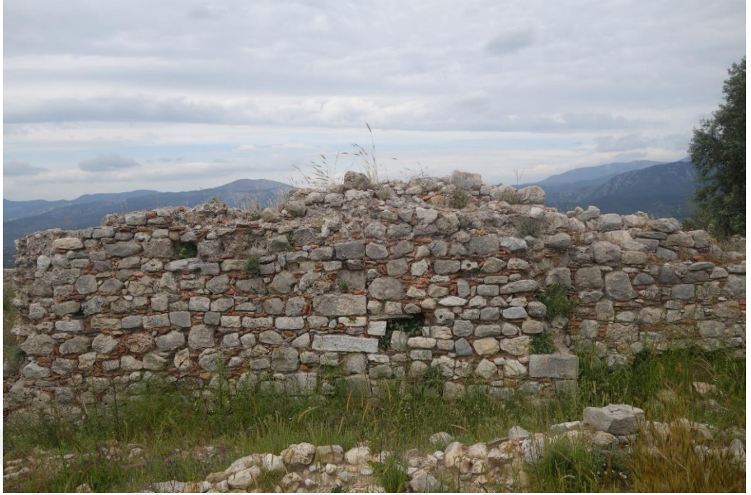
Resim 518 Kale Hamamı Batı Duvar Genel Görünüş
