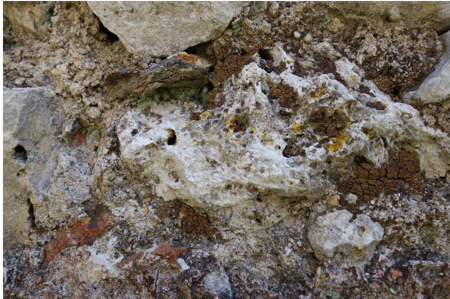
Resim 237 Güney Halvet Odası Doğu Duvarı (4 Nolu) c. Petek Gözlülük e. Biyolojik Oluşumlar
