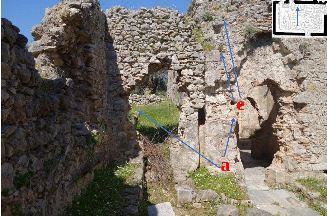
Resim 21 Soyunmalık Bölümü Batı Duvarı (1 Nolu) a. Malzeme e. Köklü Bitkiler
