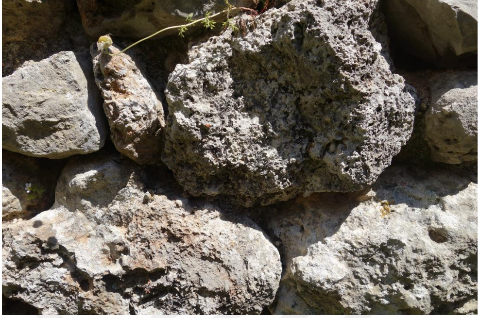
Resim 242 Güney Halvet Odası Kuzey Duvarı (4 Nolu) c. Petek Gözlülük e. Köklü Bitkiler
