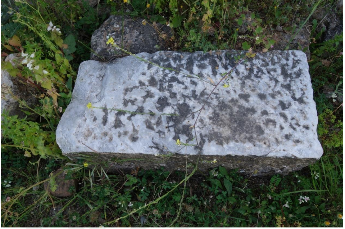
Resim 267 Soyunmalık Bölümü Zemin (1 Nolu) a. Malzeme Kaybı c. Petek Gözlülük d. Renk Değişimi e. Köklü Bitkiler
