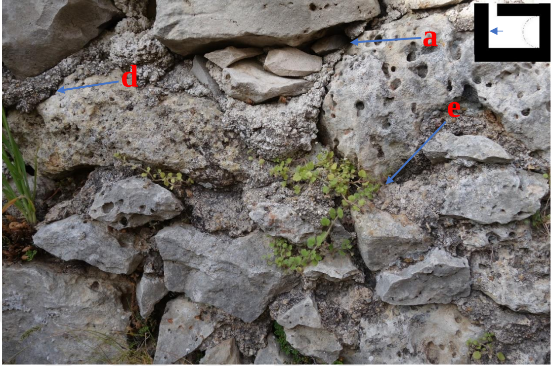
Resim 306 Traşlık Bölümü Kuzey Duvar Harç Malzeme (4 Nolu) a. Malzeme Kaybı d. Renk Değişimi e. Köklü Bitkiler
