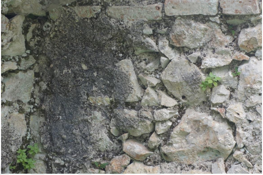
Resim 444 Sıcaklık Bölümü Batı Eyvanı (6 Nolu) d. Renk Değişimi e. Biyolojik Oluşumlar ve Köklü Bitkiler
