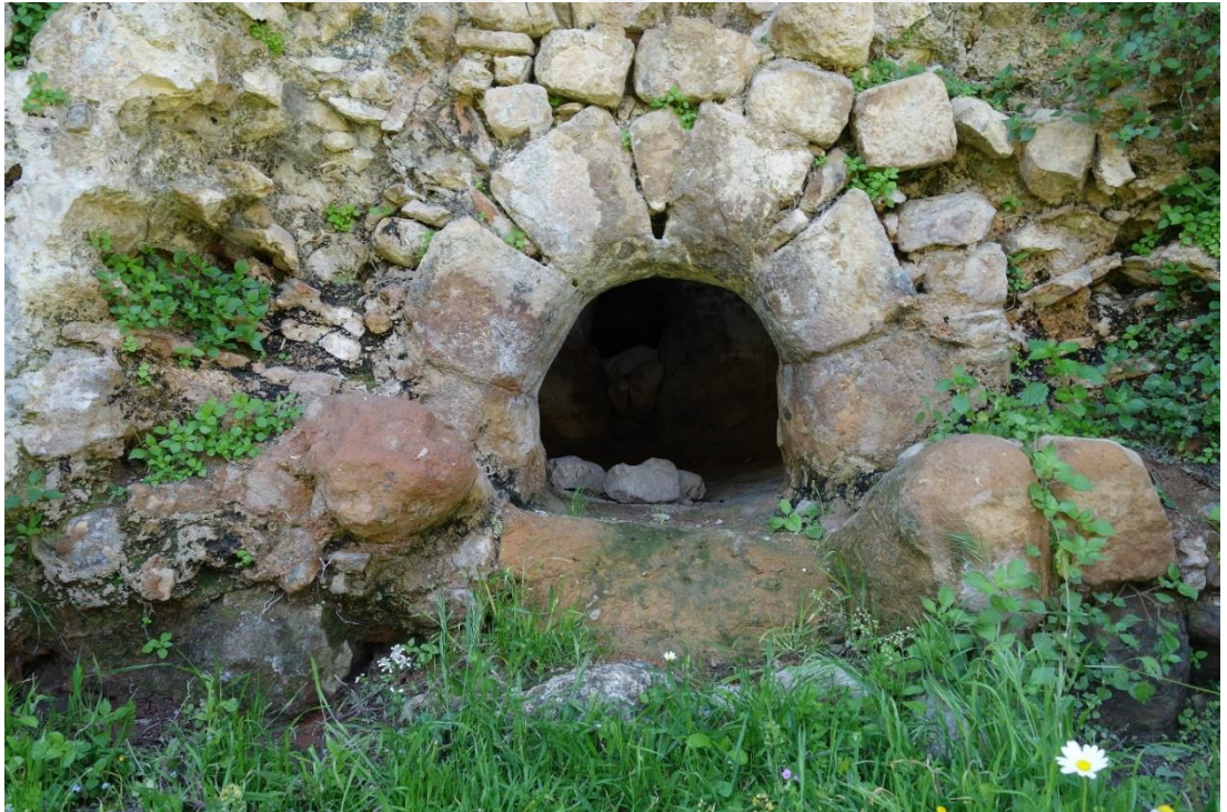
Resim 180 Külhan Bölümü (11 Nolu) a. Malzeme Kaybı d. Renk Değişimi e. Biyolojik Oluşumlar ve Köklü Bitkiler
