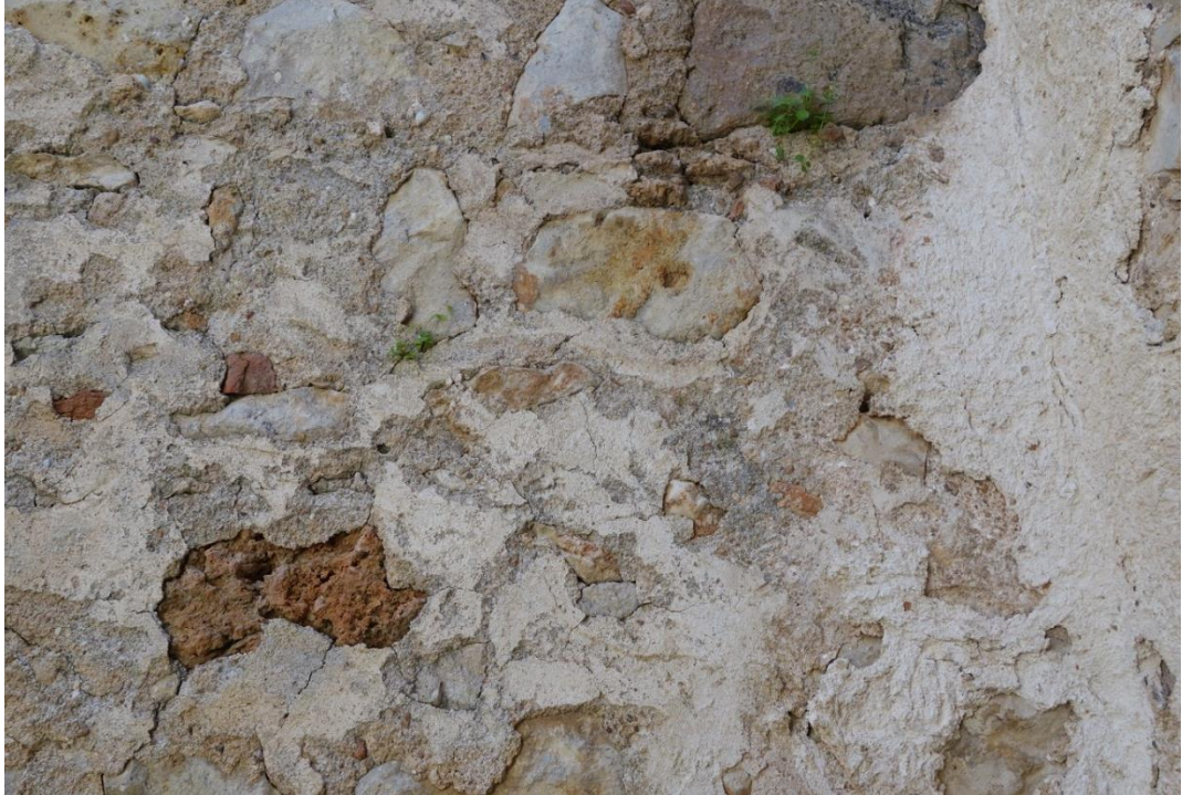
Resim 143 Doğu Halvet Odası Doğu Duvarı (8 Nolu) c. Petek Gözlülük e. Köklü Bitkiler
