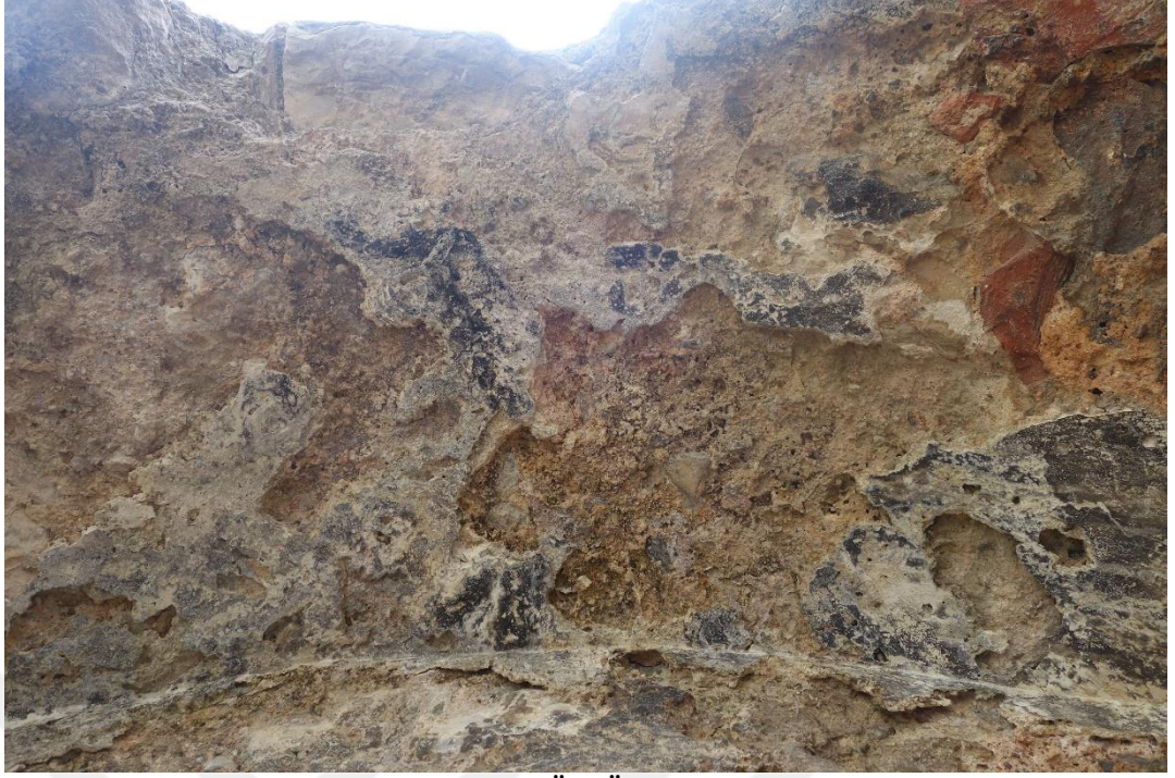
Resim 544 Aralık Bölümü Üst Örtü Sıva Malzeme (2 Nolu) a. Malzeme Kaybı d. Renk Değişimi
