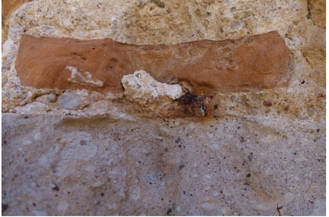
Resim 71 Ilıklık Bölümü Doğu Duvarı (4 Nolu) d. Renk Değişimi
