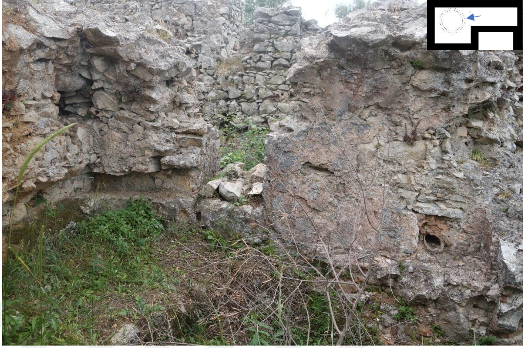
Resim 502 Su Deposu Bölümü (1) Batı Duvarı (9 Nolu) a. Malzeme Kaybı d. Renk Değişimi e. Biyolojik Oluşumlar
