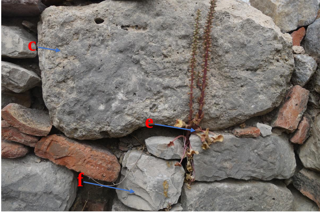
Resim 523 Soyunmalık Bölümü Doğu Duvar (1 Nolu) c. Petek Gözlülük f. Kabuklanma e. Köklü Bitkiler
