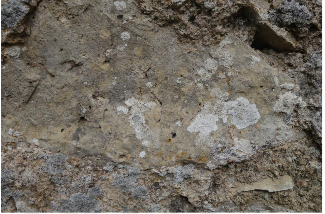
Resim 374 Soymalılık Bölümü Doğu Duvar (1 Nolu) e. Biyolojik Oluşumlar
