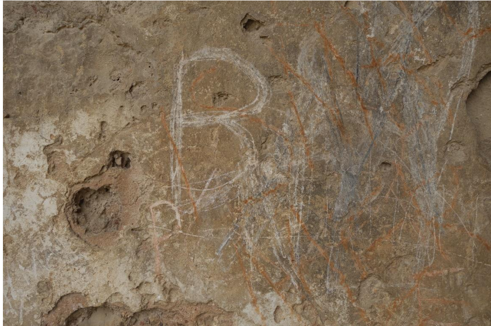
Resim 537 Aralık Bölümü Batı Duvarı (2 Nolu) h. Vandalizm
