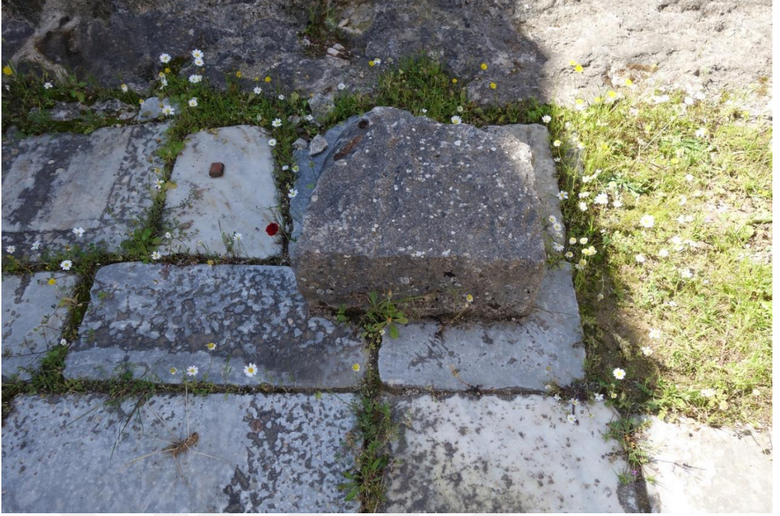
Resim 10 Soyunmalık Bölümü Zemin (1 nolu) c. Petek Gözlülük d. Renk Değişimi e. Köklü Bitki
