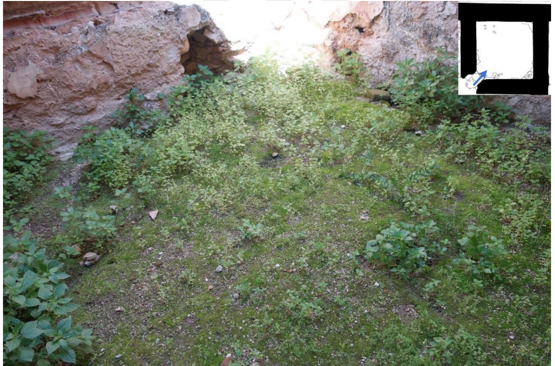
Resim 127 Batı Halvet Odası Zemin (7 Nolu) a. Malzeme Kaybı e. Biyolojik Oluşum ve Köklü Bitkiler
