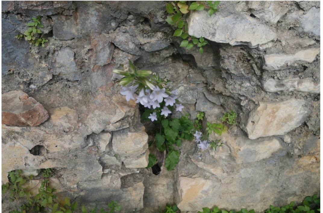
Resim 433 Sıcaklık Bölümü Doğu Eyvanı (6 Nolu) a. Malzeme Kaybı d. Renk Değişimi e. Köklü Bitkiler
