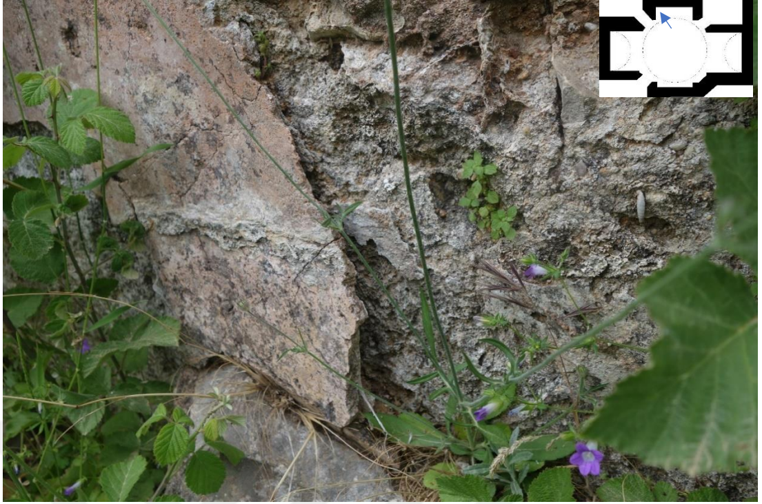
Resim 460 Sıcaklık Bölümü Kuzey Eyvanı Sıva Malzeme (6 Nolu)
