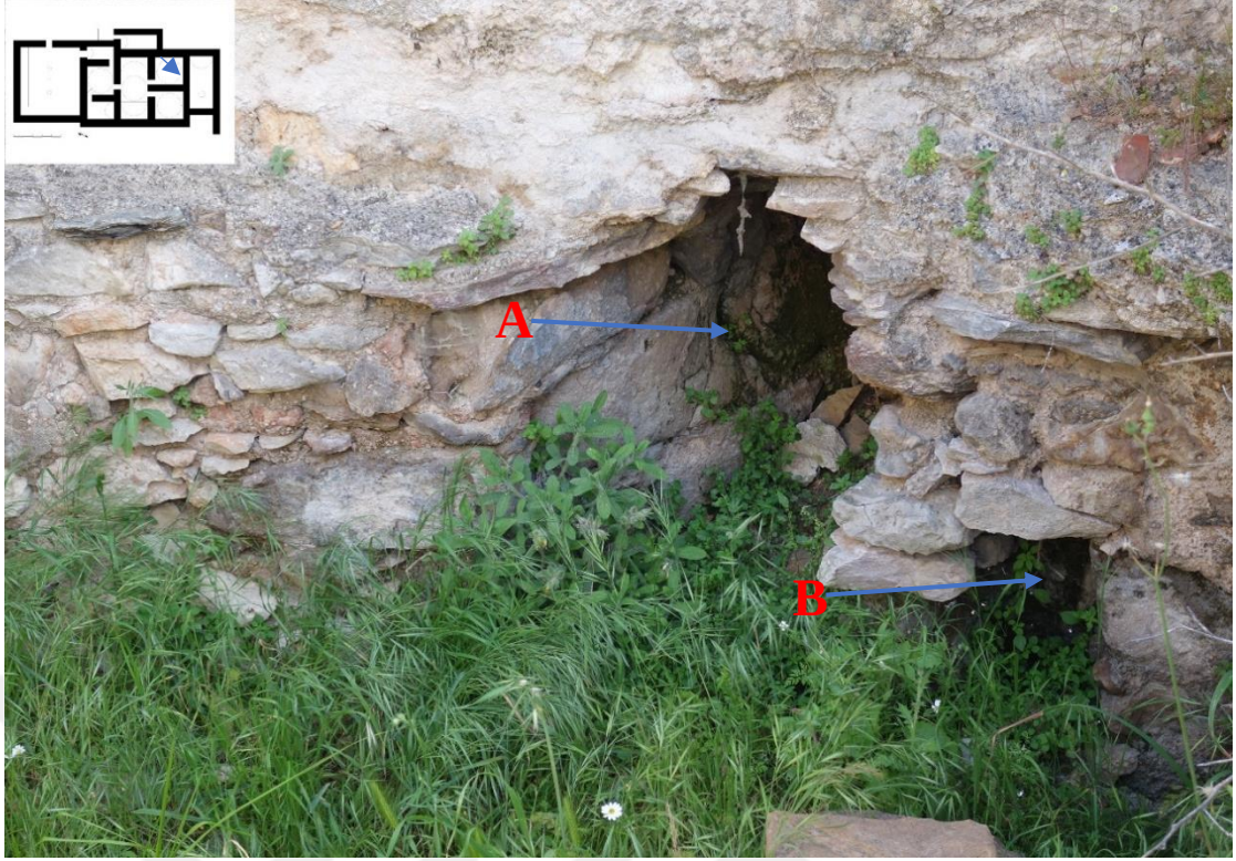
Resim 354 Doğu Halvet Bölümü Duman Kanalı Ağzı (A) ve Tüteklik (B)
