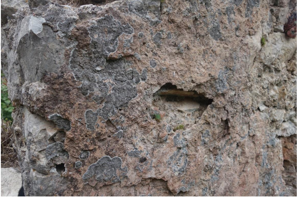
Resim 503 Su Deposu Bölümü (1) Batı Duvarı (9 Nolu) a. Malzeme Kaybı e. Biyolojik Oluşumlar
