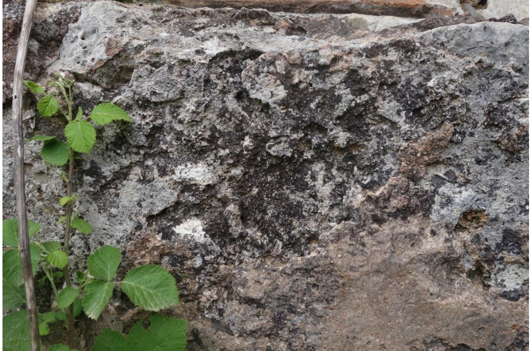
Resim 485 Batı Halvet Kuzey Duvarı (8 Nolu) d. Renk Değişimi
