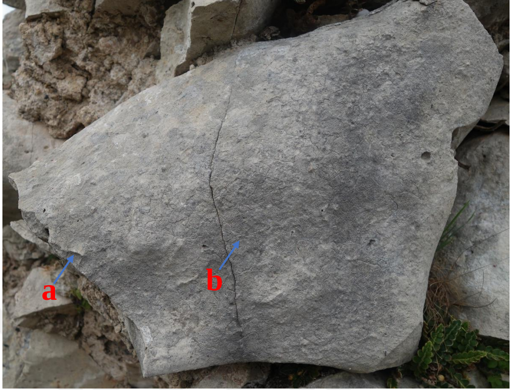
Resim 382 Soyunmalık Bölümü Kuzey Duvar (1 Nolu) a. Malzeme Kaybı b. Çatlak
