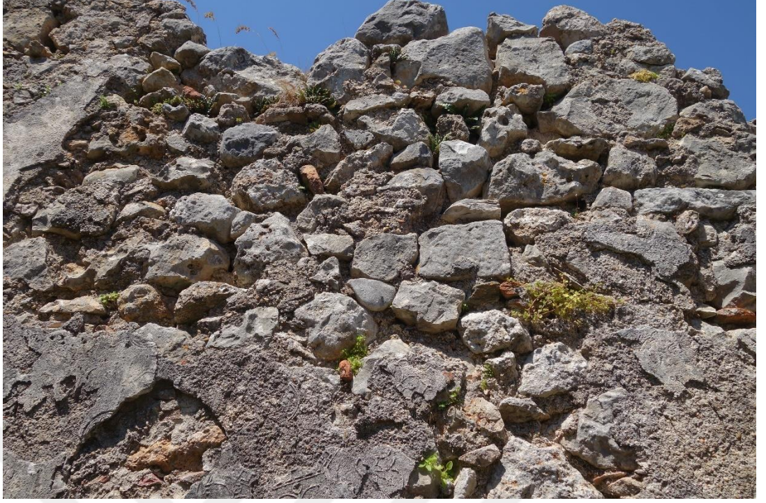
Resim 222 Kuzey Halvet Odası Batı Duvarı (3 Nolu) e. Köklü Bitkiler
