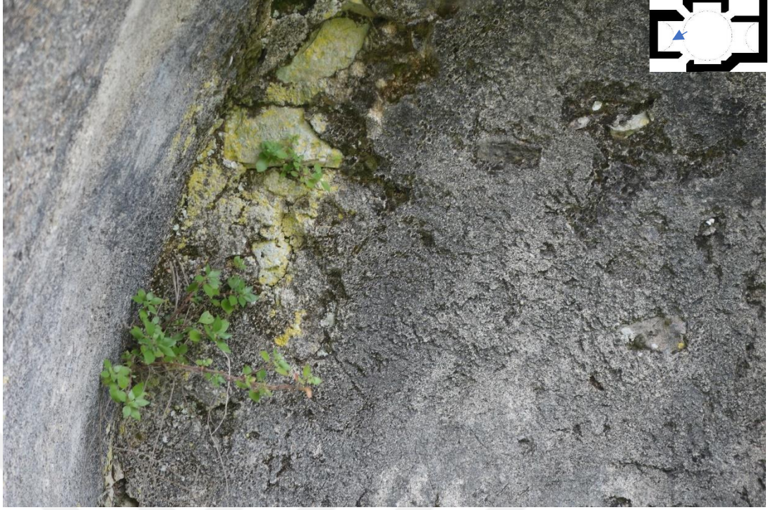
Resim 442 Sıcaklık Bölümü Batı Eyvanı (6 Nolu) e. Biyolojik Oluşumlar
