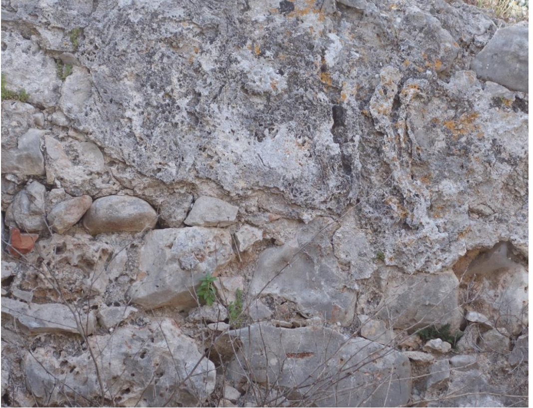
Resim 315 Sıcaklık Bölümü Batı Duvarı (5 Nolu) c. Petek Gözlülük d. Renk Değişimi e. Biyolojik Oluşumlar
