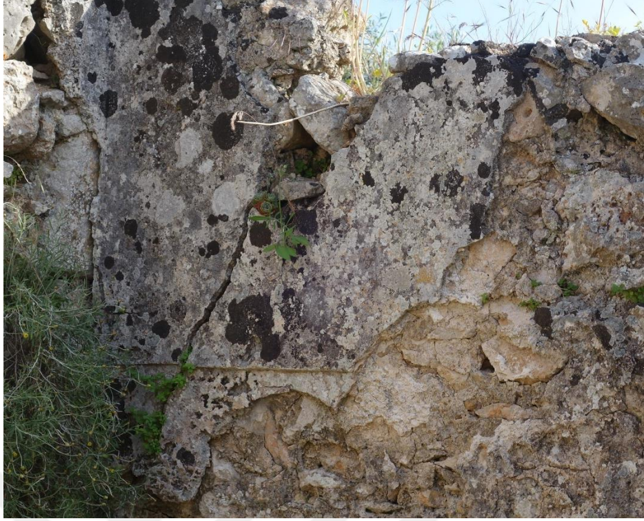
Resim 320 Sıcaklık Bölümü Güney Duvarı (5 Nolu)
