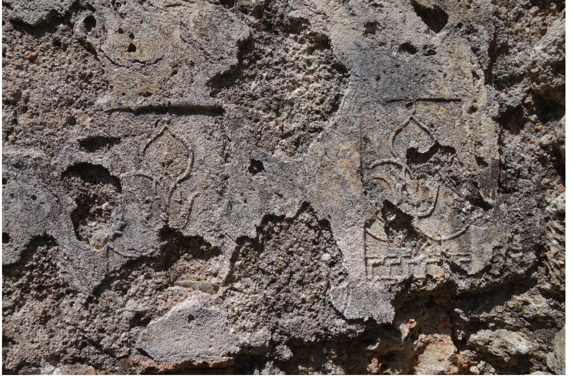
Resim 223 Kuzey Halvet Odası Batı Duvarı (3 Nolu) d. Renk Değişimi e. Biyolojik Oluşumlar
