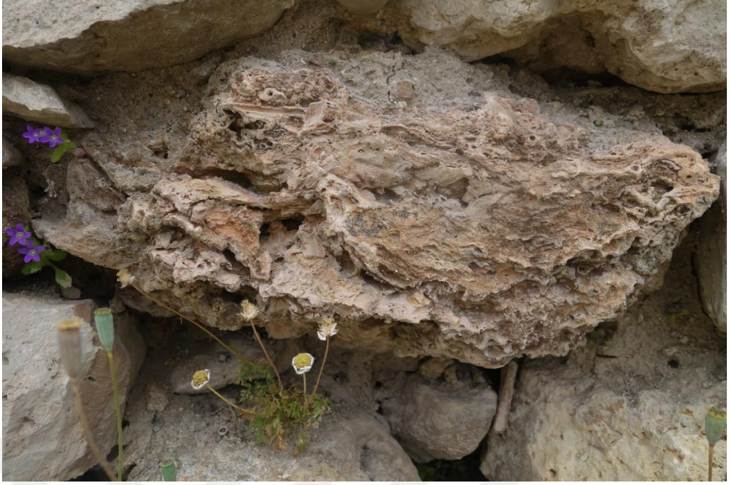
Resim 526 Soyunmalık Bölümü Batı Duvar (1 Nolu) c. Petek Gözlülük
