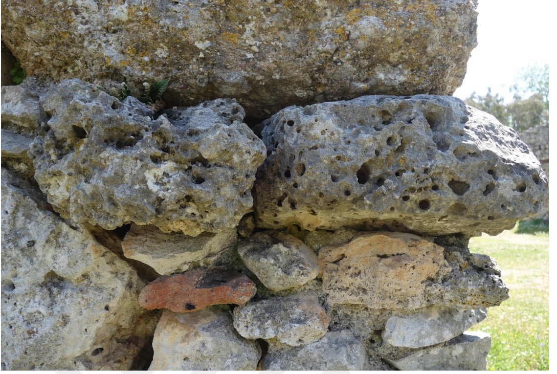
Resim 197 Soyunmalık Bölümü Doğu Duvarı (1 Nolu) c. Petek Gözlülük
