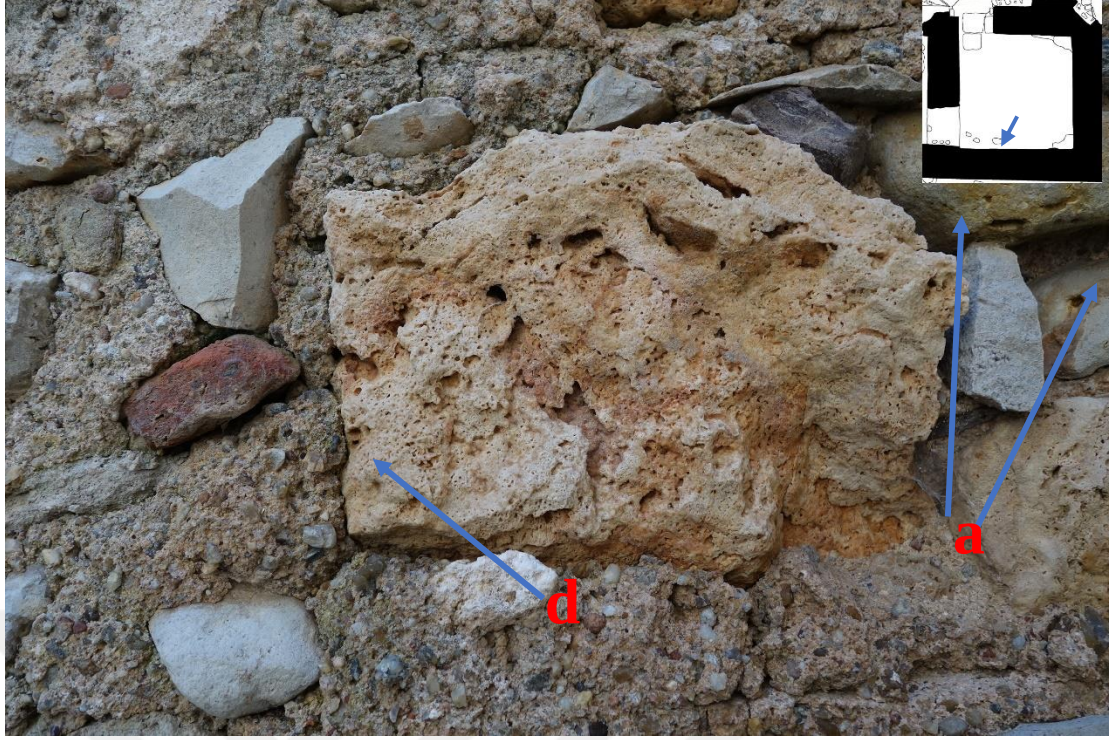
Resim 66 Tıraşlık Bölümü Harç Malzeme (3 Nolu) a. Malzeme Kaybı d. Renk Değişimi
