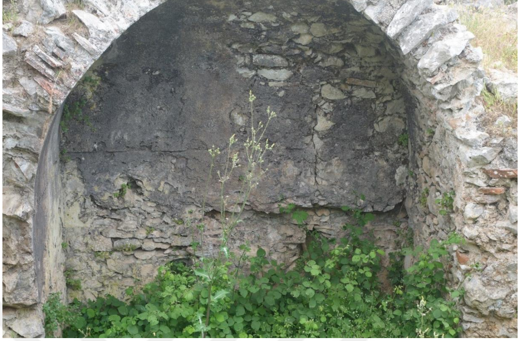
Resim 440 Sıcaklık Bölümü Batı Eyvanı (6 Nolu) b. Yarık d. Renk Değişimi e. Biyolojik Oluşumlar ve Köklü Bitkiler
