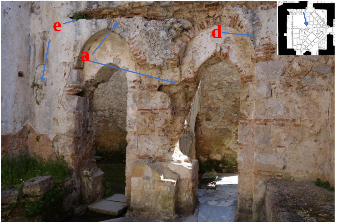
Resim 69 Ilıklık Bölümü Doğu Duvarı (4 Nolu) a. Malzeme Kaybı d. Renk Değişimi e. Köklü Bitkiler
