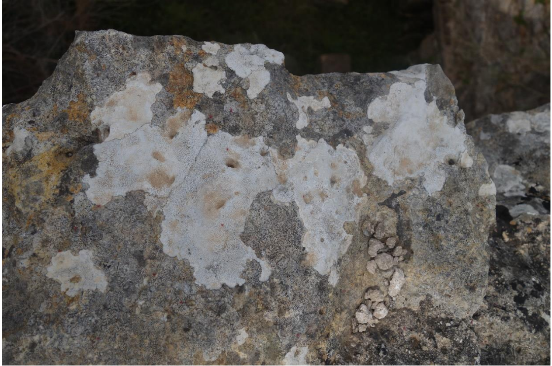
Resim 343 Su Deposu Bölümü Kuzey Duvar (8 Nolu) e. Biyolojik Oluşumlar
