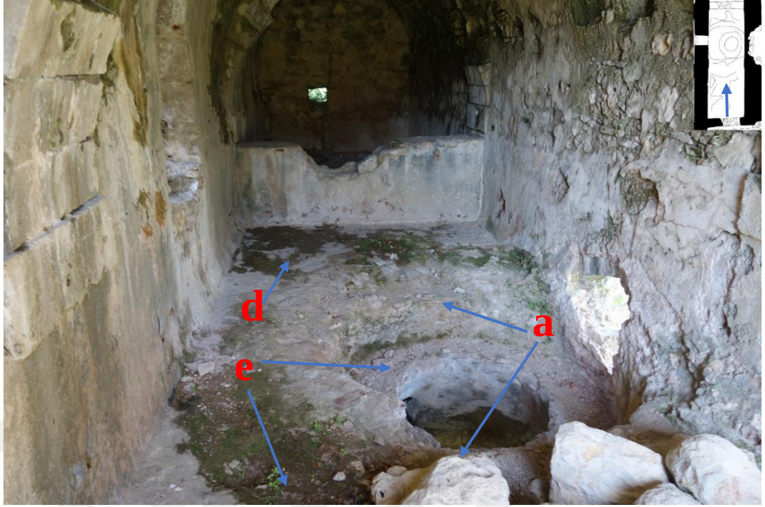
Resim 158 Su Deposu (1) Zemin (9 Nolu) a. Malzeme Kaybı d. Renk Değişimi e. Biyolojik Oluşumlar ve Köklü Bitkiler
