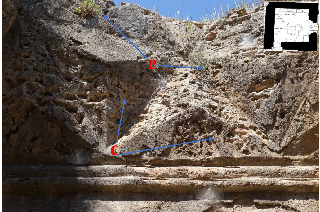
Resim 101 Tıraşlık Bölümü (2) Geçiş Ögesi (5 Nolu) d. Petek Gözlülük e. Köklü Bitkiler
