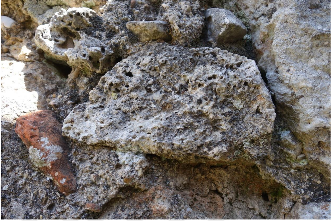
Resim 226 Kuzey Halvet Odası Kuzey Duvarı (3 Nolu) c. Petek Gözlülük
