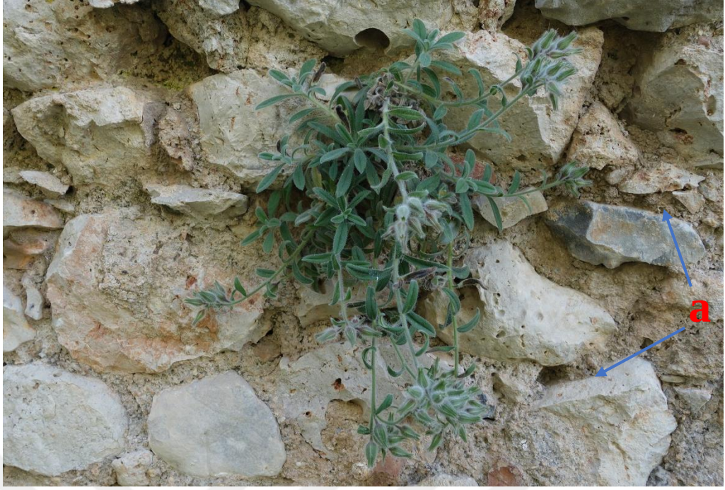
Resim 352 Ek Mekân Batı Duvar Harç Malzeme (9 Nolu) a. Malzeme Kaybı e. Köklü Bitkiler
