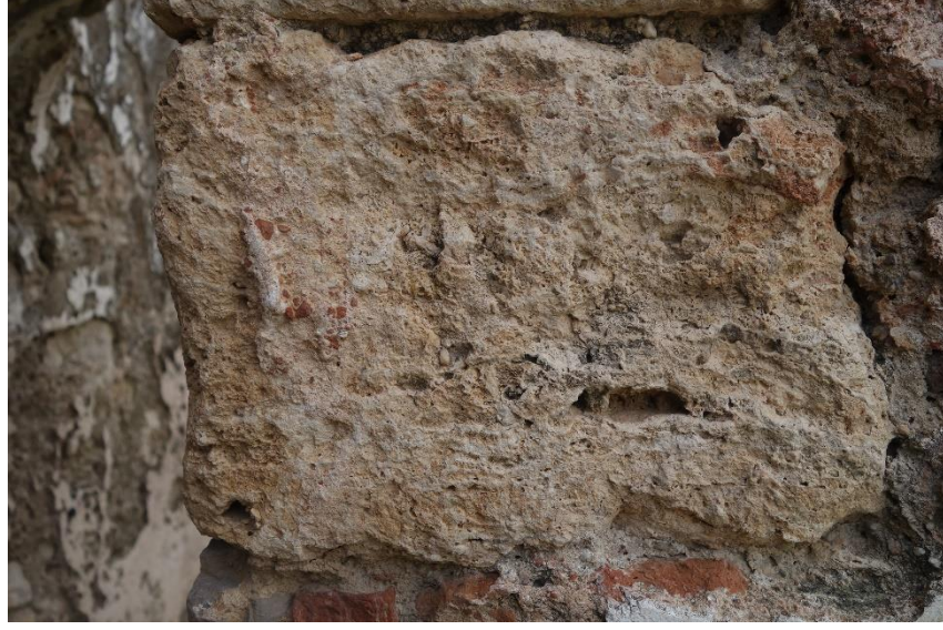
Resim 540 Aralık Bölümü Kuzey Duvarı (2 Nolu) c. Petek Gözlülük
