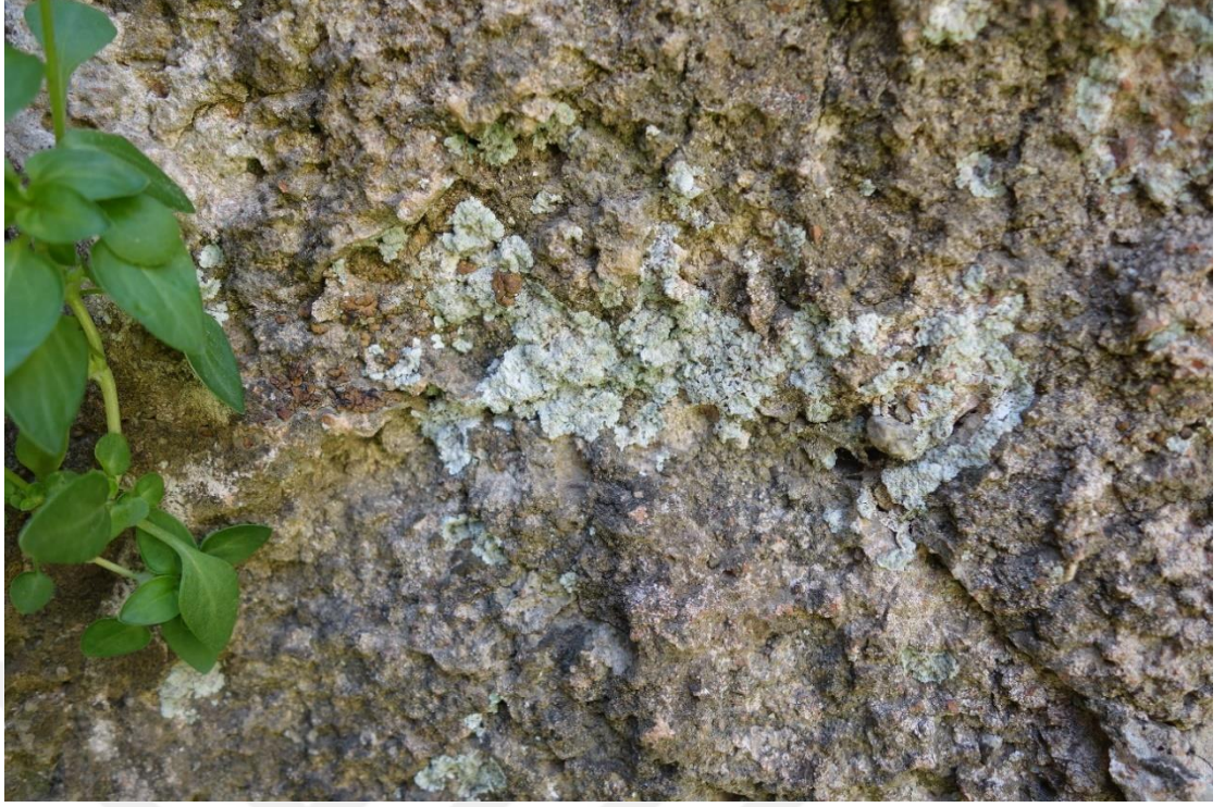
Resim 246 Güney Halvet Odası Güney Duvarı (4 Nolu) e. Biyolojik Oluşumlar
