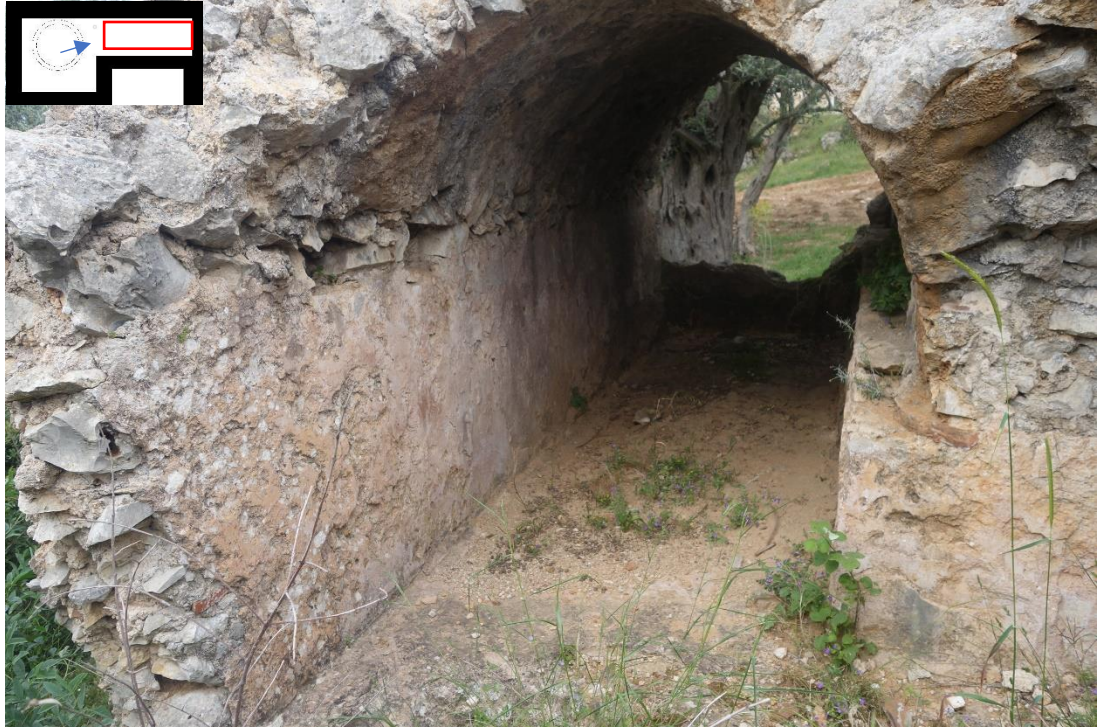
Resim 499 Su Deposu Bölümü (1) Zemin (9 Nolu) e. Köklü Bitkiler
