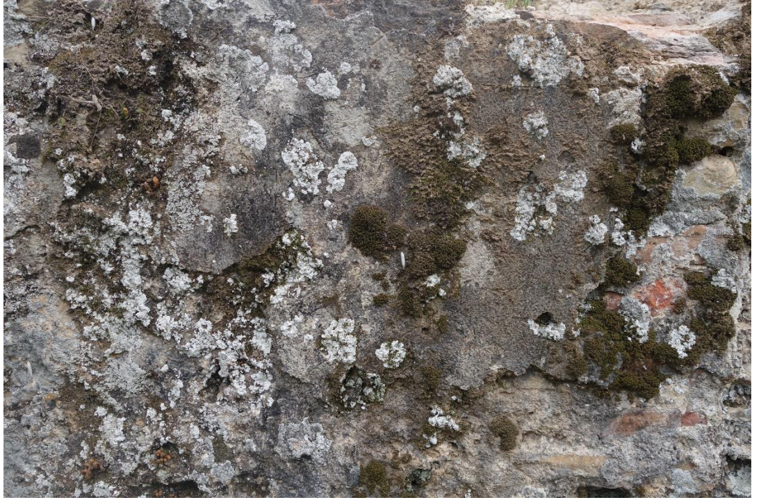
Resim 427 Ilıkkık Bölümü Kuzey Duvarı (4 Nolu) d. Renk Değişimi e. Biyolojik Oluşumlar
