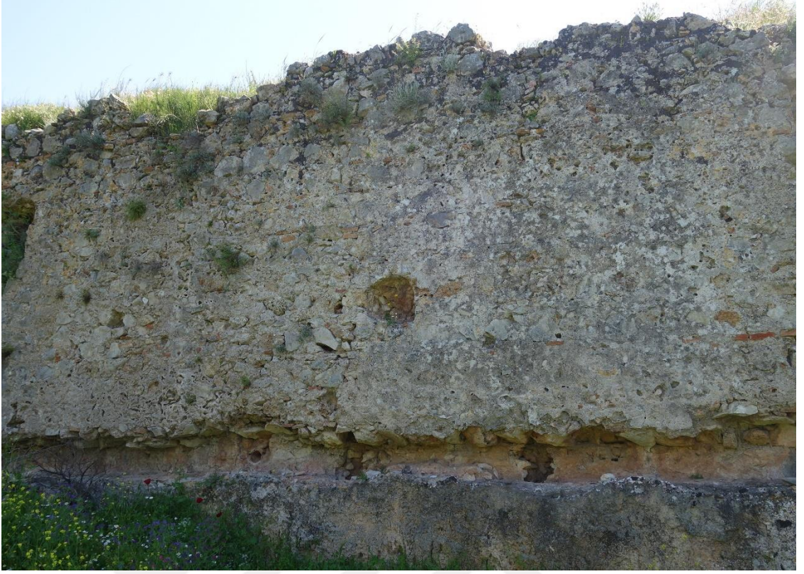
Resim 7 Büyük Hamam Batı Duvarı Genel Görünüş (17 Nolu)
