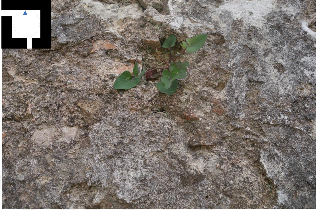
Resim 550 Sıcaklık Bölümü Batı Duvarı (3 Nolu) e. Köklü Bitkiler
