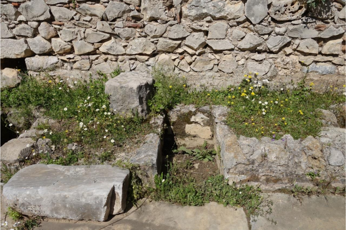
Resim 19 Soyunmalık Bölümü Batı Duvarı ve Seki (1 Nolu) e. Köklü Bitkiler ve Biyolojik Oluşum
