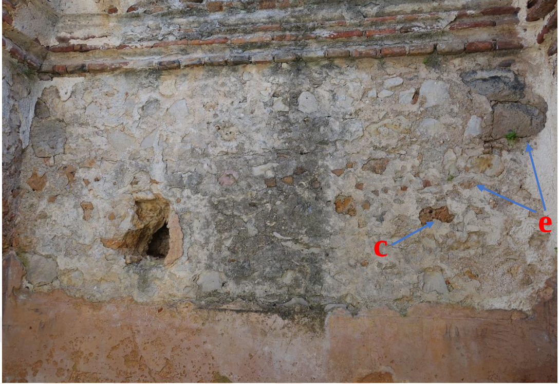
Resim 142 Doğu Halvet Odası Doğu Duvarı (8 Nolu) c. Petek Gözlülük e. Köklü Bitkiler
