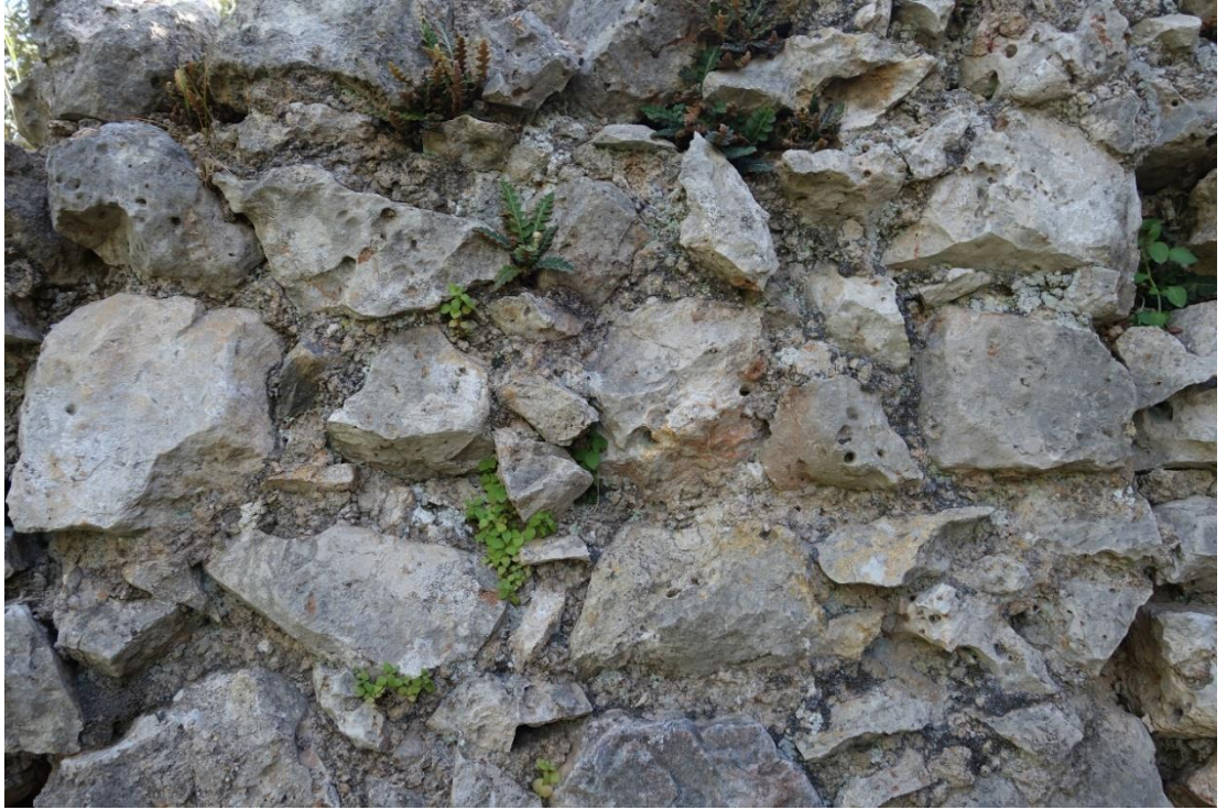
Resim 351 Ek Mekân Güney Duvar (9 Nolu) c. Petek Gözlülük e. Köklü Bitkiler
