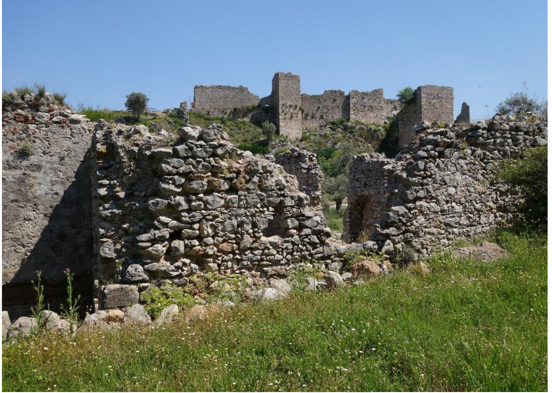
Resim 8 Büyük Hamam Güney Duvarı Genel Görünüş (19 Nolu)
