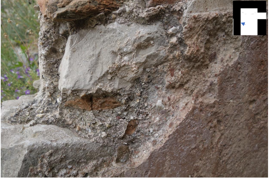
Resim 543 Aralık Bölümü Harç Malzeme (2 Nolu) a. Malzeme Kaybı d. Renk Değişimi
