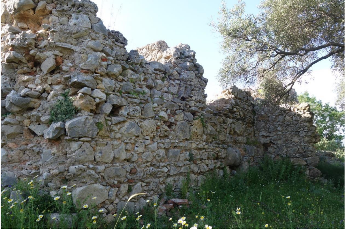
Resim 264 Seymenlik Hamamı Doğu Duvarı Genel Görünüş (11 Nolu)
