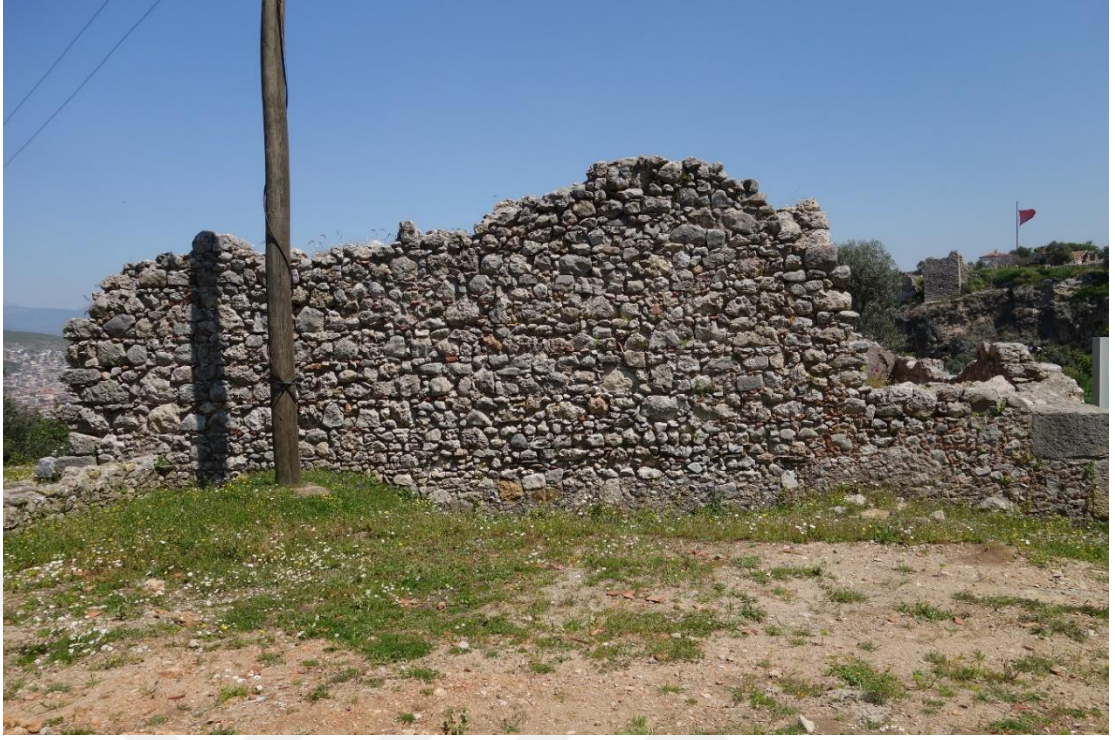
Resim 191 Bey Hamamı Güney Duvarı Genel Görünüş
