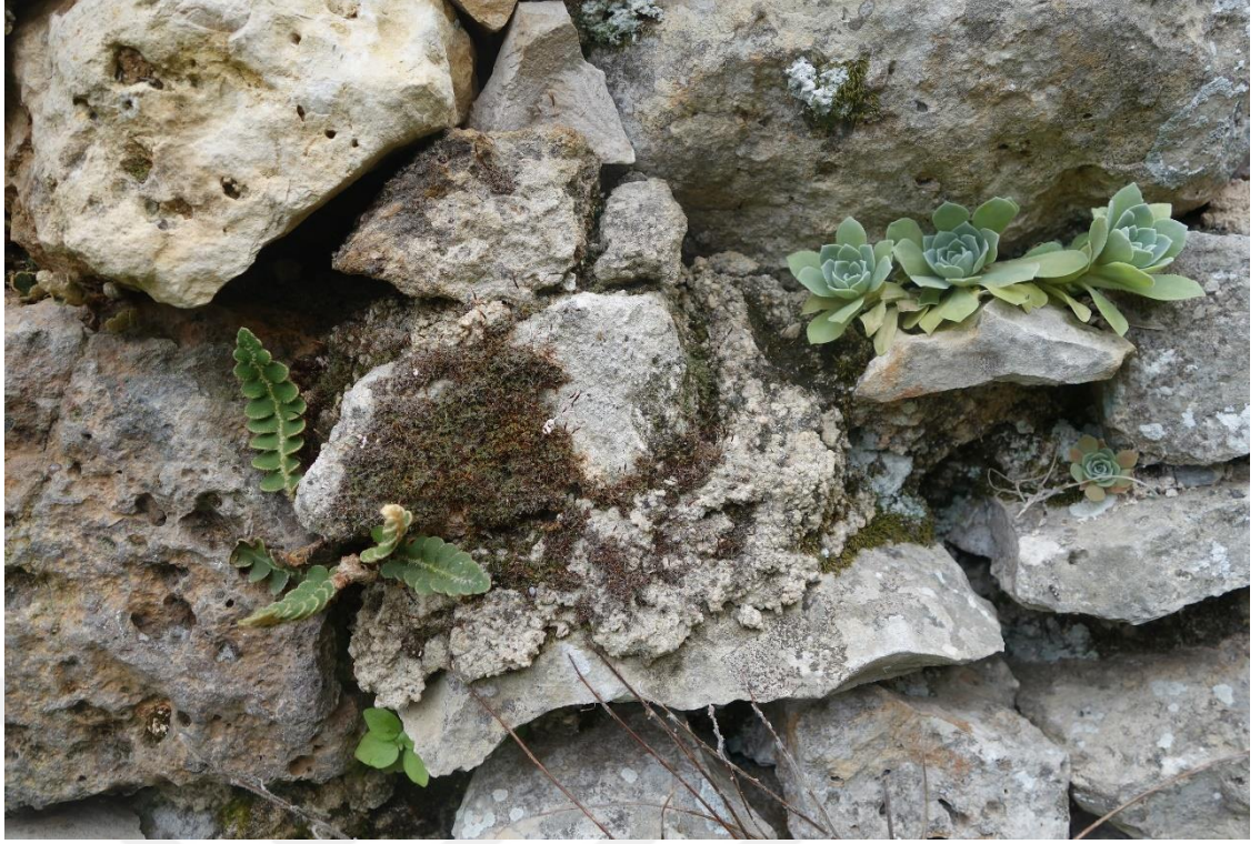
Resim 490 Batı Halvet Güney Duvarı (8 Nolu) e. Biyolojik Oluşumlar ve Köklü Bitkiler
