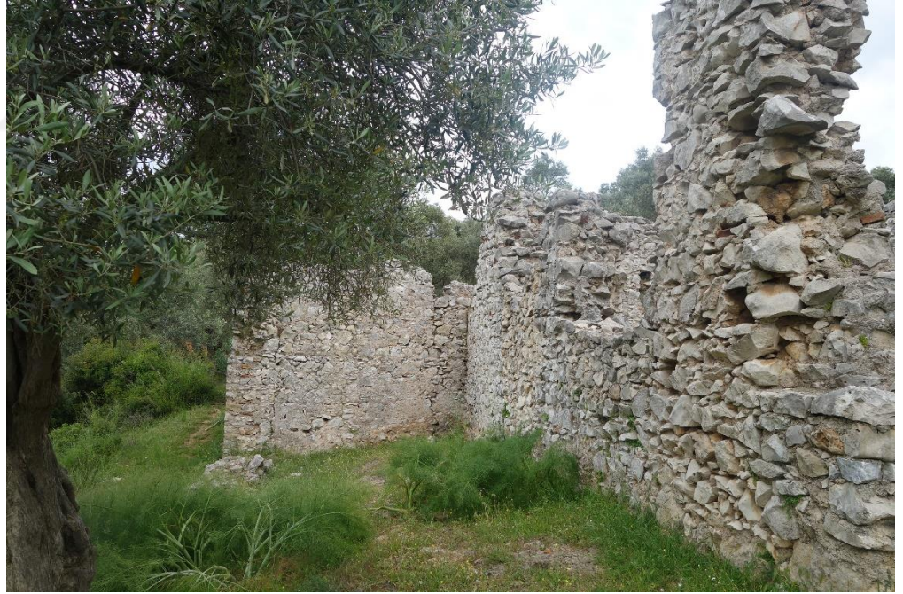
Resim 361 Yelli Hamamı Kuzey Batıdan Görünüşü
