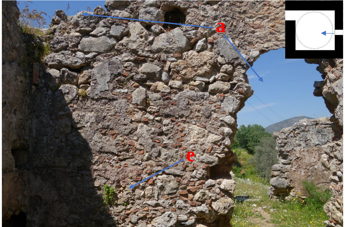
Resim :239 Güney Halvet Odası Batı Duvarı (4 Nolu) a. Malzeme Kaybı e. Köklü Bitkiler
