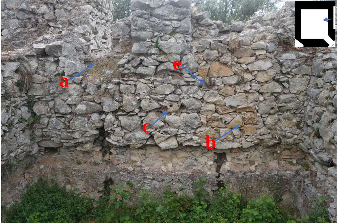
Resim 481 Batı Halvet Batı Duvarı (8 Nolu) a. Malzeme Kaybı b. Yarık c. Petek Gözlülük e. Köklü Bitkiler
