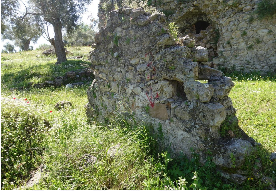
Resim 5 Büyük Hamam Kuzey Duvarı Genel Görünüş (16 Nolu)
