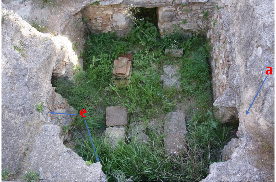
Resim 285 Ilıklık Bölümü Zemin (3 Nolu) a. Malzeme Kaybı e. Köklü Bitkiler
