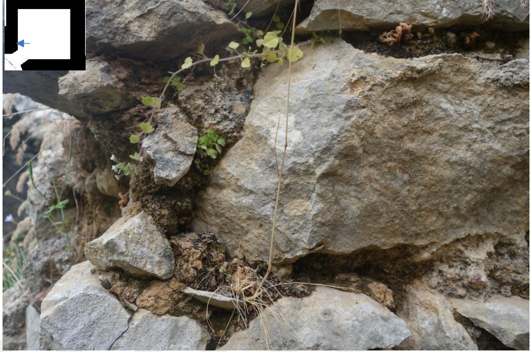
Resim 472 Doğu Halvet Bölümü Batı Duvarı Harç Malzeme (7 Nolu) a. Malzeme Kaybı d. Renk Değişimi e. Biyolojik Oluşum ve Köklü Bitkiler
