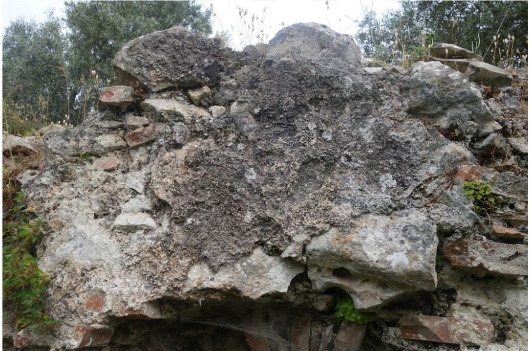
Resim 455 Sıcaklık Bölümü Güney Eyvanı (6 Nolu)
