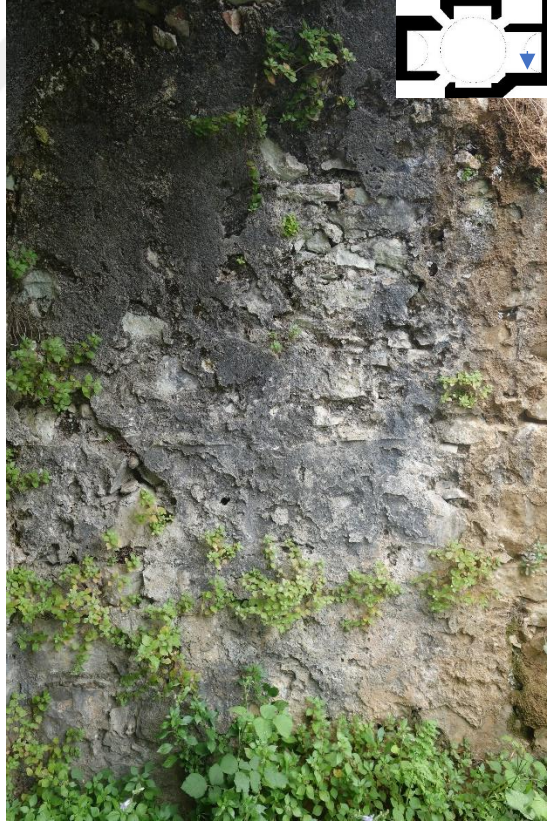
Resim 435 Sıcaklık Bölümü Doğu Eyvanı (6 Nolu) d. Renk Değişimi e. Köklü Bitkiler
