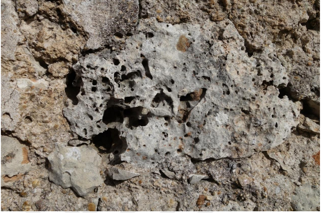
Resim 288 Ilıklık Bölümü Doğu Duvarı (3 Nolu) c. Petek Gözlülük
