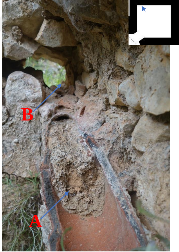
Resim 475 Doğu Halvet Bölümü Kuzey Duvarı Su Hattı (7 Nolu) A. Eski Su Hattı B. Sonradan Yapılan Su Hattı
