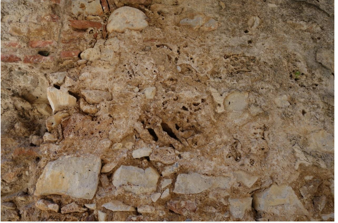
Resim 44 Aralık Bölümü Güney Duvarı (2 Nolu) c. Petek Gözlülük
