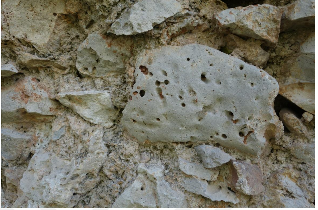
Resim 348 Ek Mekân Batı Duvarı (9 Nolu) c. Petek Gözlülük
