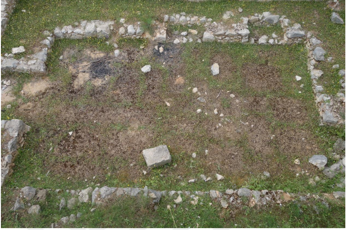
Resim 370 Soyunmalık Bölümü Zemin ve Sekiler (1 Nolu) a. Malzeme Kaybı e. Biyolojik Oluşumlar ve Köklü Bitkiler
