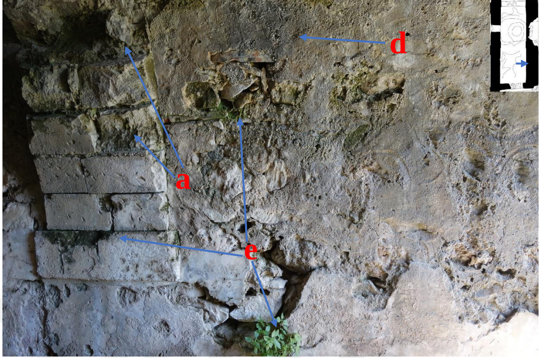
Resim 165 Su Deposu (1) Kuzey Duvarı (9 Nolu) a. Malzeme Kaybı d. Renk Değişimi e. Biyolojik Oluşumlar
