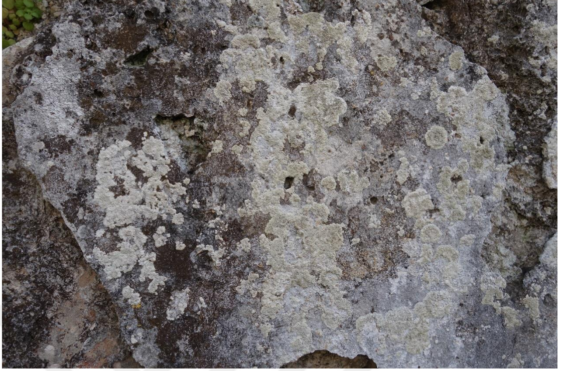
Resim 322 Sıcaklık Bölümü Sıva Malzeme (5 Nolu) a. Malzeme Kaybı d. Renk Değişimi e. Biyolojik Oluşumlar
