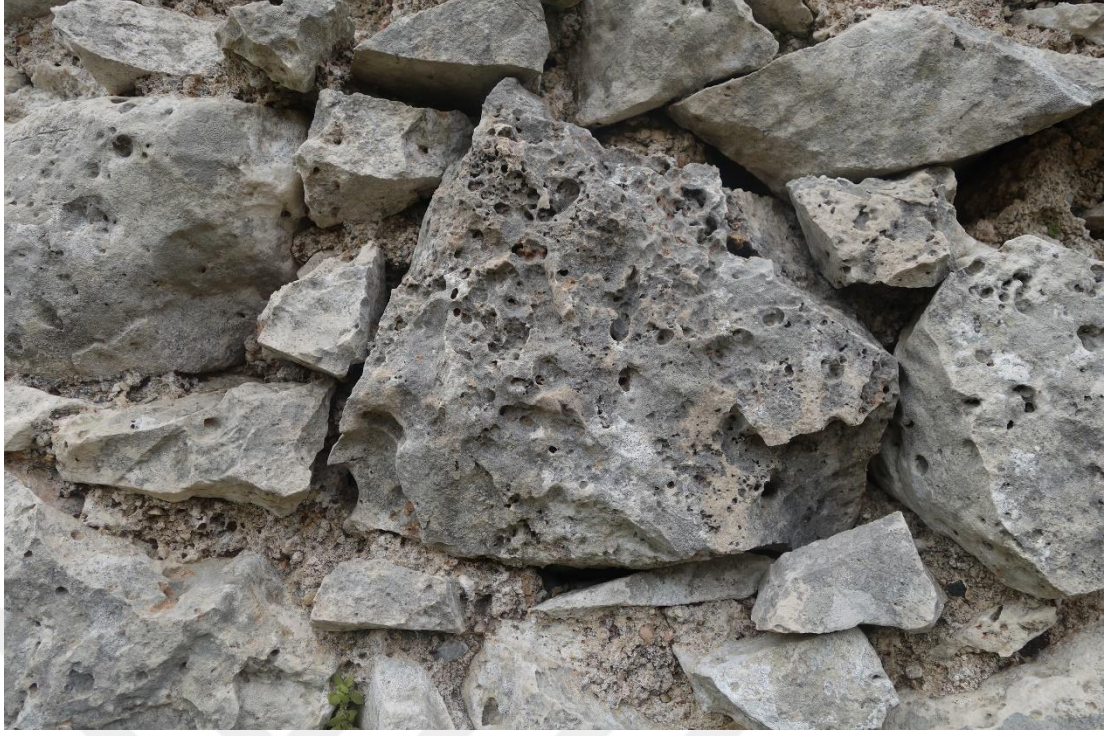
Resim 380 Soyunmalık Bölümü Kuzey Duvar (1 Nolu) c. Petek Gözlülük
