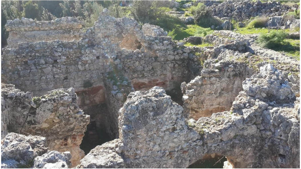
Resim 262 Seymenlik Hamamı Batı Duvarı Genel Görünüş
