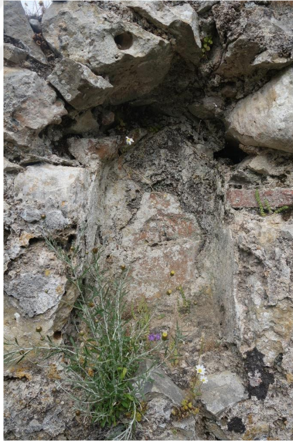
Resim 415 Ilıklık Bölümü Doğu Duvarı (4 Nolu) a. Malzeme Kaybı e. Biyolojik Oluşum ve Köklü Bitkiler
