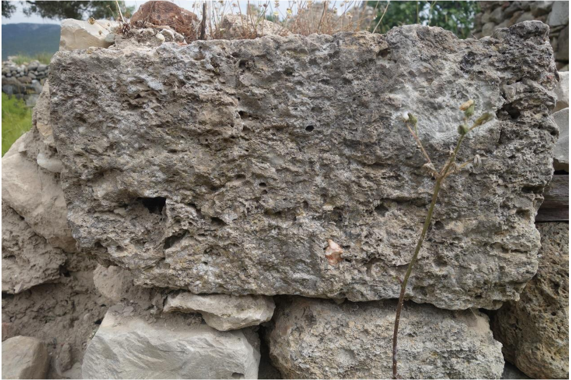
Resim 531 Soyunmalık Bölümü Güney Duvar (1 Nolu) c. Petek Gözlülük
