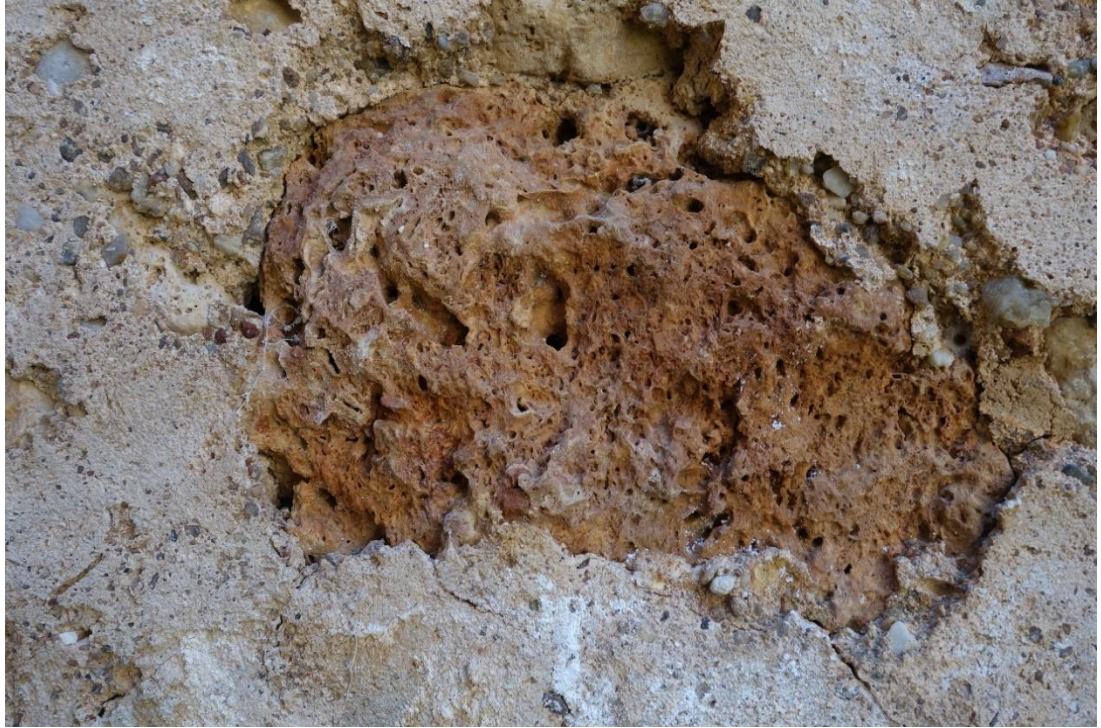
Resim 151 Doğu Halvet Odası Güney Duvarı (8 Nolu) c. Petek Gözlülük
