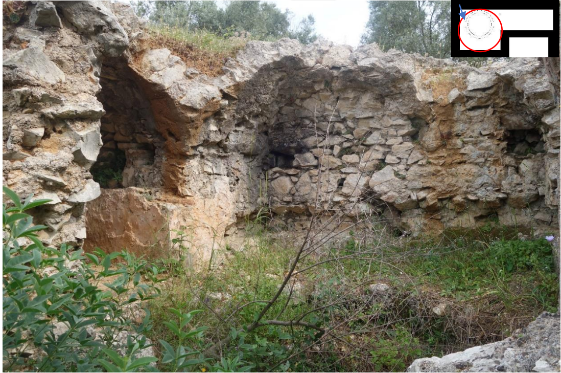
Resim 495 Su Deposu Bölümü (1) Genel Görünüş (9 Nolu)
