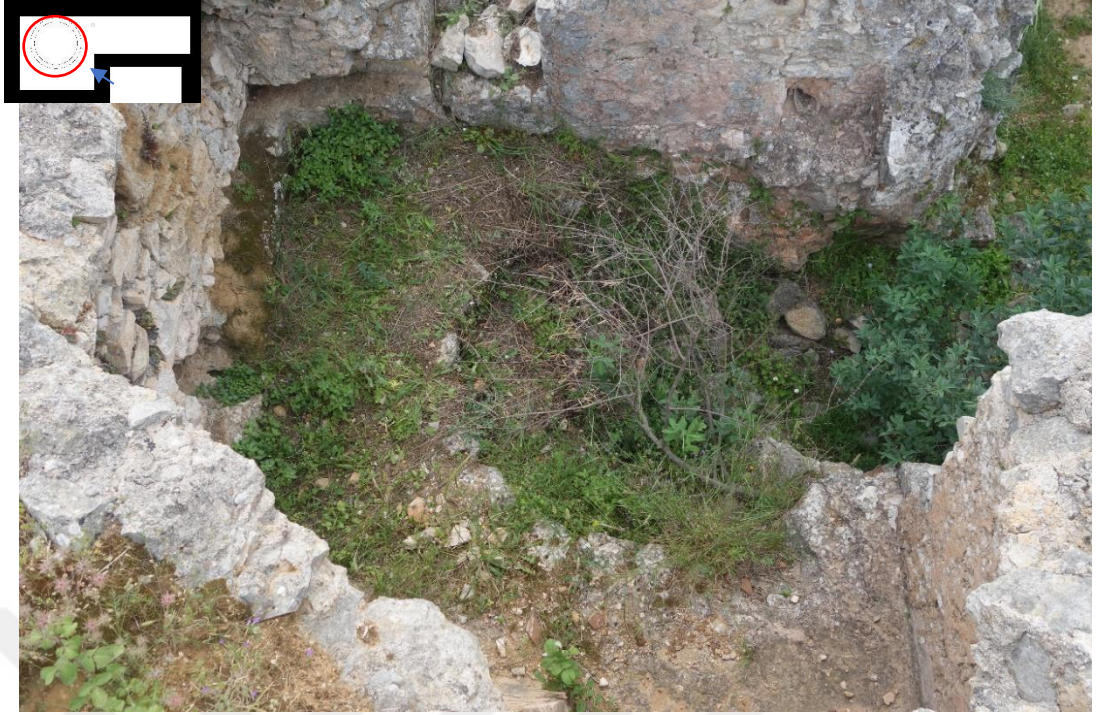
Resim 498 Su Deposu Bölümü (1) Zemin (9 Nolu) a. Malzeme Kaybı e. Köklü Bitkiler
