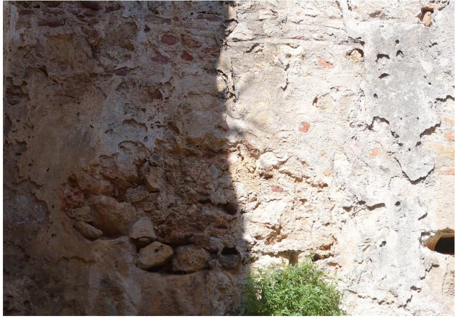
Resim 73 Ihlıklik Bölümü Batı Duvarı (4 Nolu) e. Köklü Bitkiler g. Tuzlanma
