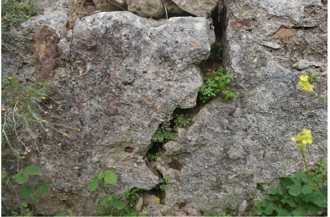
Resim 479 Batı Halvet Doğu Duvarı (8 Nolu) b. Yarık
