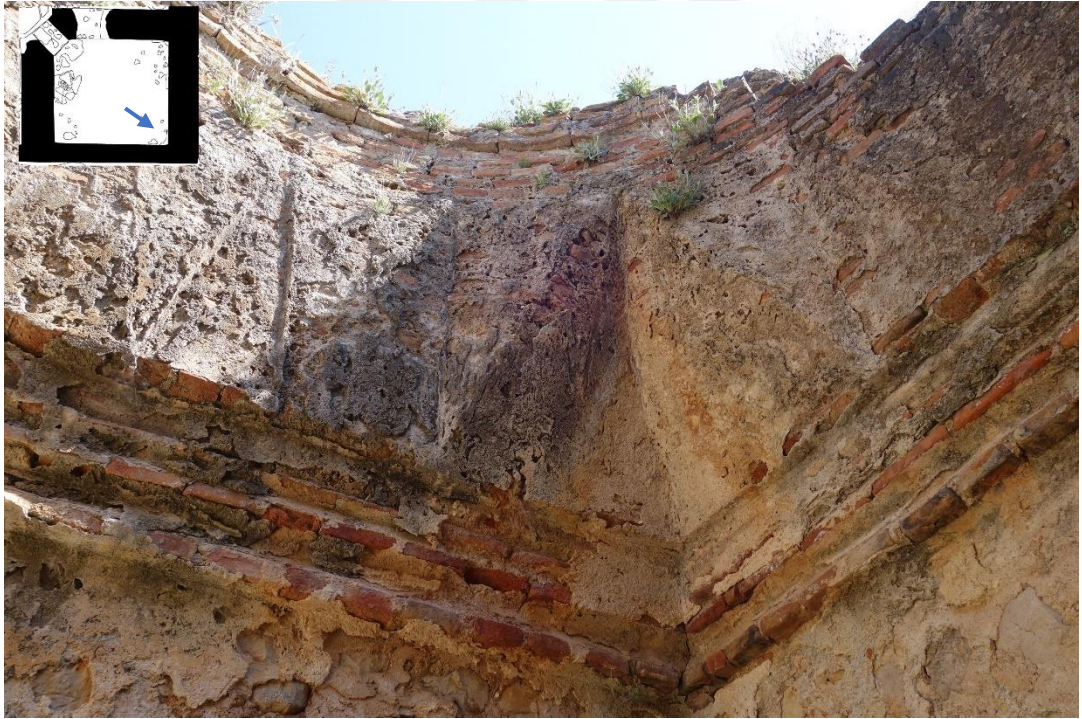
Resim 155 Doğu Halvet Odası Geçiş Ögesi (8 Nolu) a. Malzeme Kaybı d. Renk Değişimi e. Köklü Bitkiler
