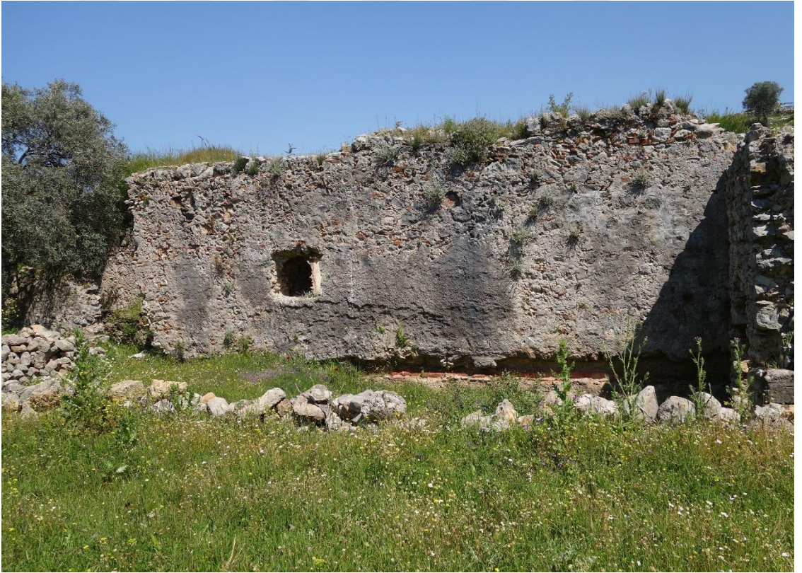
Resim 7 Büyük Hamam Güney Duvarı Genel Görünüş (18 Nolu)
