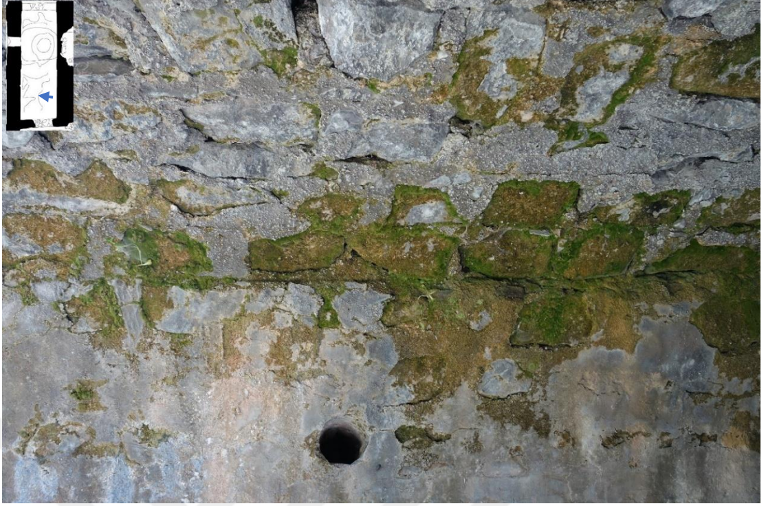
Resim 167 Su Deposu (1) Üst Örtü (9 Nolu) e. Biyolojik Oluşumlar
