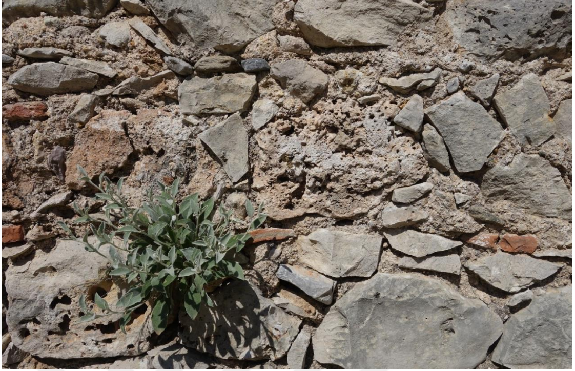
Resim 20 Soyunmalık Bölümü Batı Duvarı (1 Nolu) c. Petek Gözlülük e. Köklü Bitkiler
