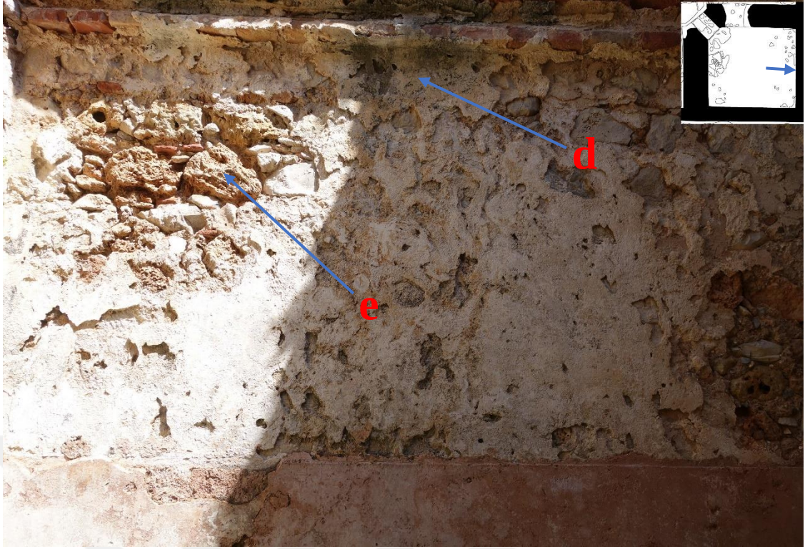
Resim 148 Doğu Halvet Odası Kuzey Duvarı (8 Nolu) c. Petek Gözlülük d. Renk Değişimi
