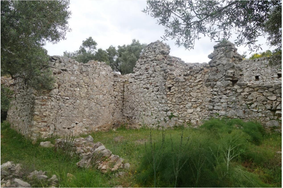
Resim 369 Yelli Hamamı Kuzey Batıdan Görünüşü
