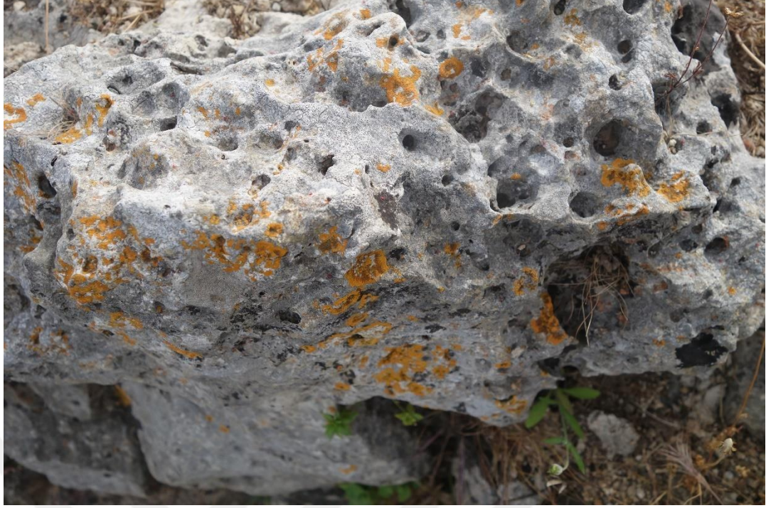
Resim 342 Su Deposu Bölümü Kuzey Duvar (8 Nolu) e. Biyolojik Oluşumlar
