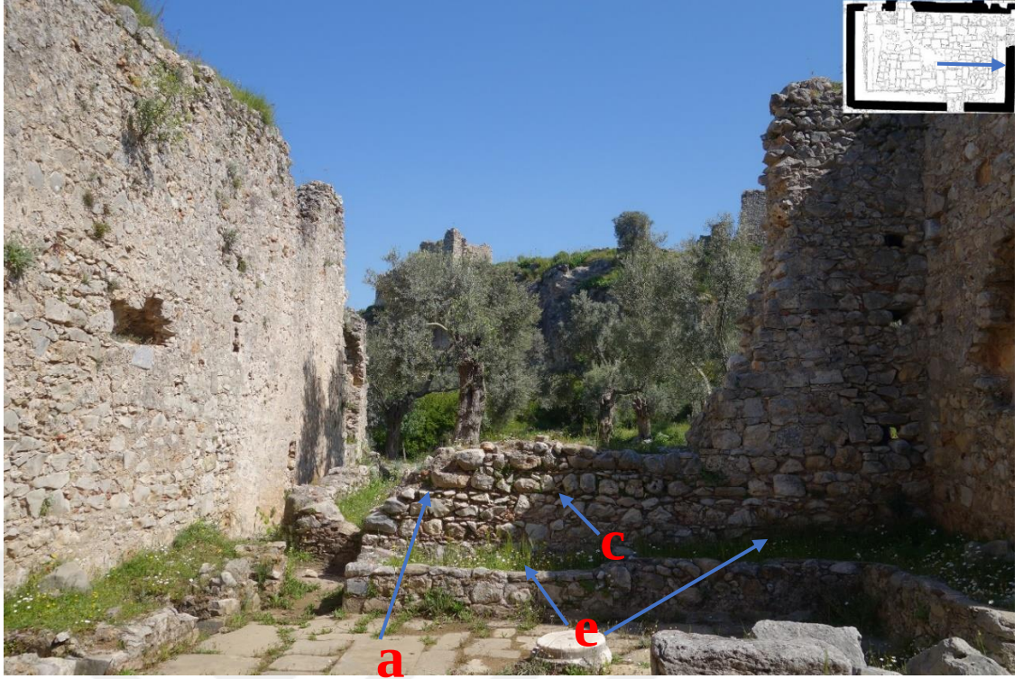
Resim 22 Soyunmalık Bölümü Kuzey Duvarı (1 Nolu) a. Malzeme Kaybı c Petek Gözlülük e Köklü Bitkiler
