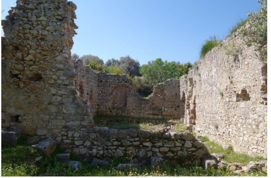
Resim 3 Büyük Hamam Soyunmalık Kuzey Duvarı Genel Görünüş (14 Nolu)
