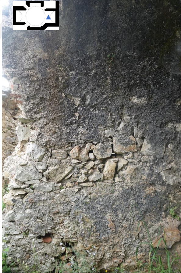
Resim 437 Sıcaklık Bölümü Doğu Eyvanı (6 Nolu) d. Renk Değişimi e. Köklü Bitkiler
