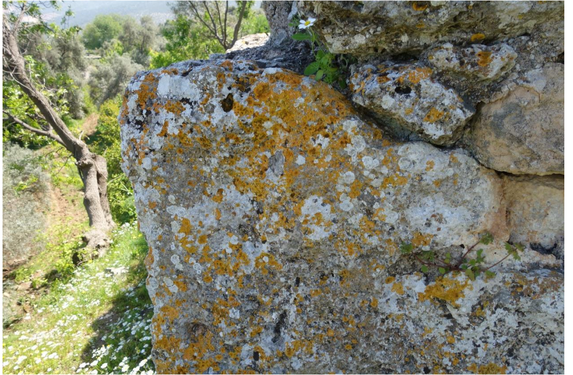
Resim 202 Soyunmalık Bölümü Doğu Duvarı (1 Nolu) d. Renk Değişimi e. Biyolojik Oluşumlar ve Köklü Bitkiler
