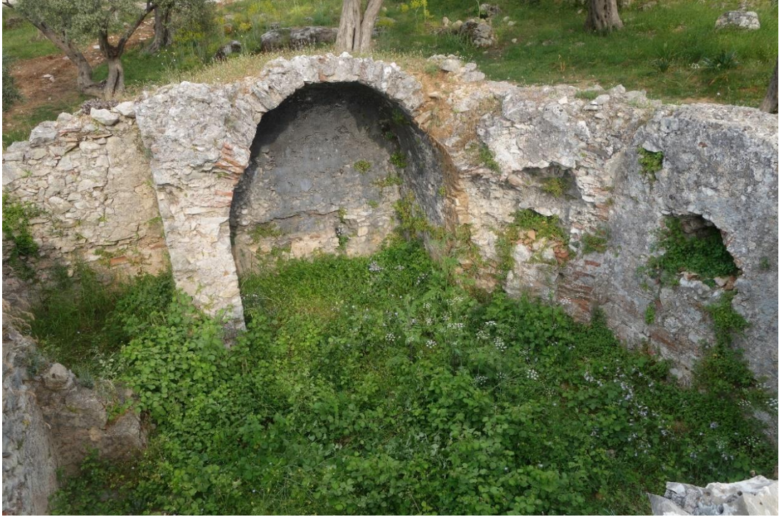
Resim 365 Yelli Hamamı Sıcaklık Bölümü Kuzey Batıdan Bir Görünüm
