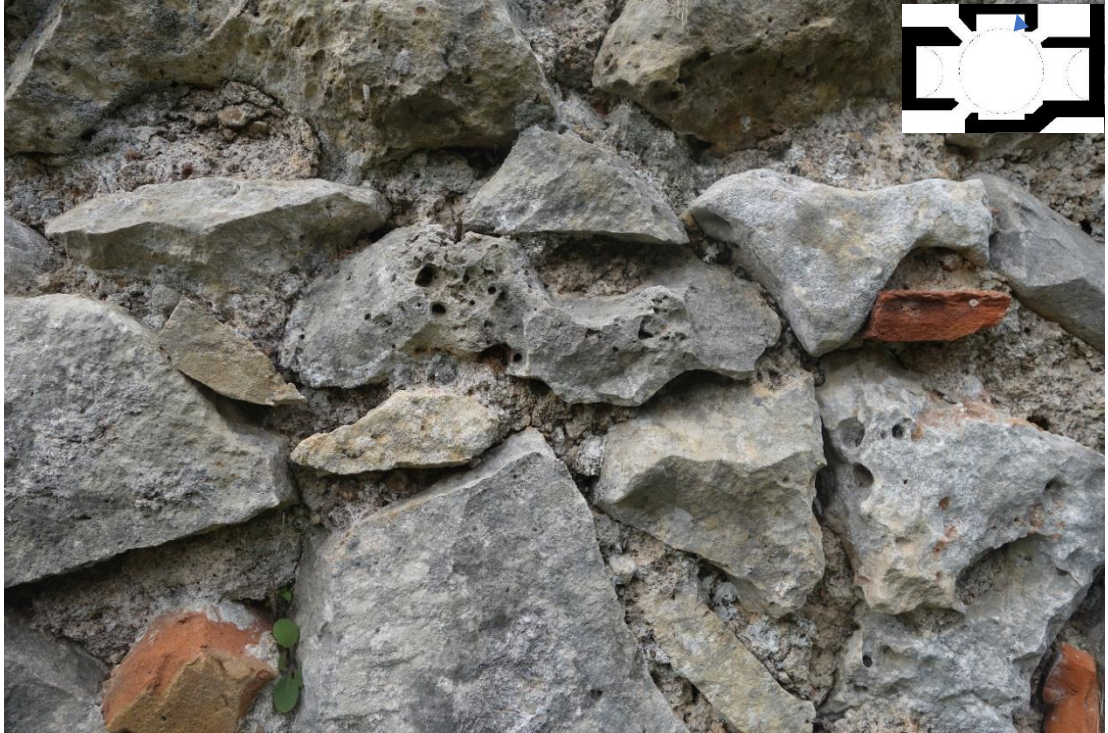
Resim 459 Sıcaklık Bölümü Kuzey Eyvanı Harç Malzeme (6 Nolu) a. Malzeme Kaybı d. Renk Değişimi e Köklü Bitkiler
