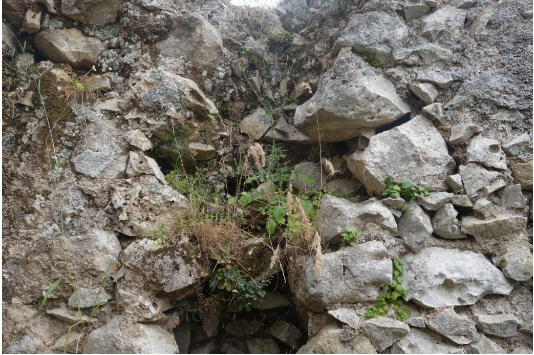
Resim 471 Doğu Halvet Bölümü Güney Duvarı (7 Nolu) a. Malzeme Kaybı d. Renk Değişimi e. Biyolojik Oluşum ve Köklü Bitkiler
