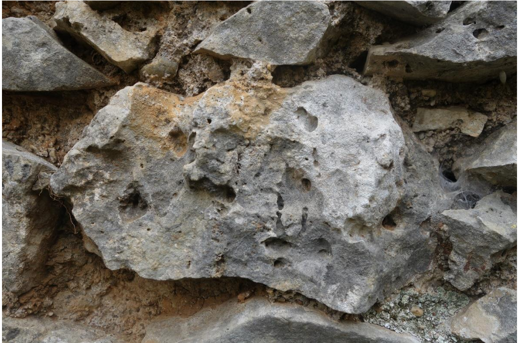
Resim 469 Doğu Halvet Bölümü Kuzey Duvarı (7 Nolu) c. Petek Gözlülük
